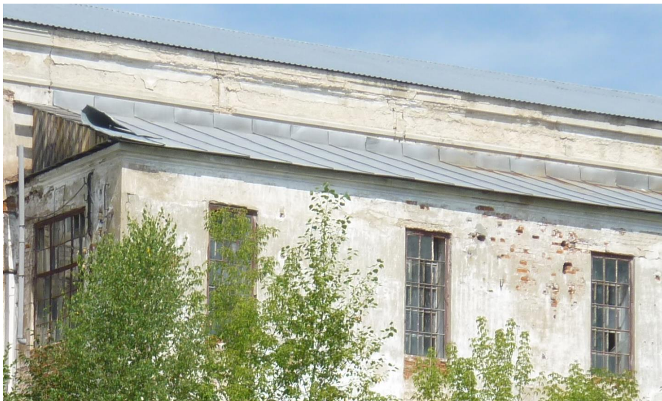
Расстекловка окон и профилировка карнизов электростанции
