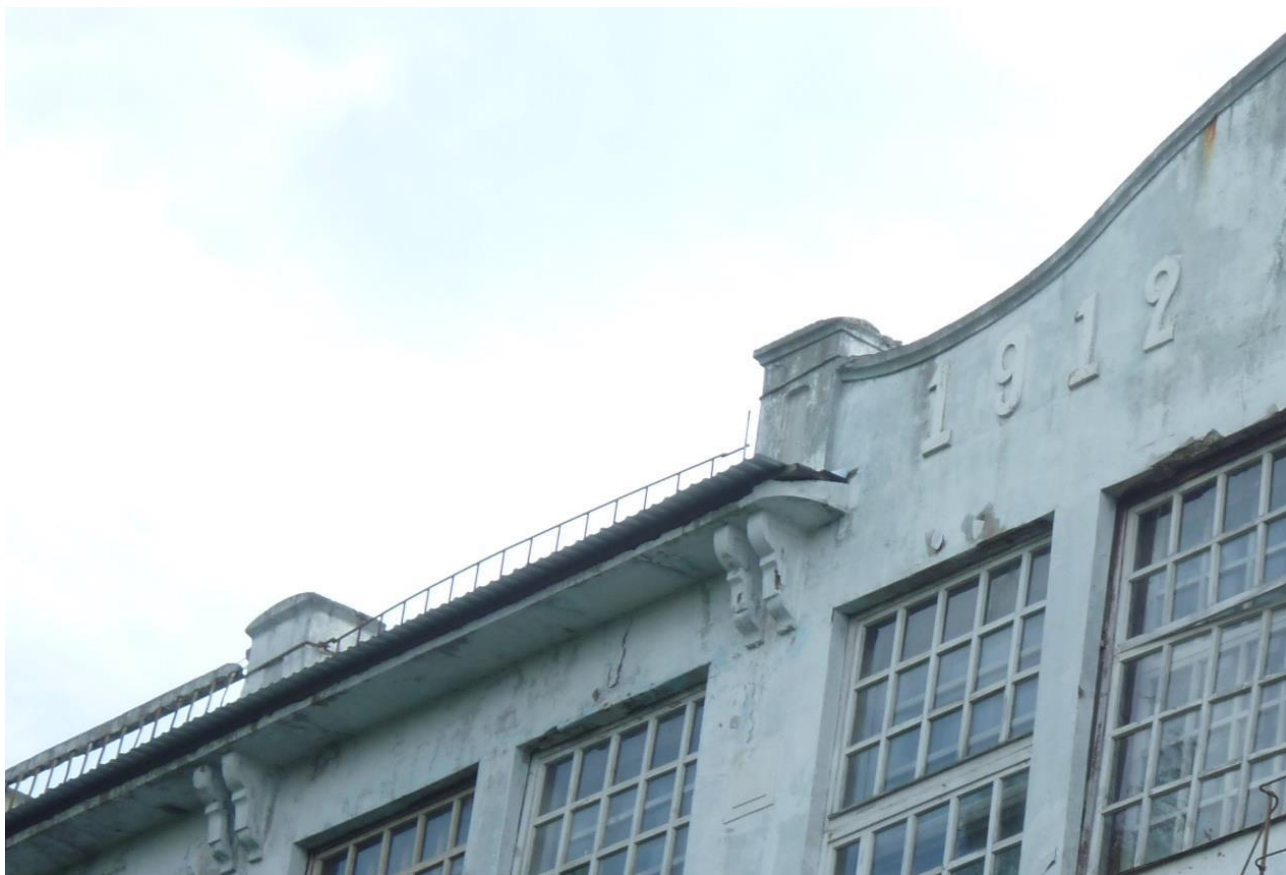
Расстекловка окон и профилировка карнизов электростанции
