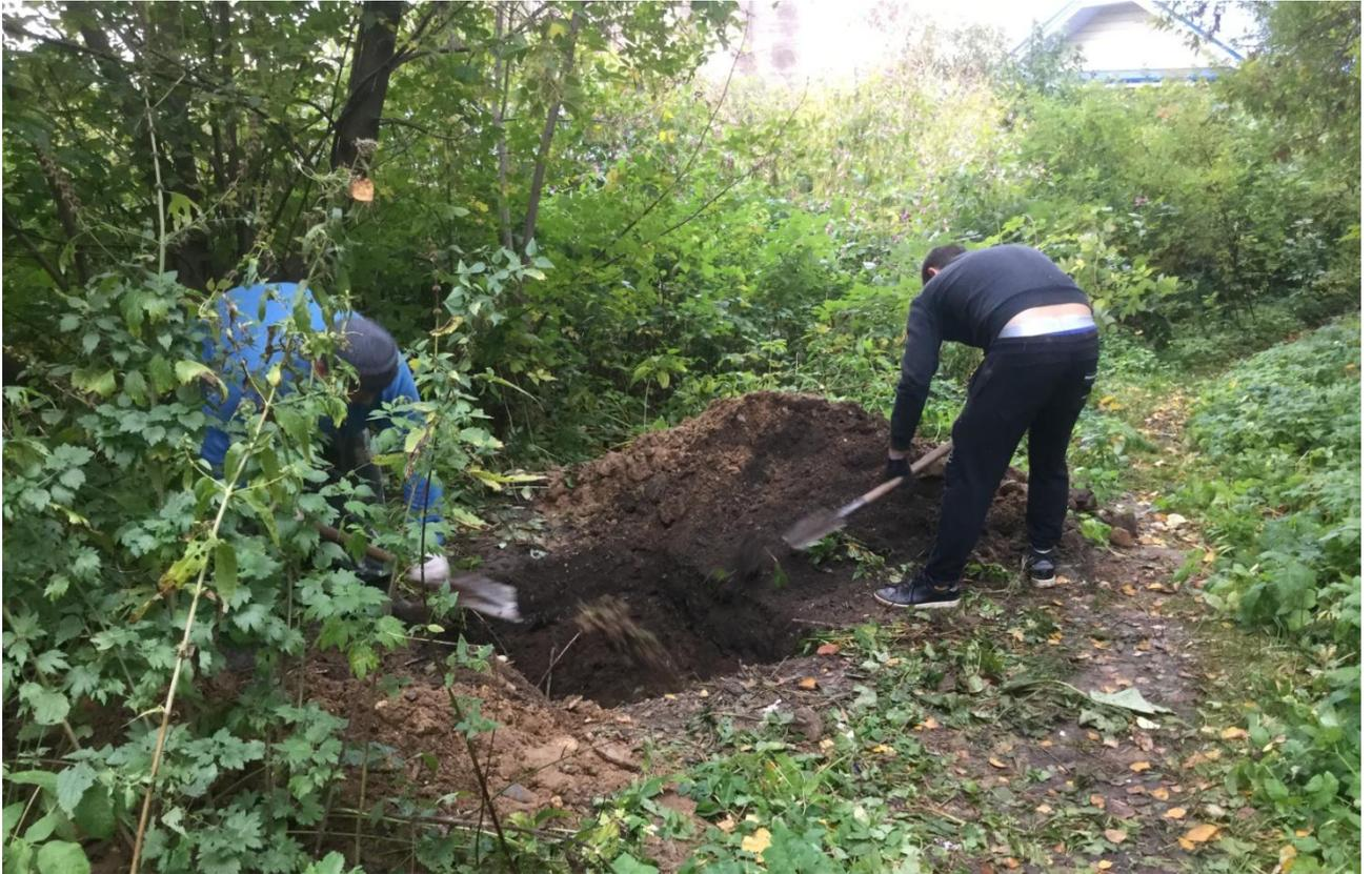
Рис. 20. Ивановская обл., г. Кинешма, пер. Мельничный, 14, газопровод-ввод к жилому дому. Общий вид с юго-востока выкопанного шурфа № 2, процесс рекультивации.
