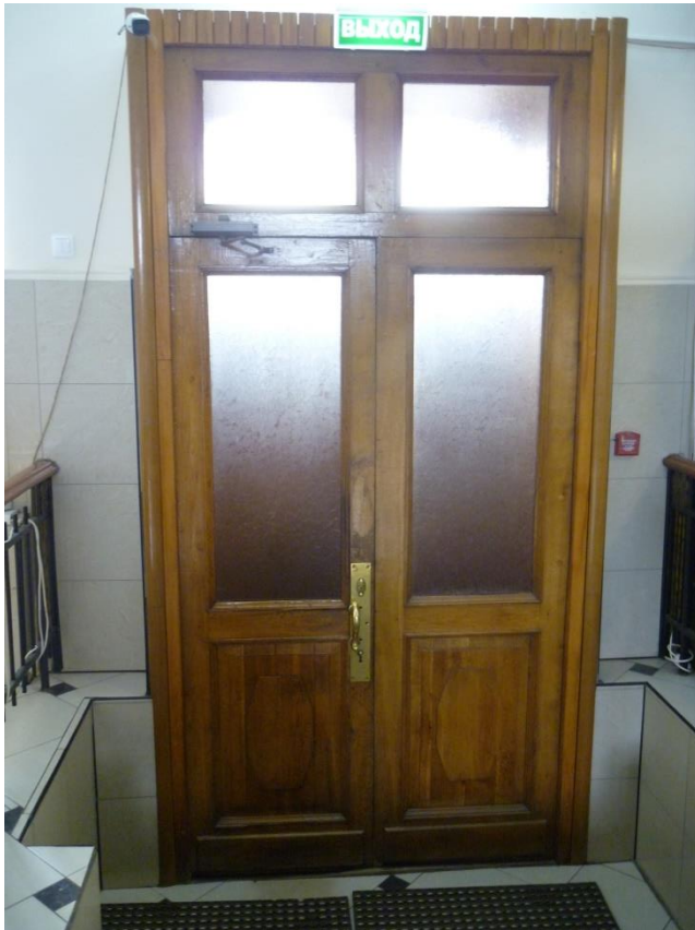
15. Внутренние двери входного тамбура
