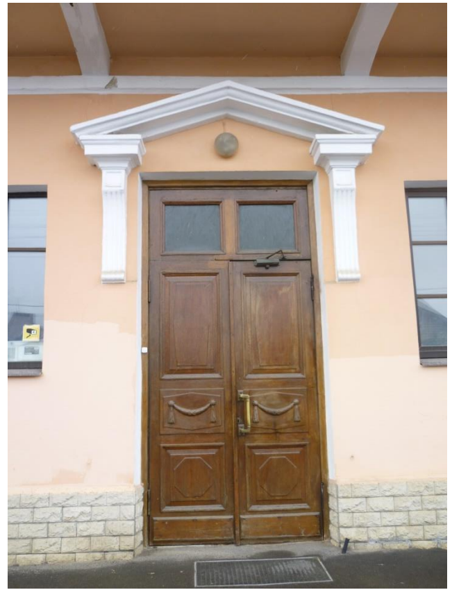
16. Наружные двери входного тамбура
