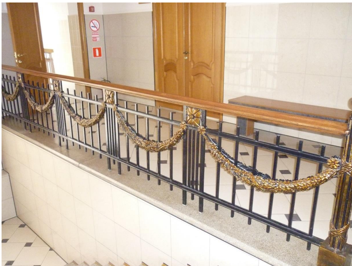
13. Решетка ограждения лестничной клетки
