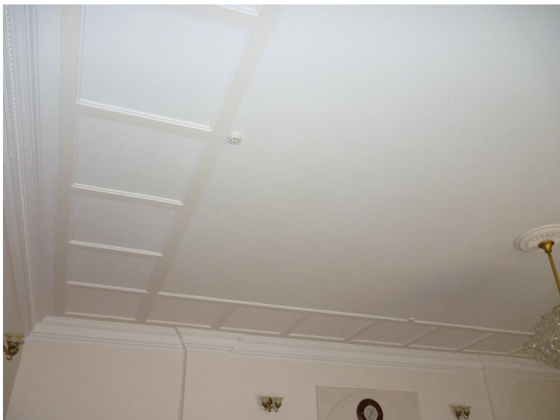
12. Плафон на верхней лестничной площадке
