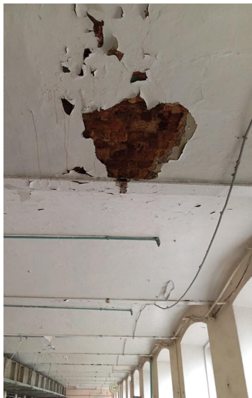
Фото 12. Кирпичные своды по металлическим балкам
