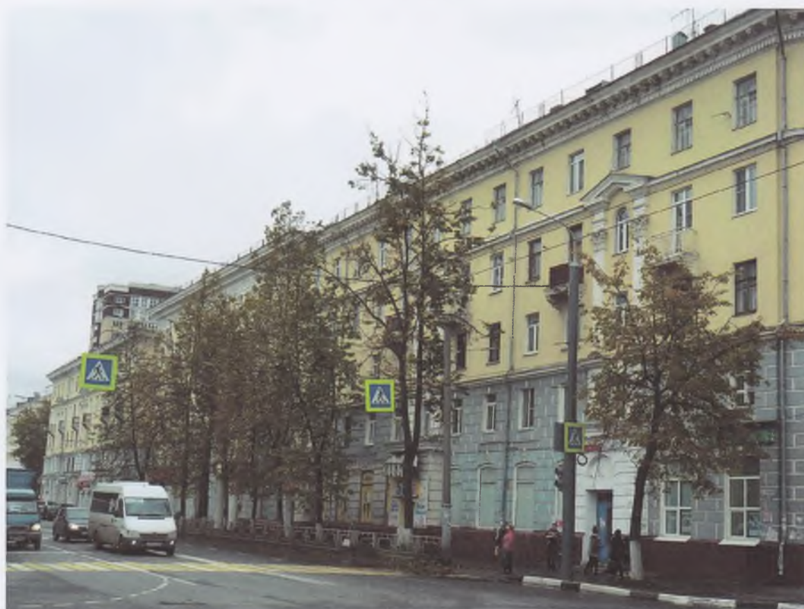
10. Общий вид с северо-запада.
