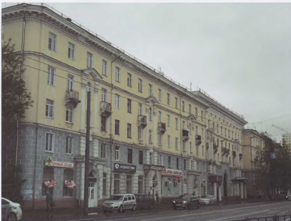
8 . Общий вид с северо-востока.
