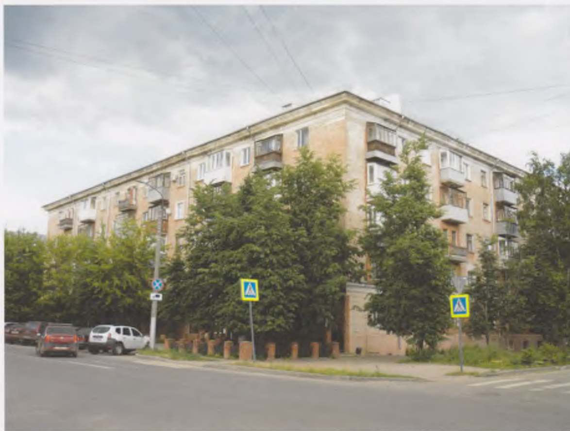
11. Дом фабрики «Красная Талка» (ул. Калинина, 10)
