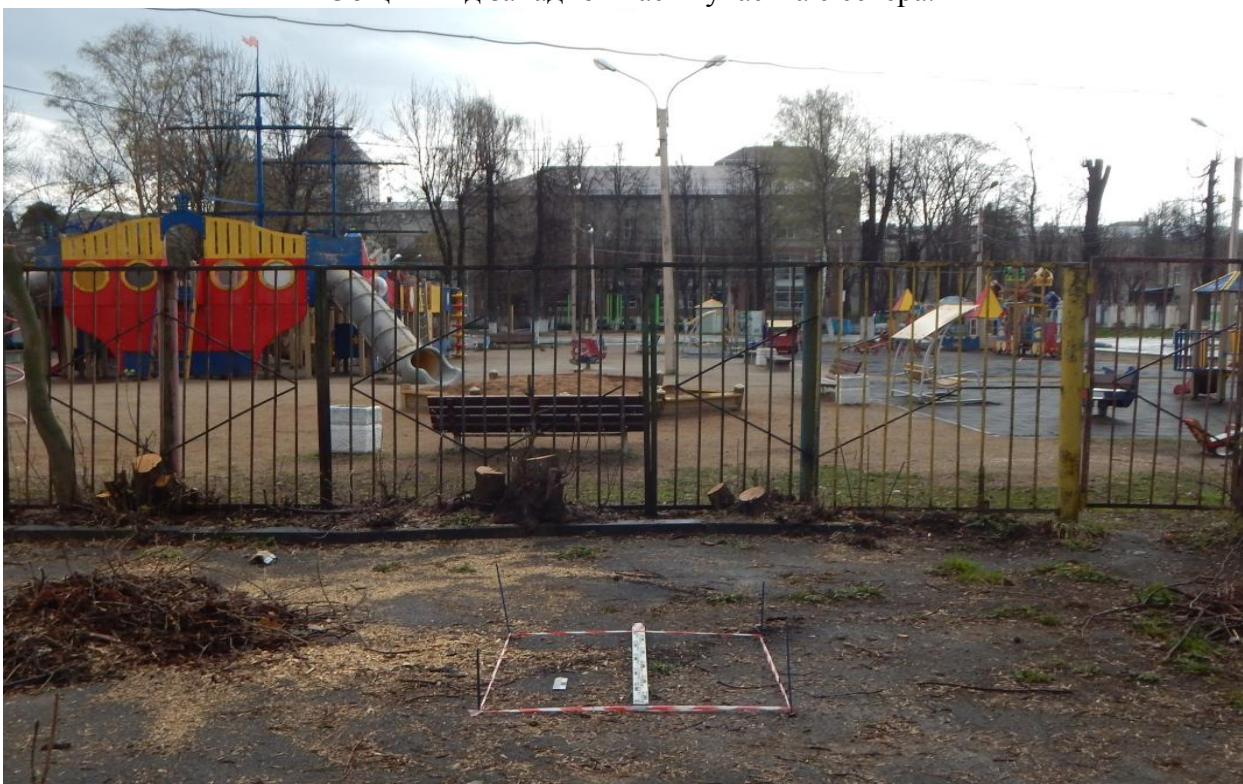
Рис. 17. г. Иваново, ул. Комсомольская, 7а, участок к/н 37:24:020115:4. Разведочный шурф, разметка и общий вид с юга.
