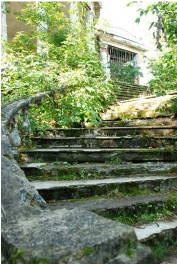
Фото 81. Общий вид с северной стороны
