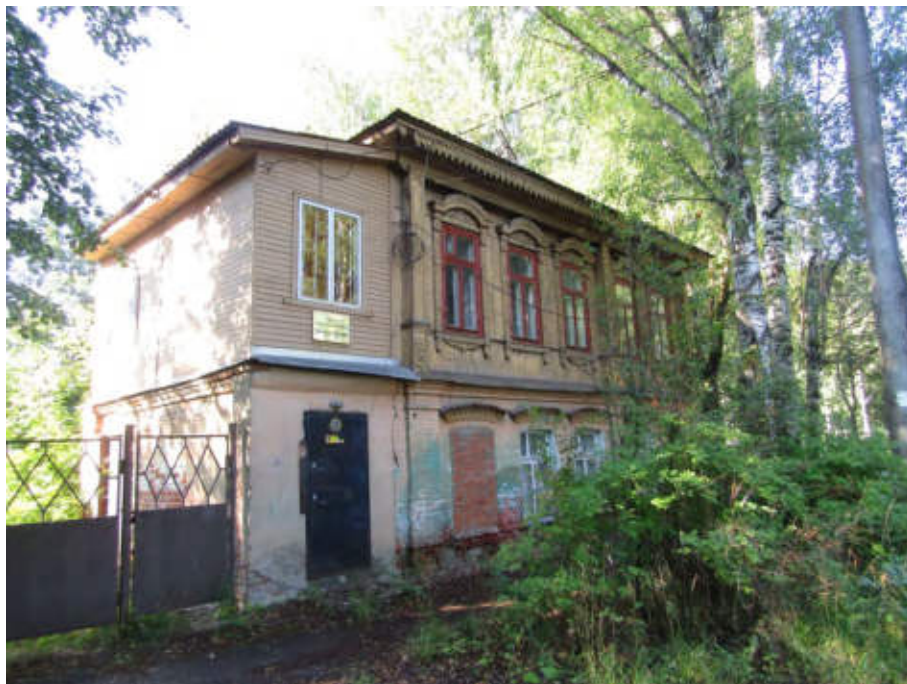
Фото 35д. Вид с западной стороны Дом № 20. При визуальном осмотре не обнаружен.
