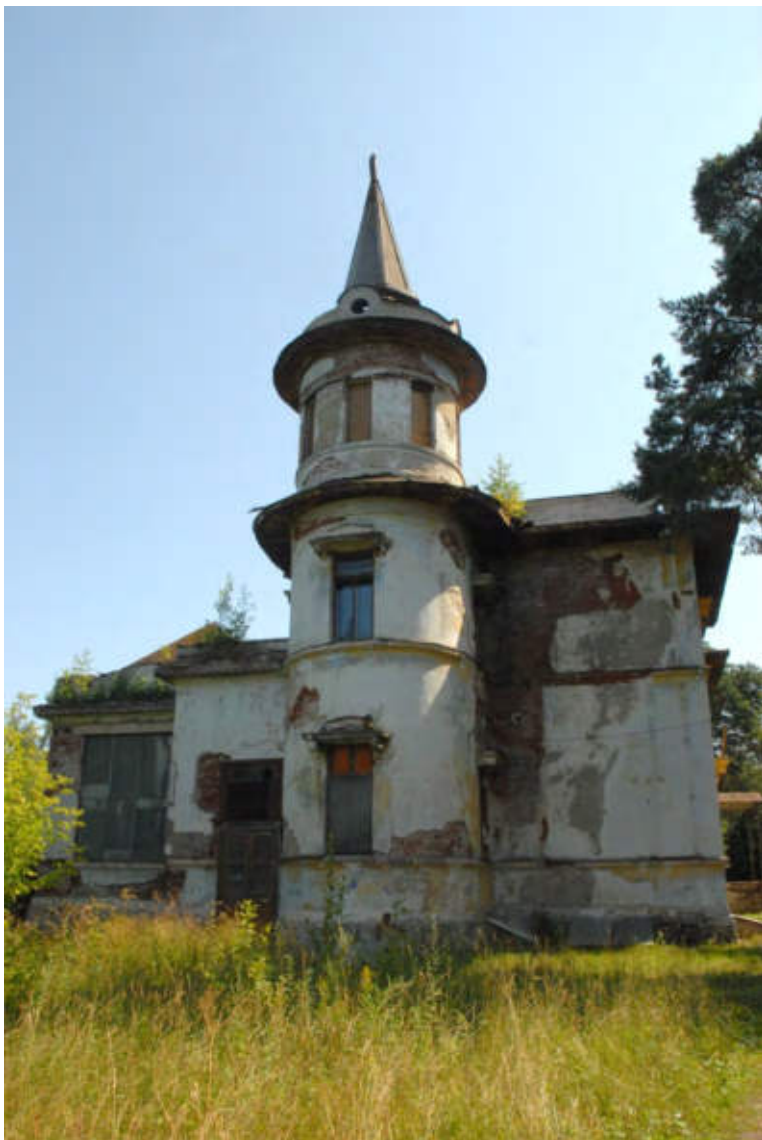
Фото 79. Общий вид с западной стороны
