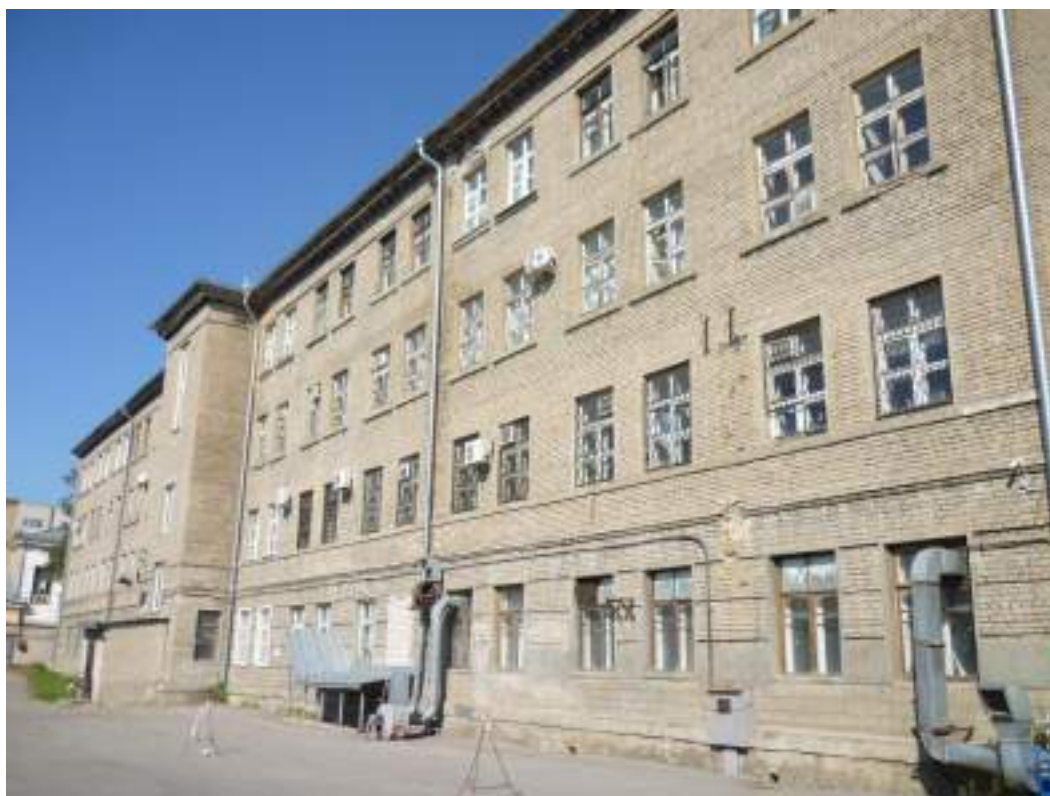
18. Общежитие (Учебный корпус № 3). Вид со двора. Фото 16.10.2023 г. А.В. Снитко
