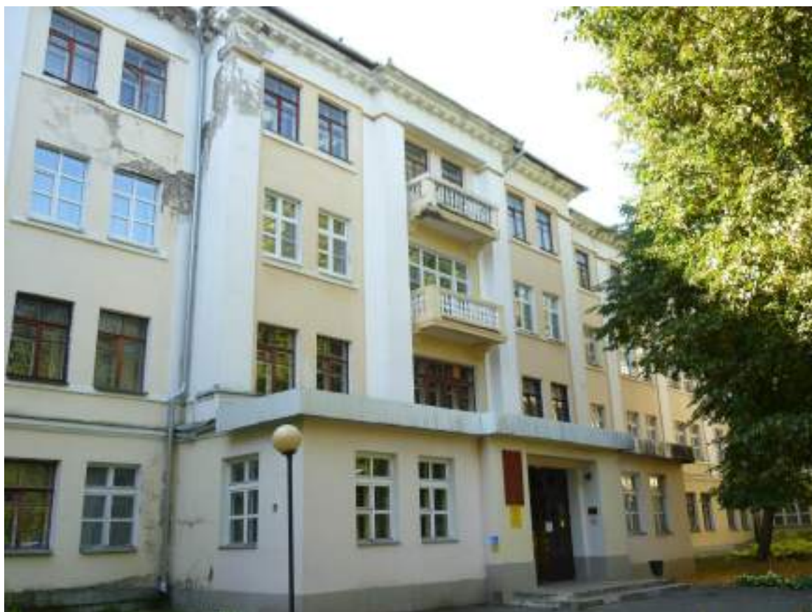
16. Общежитие (Учебный корпус № 3). Главный фасад. Фото 16.10.2023 г. А.В. Снитко
