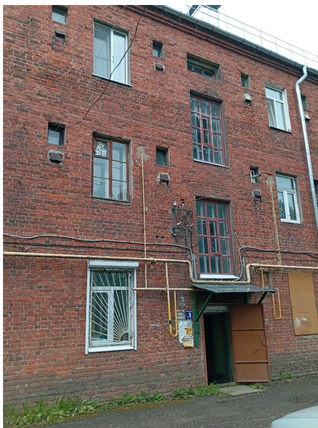
Фото 5. Здание по адресу ул. Ленинградская, д. 20. Фрагмент фасада с лестничной клеткой (межэтажные окна в центре), окнами кухонь и маленькими окнами вспомогательных помещений.
