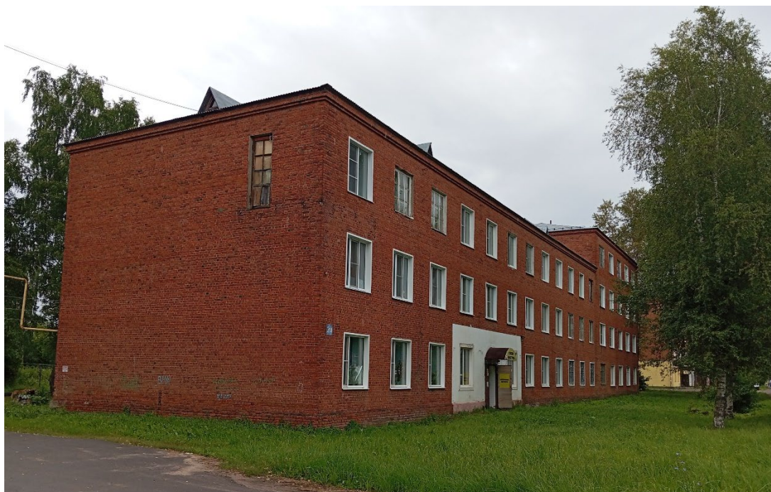
Фото 2. Здание по адресу ул, Ленинградская, д. 20.
