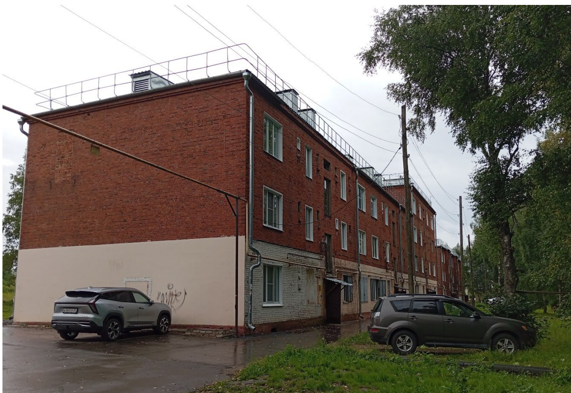
Фото 4. Здание по адресу ул, Ленинградская, д. 22.
