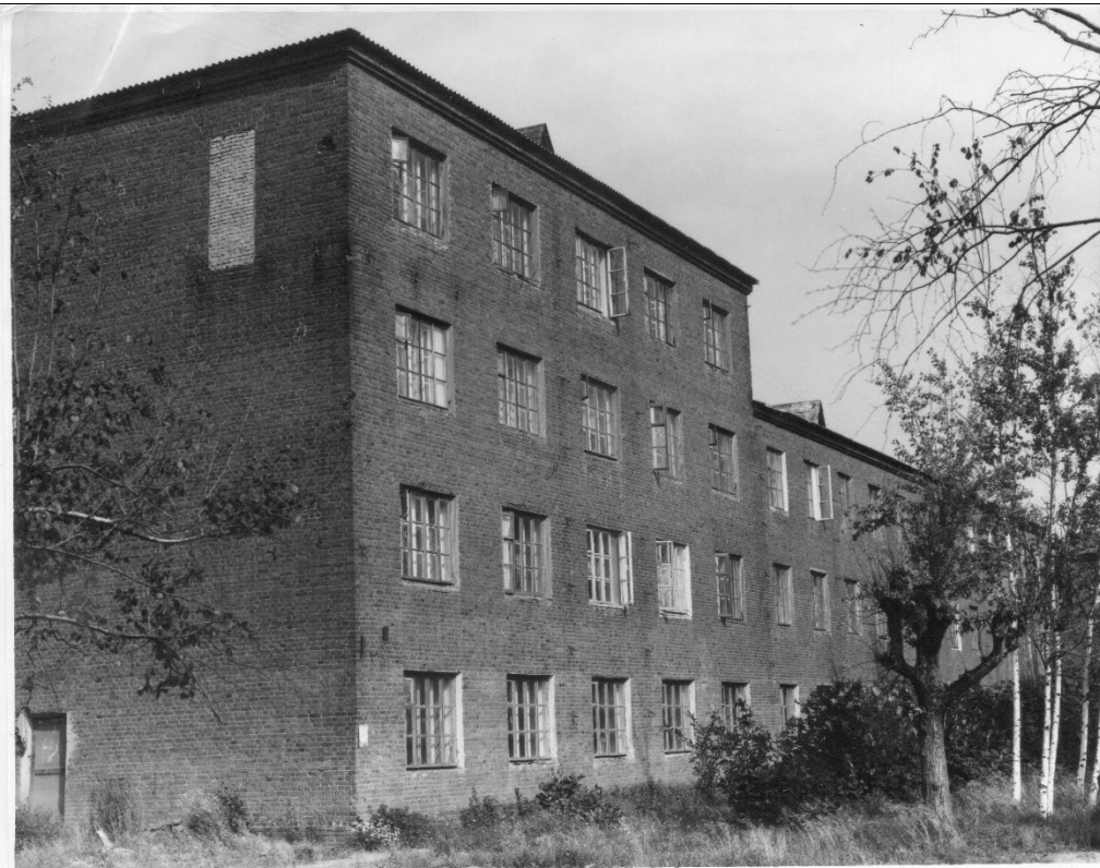
Историческая расстекловка оконных рам домов №№ 18, 20, 22
