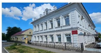
Фото 11. Главный фасад здания по улице Станко, 76 в Иваново.
