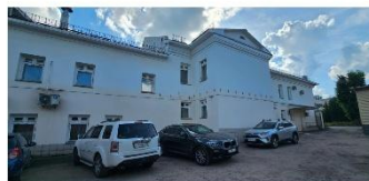
Фото 13. Боковой фасад здания по улице Станко, 76 в Иваново.
