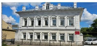
Фото 10. Главный фасад здания по улице Станко, 76 в Иваново.
