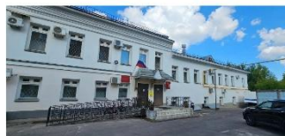
Фото 12. Боковой фасад здания по улице Станко, 76 в Иваново.
