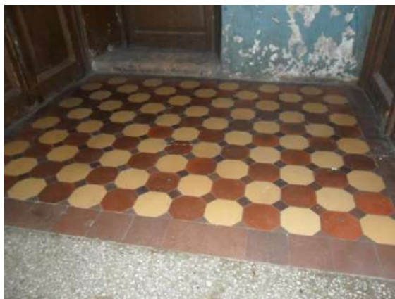
Фото 32. Плитка на 2-м этаже парадной лестницы.
