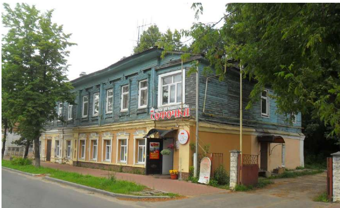
Фото 105. Главный (южный) фасад и восточный (боковой).
