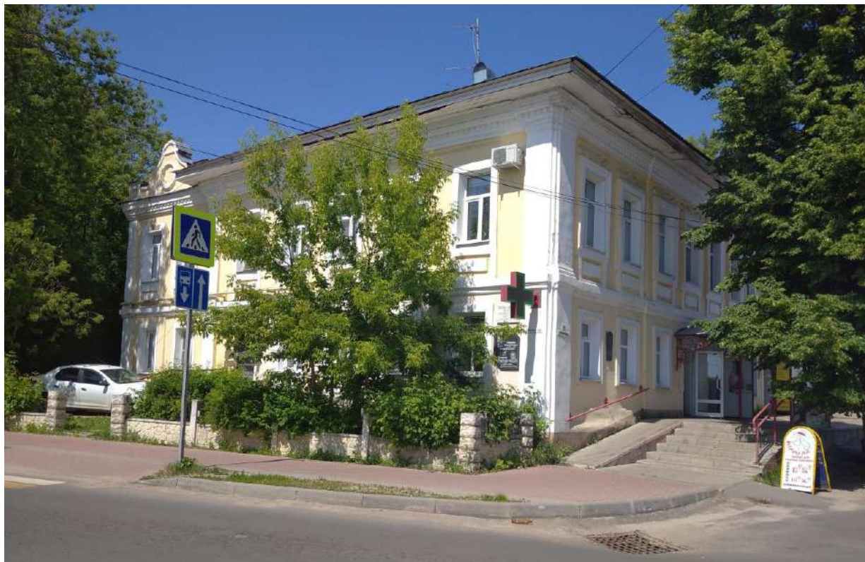
Фото 87. Фасады по ул. Комсомольской (слева от угла) и ул. Рылеевская (справа от угла)
