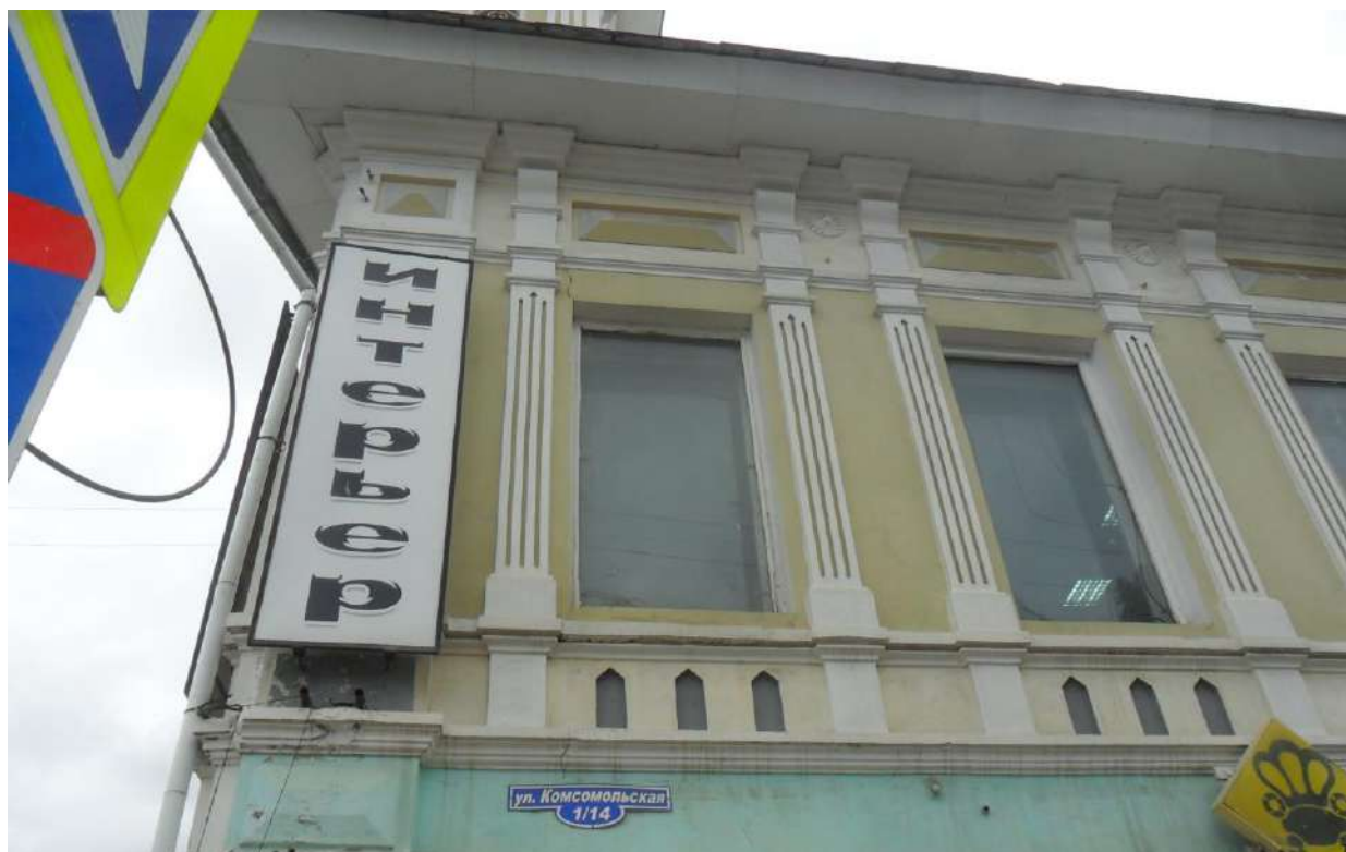
Фото. 15. Фасад здания по ул. Комсомольской. Детали декора. 2 этаж
