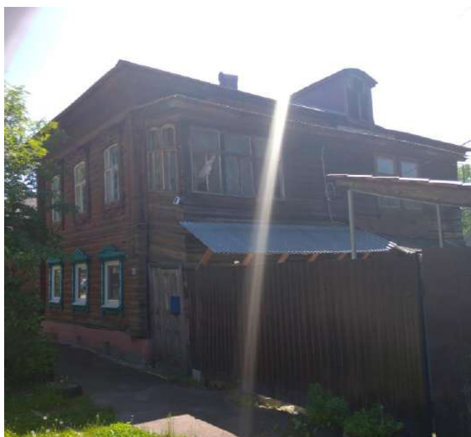
Фото 85. Главный и западный фасады.
