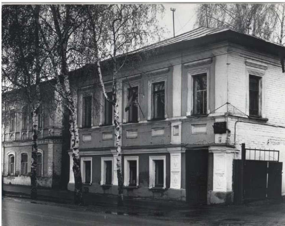
Фото 116. Дом № 18. Главный фасад. Фото 1988 г.
