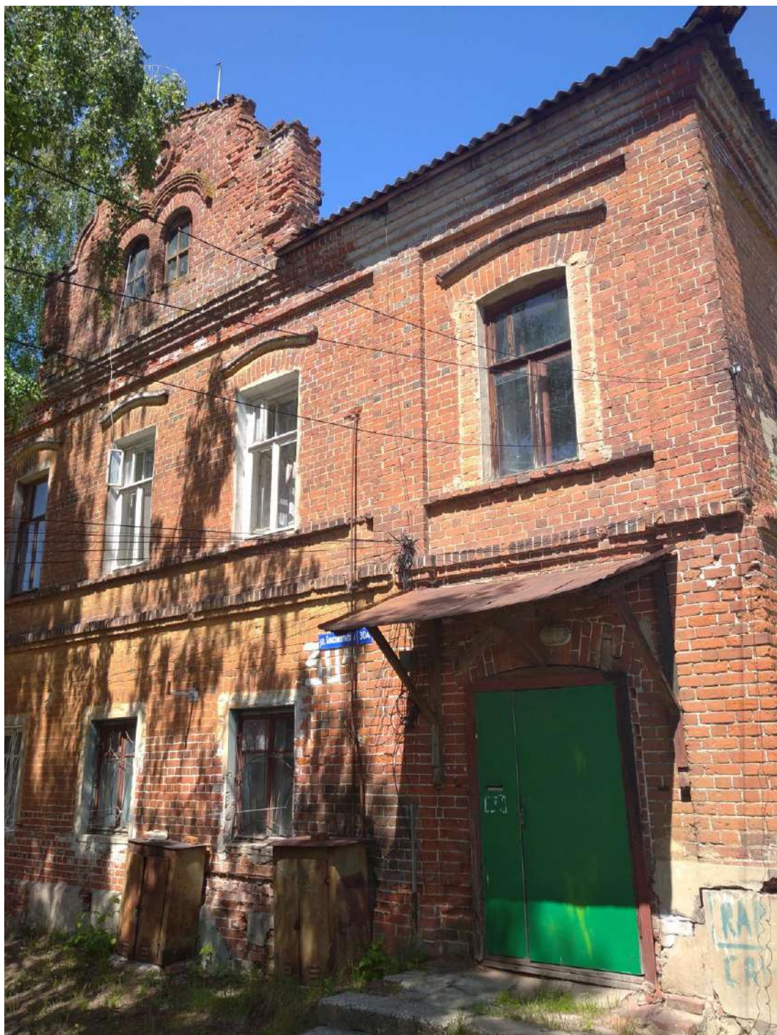
Фото 168. Фрагмент южного фасада
