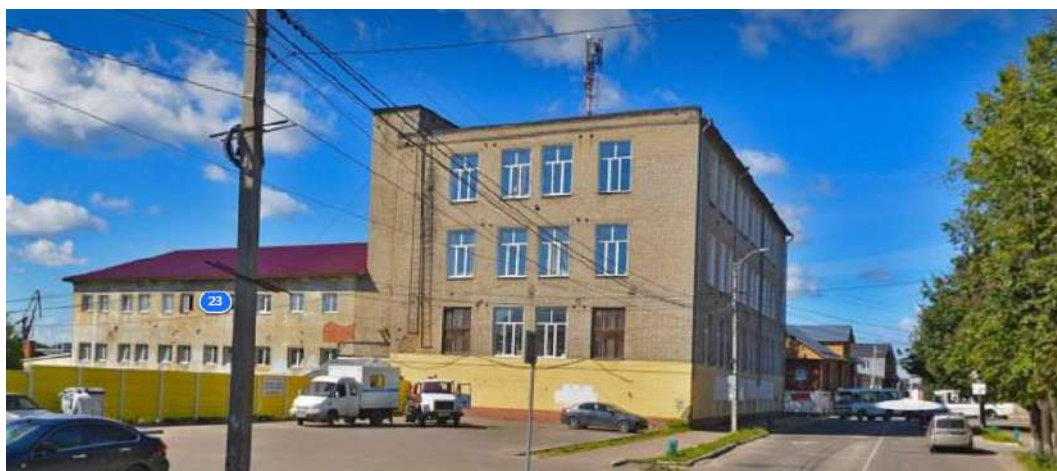
Фото 8. Ул. Комсомольская. Швейная фабрика (дом № 23). Яндекс фото
