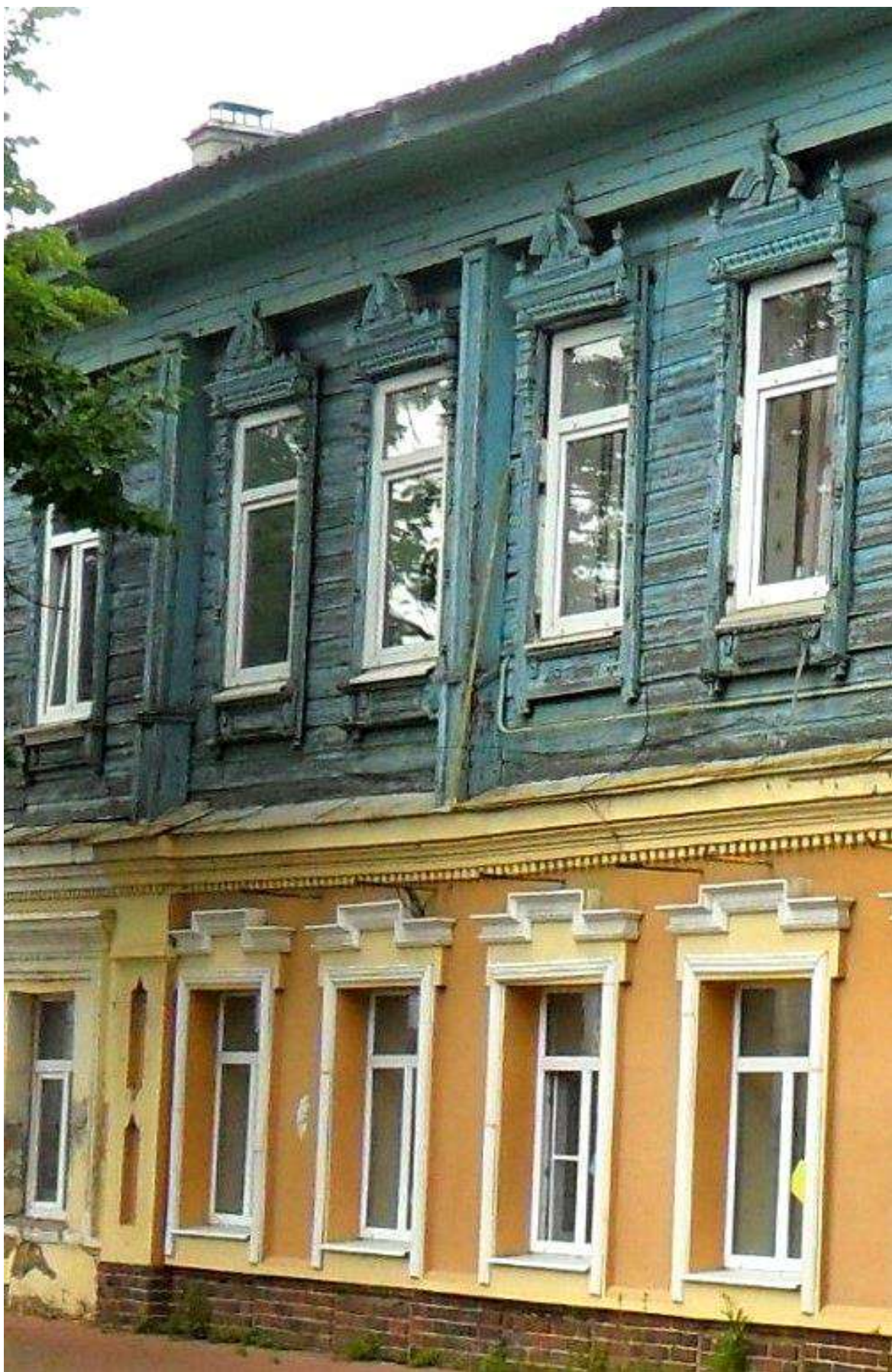
Фото 107. Фрагмент главного фасада.
