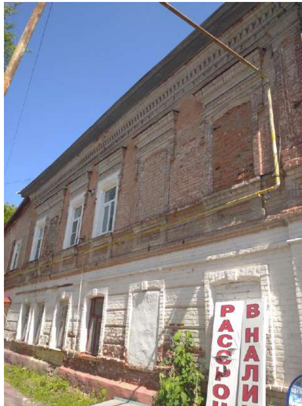
Фото 100. Боковой (западный) фасад.
