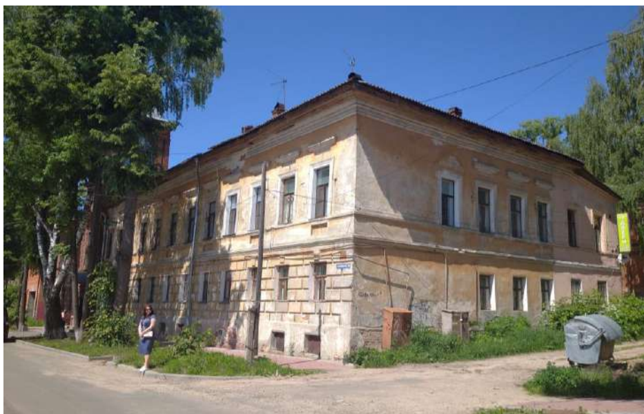
Фото 145. Здание № 30 по ул. Комсомольской. Старый блок. Главный (южный) фасад и восточный (боковой)
