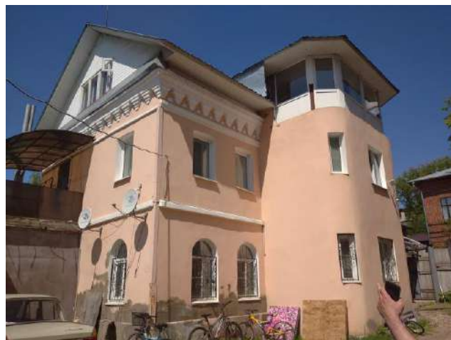
Фото 77. Восточный и южный фасады.
