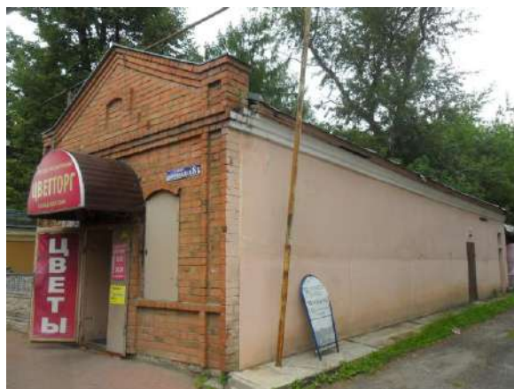
Фото 103. Флигель по улице. Современное фото
