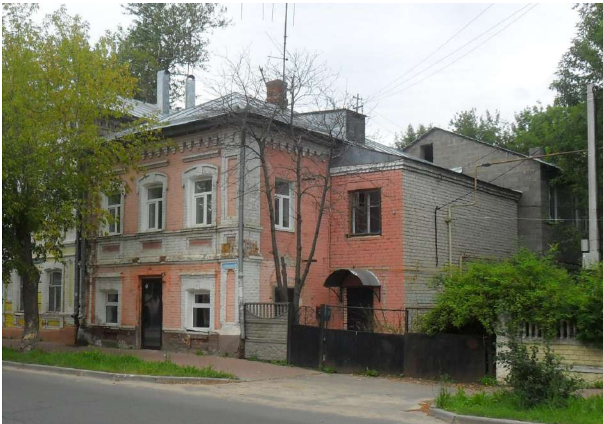
Фото 97. Общий вид здания. Южный и восточный фасады.
