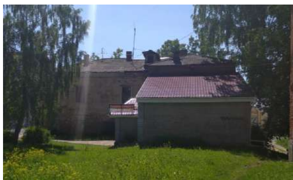
Фото 138. Вид задних фасадов со двора.
