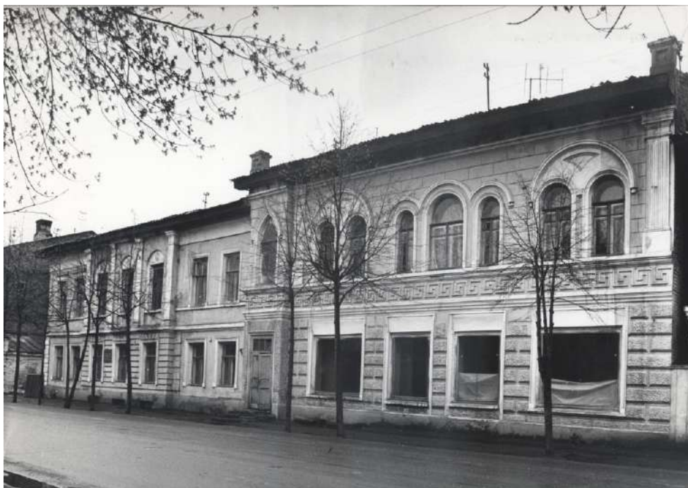
Фото 19. Вид на здание с улицы Комсомольской, 1988 г.
