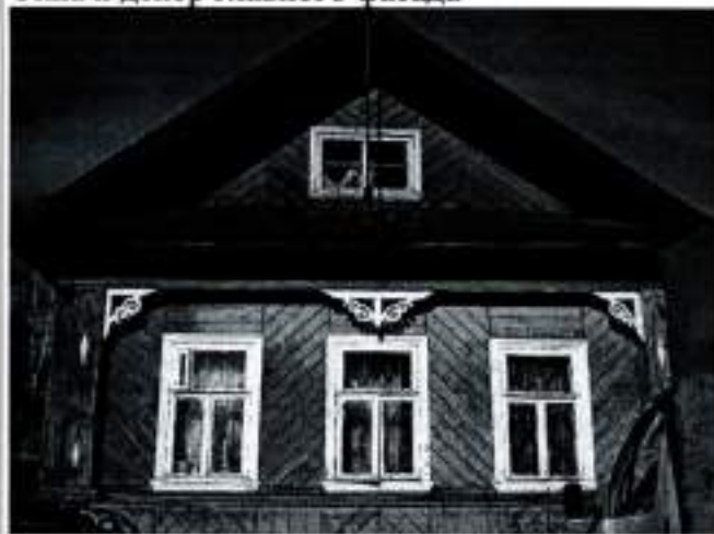
Окна и декор главного фасада
