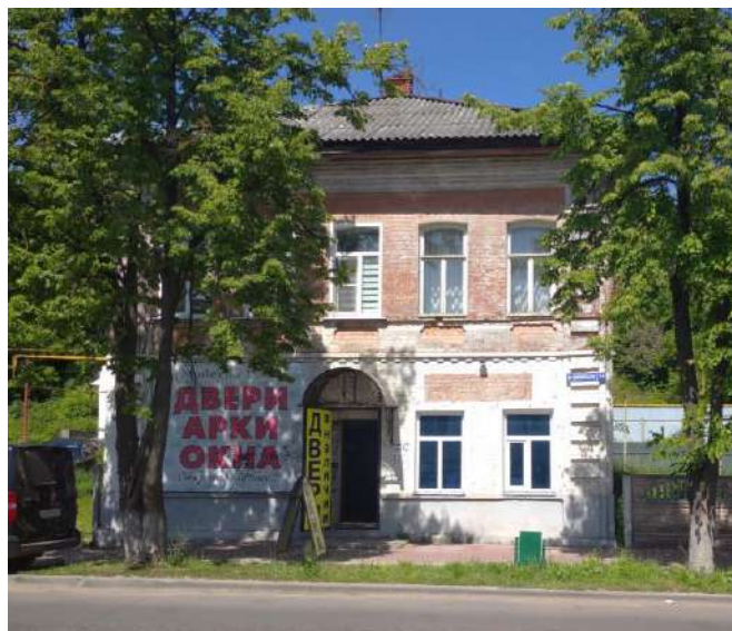
Фото 109. Фасад по ул. Комсомольской (главный).
