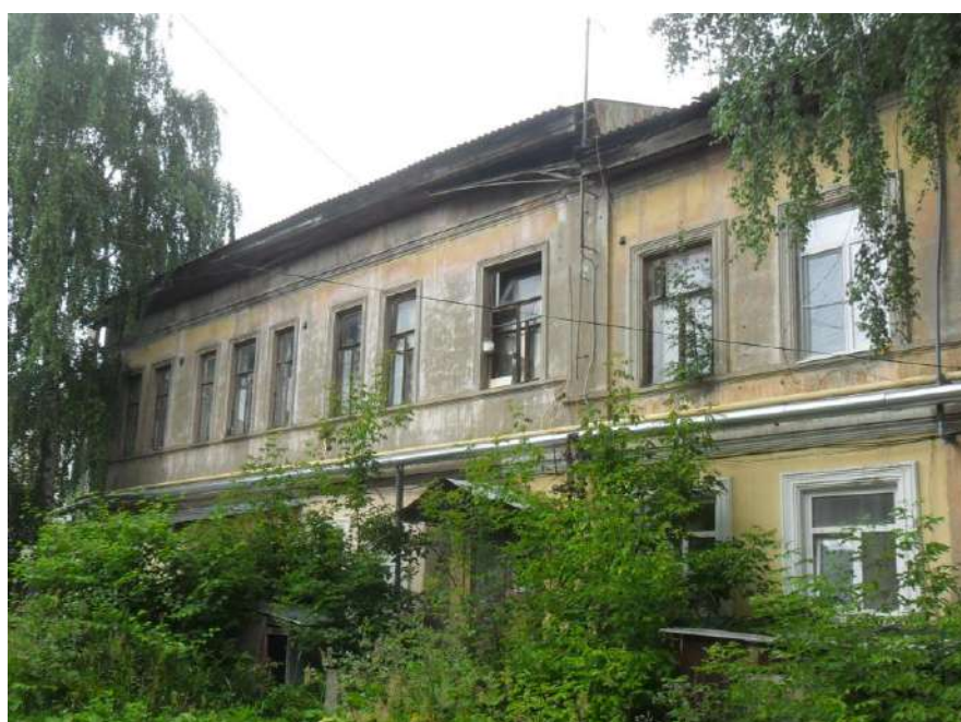
Фото 20. Задний фасад западной части здания.
