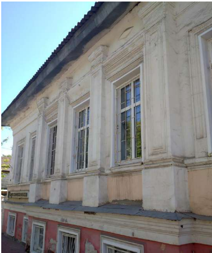
Фото 54. Главный фасад. Портик.
