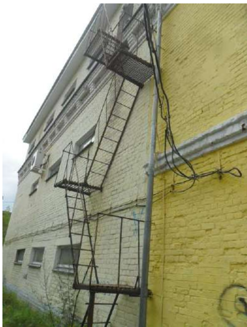
Фото 67. Стык исторической и новой (из силикатного кирпича) частей на восточном фасаде.
