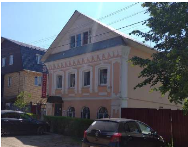
Фото 76. Главный и западный фасады.
