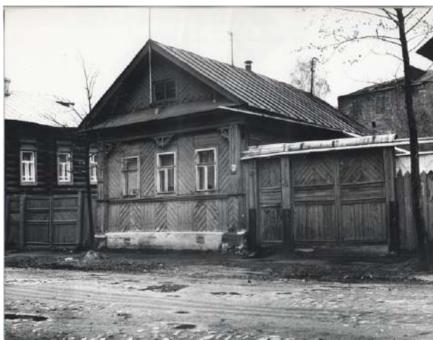
Фото 174. Общий вид здания в 1988 г.
