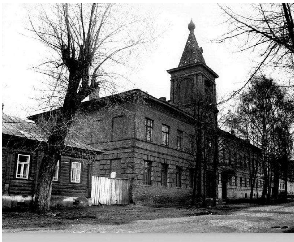
Фото 6. Здание бывшего духовного училища. На дороге ещё сохранилась брусчатка. 1988 г.
