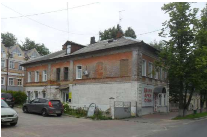
Фото 110. Боковой западный фасад.
