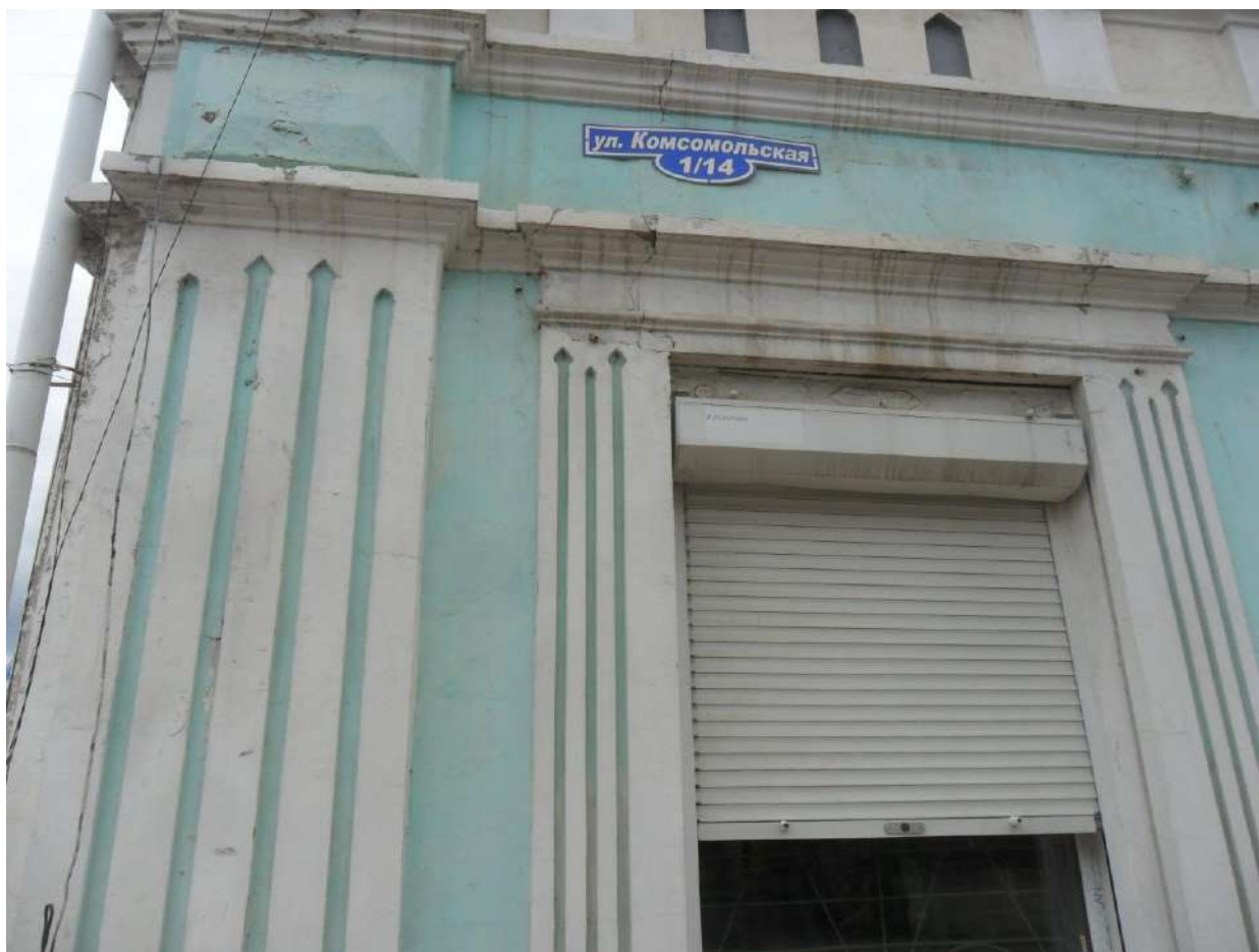
Фото. 14. Фасад здания по ул. Комсомольской. Детали декора. 1 этаж.
