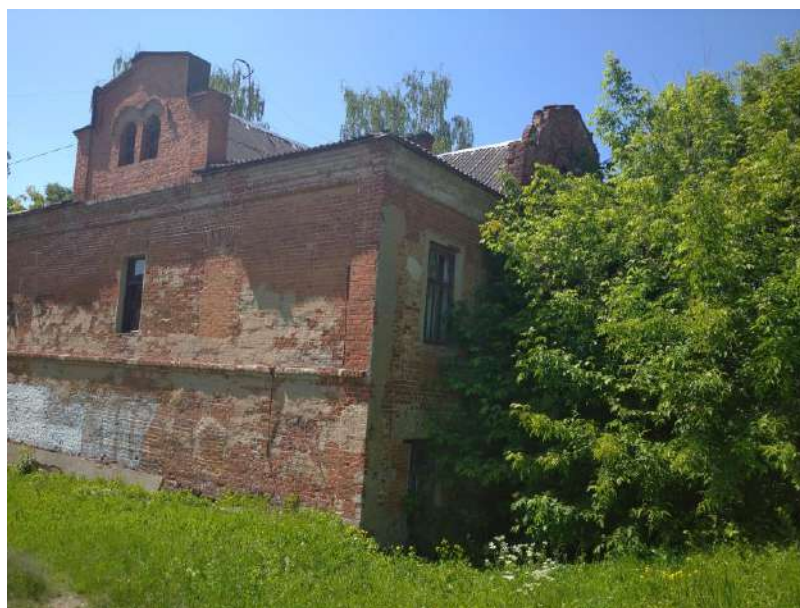
Фото 167. Вид на восточный и северный фасады.
