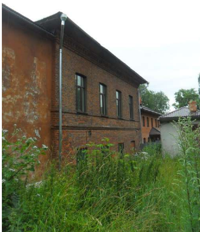
Фото 150. Задний фасад нового блока
