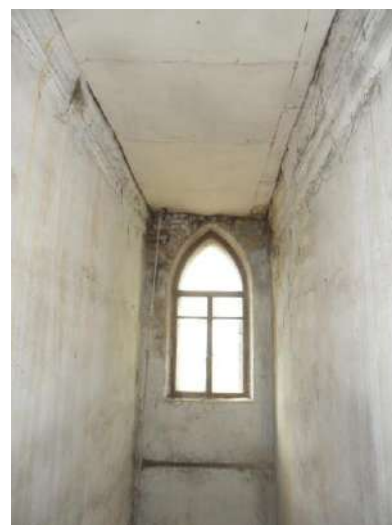
Фото 35. Окно в лестничной клетке
