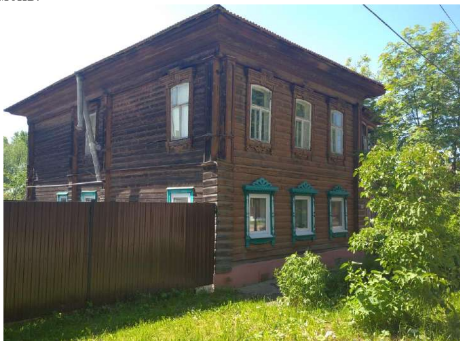
Фото 84. Главный и восточный фасады.
