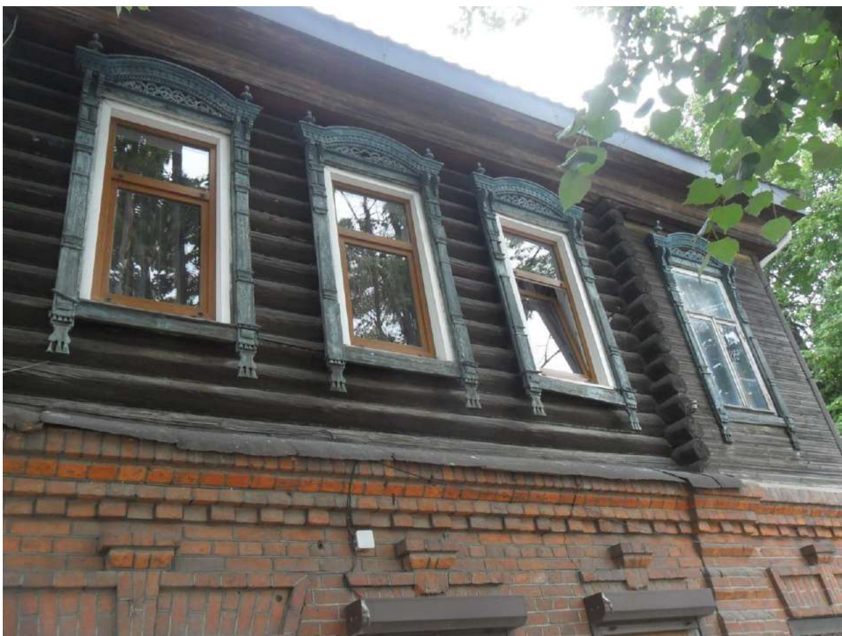
Фото 126. Фрагмент главного фасада
