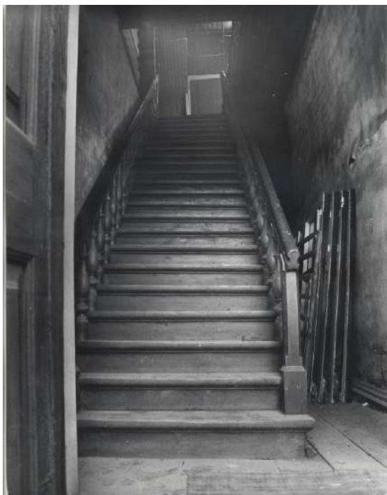
Фото 130. Лестница. Вид с 1 этажа. Фото 1988 г.
