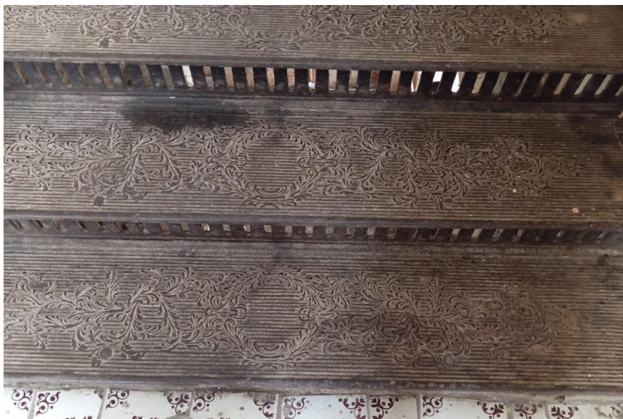
Фото 17. Проступи металлических лестниц.
