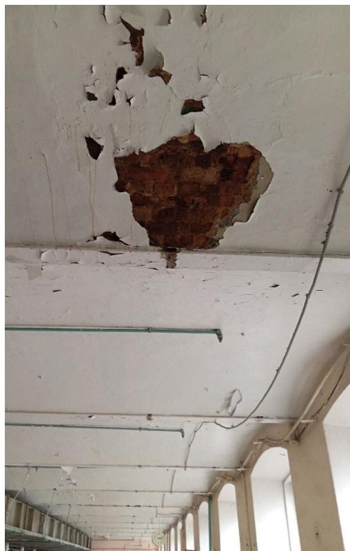
Фото 12. Кирпичные своды по металлическим балкам
