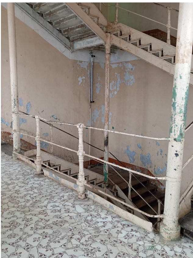
Фото 16. Металлическая лестница в башне.
