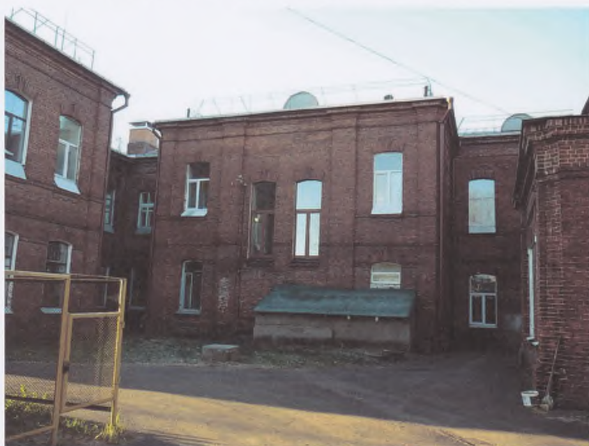
7. Главный корпус. Вид со двора.
