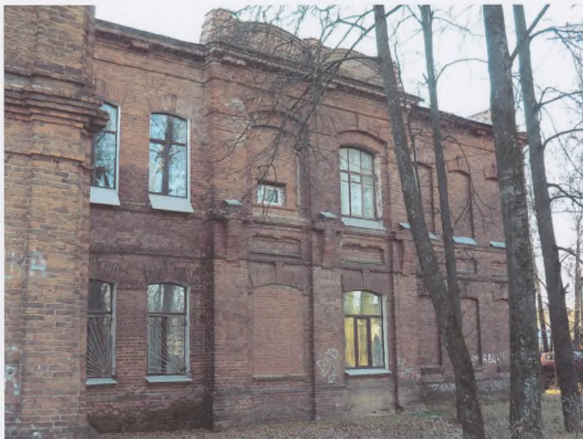
6. Главный корпус. Вид с северо-запада.
