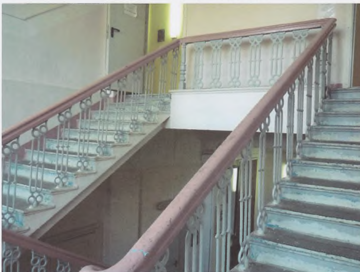
15 Главный корпус. Центральная лестница.
