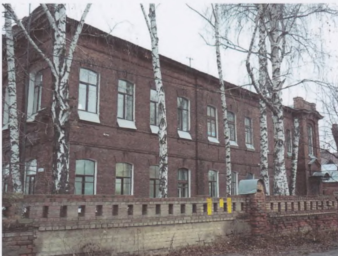
5. Главный корпус. Вид с юга.
