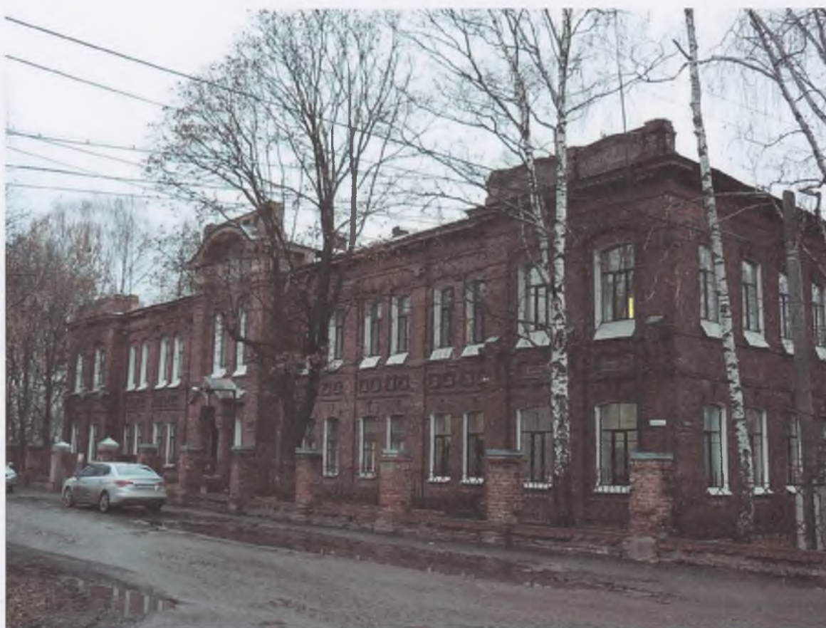
1. Главный корпус. Главный фасад.
