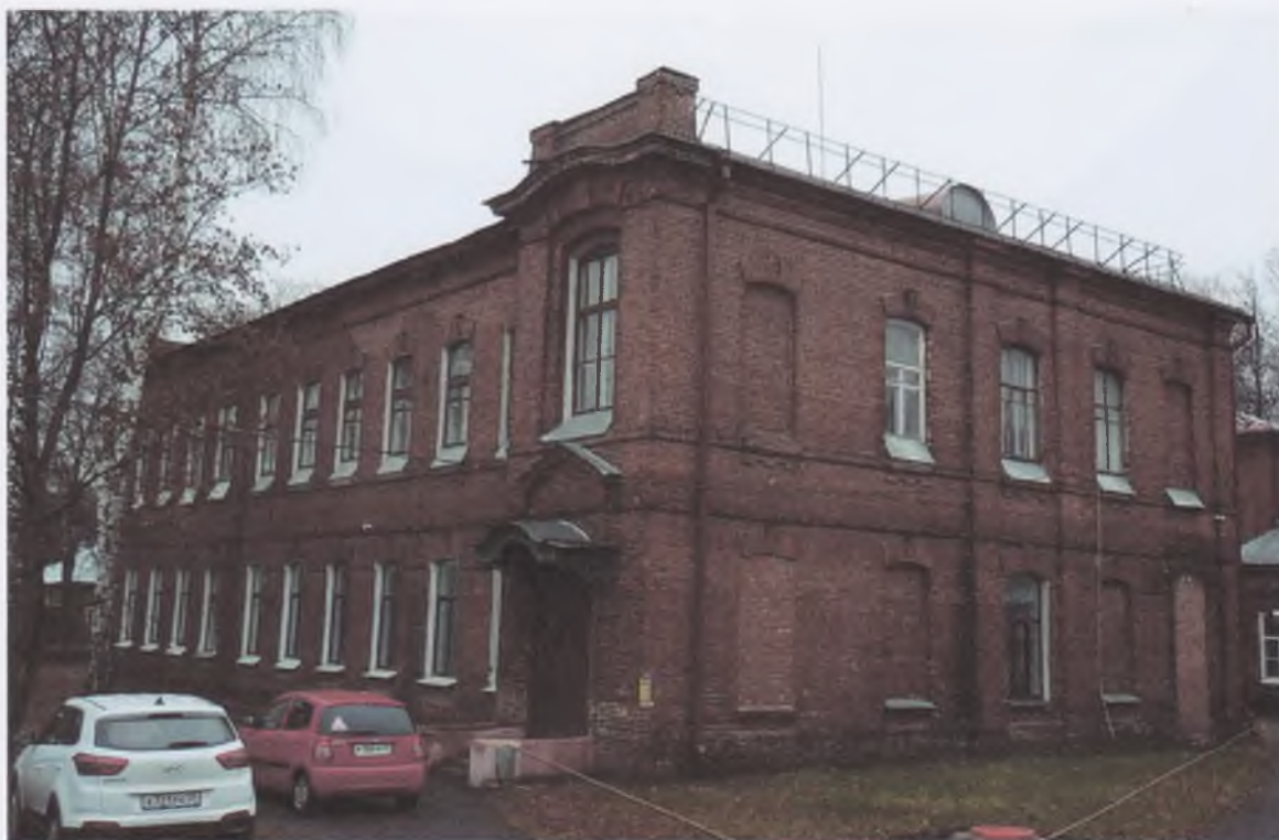
4. Главный корпус. Вид с востока.
