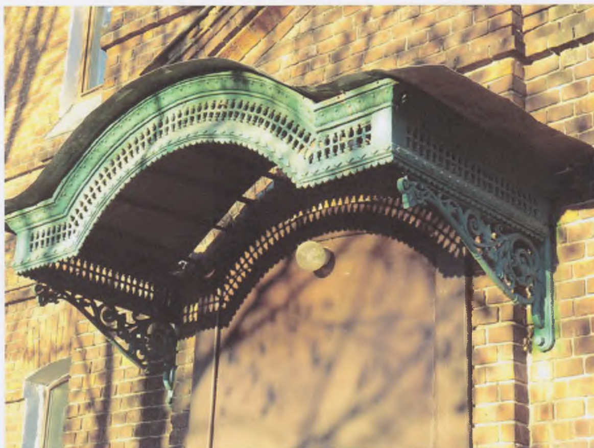
12. Чугунный навес над входом на юго-восточном фасаде.
