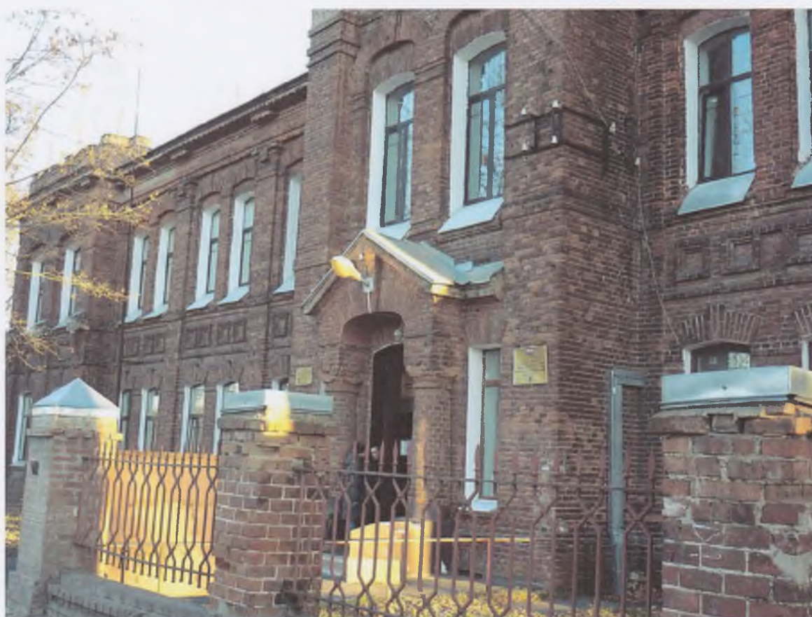
2. Главный корпус. Фрагмент главного фасада.
