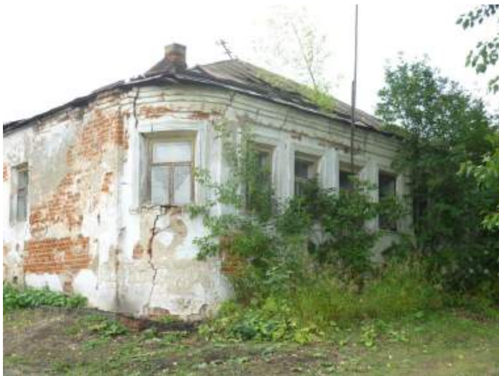
21. Жилой дом А.И. Медникова (Нижняя Березовка ул., д. 3).
