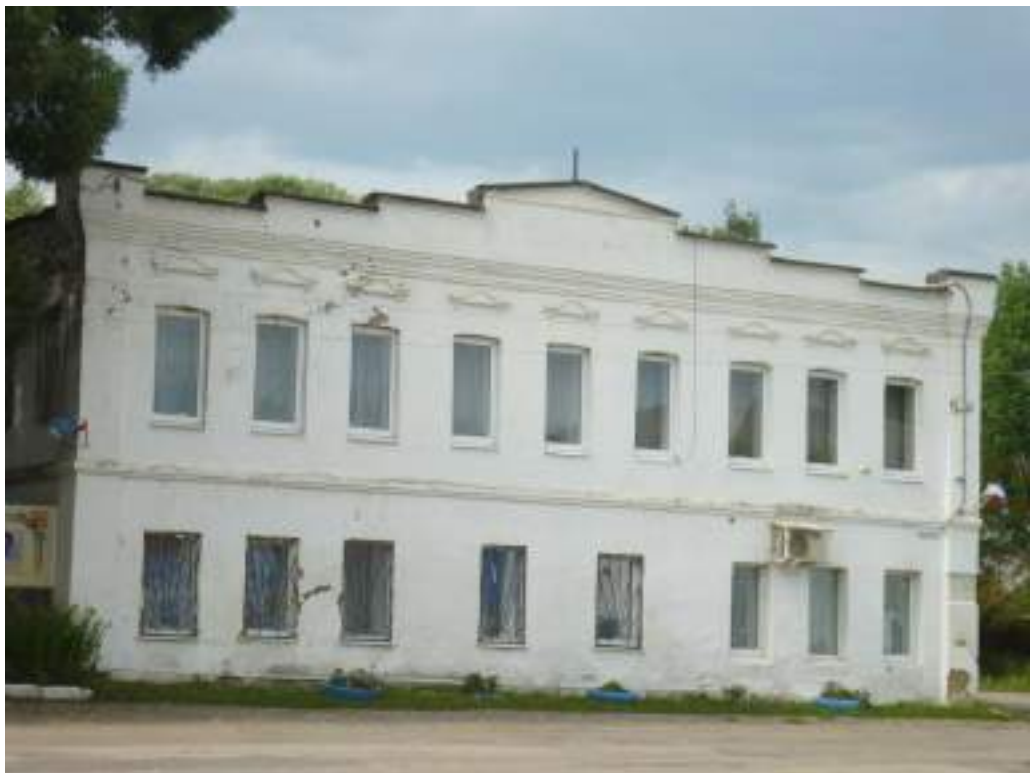
12. Жилой дом (Ленинская ул., д. 2).
