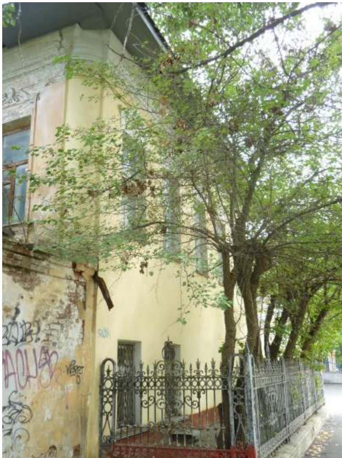
5. Дом Н.Х. Бурьиной. (Ул. Арсения, д. 35А). Вид с запада.
