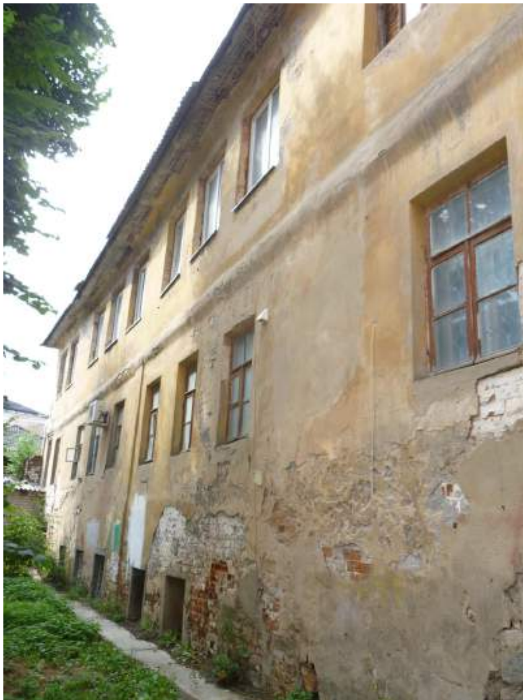
10. Набойный корпус. (Ул. Садовая, д. 30А). Вид с северо-востока.
