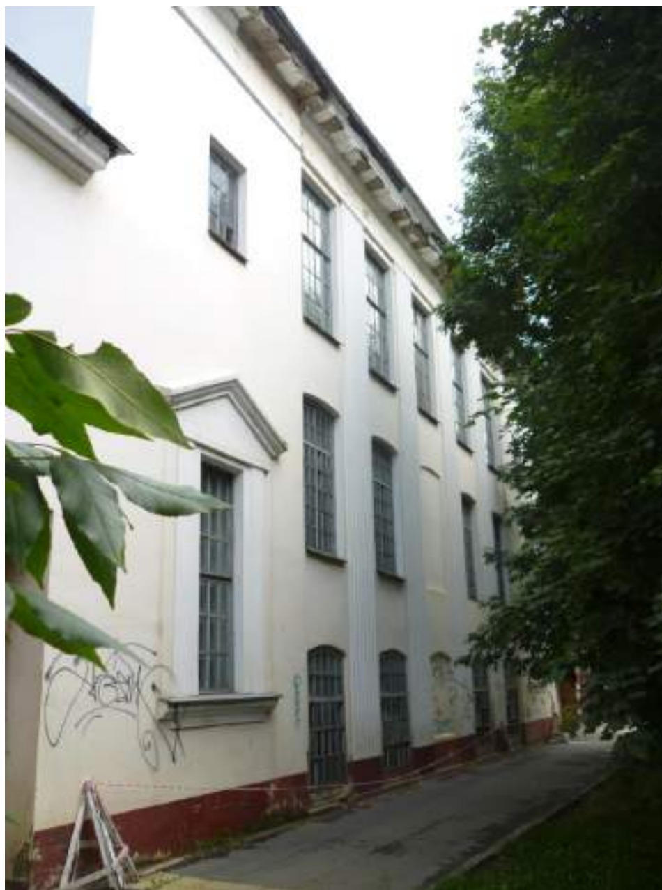
13. Складской корпус (Ул. Арсения, д. 43Б) Вид с запада.
