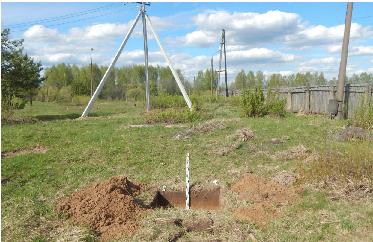
Рис. 62. г. Шуя, Северный Тракт, 114. з/у 37:28:010222:1. Общий вид выкопанного шурфа № 7 с юга.
