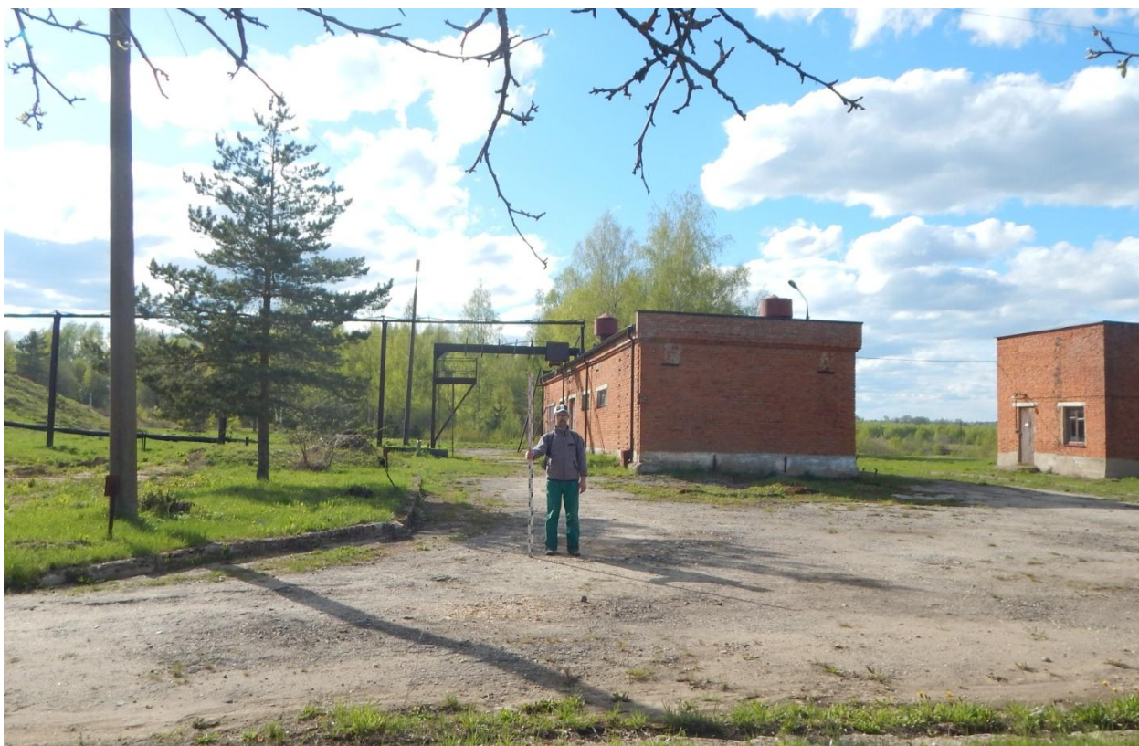
Рис. 15. г. Шуя, Северный Тракт, 114. з/у 37:28:010222:1. Общий вид с востока на центральную часть участка, точка фотофиксации 4.
