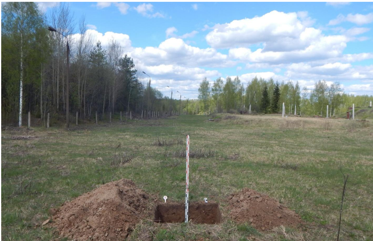
Рис. 54. г. Шуя, Северный Тракт, 114. з/у 37:28:010222:1. Общий вид выкопанного шурфа № 5 с юга.
