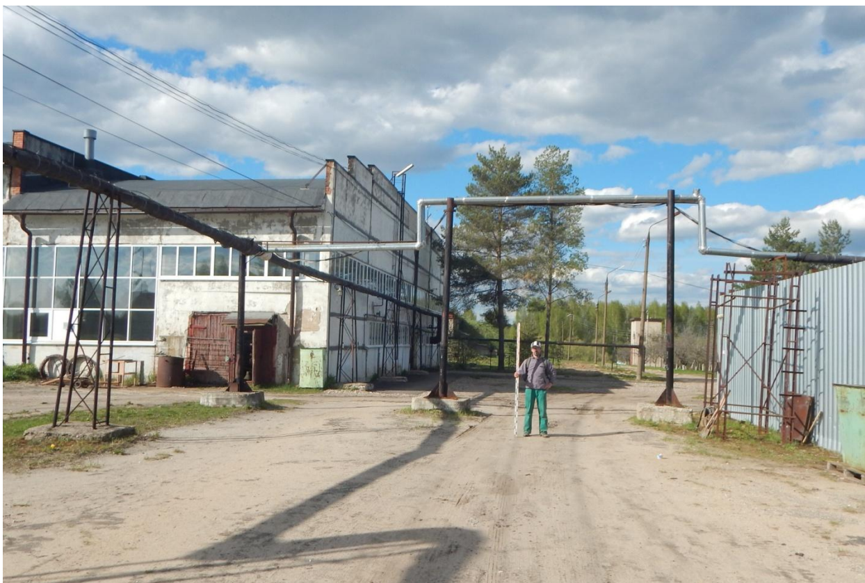
Рис. 12. г. Шуя, Северный Тrakt, 114. з/у 37:28:010222:1. Общий вид с юга от входной зоны участка, точка фотофиксации 1.
