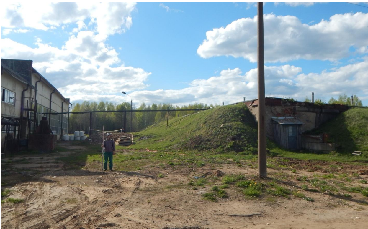
Рис. 14. г. Шуя, Северный Тракт, 114. з/у 37: 37:28:010222:1. Общий вид с востока на центральную часть участка, точка фотофиксации 3.
