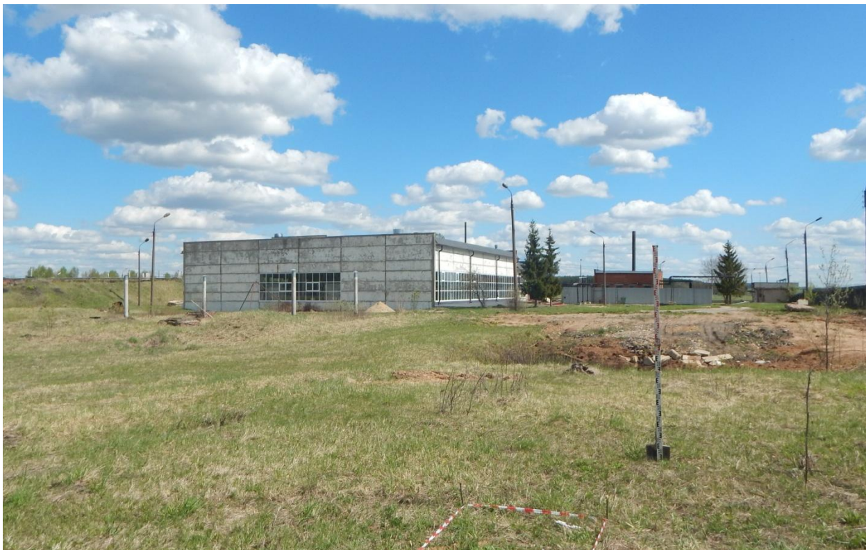
Рис. 30. г. Шуя, Северный Тракт, 114. з/у 37:28:010222:1. Общий вид с запада вдоль южной границы участка, точка фотофиксации 11.
