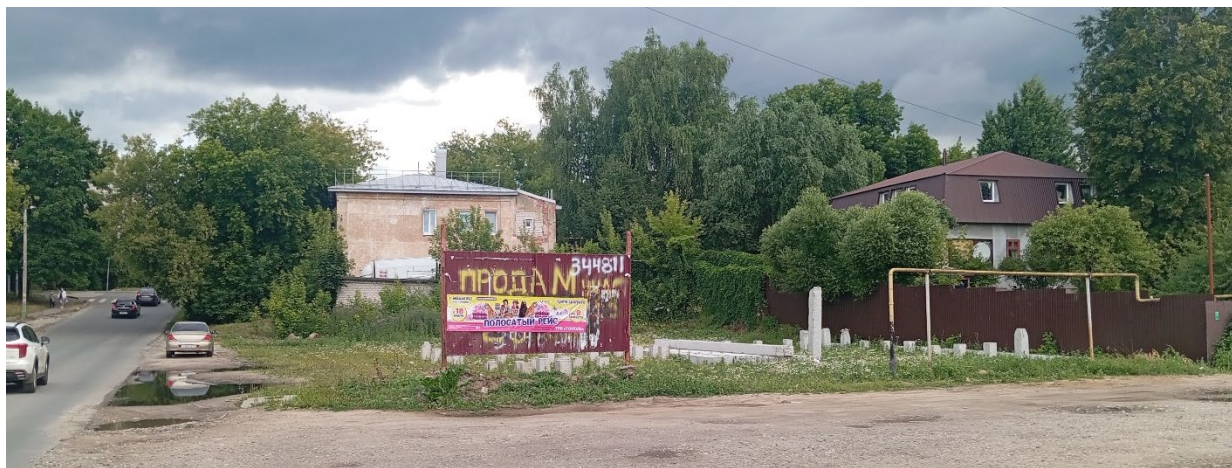
Фото 9. Общий вид территории строительства.
