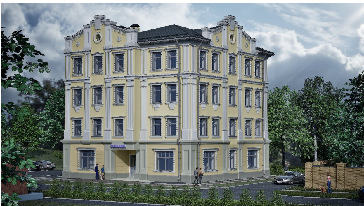
Рис. 6. Вид здания со стороны ул.Багаева.
