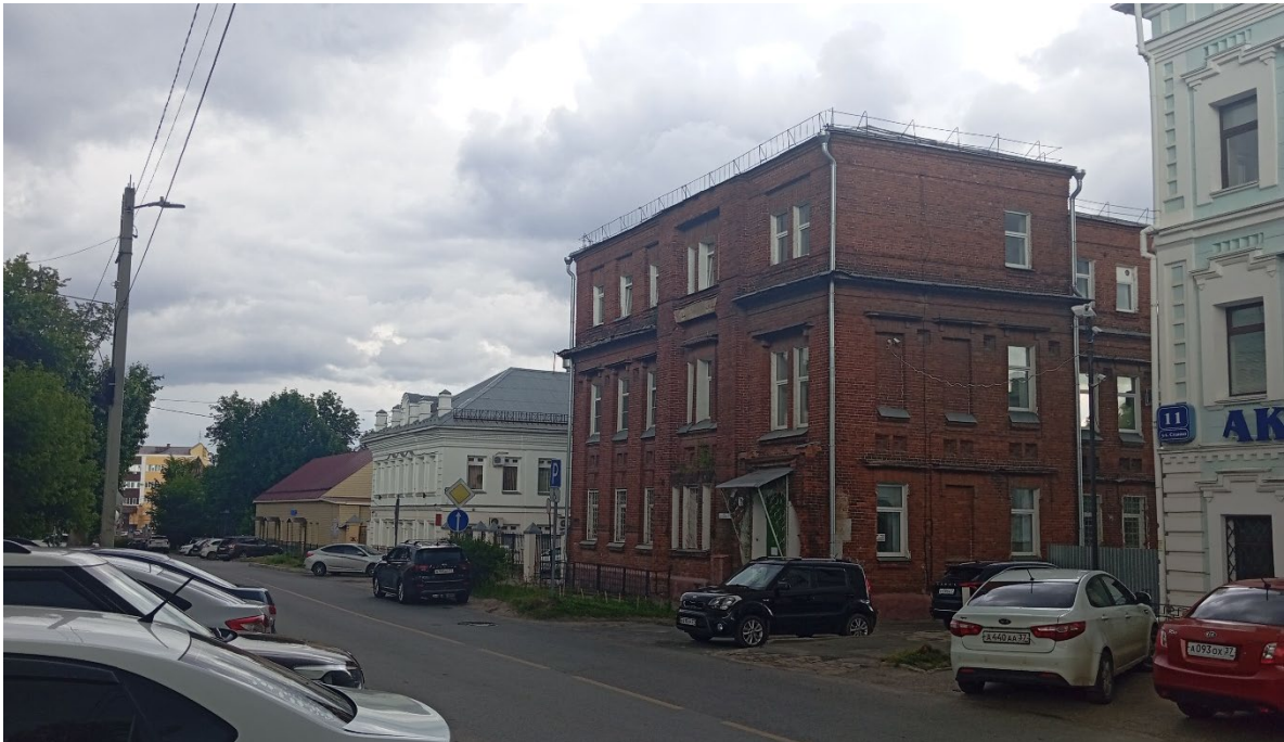
Фото 4. Участок улицы от ул. Варенцовой до ул. Багаева
