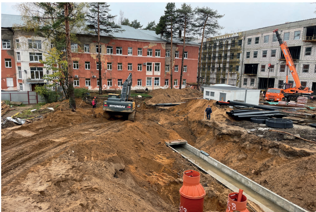
Рис. 16. Объект: «Строительство водогрейной котельной 400Гкал/час на территории Ивановской ТЭЦ-2», расположенной по адресу: РФ, Ивановская обл., г. Иваново, ул. Суворова, 76. Вид из тф 1 на Ю.
