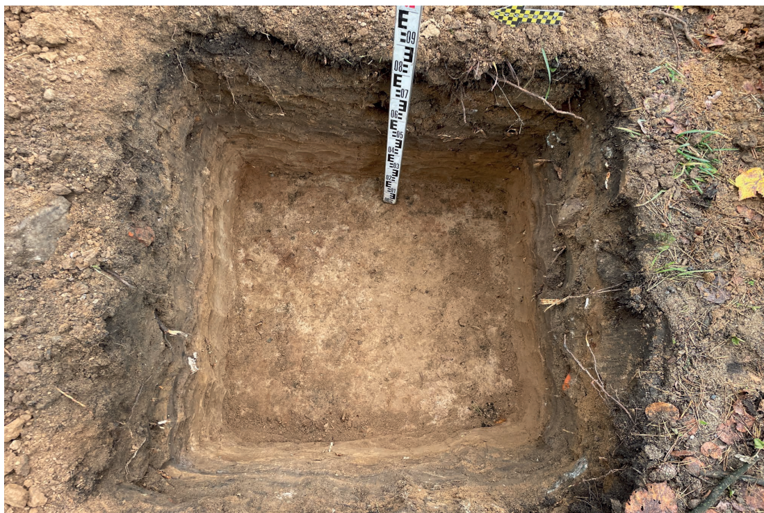
Рис. 30. Объект: «Строительство водогрейной котельной 400Гкал/час на территории Ивановской ТЭЦ-2», расположенной по адресу: РФ, Ивановская обл., г. Иваново, ул. Суворова, 76. Вид на дно шурфа 3.
