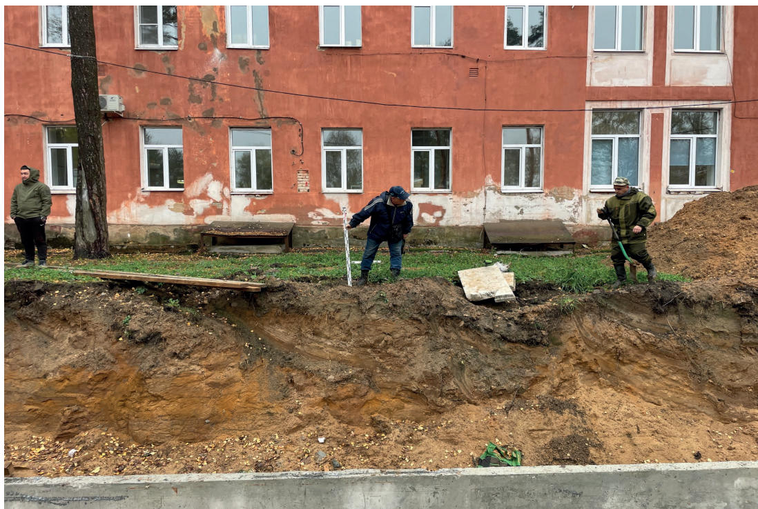
Рис. 24. Объект: «Строительство водогрейной котельной 400Гкал/час на территории Ивановской ТЭЦ-2», расположенной по адресу: РФ, Ивановская обл., г. Иваново, ул. Суворова, 76. Вид с С на разбивку шурфа 2.
