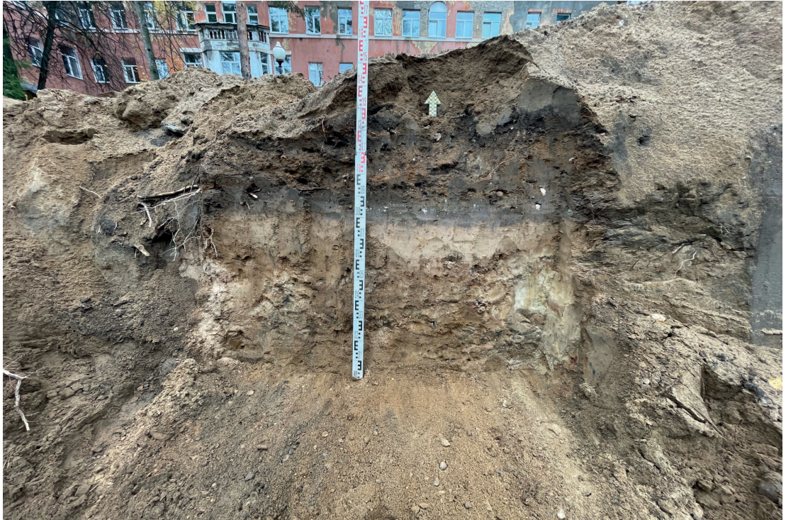
Рис. 36. Объект: «Строительство водогрейной котельной 400Гкал/час на территории Ивановской ТЭЦ-2», расположенной по адресу: РФ, Ивановская обл., г. Иваново, ул. Суворова, 76. Вид с Ю на зачистку 2.
