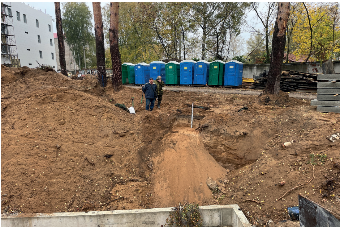
Рис. 22. Объект: «Строительство водогрейной котельной 400Гкал/час на территории Ивановской ТЭЦ-2», расположенной по адресу: РФ, Ивановская обл., г. Иваново, ул. Суворова, 76. Общий вид на шурф 1.
