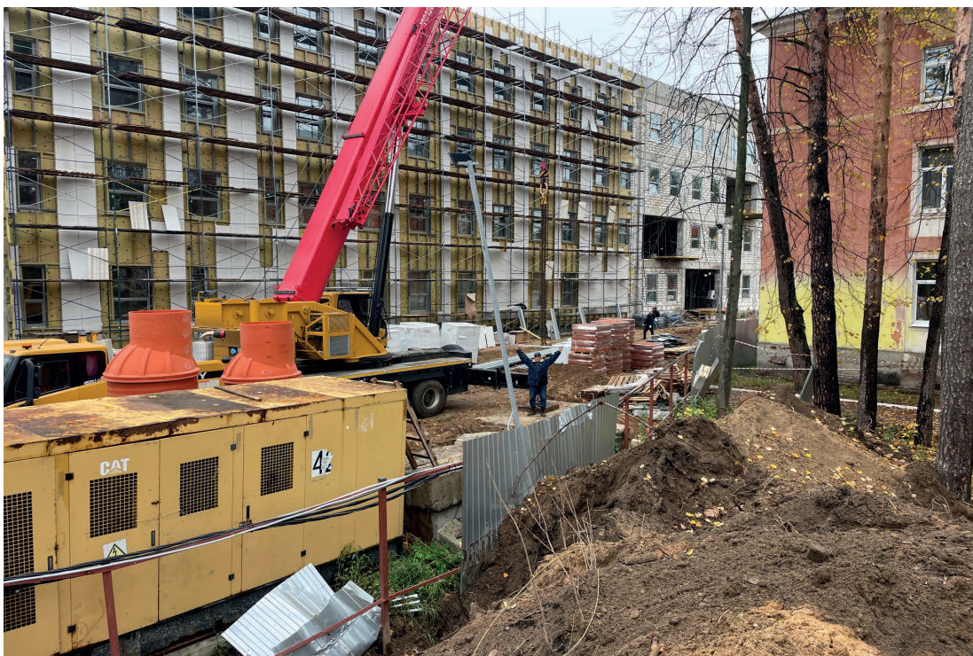
Рис. 19. Объект: «Строительство водогрейной котельной 400Гкал/час на территории Ивановской ТЭЦ-2», расположенной по адресу: РФ, Ивановская обл., г. Иваново, ул. Суворова, 76. Вид из тф 2 на 3.
