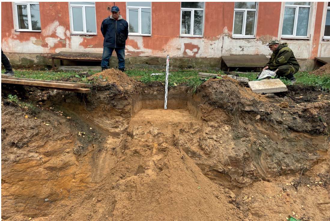
Рис. 26. Объект: «Строительство водогрейной котельной 400Гкал/час на территории Ивановской ТЭЦ-2», расположенной по адресу: РФ, Ивановская обл., г. Иваново, ул. Суворова, 76. Общий вид с С на шурф 2.
