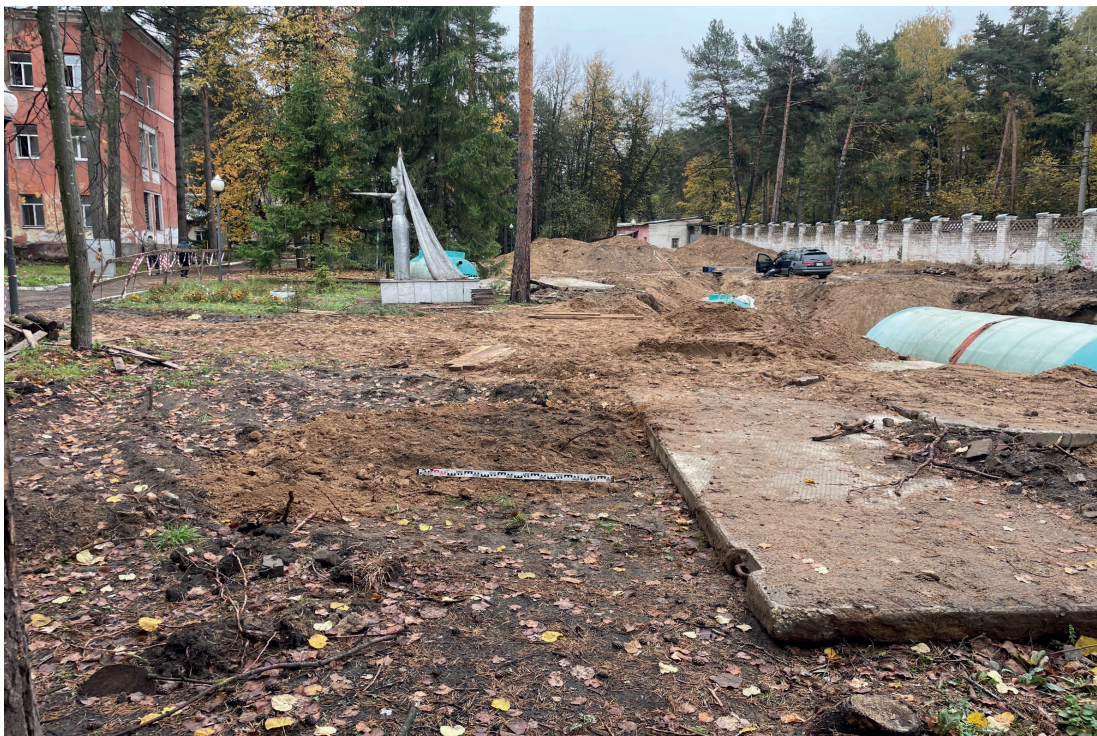
Рис. 32. Объект: «Строительство водогрейной котельной 400Гкал/час на территории Ивановской ТЭЦ-2», расположенной по адресу: РФ, Ивановская обл., г. Иваново, ул. Суворова, 76. Вид с З на рекультивацию шурфа 3.
