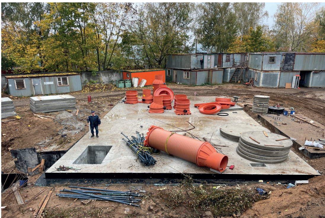
Рис. 14. Объект: «Строительство водогрейной котельной 400Гкал/час на территории Ивановской ТЭЦ-2», расположенной по адресу: РФ, Ивановская обл., г. Иваново, ул. Суворова, 76. Вид из тф 1 на С.
