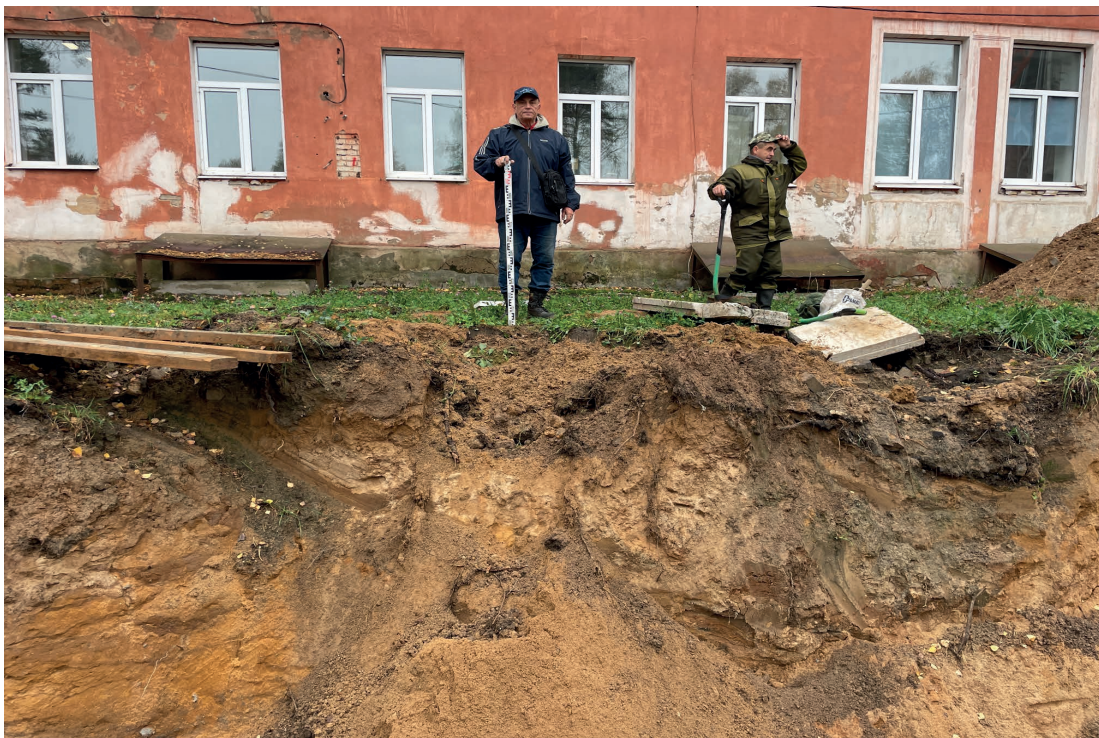
Рис. 27. Объект: «Строительство водогрейной котельной 400Гкал/час на территории Ивановской ТЭЦ-2», расположенной по адресу: РФ, Ивановская обл., г. Иваново, ул. Суворова, 76. Вид с С на рекультивацию шурфа 2.
