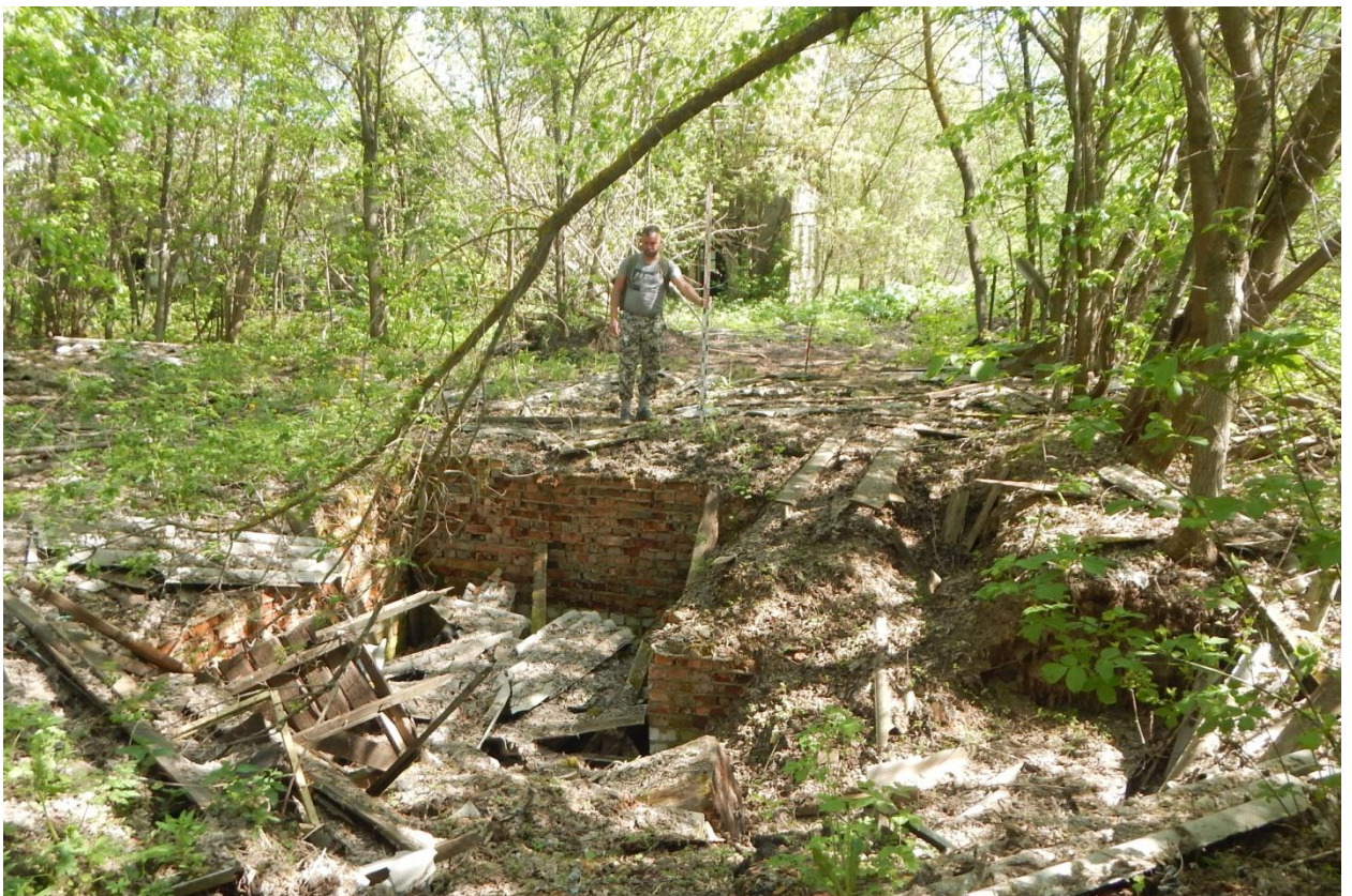
Рис. 12. Ивановская обл., г. Гаврилов Посад, ул. Розы Люксембург, участок станции обезжелезивания. Вид с юго-запада на южную часть участка.
