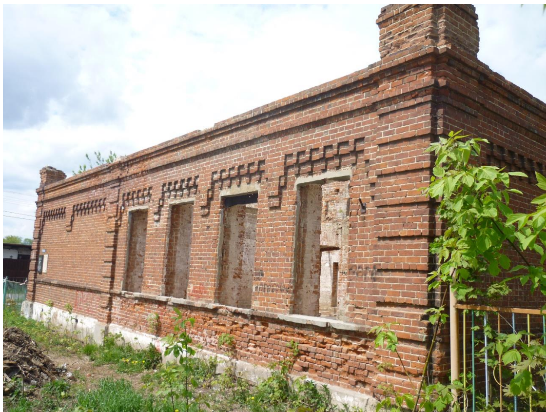
5. Юго-восточный фасад. Вид с востока.
