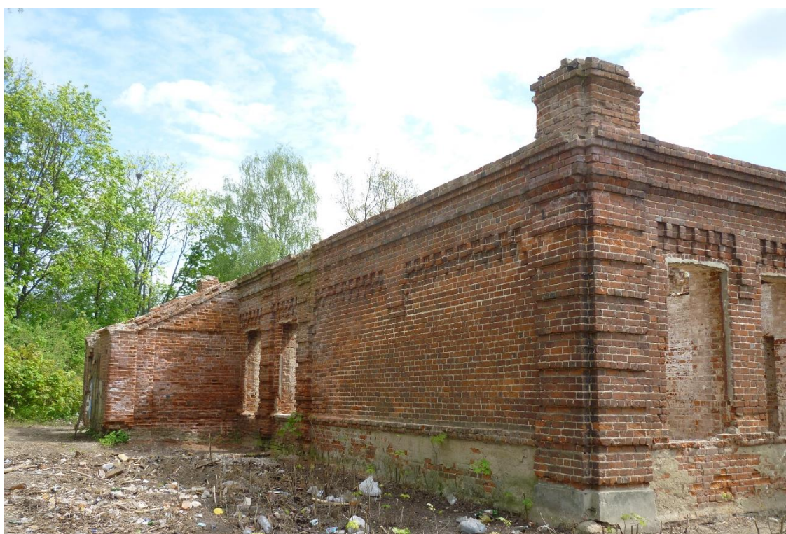
6. Северо-западный фасад. Вид с запада.
