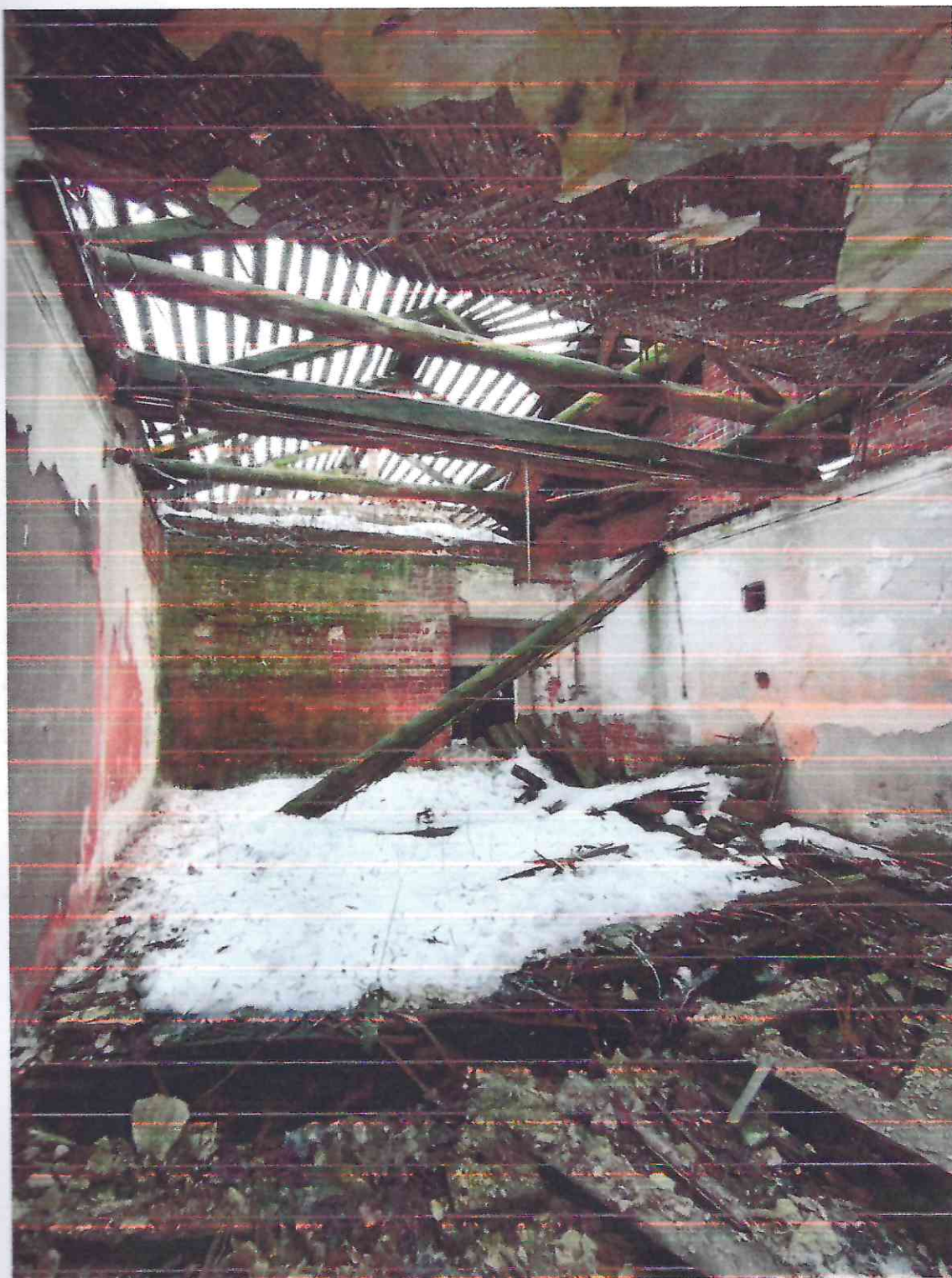
Фото, г. Шуя, ул. Балакова, д.1, март 2024 г. (фрагмент 1-го этажа снятого снаружи из оконного проема)
