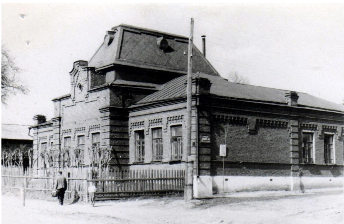
2. Вид с юга. Фото 1963 г.
