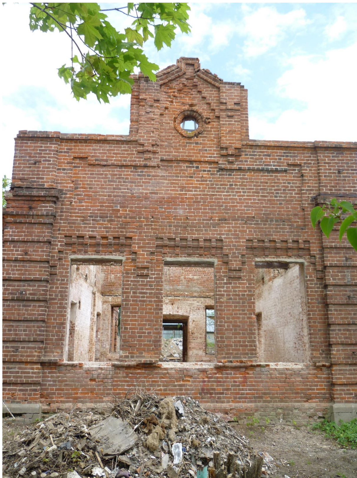
7. Центральный ризалит. Вид с юго-запада
