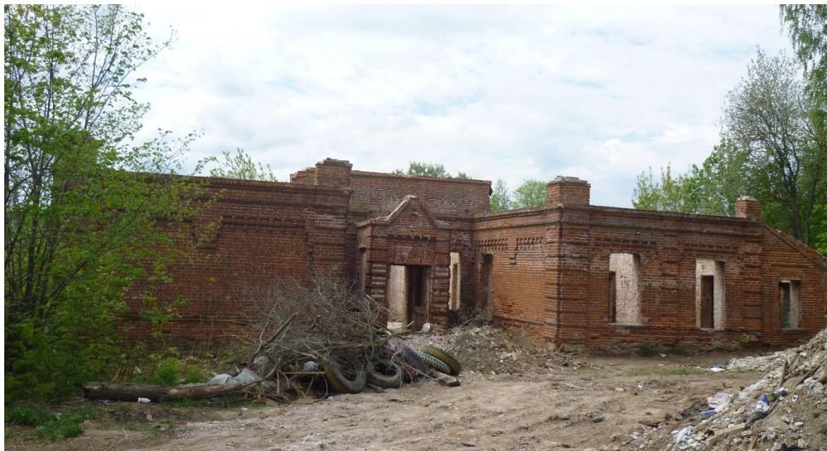
8. Вид со двора. Северо-восточный фасад.
