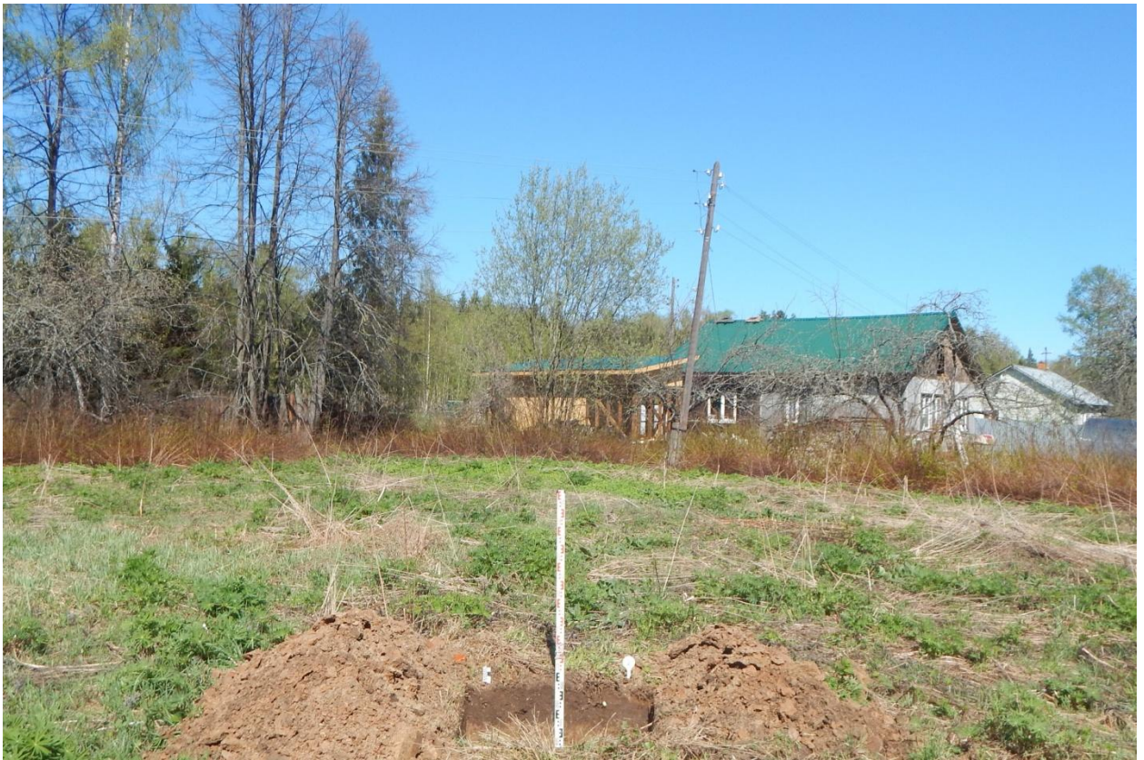
Рис. 24. Ивановский р-н, д. Железнодорожная станция Ермолино, з/у 37:05:021246:1002. Общий вид выкопанного шурфа № 2 с юга.
