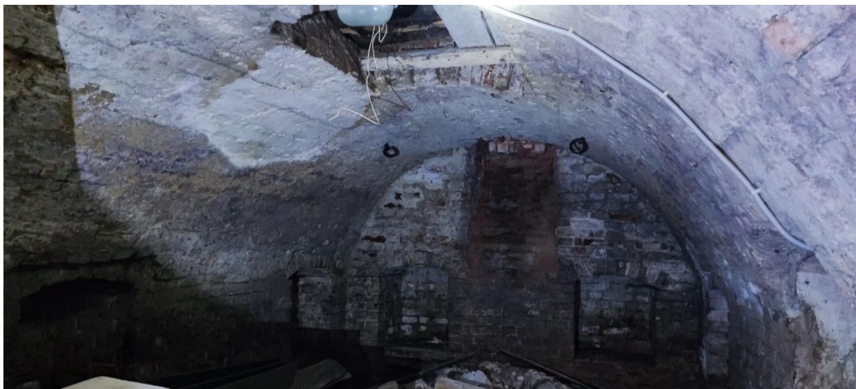
14. Свод в подвале
