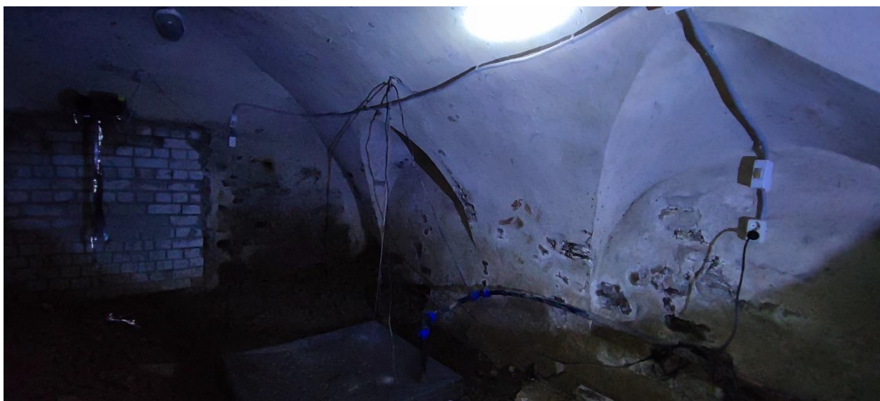
15. Свод в подвале
