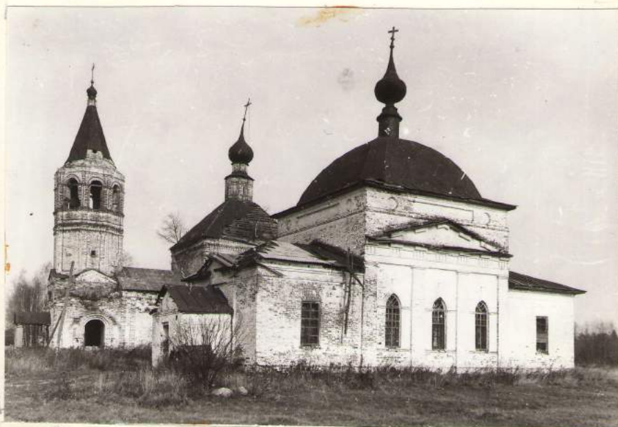
40/2 с. Обезово, ВВЕДЕНСКАЯ церковь, 1830г.
