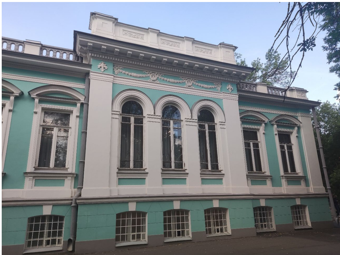
Фото 5. Общий вид Объекта с южной стороны.
