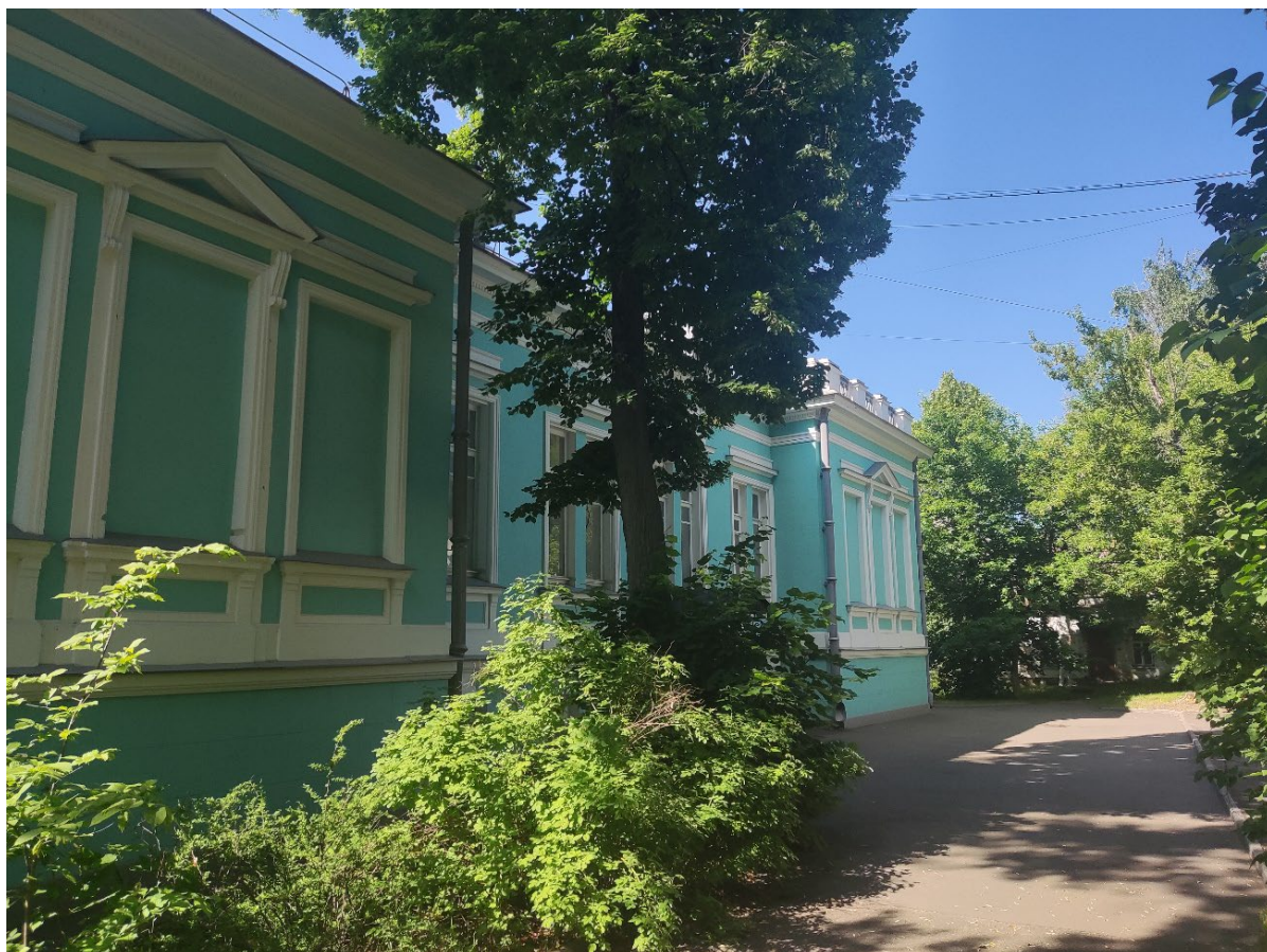
Фото 6. Общий вид Объекта с северо-восточной стороны.
