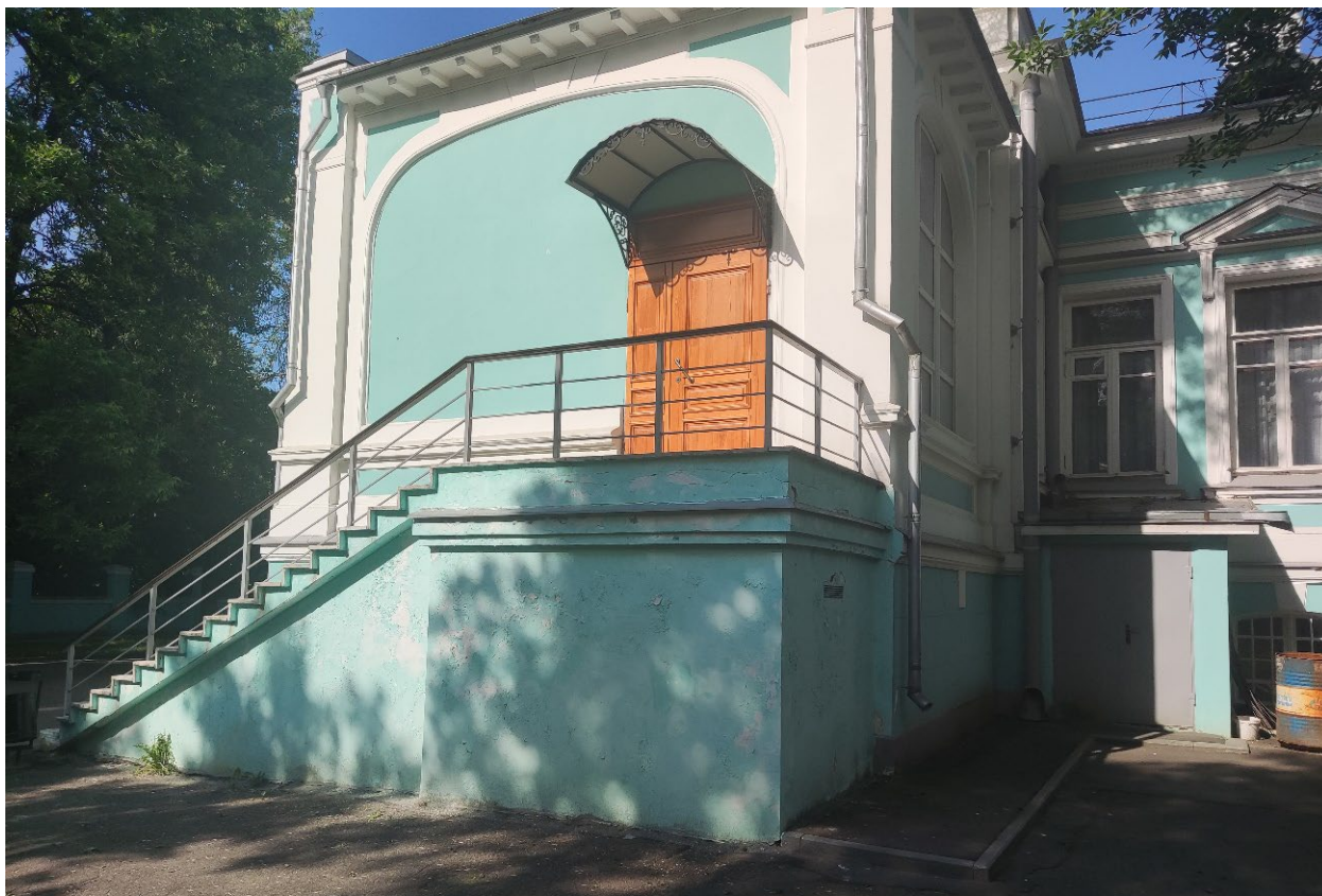
Фото 3. Общий вид Объекта с восточной стороны.
