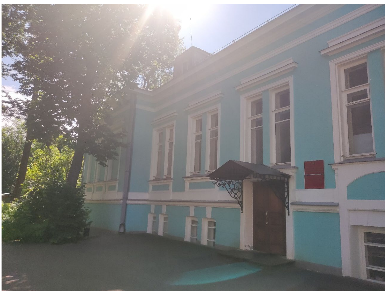
Фото 4. Общий вид Объекта с северной стороны.
