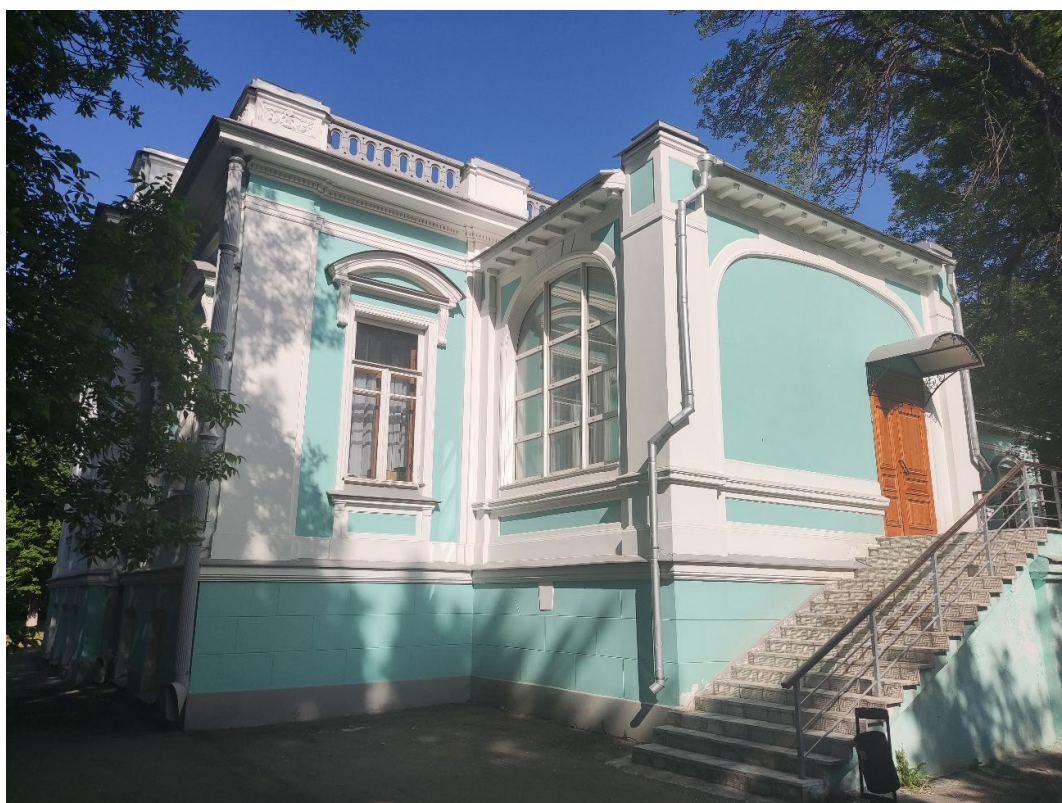
Фото 2. Общий вид Объекта с южной стороны.
