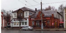
Фото 37. Общий вид дома №37а.
