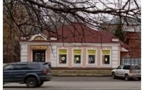
Фото 48. Общий вид дома №77.
