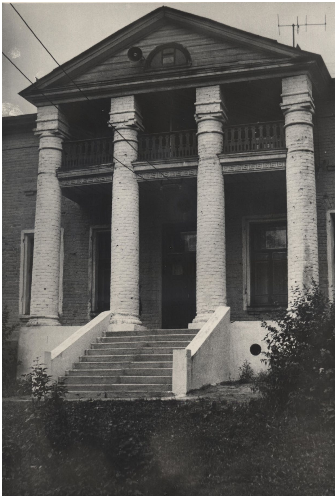
Рис. 3. Фото главного дома в 1971 г. из архива Комитета Ивановской области по государственной охране объектов культурного наследия
