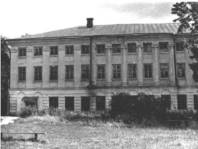
4. Фрагмент западного фасада. Фото 1975 г. (мл. научн. сотр. Ив. СНРПМ - Л. Шлычков)
