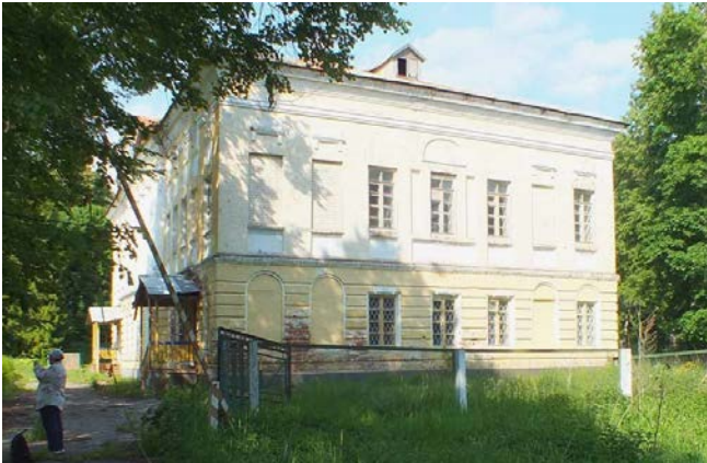
17. Главный дом с юго-запада. Фото 2019 г.
