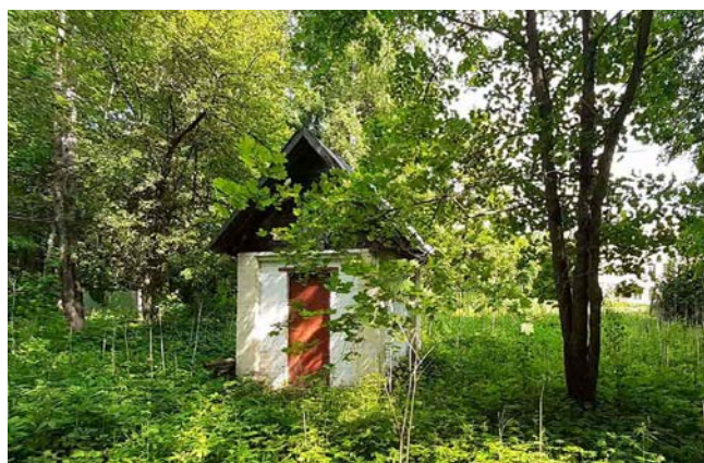
60. Насосная станция на водозаборной скважине. Фото 2019 г.
