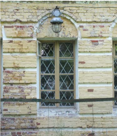
21. Центральное окно восточного ризалита на месте бывшего дверного проема с лучковой перемычкой. Фото 2019 г.
