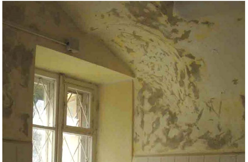
22. Фрагмент коробового свода вестибюля у центрального окна восточного ризалита (бывшего дверного проема). Фото 2019 г.
