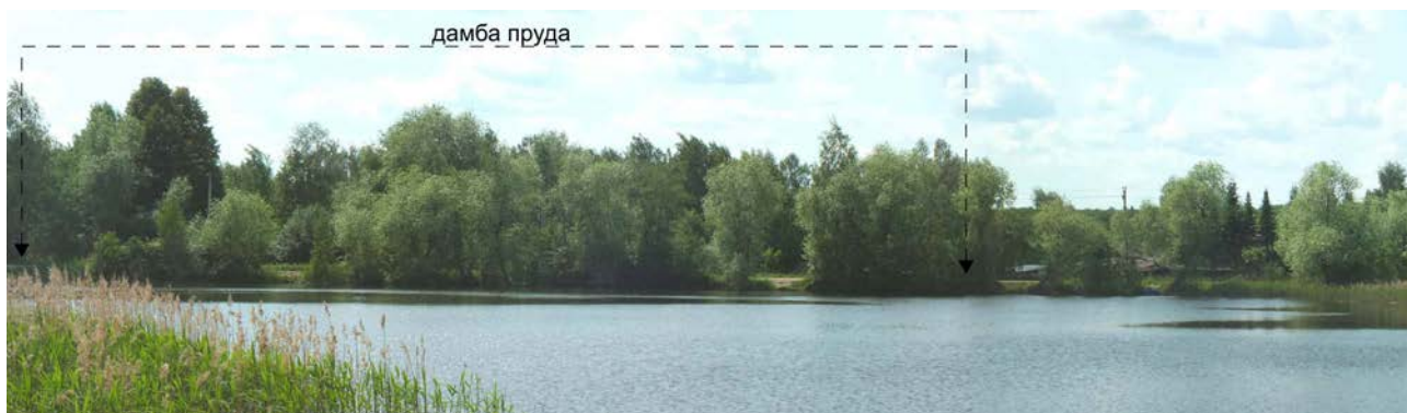
Фото 51. Вид на южную часть пруда и дамбу. Фото 2019 г.
