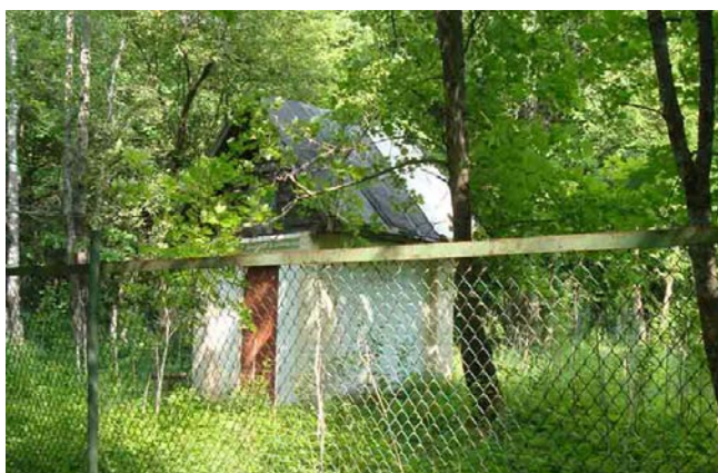
59. Насосная станция на водозаборной скважине. Фото 2019 г.
