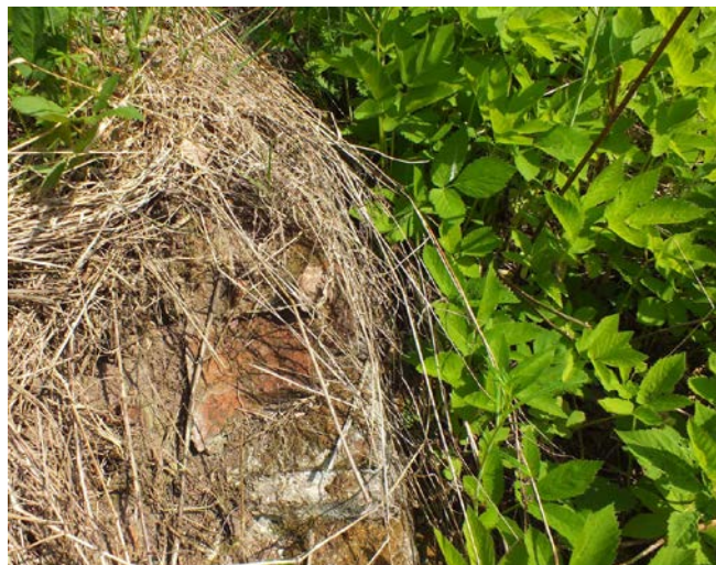
49. Фрагмент фундамента церкви. Фото 2019 г.
