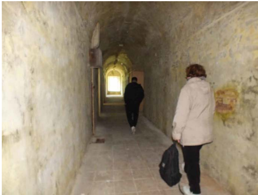
23. Коридор 1 эт. с полуциркульным сводчатым перекрытием. Фото 2019 г.
