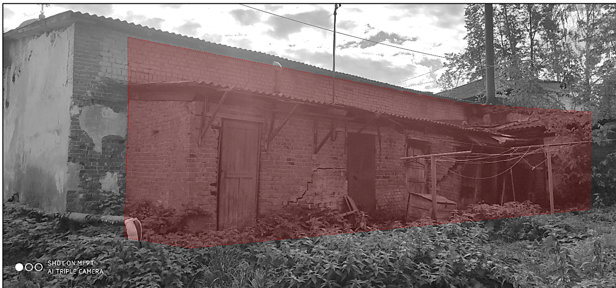
Рис. 2 Кирпичные пристройки, подлежащие реконструкции
