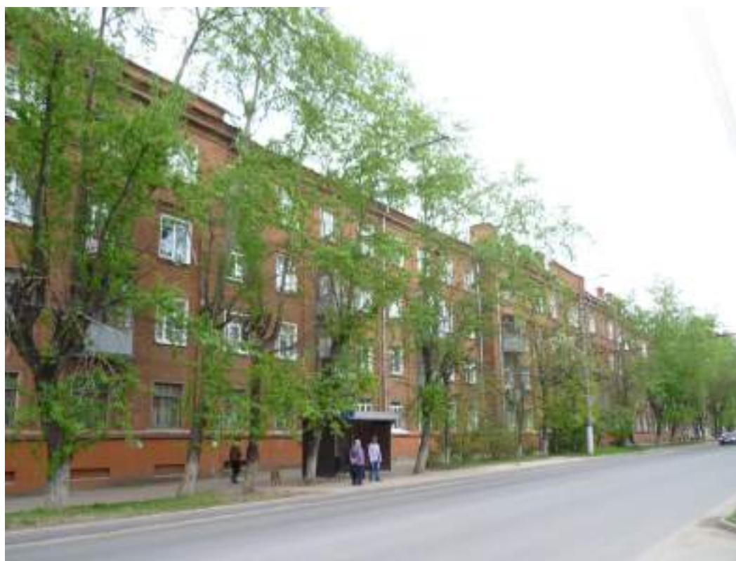
11. Вид с северо-запада
