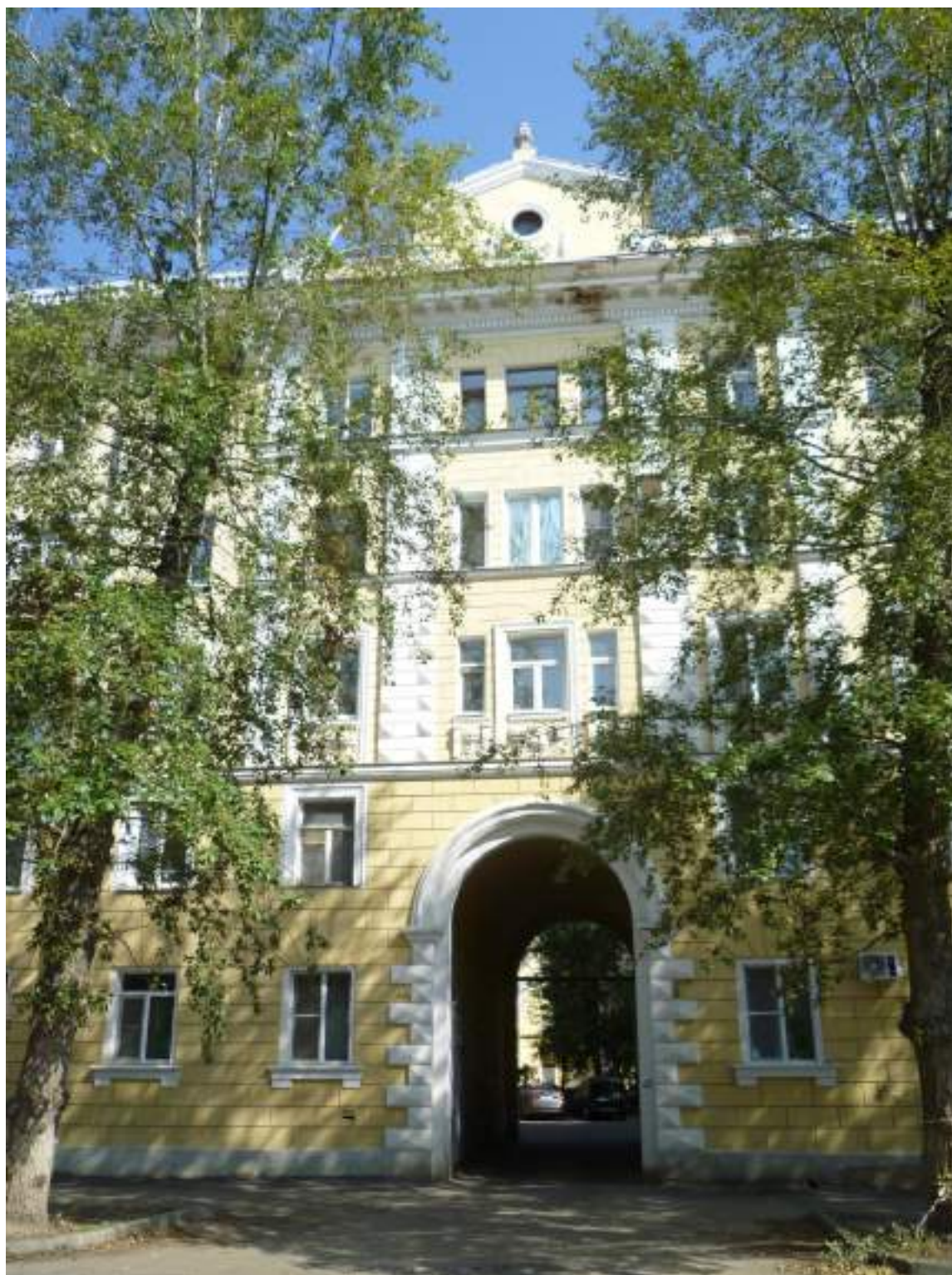
6. Боковой фасад. Вид с юго-запада
