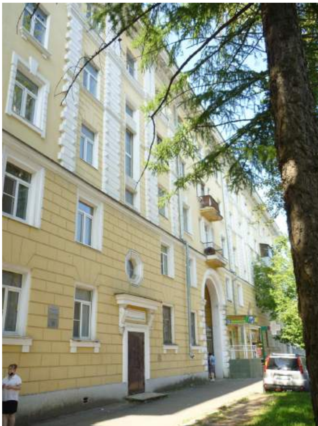
5. Боковой фасад. Вид с востока
