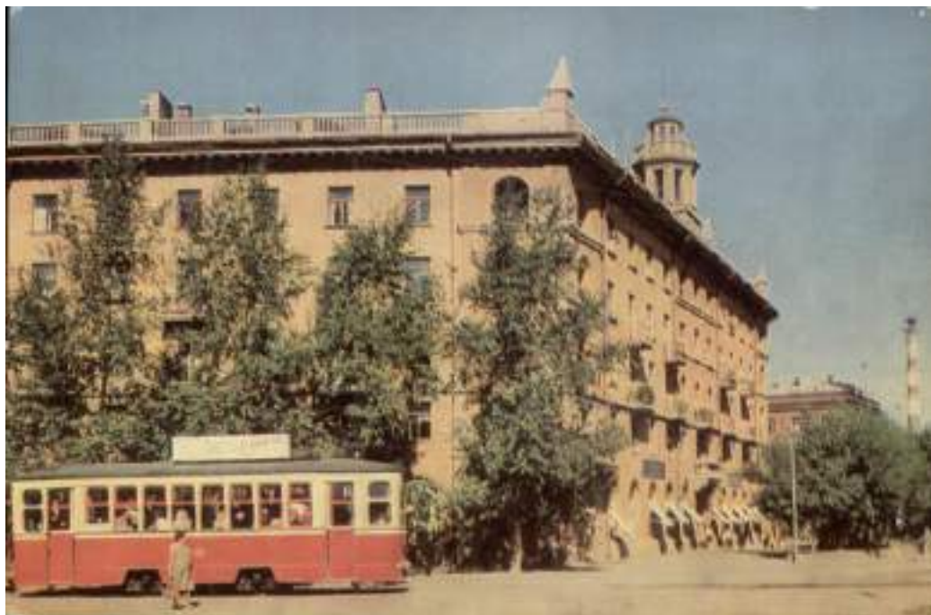
1. Вид со стороны ул. Красных Зорь. Фото 1967 г.
