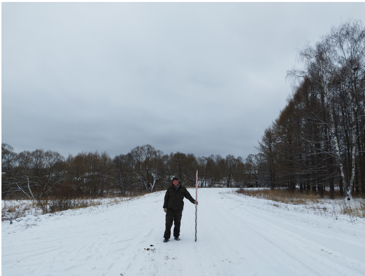
Илл. 14. Ивановская область, Родниковский район, с. Филисово, реконструкция моста через реку Возополь - 2023 г. Вид на Ю участка. Точка фотофиксации 3. Фото с Ю.
