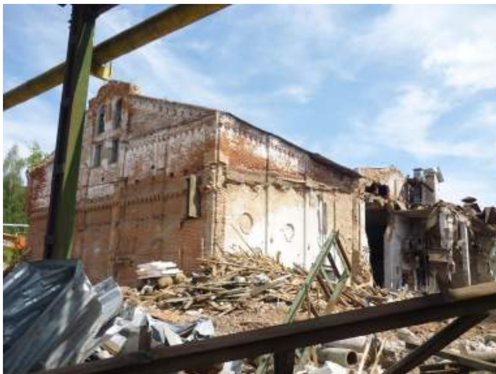
11. Пряже-бельный корпус. Вид с запада
