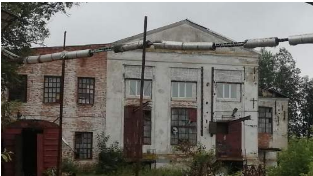
22. Расстекловка окон электростанции. Вид с северо-запада.
