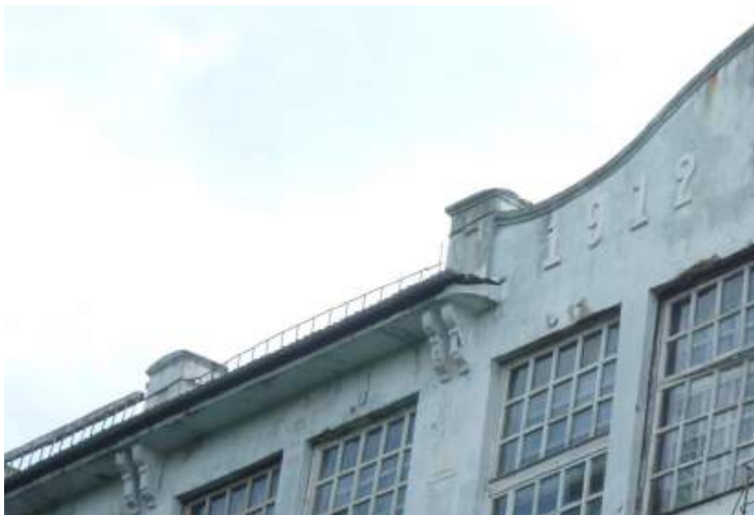
20 Венчающие карнизы северного фасада прядильного корпуса
