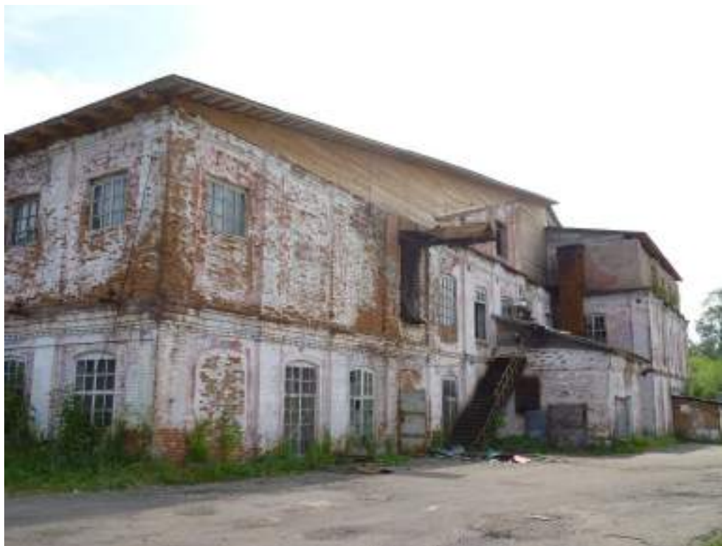
7. Бельно-отделочный корпус. Вид с северо-запада
