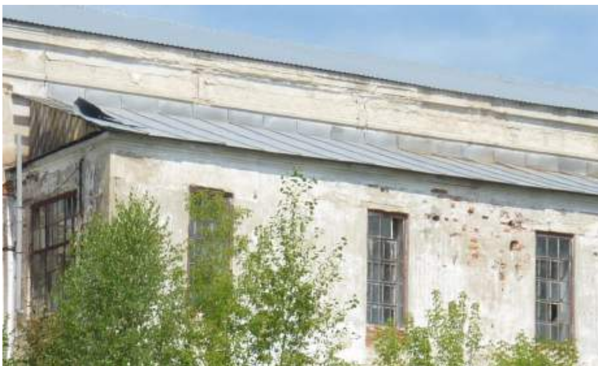
21. Венчающие карнизы и расстекловка окон на южном фасаде электростанции
