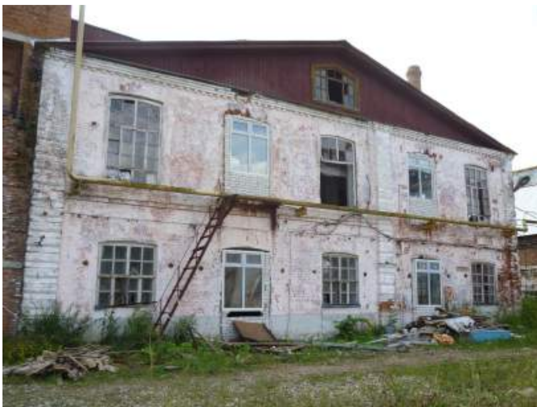
6. Ткацкий корпус. Вид с севера
