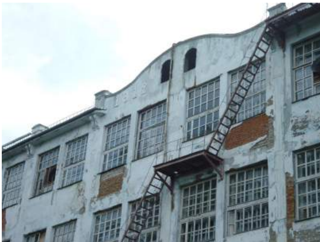
16. Прядильный корпус. Фрагмент северного фасада.
