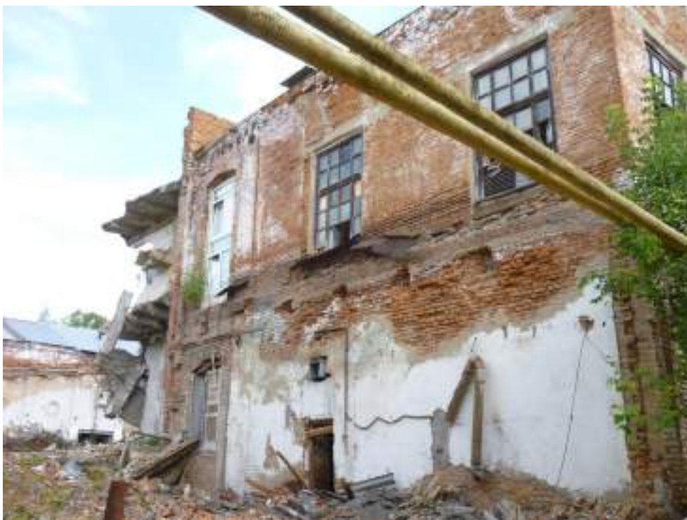
14. Пряже-бельный корпус. Вид с запада.
