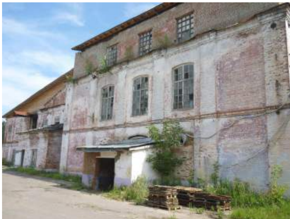
8. Бельно-отделочный корпус. Вид с юго-запада
