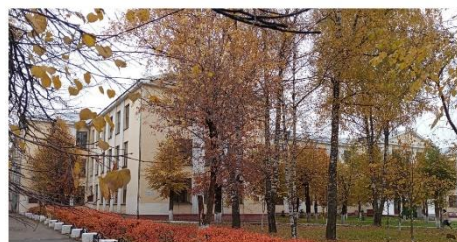
Рис. 6. Общий вид здания слева от портика главного входа.
