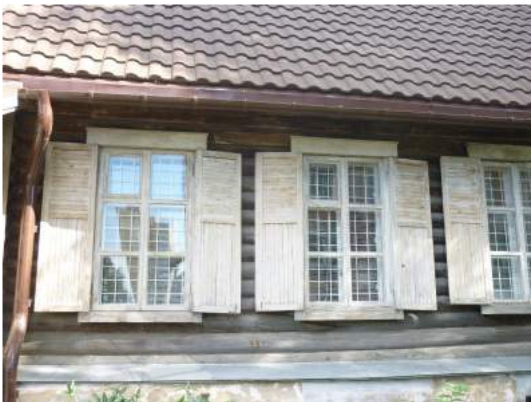
7. Окна на северо-западном фасаде. Фото 25.06.2026 г., А.М. Тихомиров
