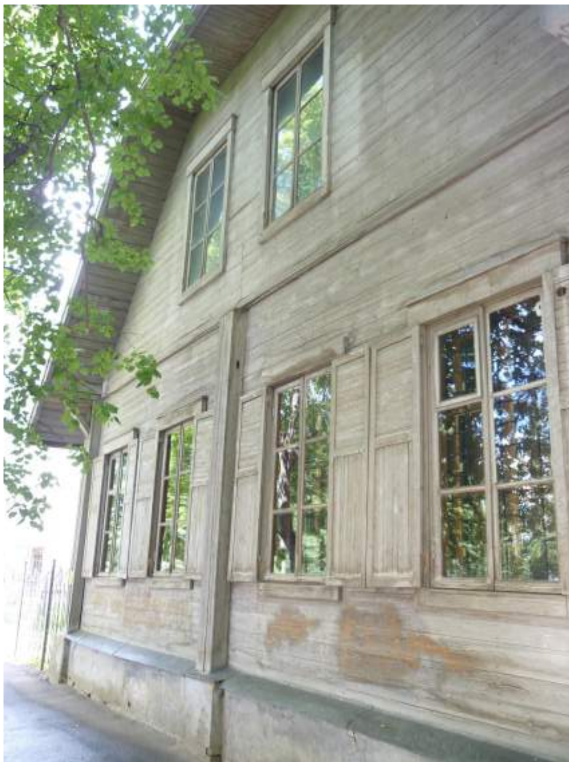
5. Вид с севера. Фото 25.06.2026 г., А.М. Тихомиров
