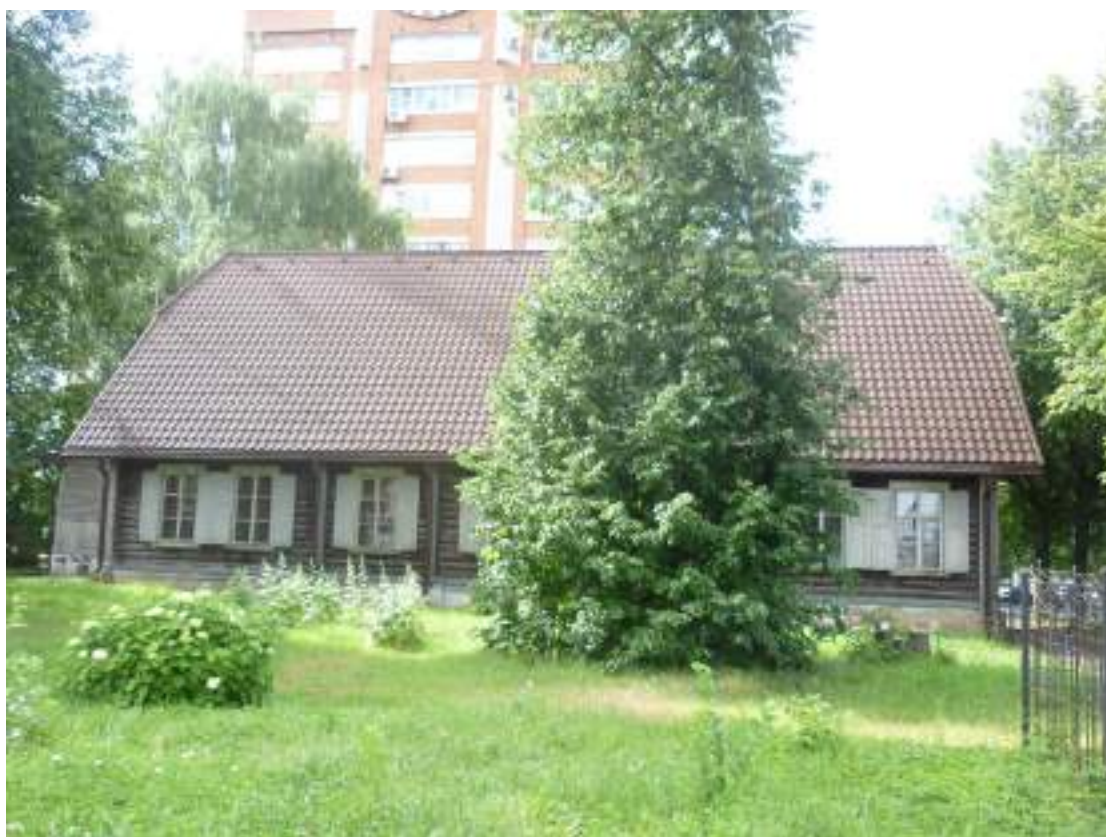
2. Расположение окон на юго-восточном фасаде
