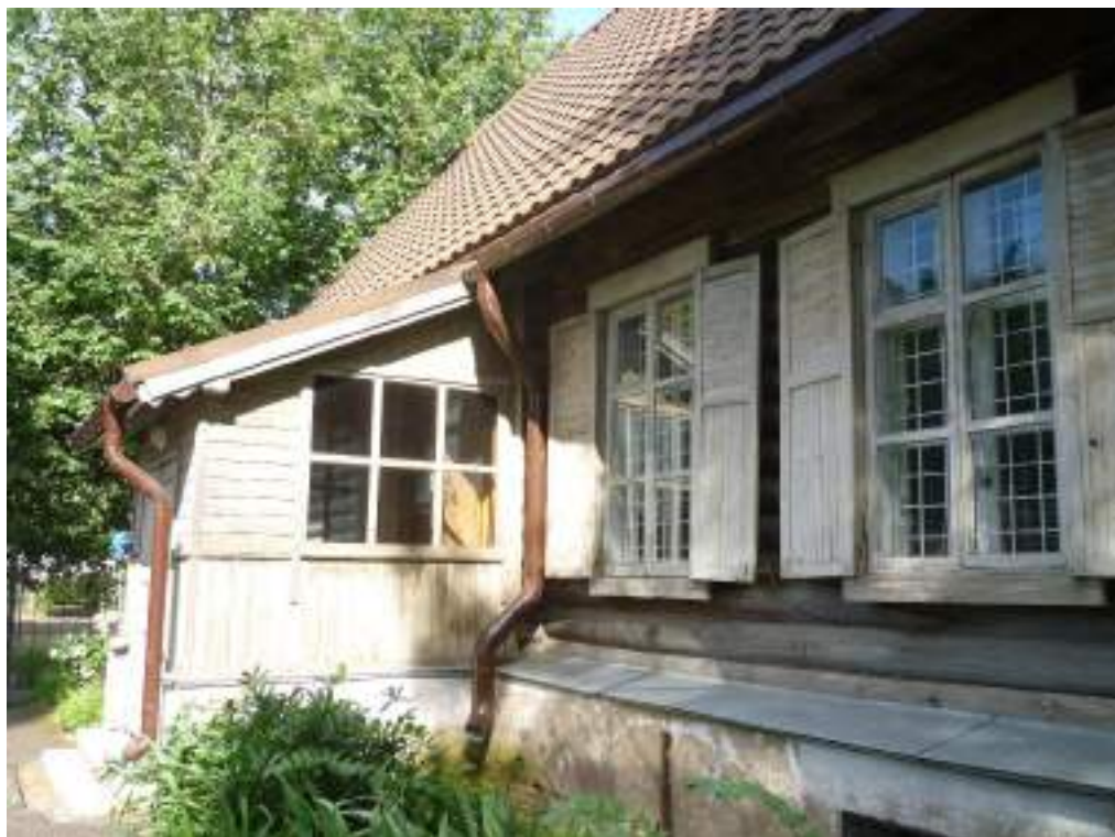
8. Крыльцо на северо-западном фасаде. Фото 25.06.2026 г., А.М. Тихомиров
