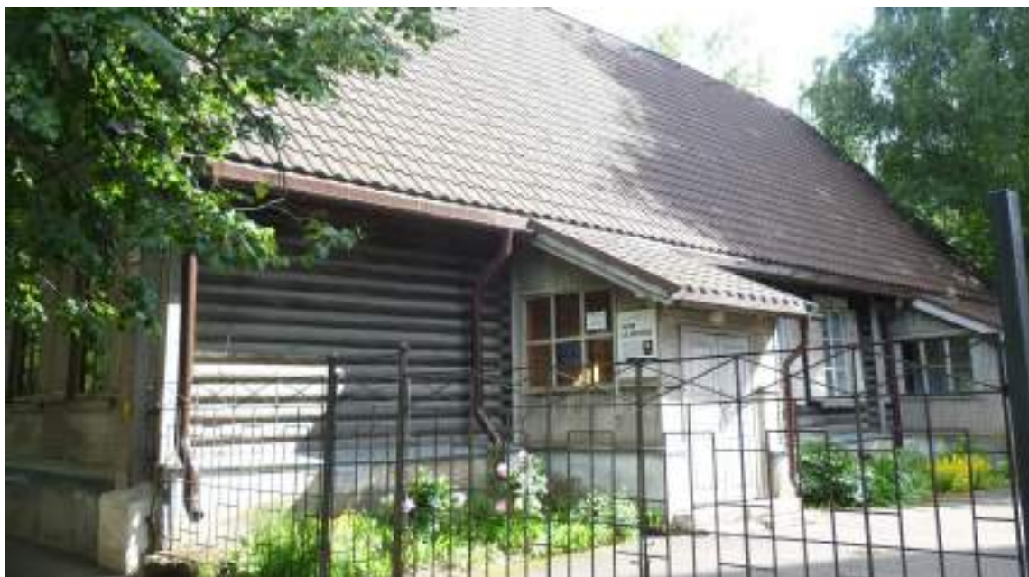
1. Крыльца на северо-западном фасаде
