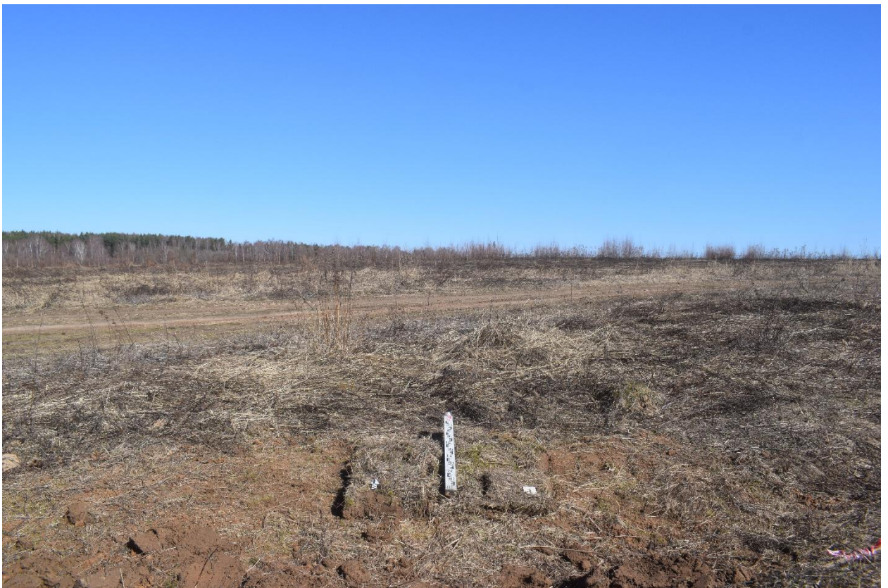
Рис. 25. Иваново, улично-дорожная сеть мкр. «Сады сирени». Шурф № 1, рекультивация, вид с юга.
