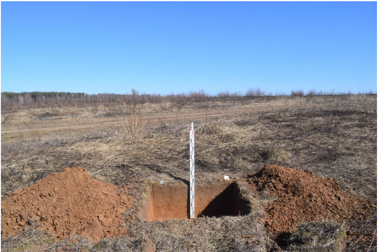
Рис. 24. Иваново, улично-дорожная сеть мкр. «Сады сирени». Общий вид с юга выкопанного шурфа № 1.
