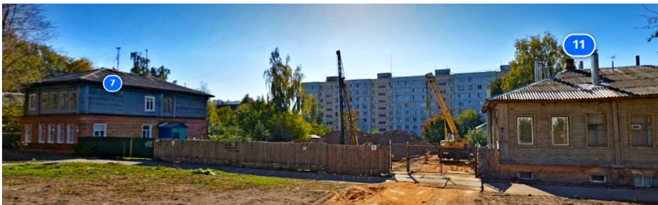
Фото 4. Территория снесенного дома № 9.
