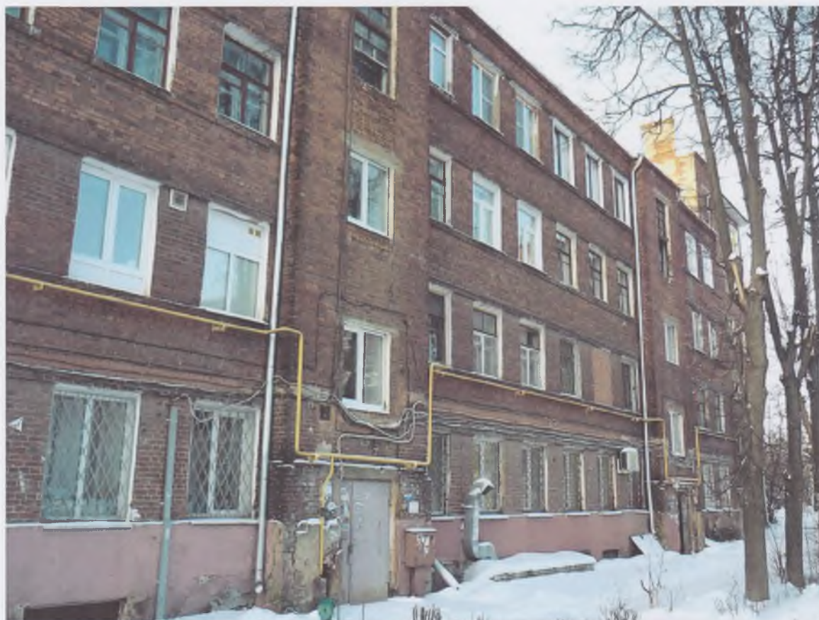
4. 62-х квартирный дом треста «Ивтекстиль» (пр. Ленина, 62). Дворовый фасад.
