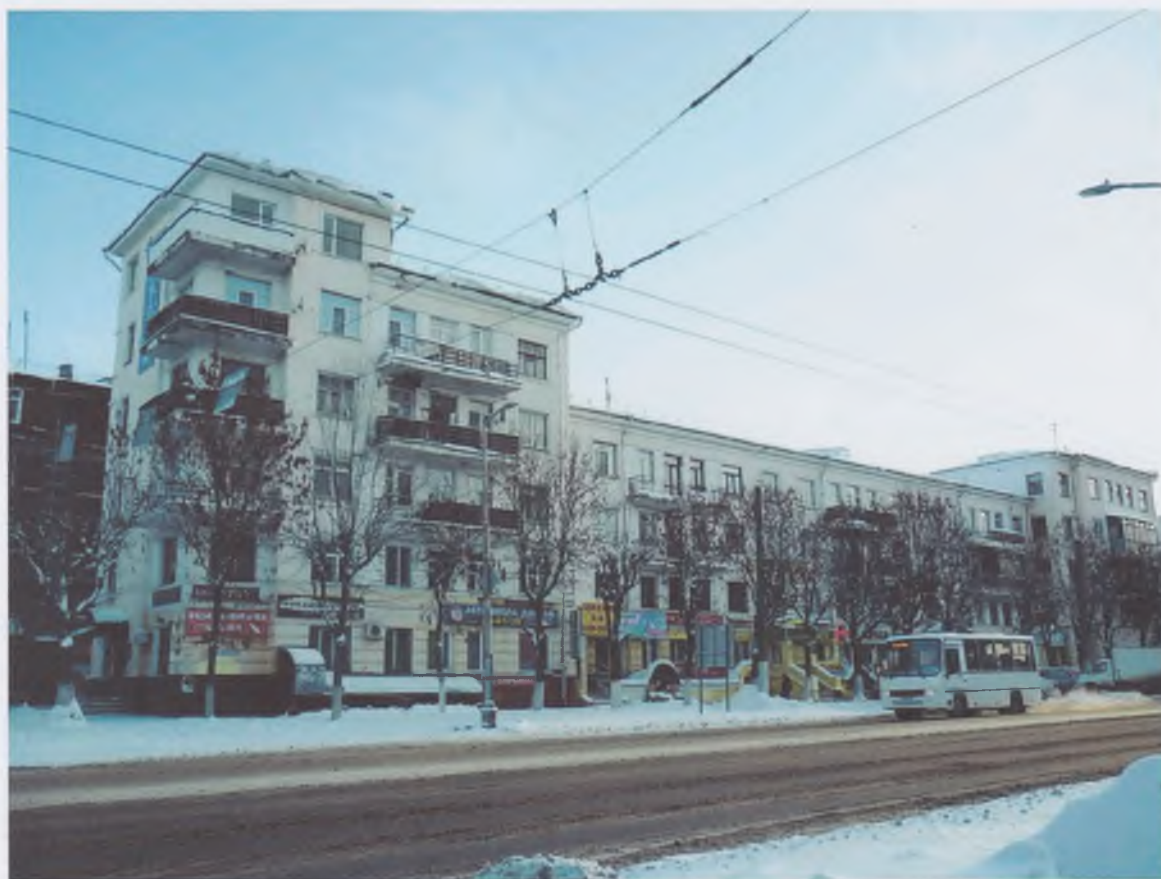
1. 62-х квартирный дом треста «Ивтекстиль» (пр. Ленина, 62). Вид с северо-запада.
