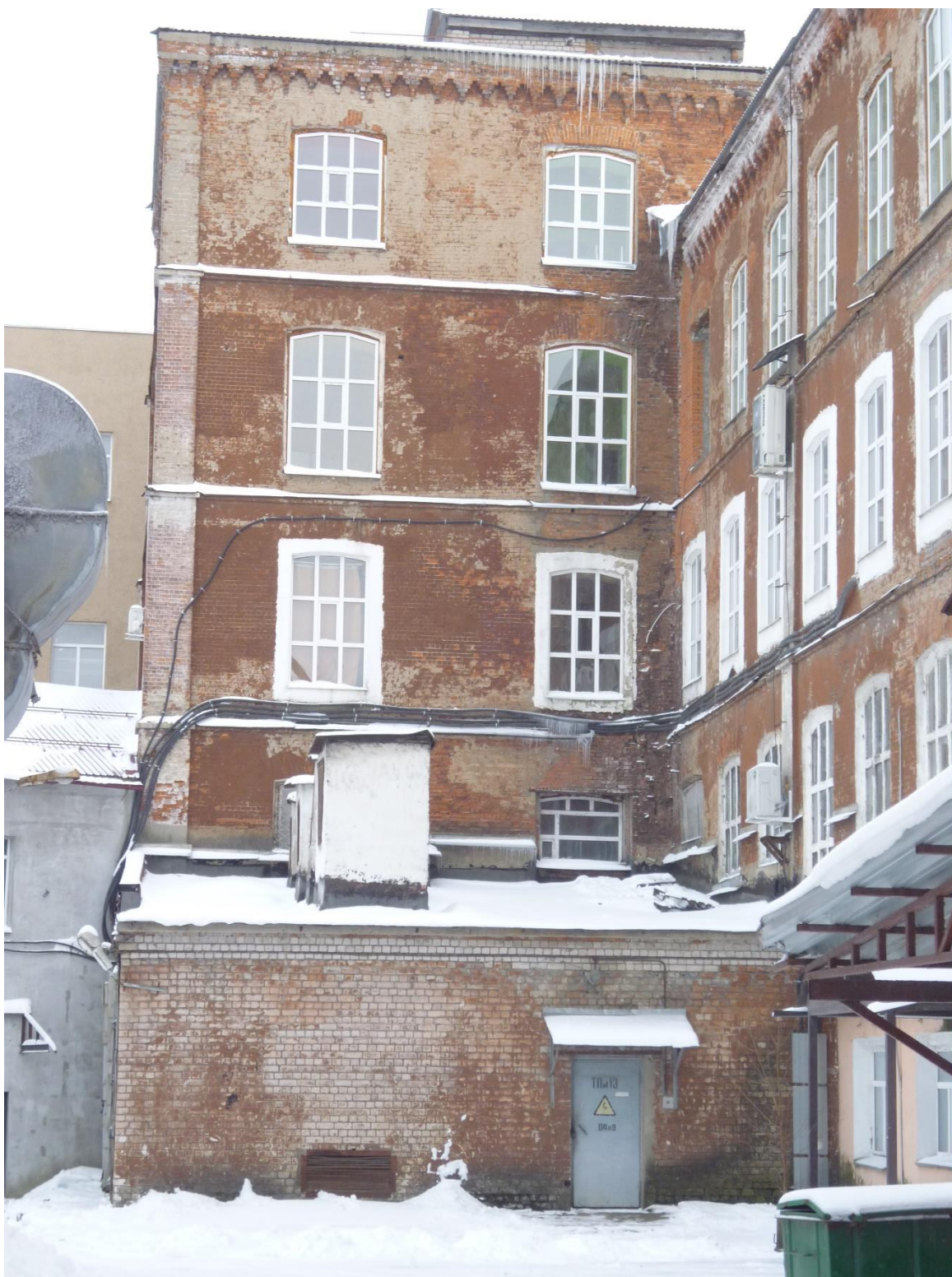
10. Прядильно-ткацкий корпус. Пристройка с севера (Лит. Б4)
