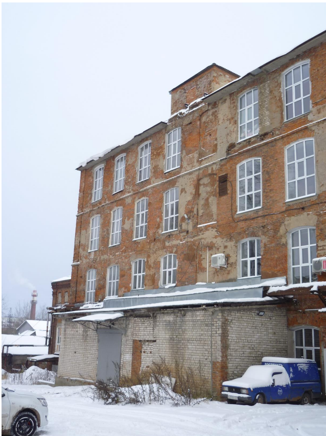
3. Старый ткацкий корпус. Вид с запада. Новая пристройка.
