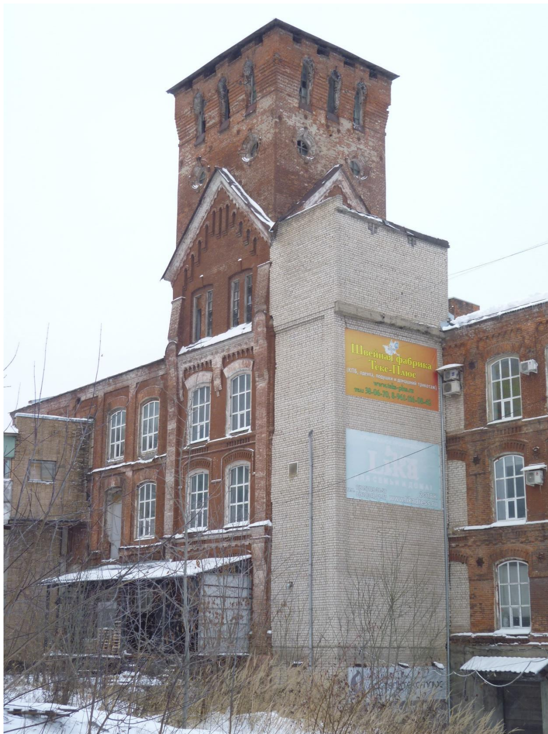
6. Прядильно-ткацкий корпус. Пристройка к водонапорной башне
