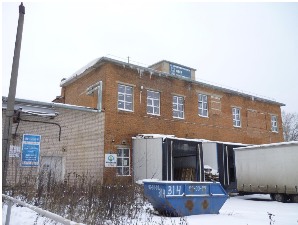
4. Старый ткацкий корпус. Новая пристройка с востока (Лит. В1)
