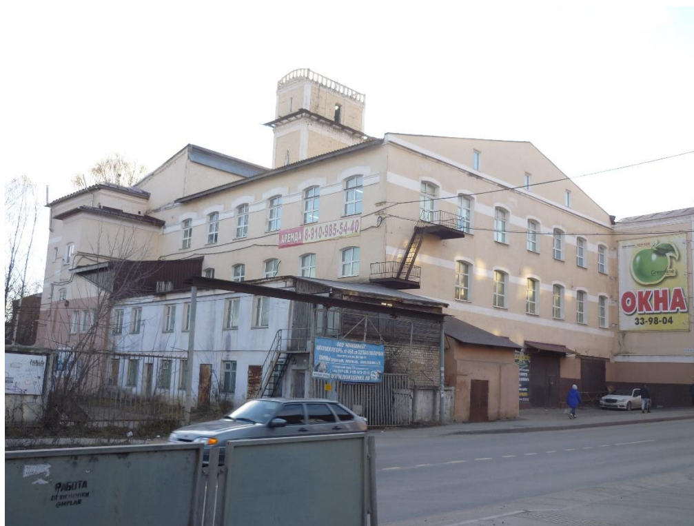
2. Корпус ситцепечатной фабрики «Товарищества мануфактур наследников Н.Ф. Зубкова». Вид с северо-запада. На переднем плане новая пристройка.
