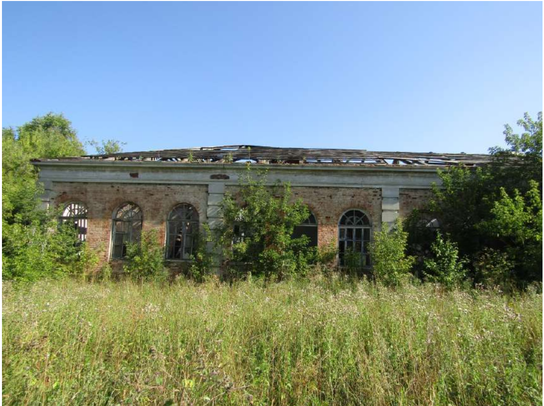
Фото 28. Вид с южной стороны
