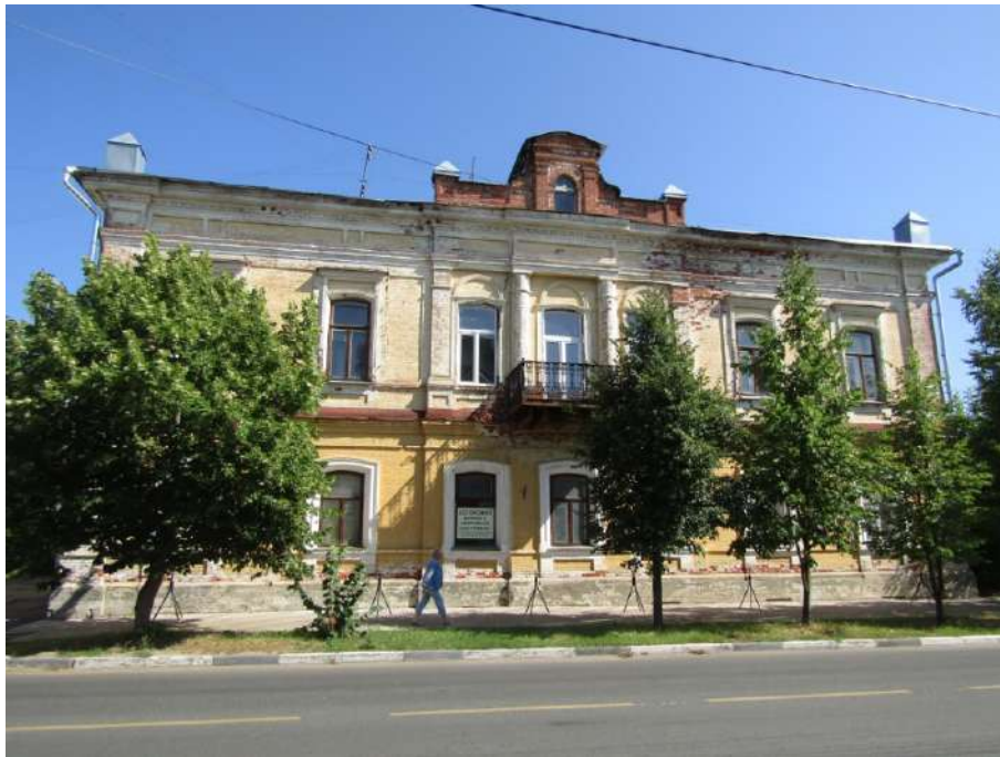
Фото 43. Общий вид с южной стороны
