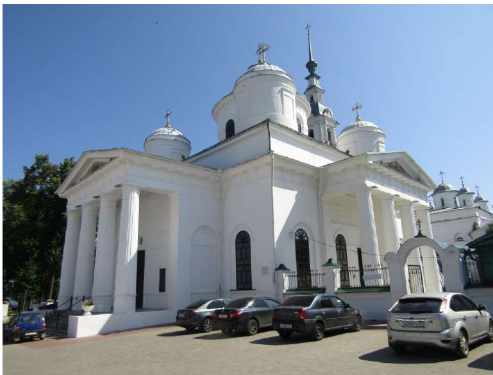
Фото 72. Общий вид с южной стороны
