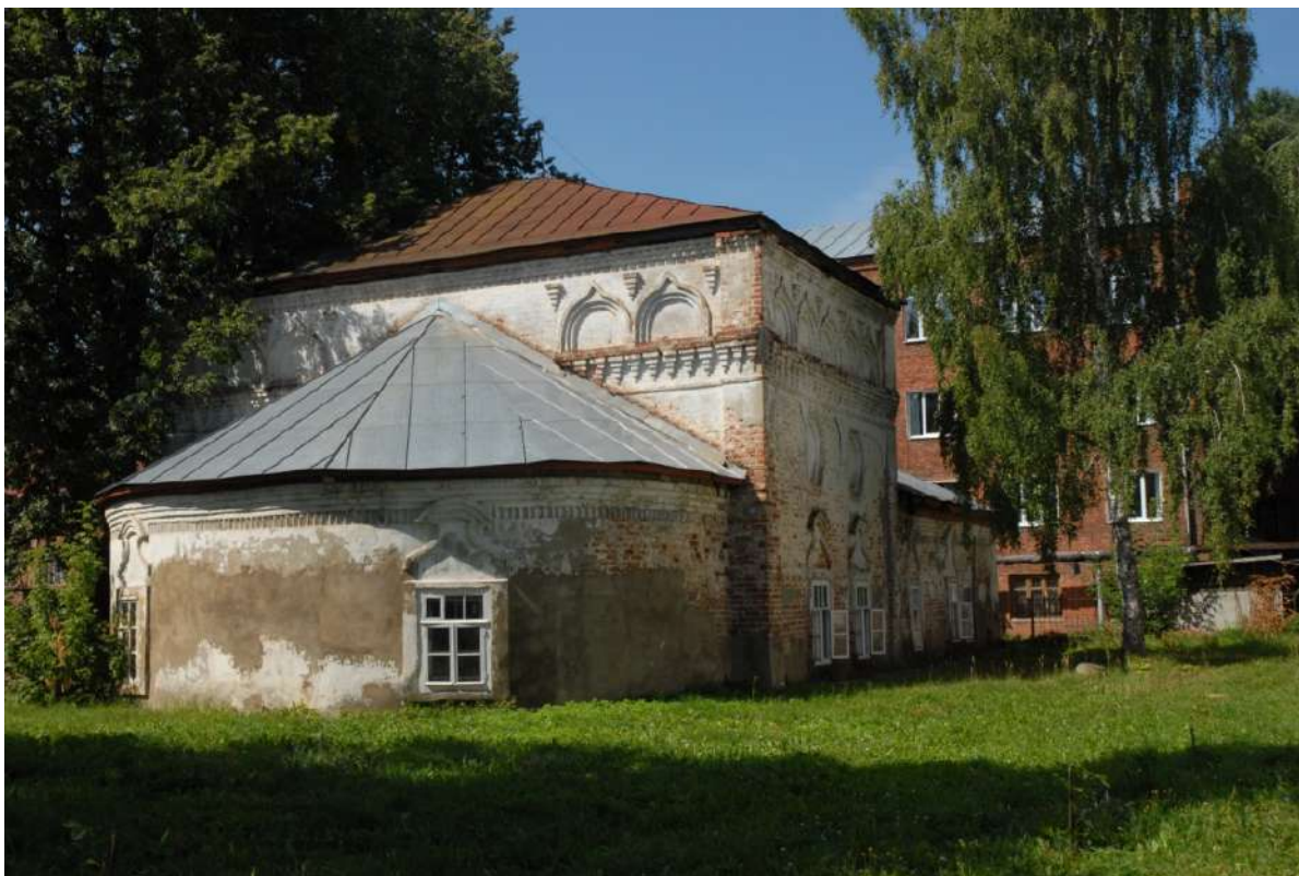
Фото 77. Общий вид церкви с северо-западной стороны.
