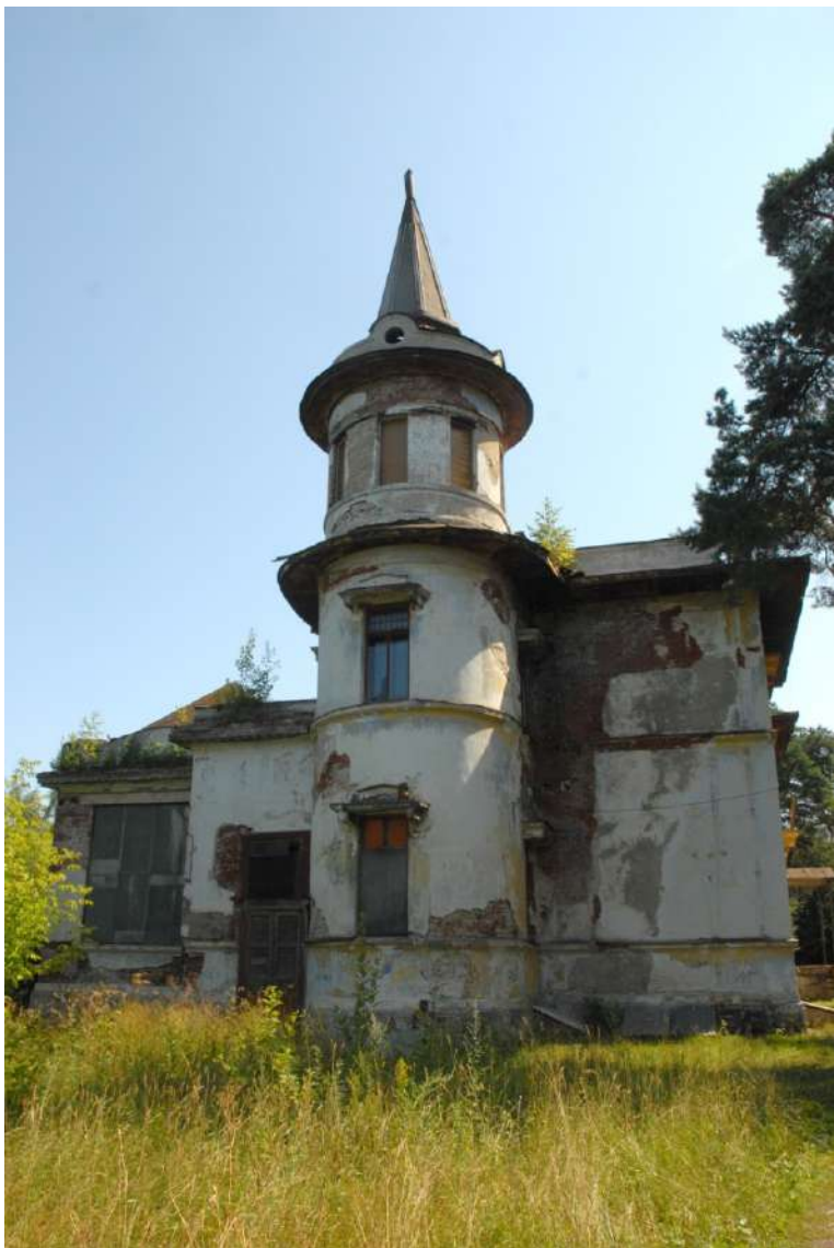
Фото 79. Общий вид с западной стороны
