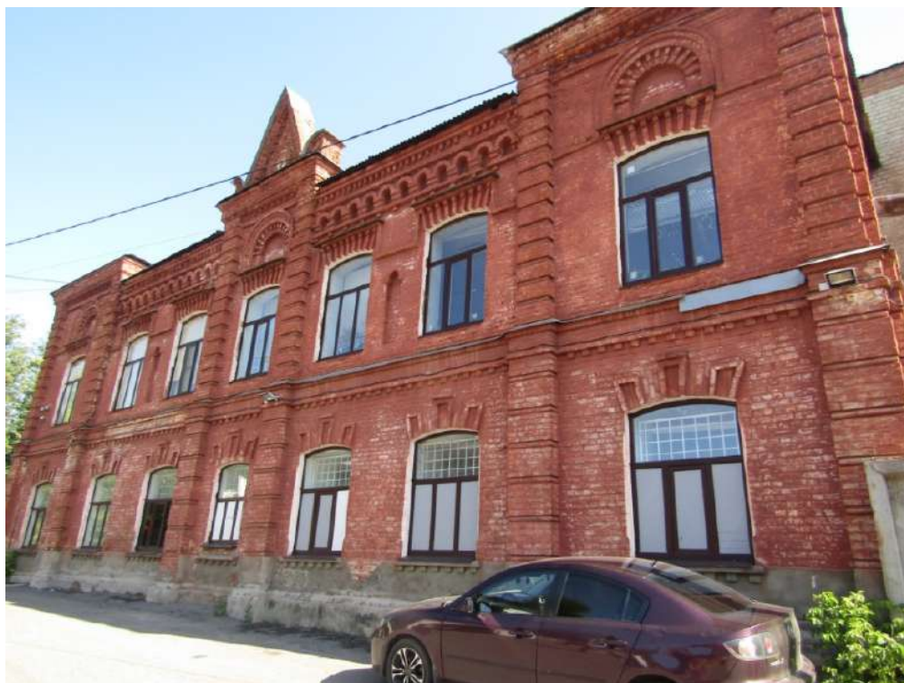
Фото55. Вид с запада
