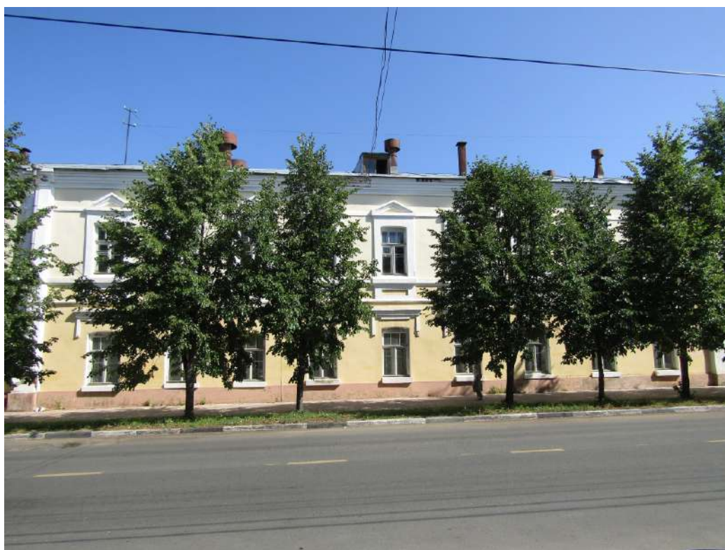
Фото 38.15. Общий вид с южной стороны
