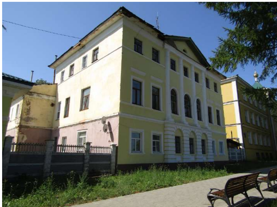
Фото 16. Общий вид с северо-восточной стороны
