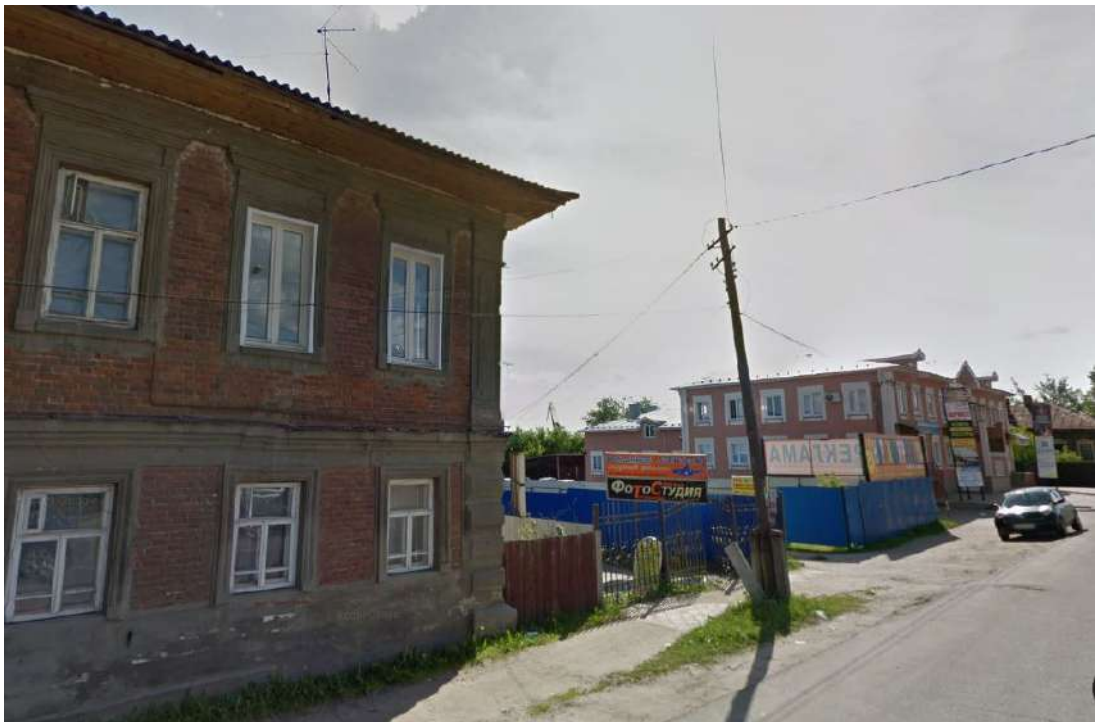
Фото 47б. Вид западной части застройки улицы
