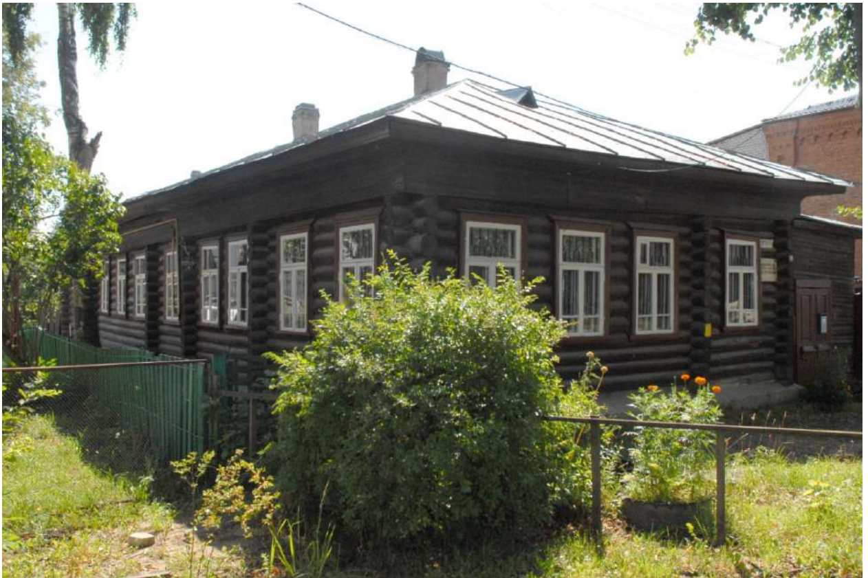
Фото 75. Вид дома с западной стороны
