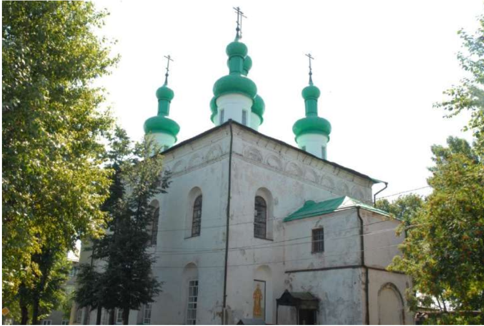
Фото 76. Общий вид церкви с северо-западной стороны.
