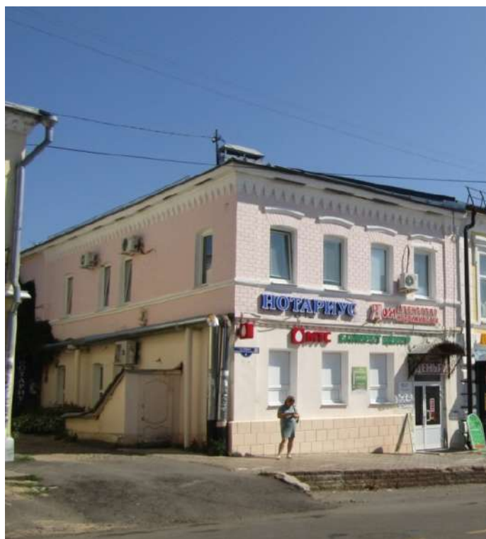
Фото 38.3. Вид с южной стороны
