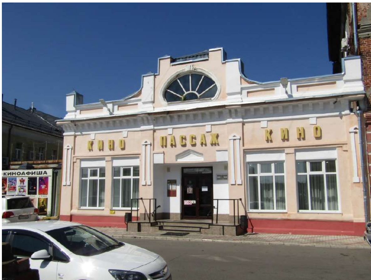
Фото 64. Общий вид с южной стороны
