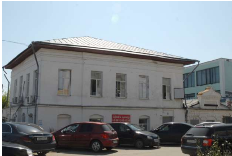
Фото 56. Вид с запада
