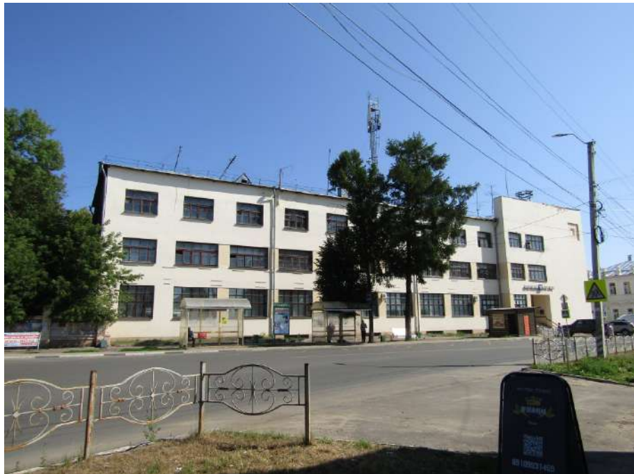
Фото 44. Общий вид с южной стороны
