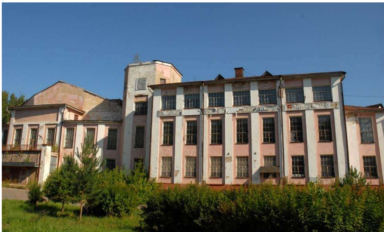
Фото 2. Вид с южной стороны
