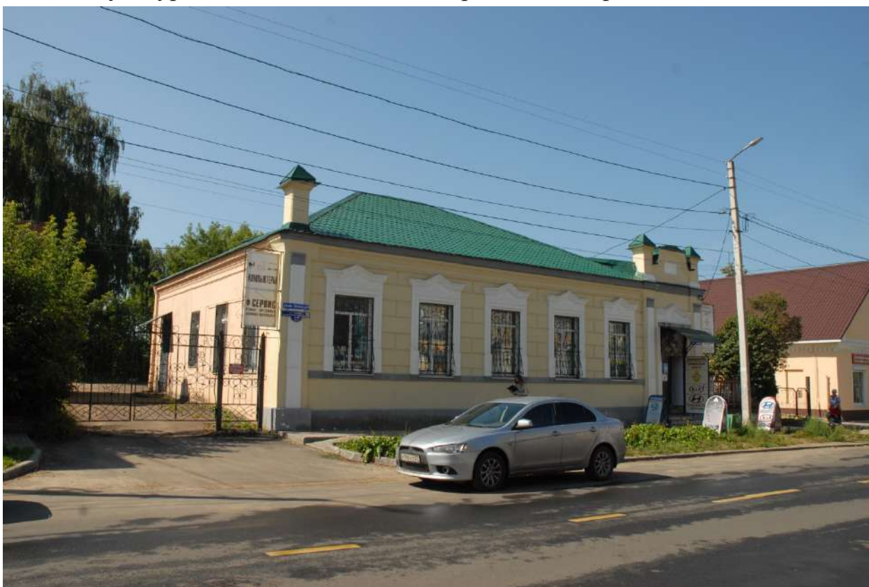
Фото 38.12. Общий вид с южной стороны
