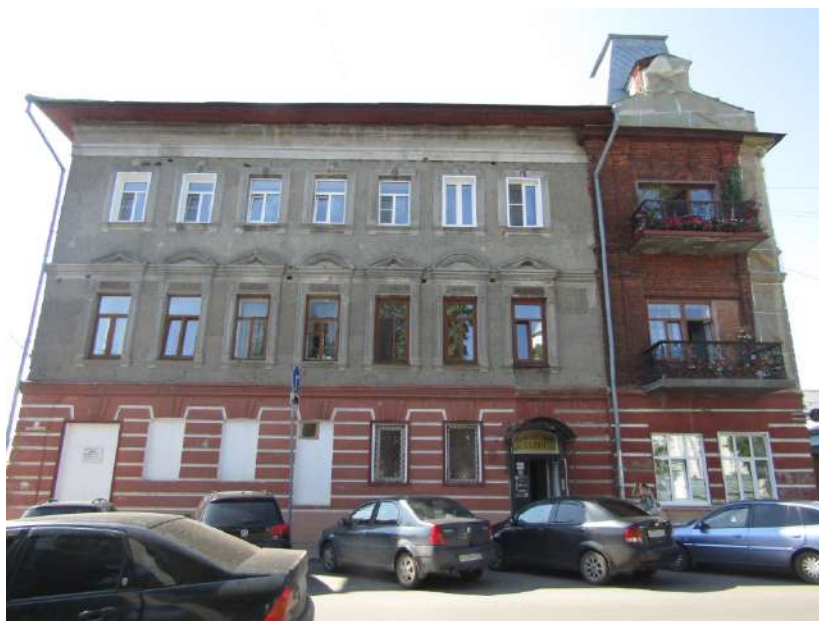
Фото 70б. Вид с восточной стороны на пристроенный объем
