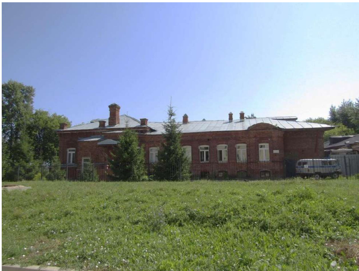
Фото 74. Общий вид с западной стороны.
