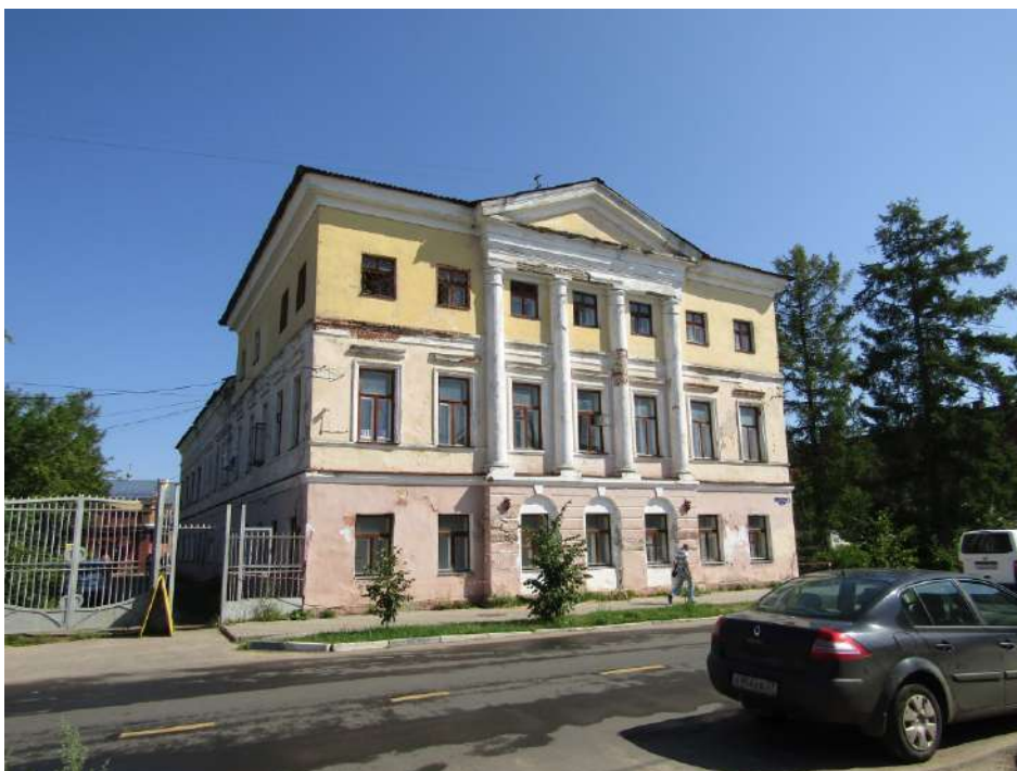
Фото 38.11. Общий вид с южной стороны
