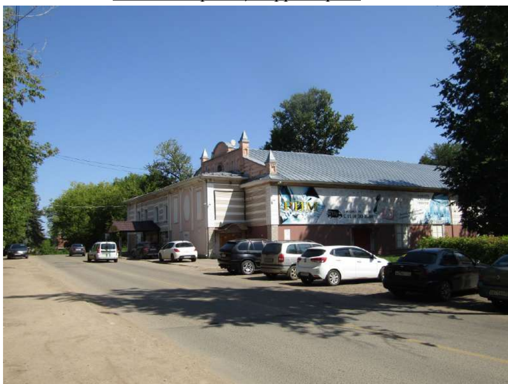
Фото 38.21. Общий вид с южной стороны
