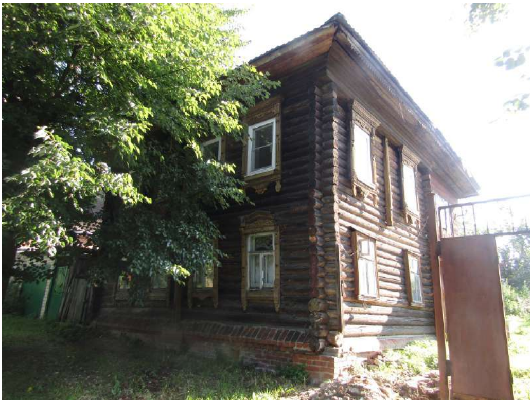
Фото 53а. Вид восточной части улицы (нечетная сторона, дом №11)
