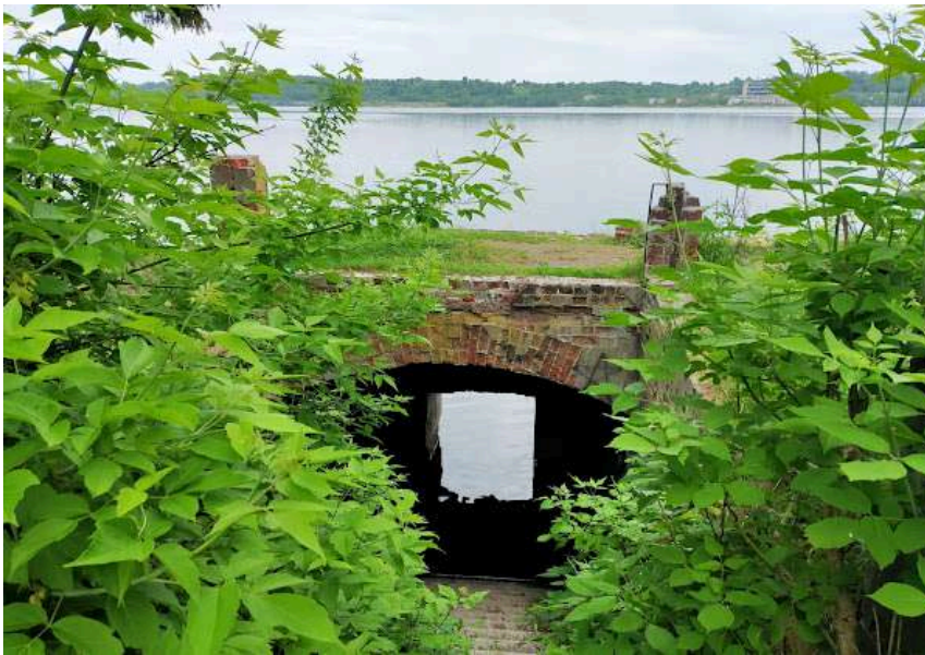
Фото 82б. Вид на грот с лестницей
