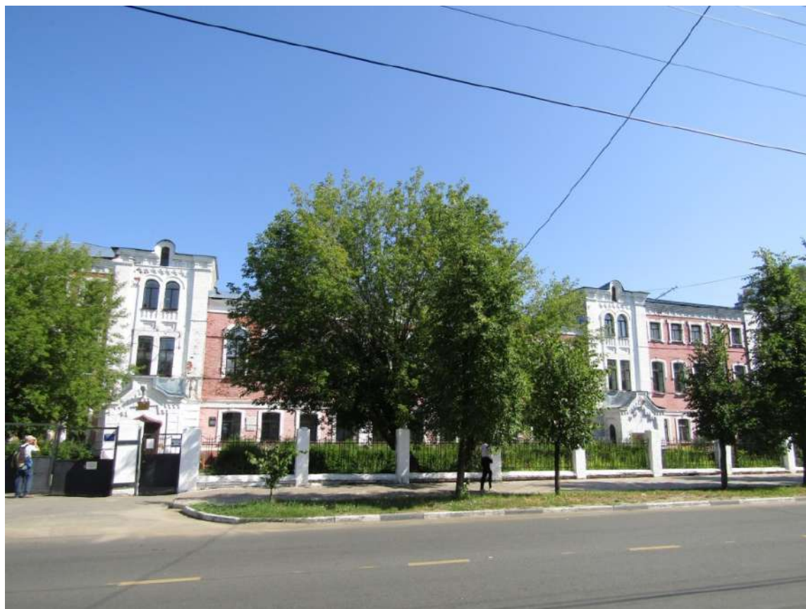
Фото 38.16. Общий вид с юго-западной стороны
