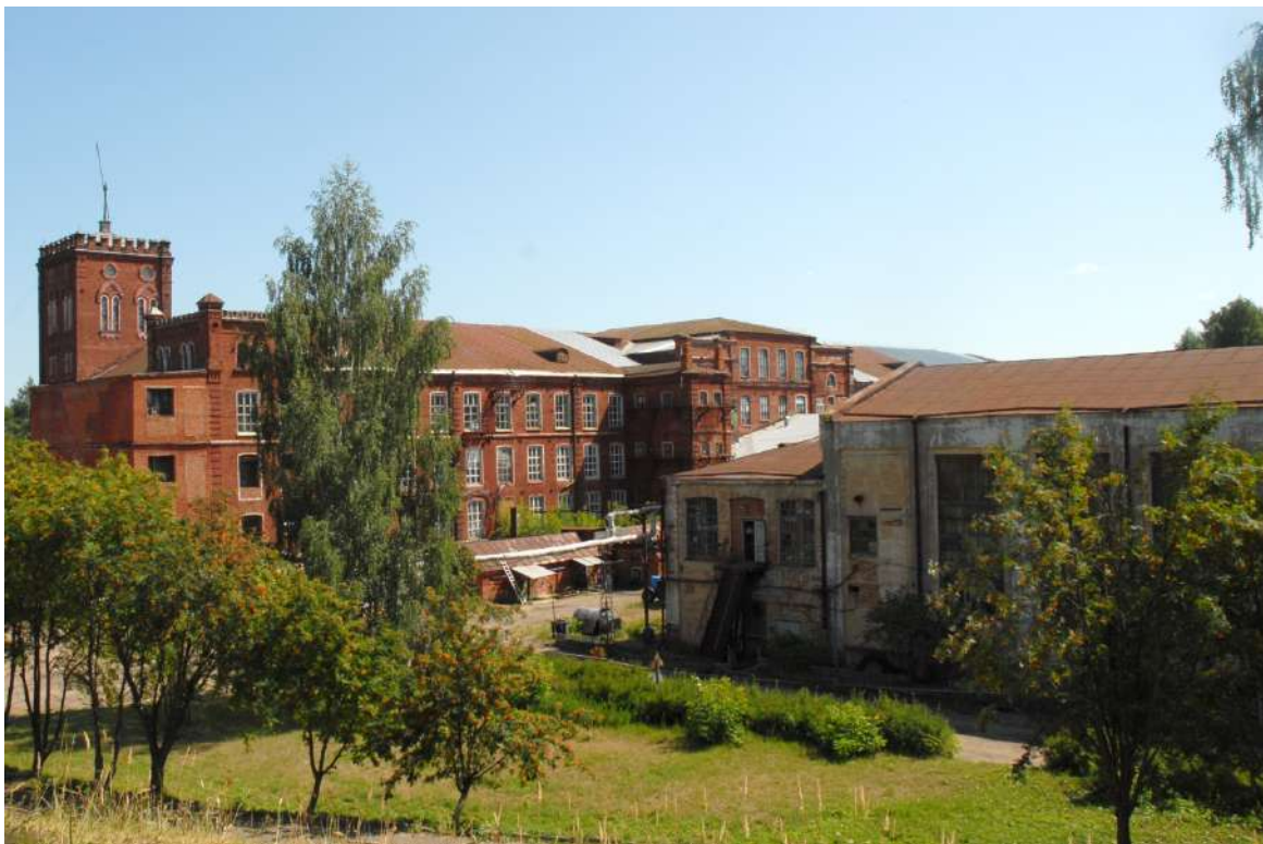
Фото 34а. Общий вид на корпуса с юго-западной стороны
