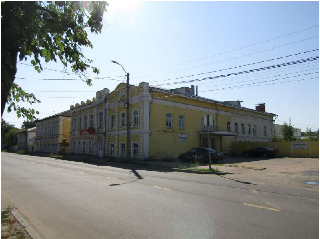
Фото 29а. Вид на юго-восточную часть улицы
