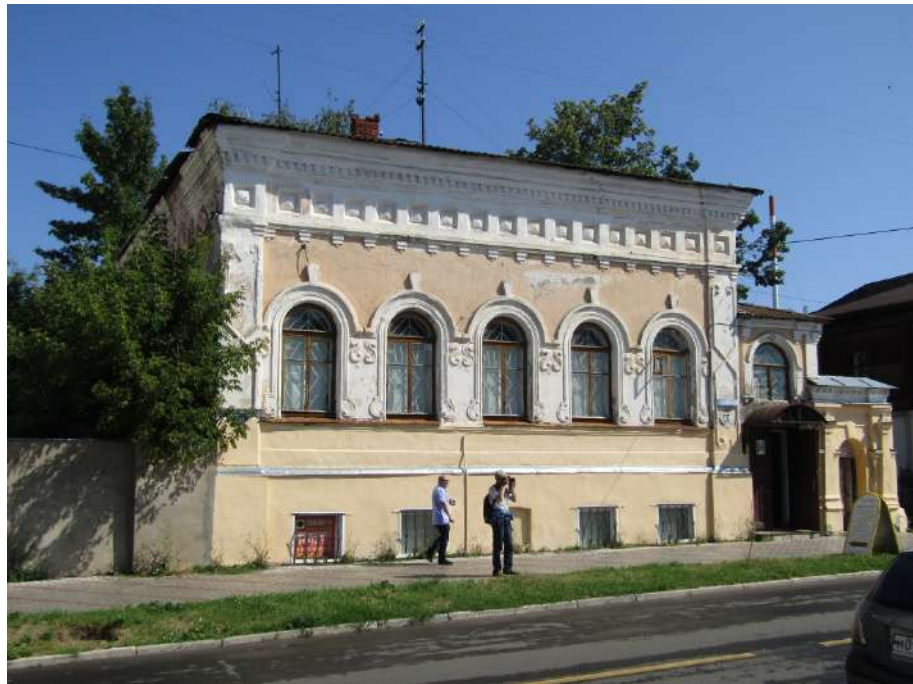
Фото 41. Вид с южной стороны
