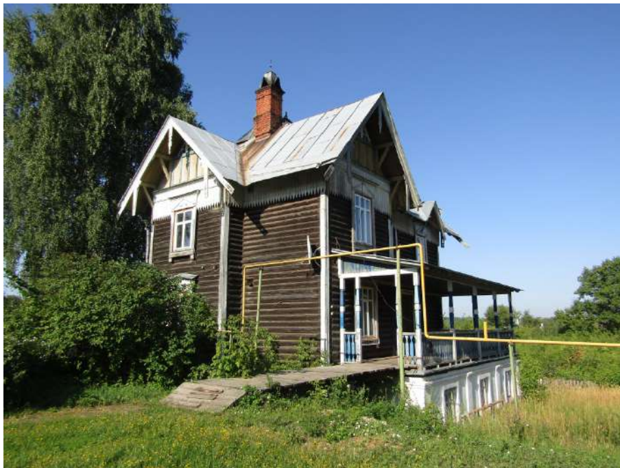
Фото54. Вид дома с восточной стороны
