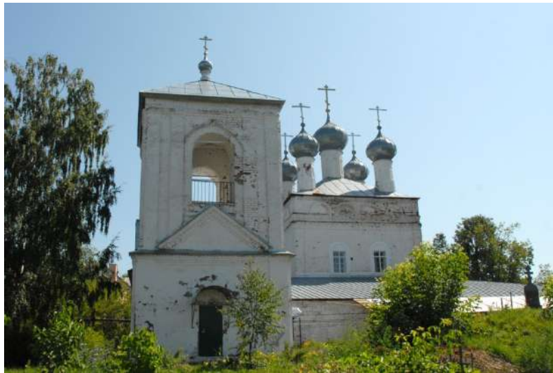
Фото 46. Вид с запада
