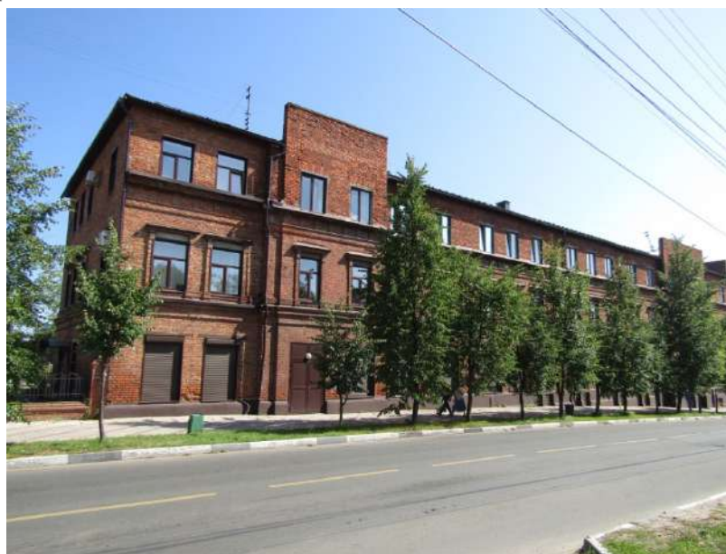
Фото 38.14. Вид с юго-западной стороны
