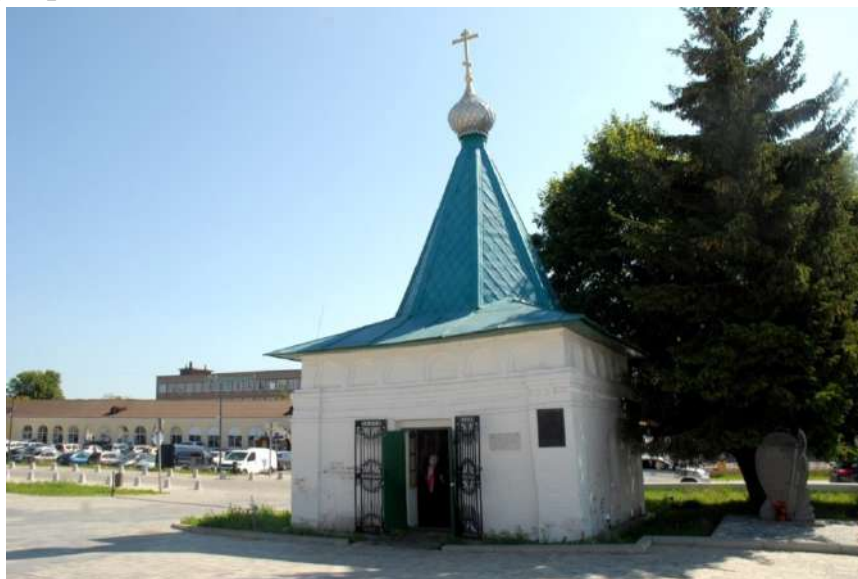
Фото 61. Вид с запада
