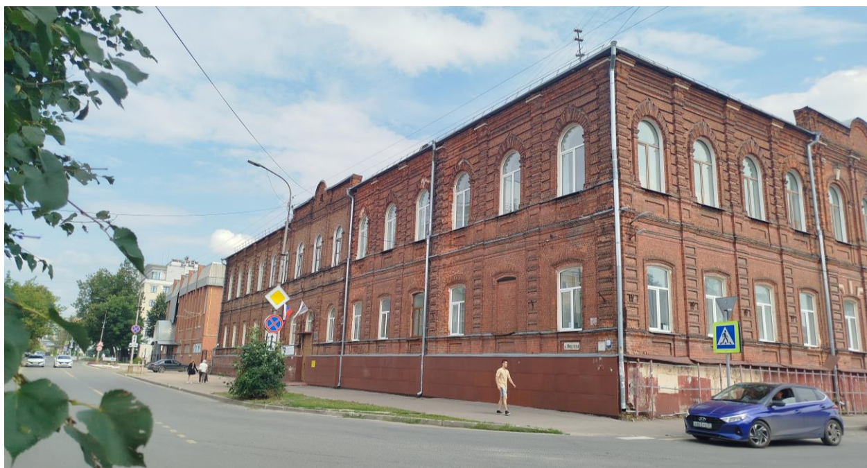
Фото 4. Фасад со стороны ул. Жидилёва Август 2026 г.
