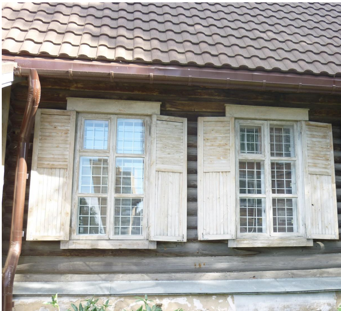
3. Обшивка ставней и расстекловка окон
