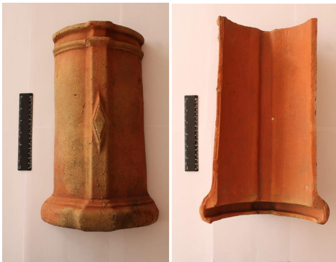
1. Черепица для конька крыши. Слева – лицевая сторона, справа – обратная сторона
