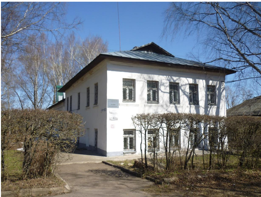
1. Главный (южный) фасад
