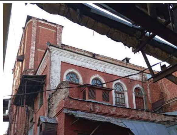
Фото 6. Прядильный корпус. Электростанция. Северный фасад.
