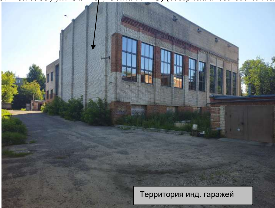
Фото 4., г. Иваново, ул. Сакко у дома № 45, (северный и юго-восточный фасады)
