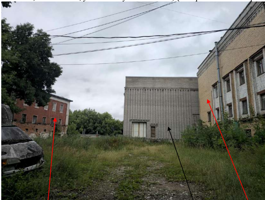
Фото 3., г. Иваново, ул. Сакко у дома № 45, (северо-западный фасад)
