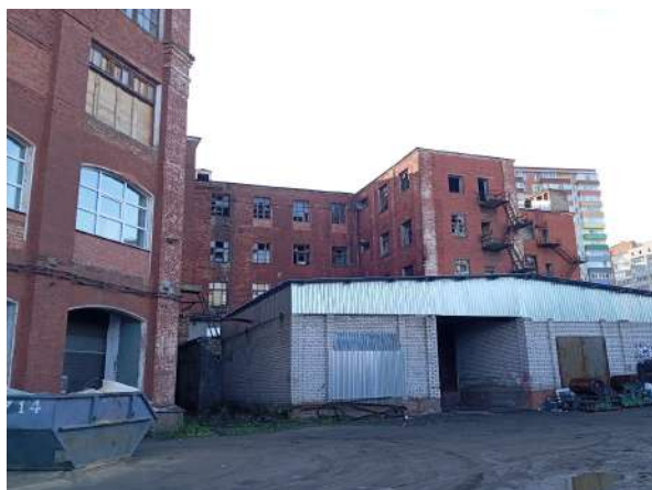
Фото 5. Прядильный корпус. Северный фасад основного блока 1848 г.
