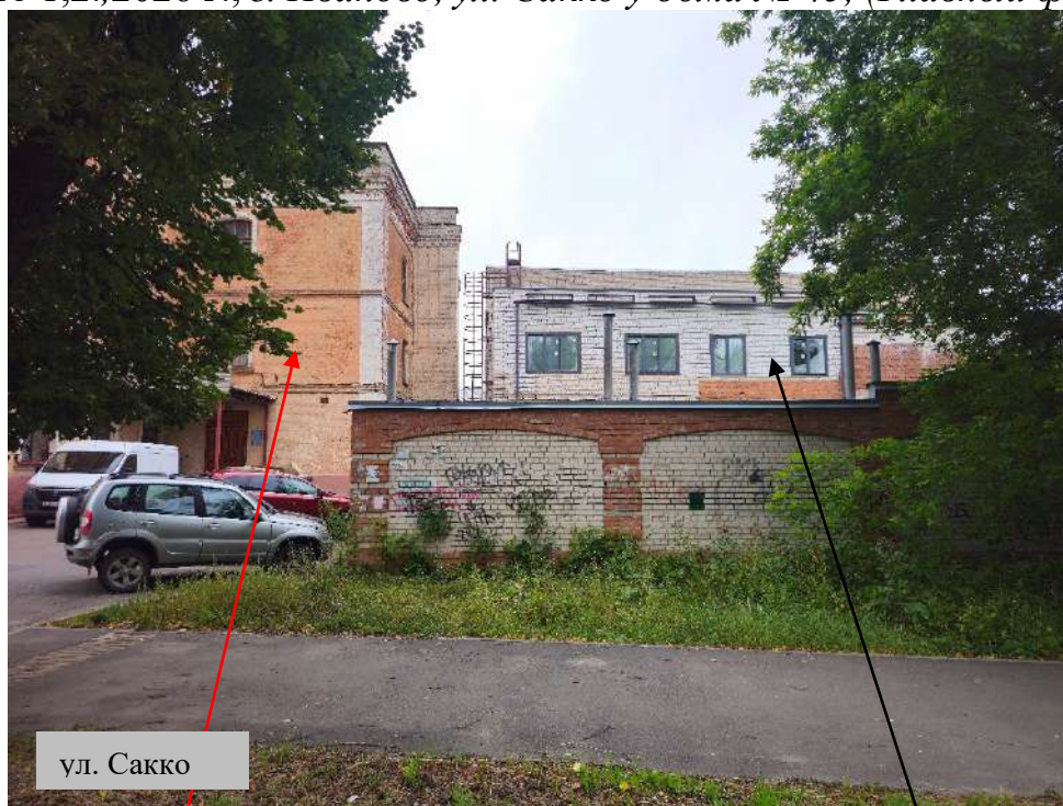
Фото 1,2.,2026 г., г. Иваново, ул. Сакко у дома № 45, (Главный фасад)
