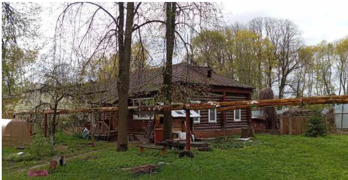
Фото 31. Жилой деревянный дом
