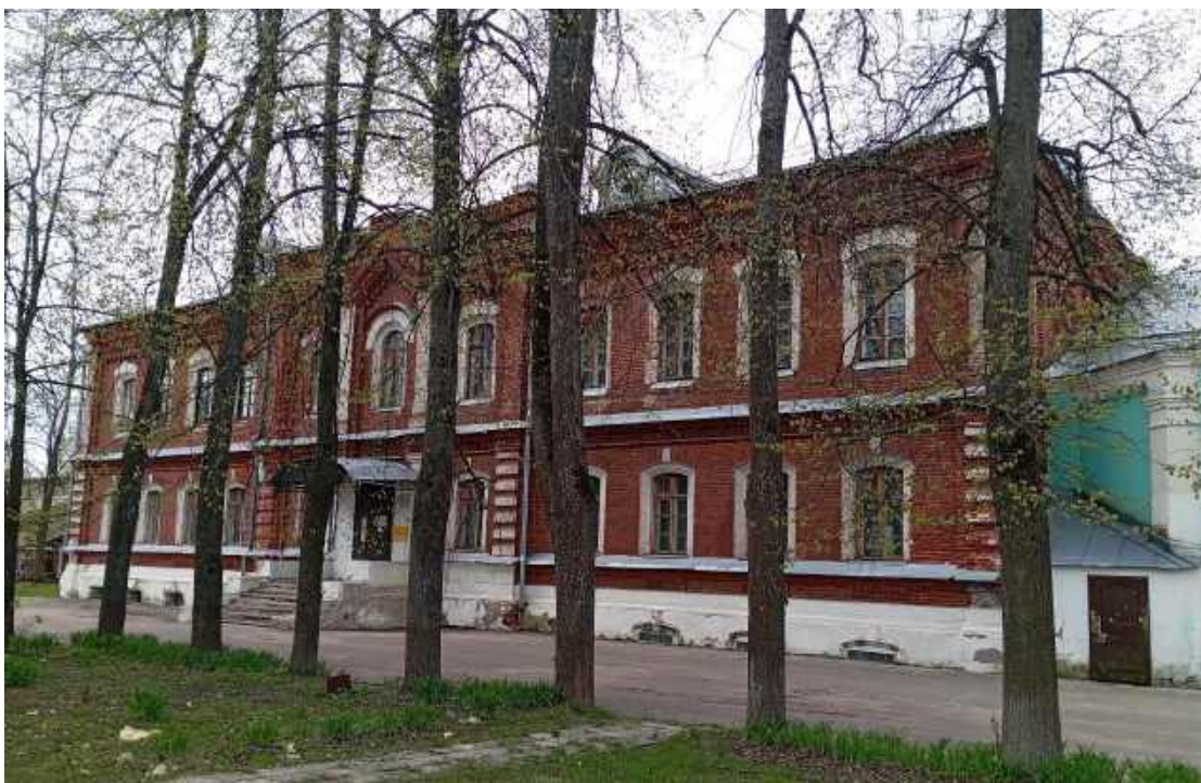
Фото 18. Общий вид главного (восточного) фасада с северо-востока
