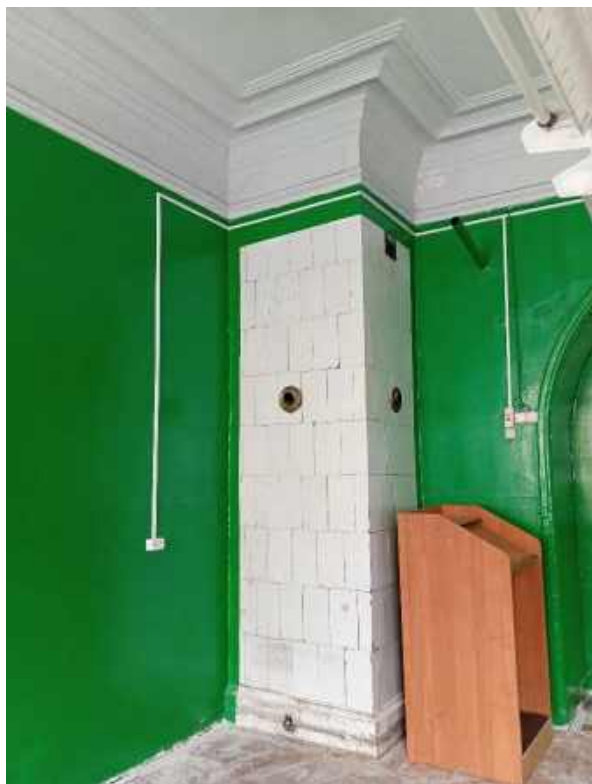
Фото 25. Печь в аудитории 2-го этажа
