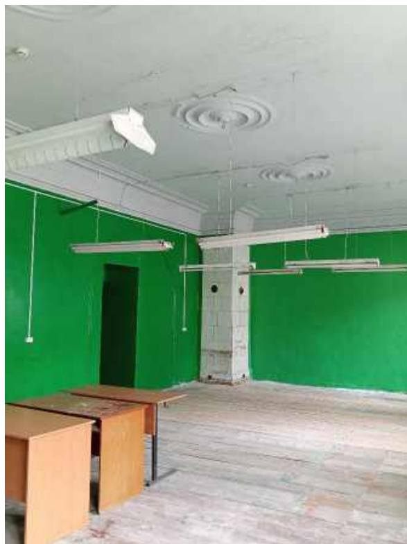
Фото 26. Аудитория 2-го этажа с печью
