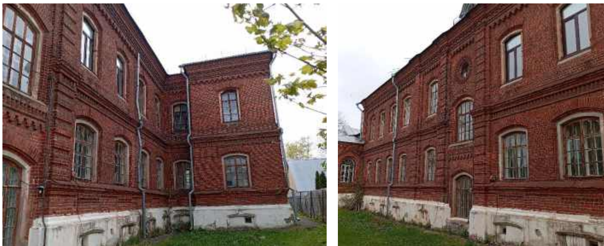
Фото 21, 22. Задний (западный) фасад
