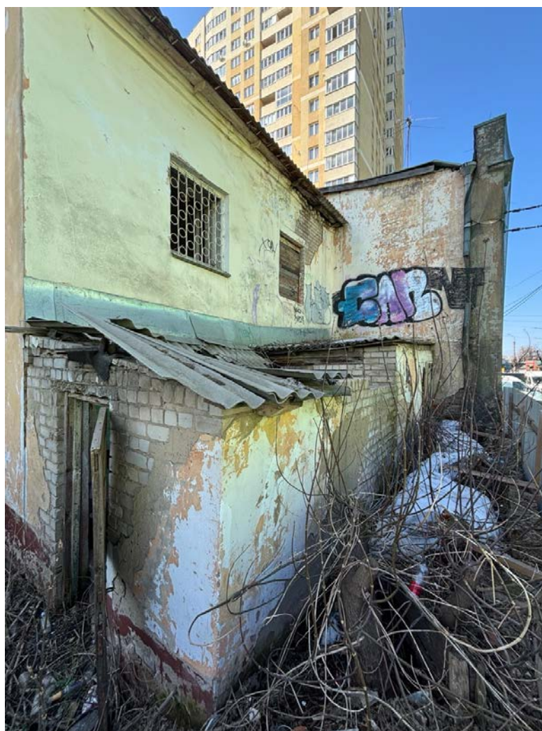
Фото 2. Вид на пристроенные объемы к боковому фасаду (Восточный фасад). Март 2026г.
