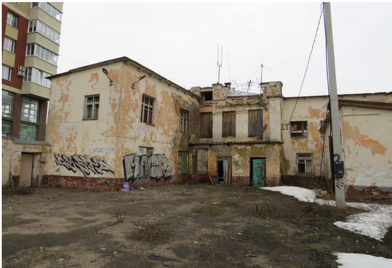
Фото 3. Вид со двора на задний фасад (Южный). Март 2026г.
