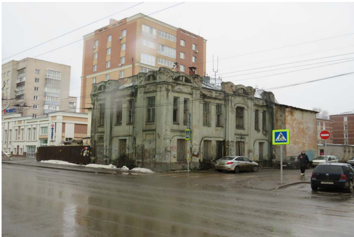
Фото 5. Общий вид на здание со стороны ул. Карла Маркса(Северный и Западный фасады). Март 2026г.
