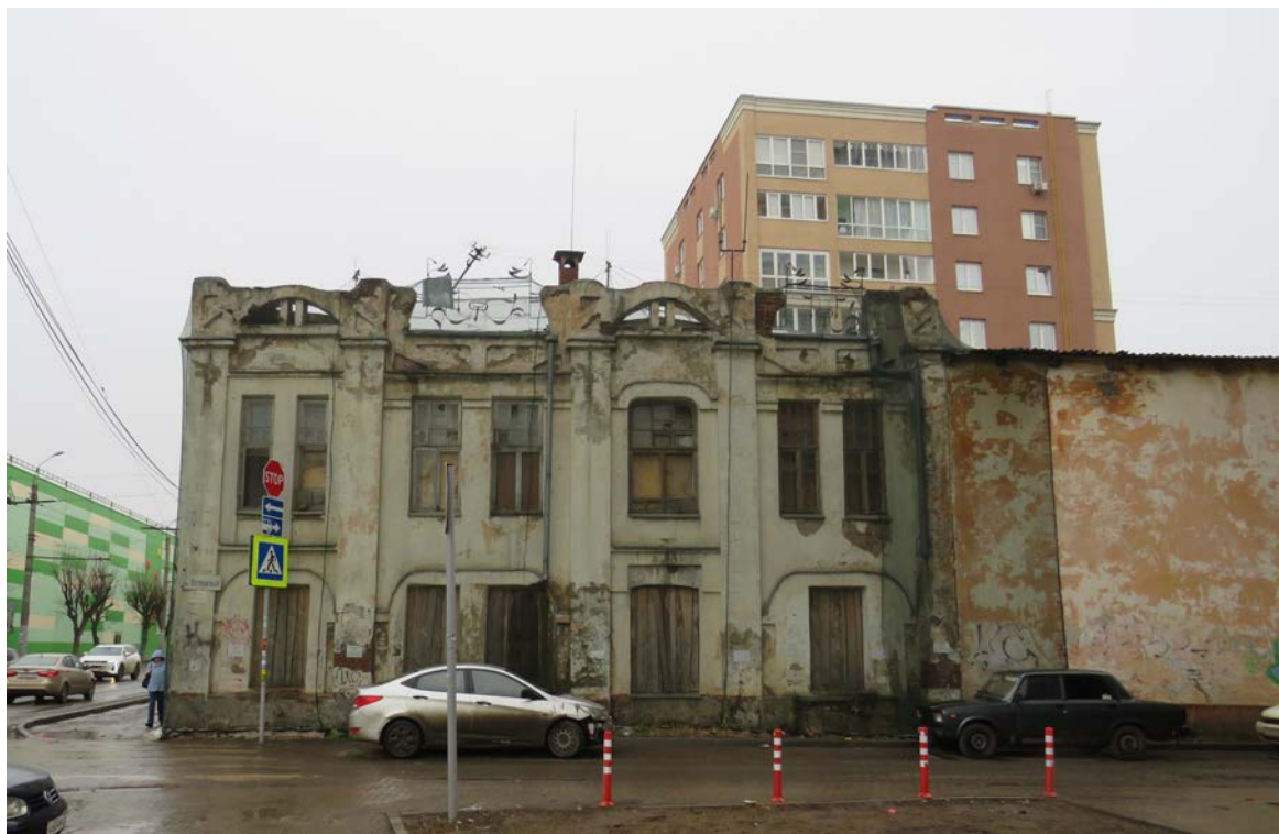
Фото 4. Боковой фасад (Западный). Вид со стороны Пограничного переулка. Март 2026г.
