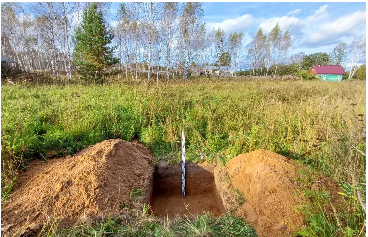
Рис. 26. Ивановская обл., Лухский р-н, распределительный газопровод д. Андреевское. Общий вид с юга выкопанного шурфа № 3.
