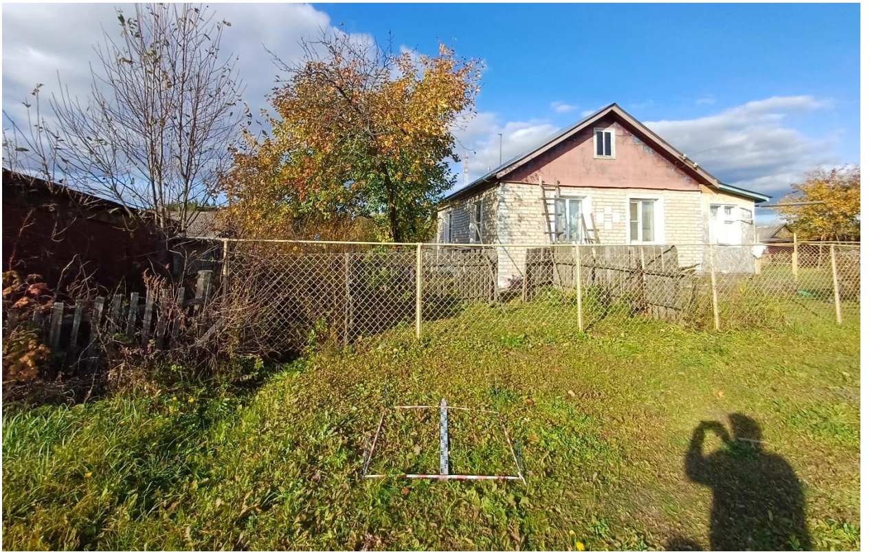
Рис. 77. Ивановская обл., Лухский р-н, распределительный газопровод д. Мясниково. Шурф № 1, разметка и общий вид с юга.
