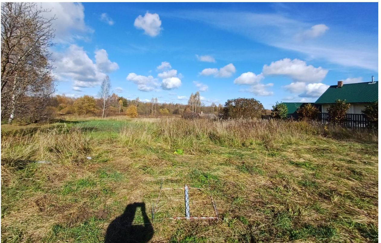
Рис. 123. Ивановская обл., Лухский р-н, распределительный газопровод д. Слободки. Шурф № 3, разметка и общий вид с юга.
