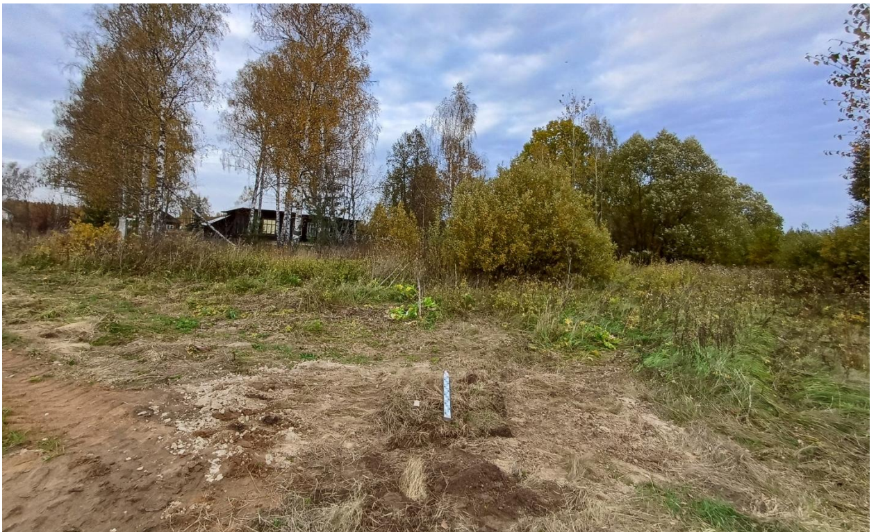
Рис. 174. Ивановская обл., Лухский р-н, распределительный газопровод д. Сорокино. Шурф № 5, рекультивация, вид с юга.
