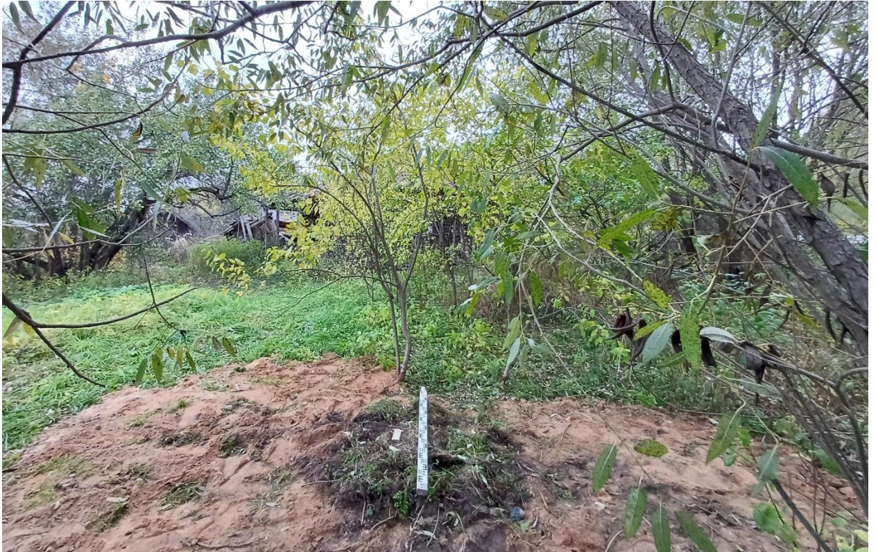
Рис. 153. Ивановская обл., Лухский р-н, распределительный газопровод д. Сорокино. Шурф № 2, рекультивация, вид с юга.
