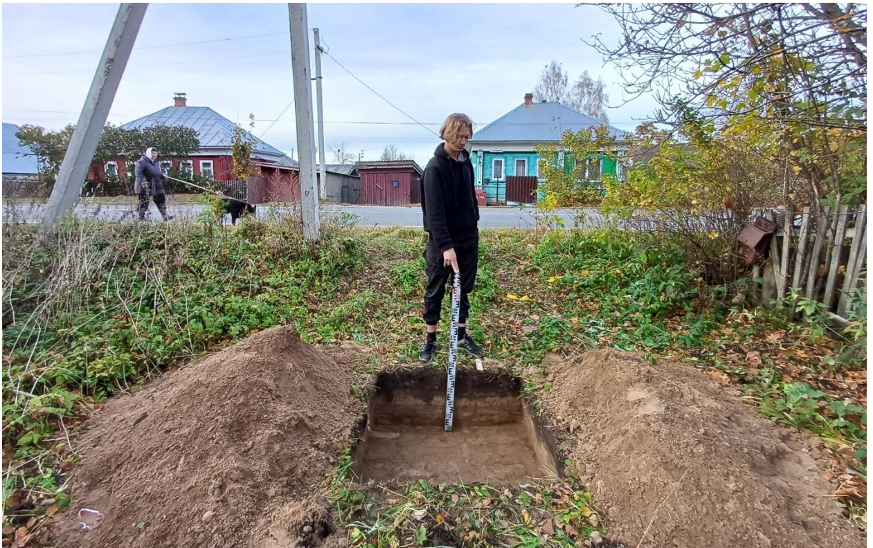
Рис. 101. Ивановская обл., Лухский р-н, распределительный газопровод д. Мясниково. Общий вид с юга выкопанного шурфа № 4.
