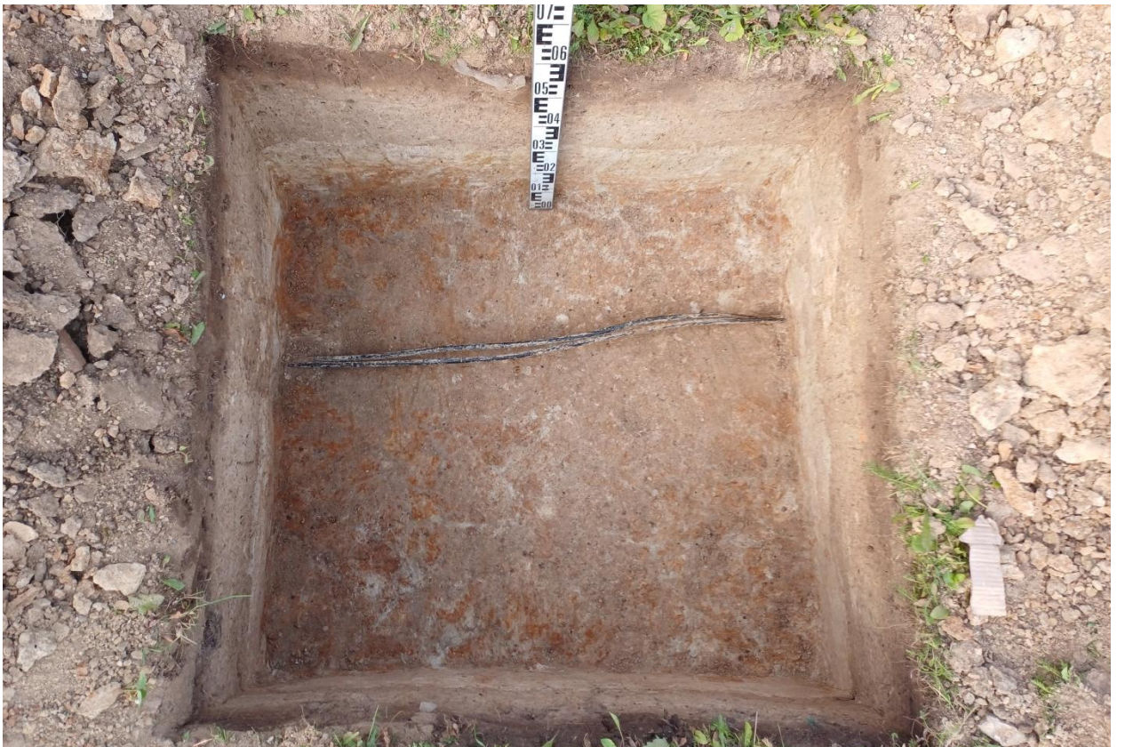
Рис. 78. Ивановская обл., Лухский р-н, распределительный газопровод д. Мясниково. Шурф № 1, зачистка поверхности материка, вид с юга.
