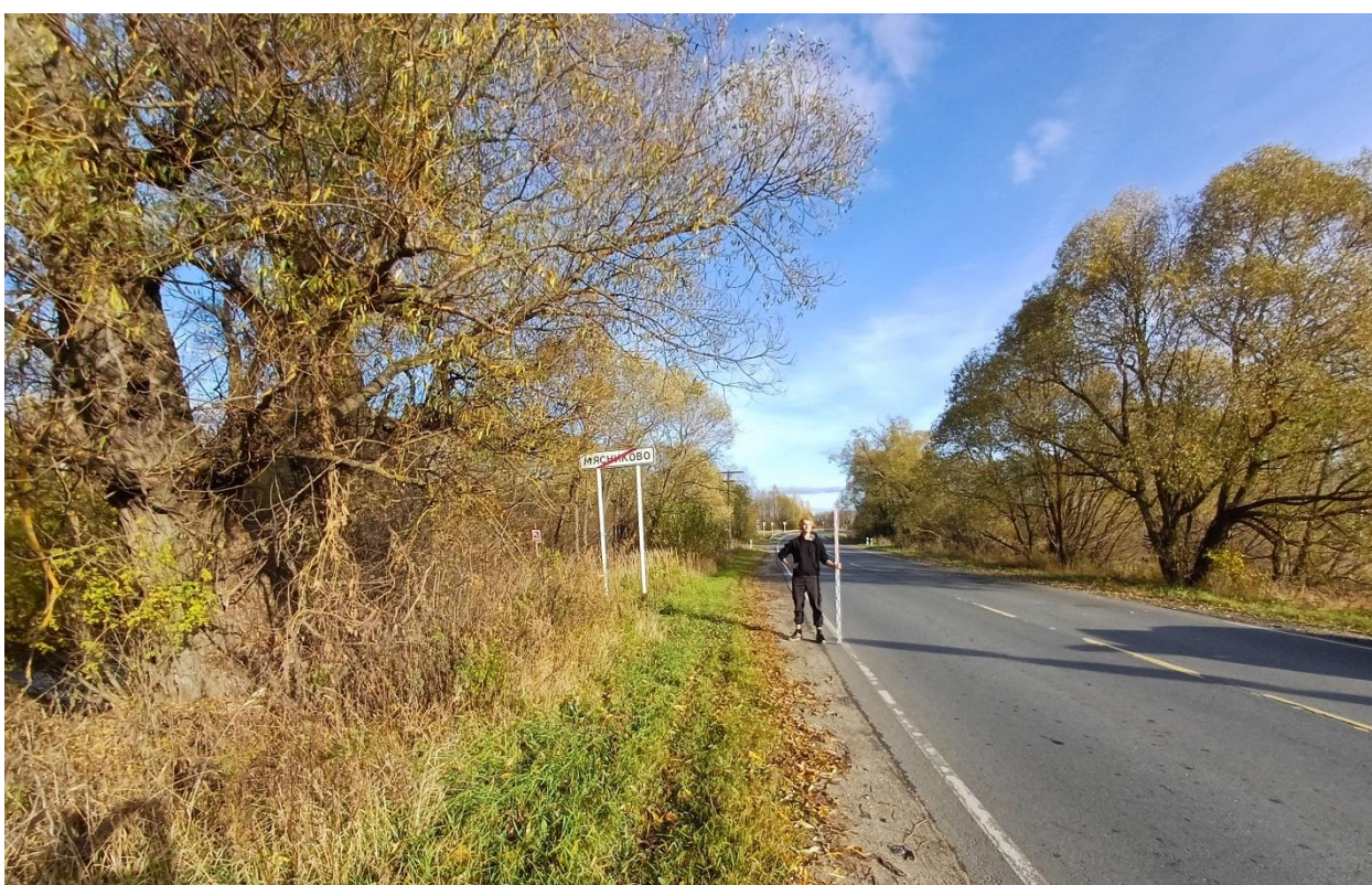
Рис. 96. Ивановская обл., Лухский р-н, распределительный газопровод д. Мясниково. Общий вид с запада участка газопровода по ул. Центральная (точка фотофиксации 4).
