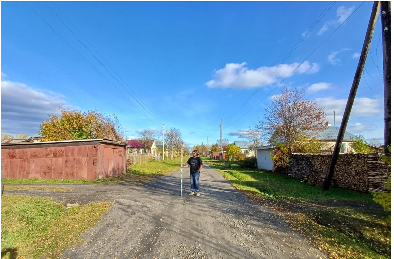
Рис. 75. Ивановская обл., Лухский р-н, распределительный газопровод д. Мясниково. Общий вид с запада участка газопровода на ул. Сосновая (точка фотофиксации 1).
