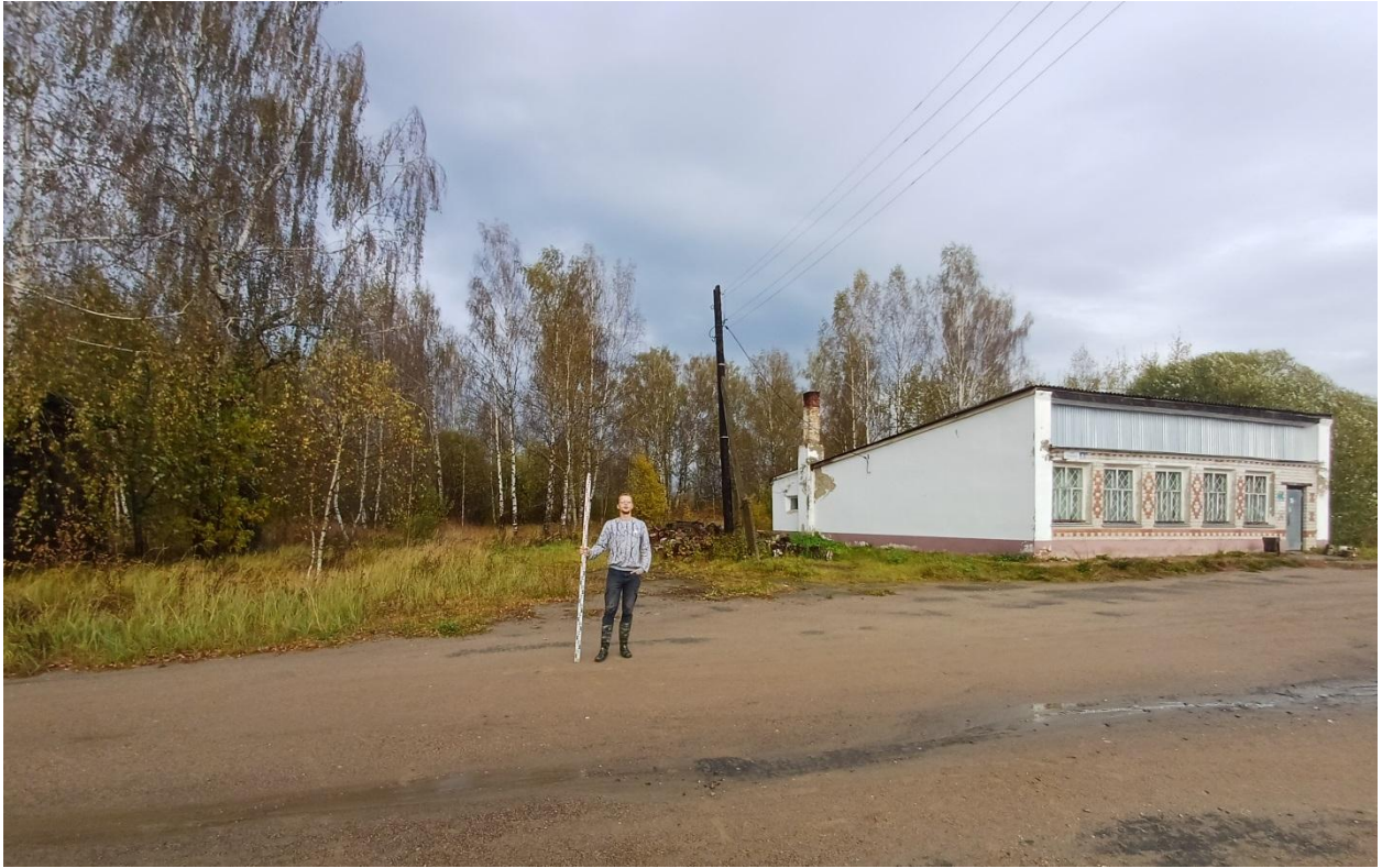
Рис. 155. Ивановская обл., Лухский р-н, распределительный газопровод д. Сорокино. Общий вид с северо-запада на участок газопровода на ул.Полевая (точка фотофиксации 3).
