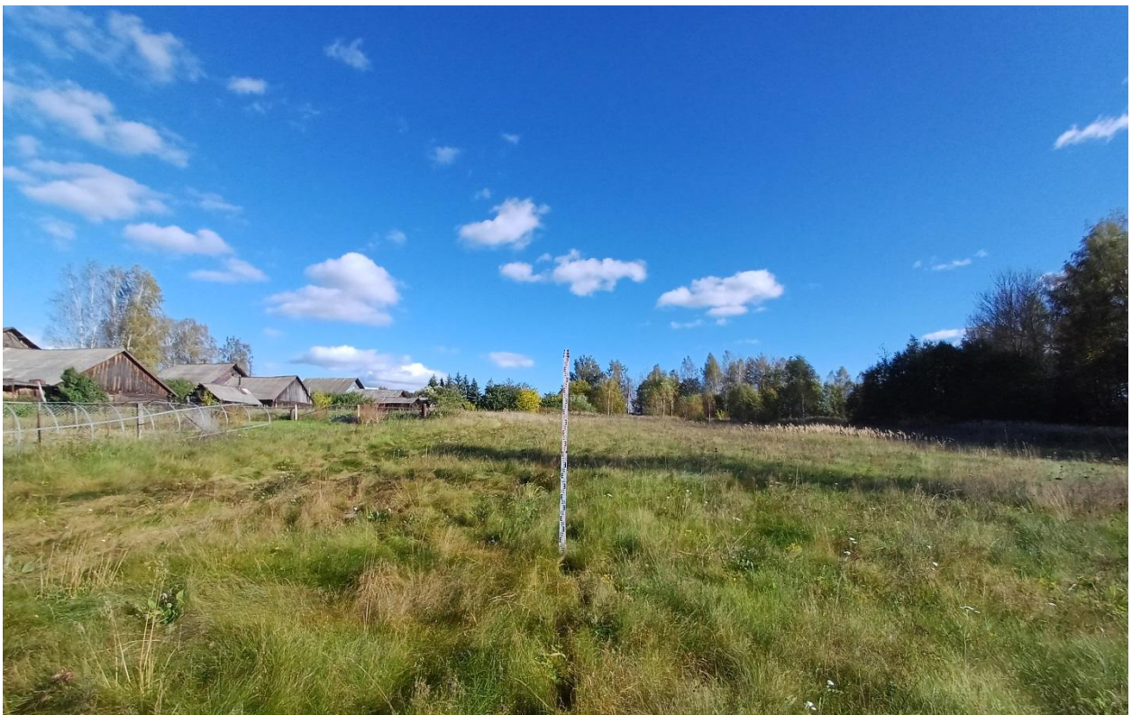
Рис. 63. Ивановская обл., Лухский р-н, распределительный газопровод с. Благовещенье. Общий вид с северо-запада (точка фотофиксации 5).
