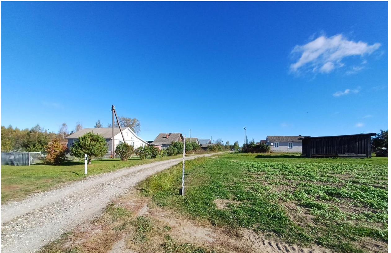
Рис. 42. Ивановская обл., Лухский р-н, распределительный газопровод с. Благовещенье. Общий вид на участок газопровода на ул. Лесная, вид с юго-запада (точка фотофиксации 2).
