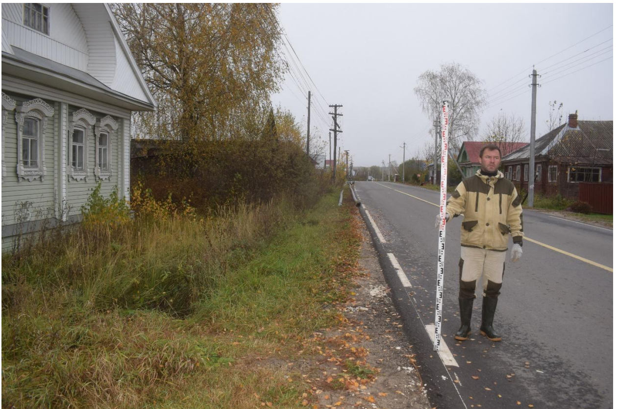
Рис. 82. Ивановская обл., Лухский р-н, распределительный газопровод д. Мясниково. Общий вид с запада участка газопровода по ул. Центральная (точка фотофиксации 2).
