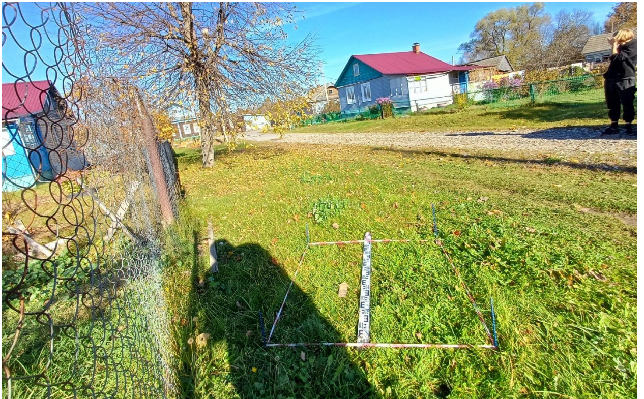
Рис. 130. Ивановская обл., Лухский р-н, распределительный газопровод д. Слободки. Шурф № 4, разметка и общий вид с юга.
