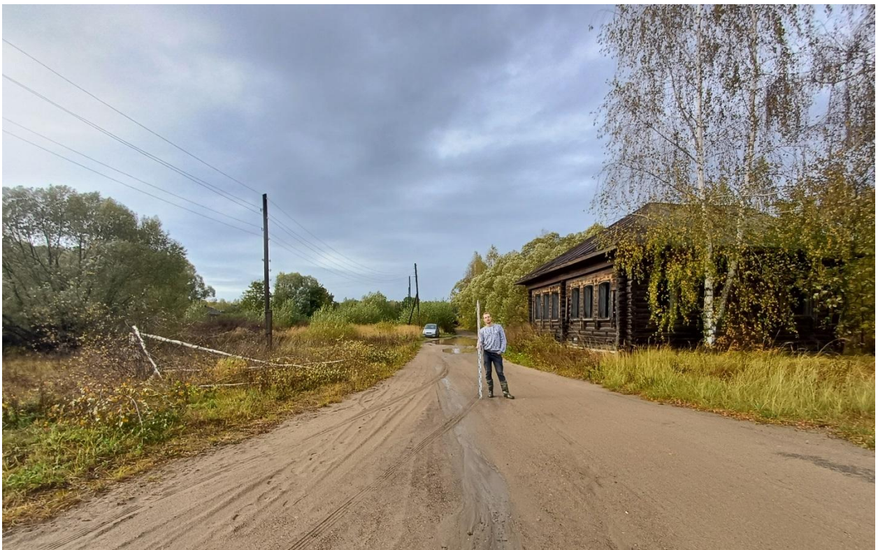
Рис. 154. Ивановская обл., Лухский р-н, распределительный газопровод д. Сорокино. Общий вид с юго-востока на участок газопровода на ул.Полевая (точка фотофиксации 3).
