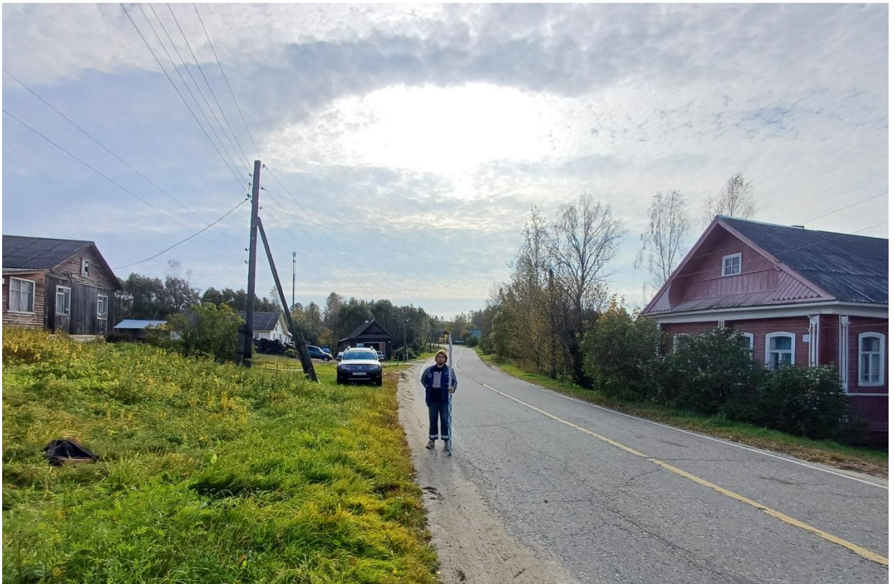
Рис. 36. Ивановская обл., Лухский р-н, распределительный газопровод с. Благовещенье. Общий вид с северо-запада (точка фотофиксации 1).
