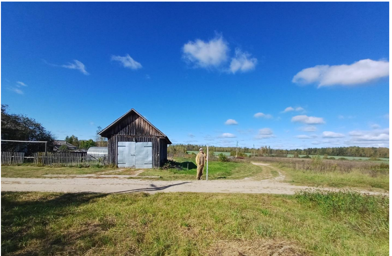
Рис. 49. Ивановская обл., Лухский р-н, распределительный газопровод с. Благовещенье. Общий вид с юго-востока (точка фотофиксации 3).
