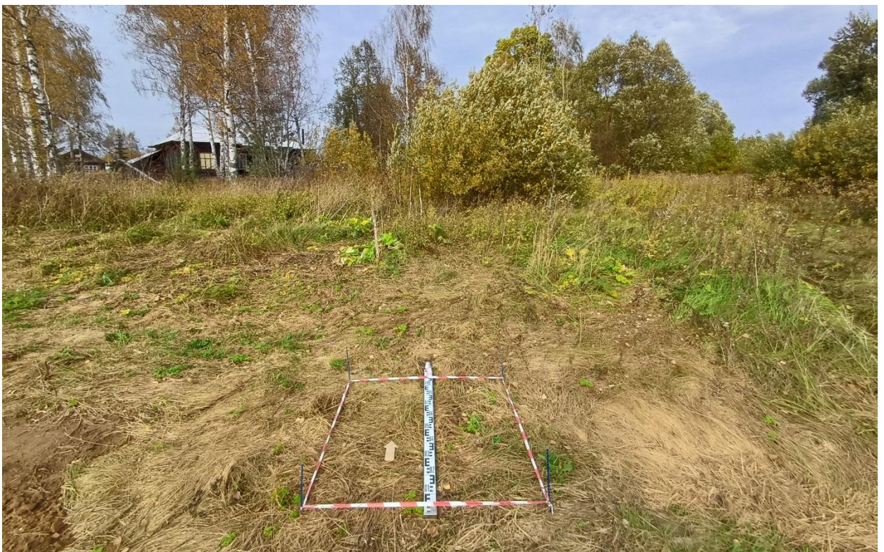
Рис. 170. Ивановская обл., Лухский р-н, распределительный газопровод д. Сорокино. Шурф № 5, разметка и общий вид с юга.
