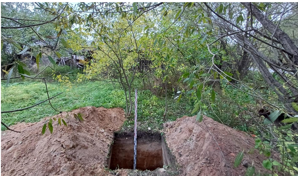
Рис. 152. Ивановская обл., Лухский р-н, распределительный газопровод д. Сорокино. Общий вид с юга выкопанного шурфа № 2.
