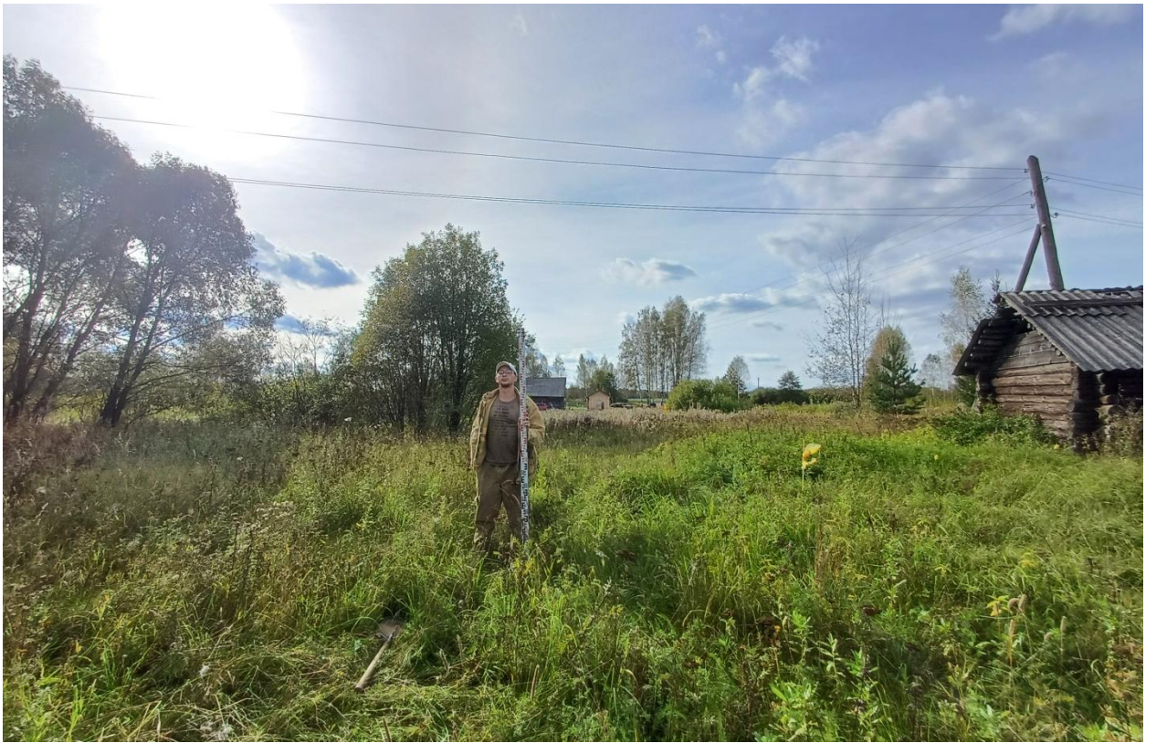
Рис. 21. Ивановская обл., Лухский р-н, распределительный газопровод д. Андреевское. Общий вид с запада-юго-запада (точка фотофиксации 3).
