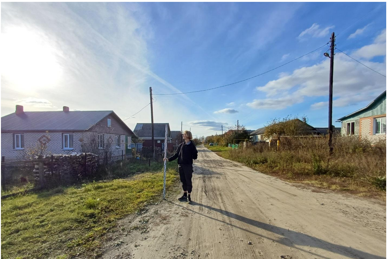
Рис. 90. Ивановская обл., Лухский р-н, распределительный газопровод д. Мясниково. Общий вид с запада участка газопровода на ул. Саватеева (точка фотофиксации 3).
