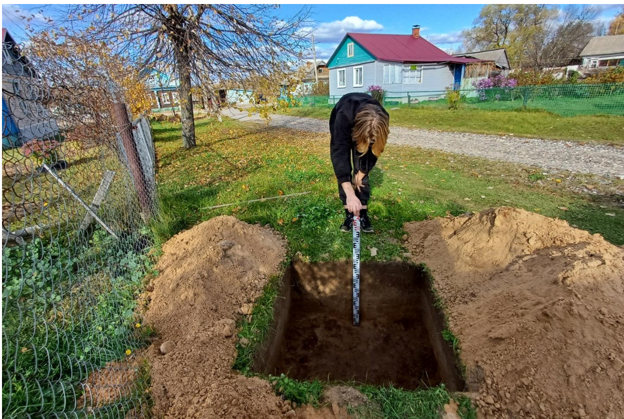
Рис. 133. Ивановская обл., Лухский р-н, распределительный газопровод д. Слободки. Общий вид с юга выкопанного шурфа № 4.
