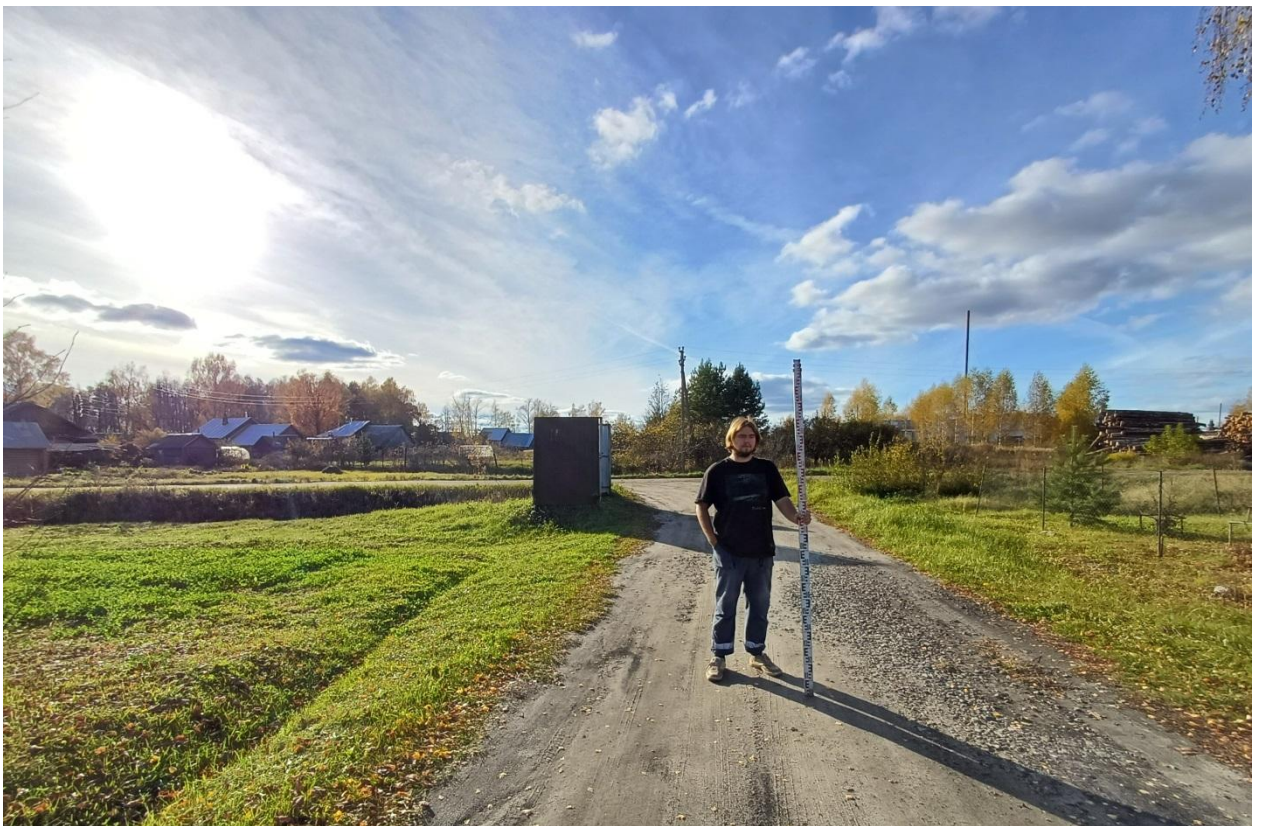
Рис. 76. Ивановская обл., Лухский р-н, распределительный газопровод д. Мясниково. Общий вид с востока участка газопровода на ул. Сосновая (точка фотофиксации 1).
