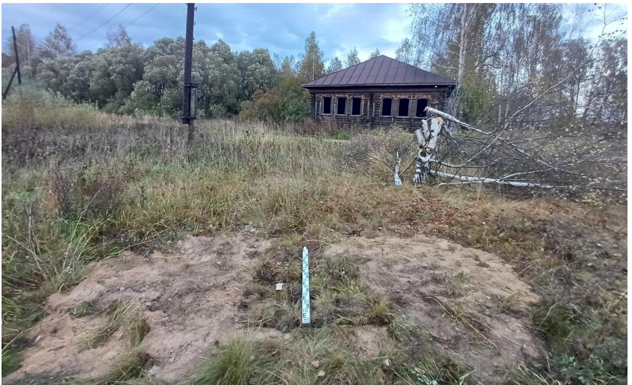
Рис. 160. Ивановская обл., Лухский р-н, распределительный газопровод д. Сорокино. Шурф № 3, рекультивация, вид с юга.
