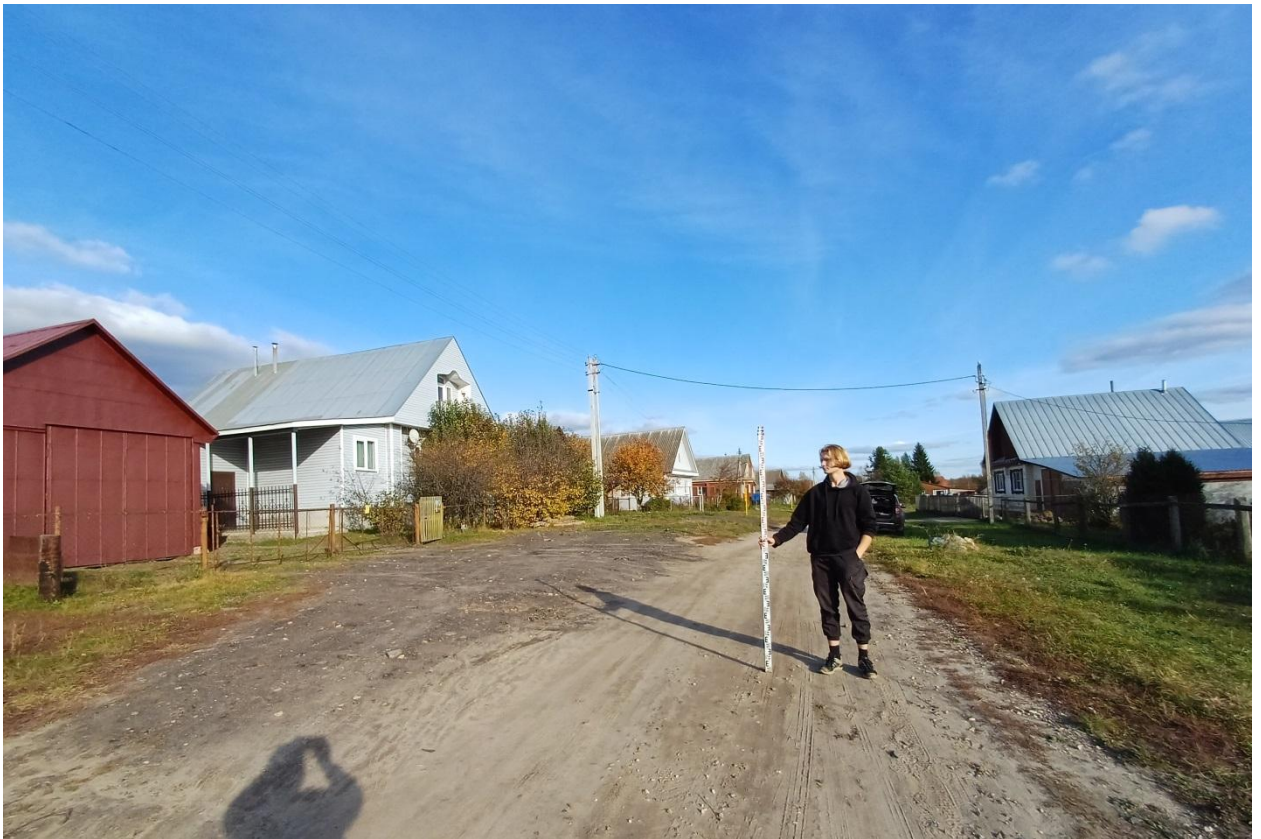
Рис. 89. Ивановская обл., Лухский р-н, распределительный газопровод д. Мясниково. Общий вид с востока участка газопровода на ул. Саватеева (точка фотофиксации 3).
