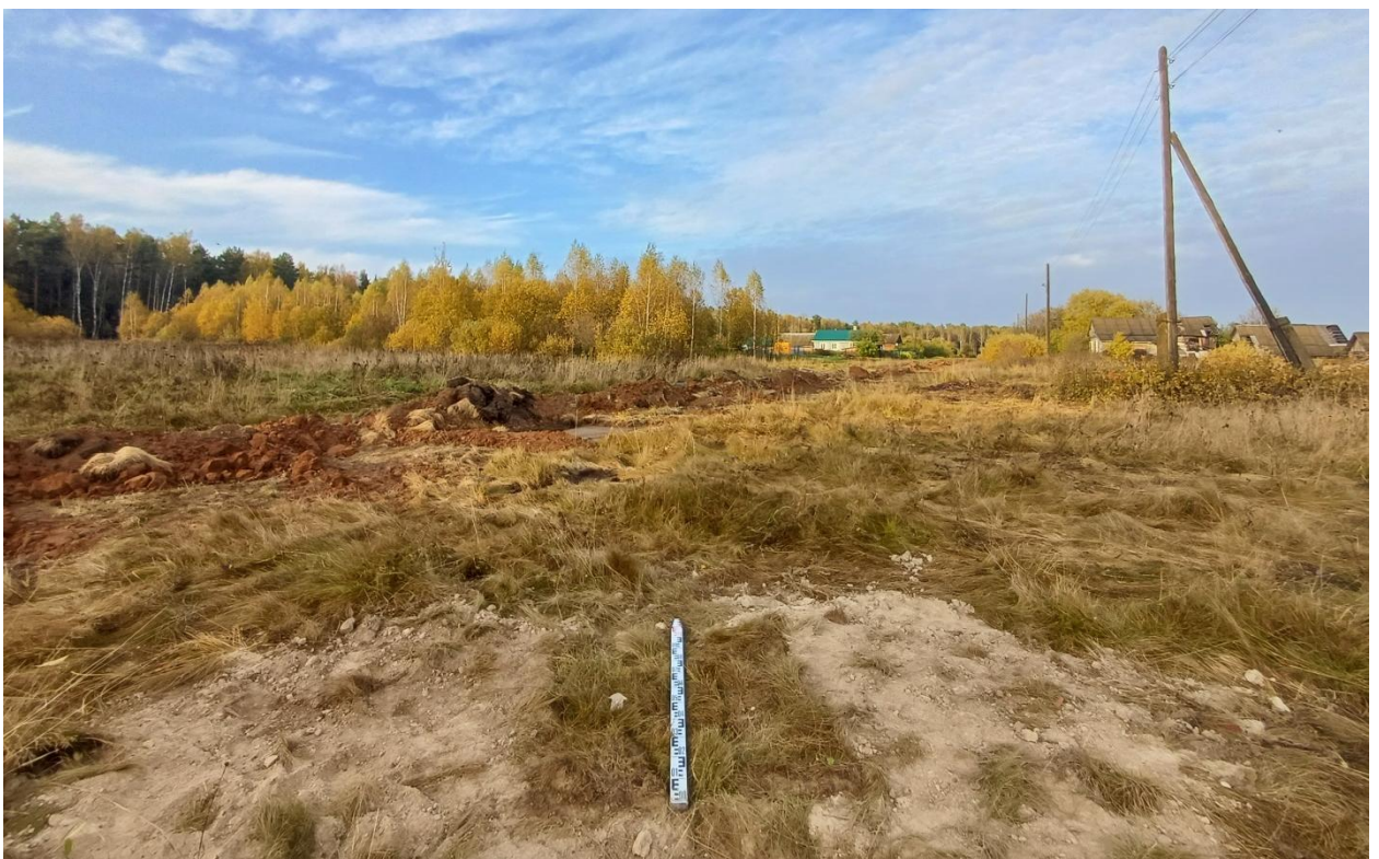
Рис. 180. Ивановская обл., Лухский р-н, распределительный газопровод д. Сорокино. Шурф № 6, рекультивация, вид с юга.
