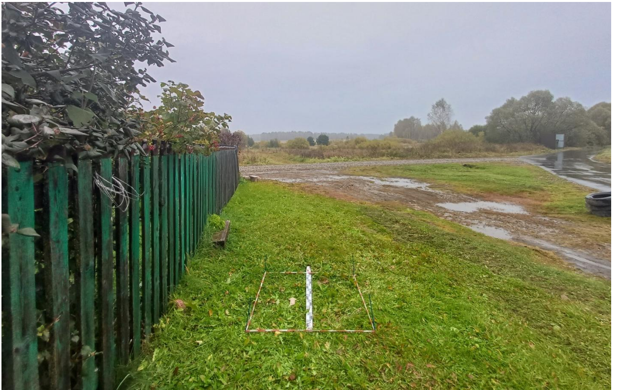
Рис. 143. Ивановская обл., Лухский р-н, распределительный газопровод д. Сорокино. Шурф № 1, разметка и общий вид с юга.
