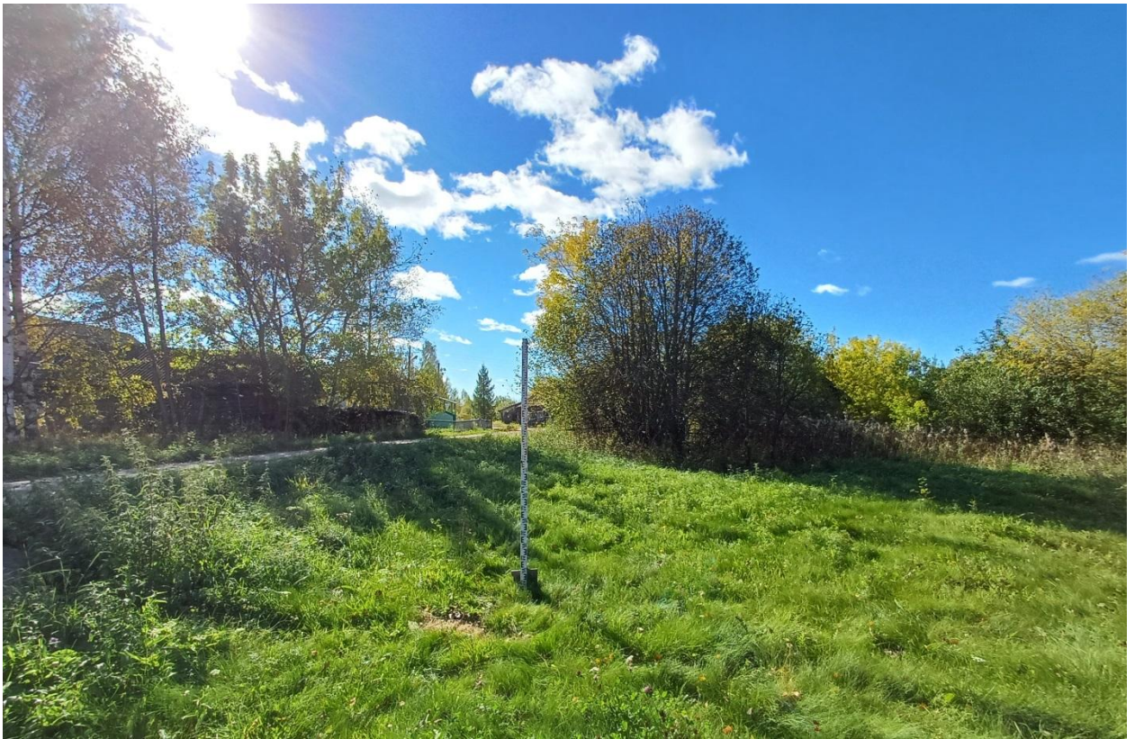
Рис. 56. Ивановская обл., Лухский р-н, распределительный газопровод с. Благовещенье. Общий вид с северо-востока (точка фотофиксации 4).
