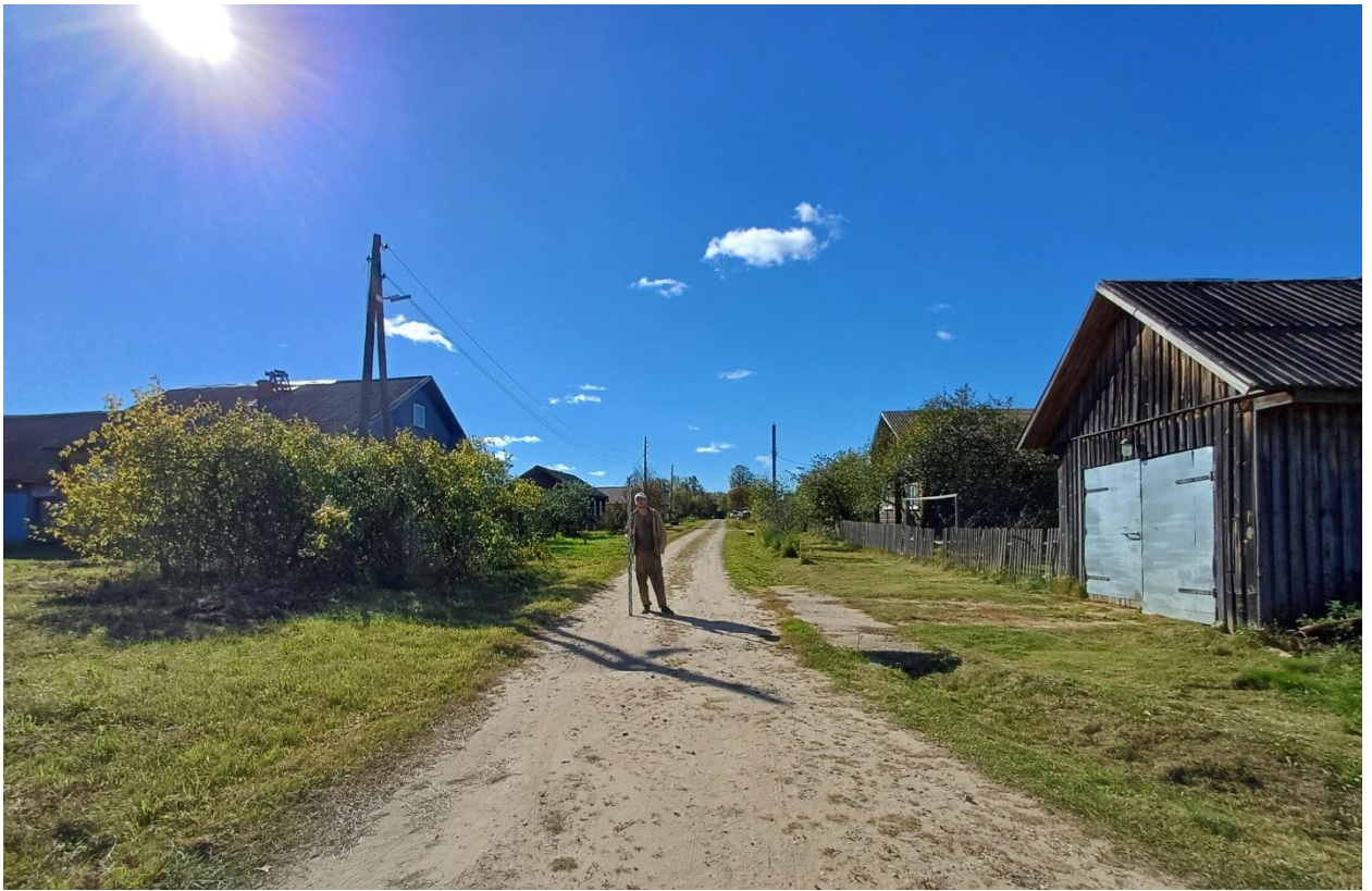
Рис. 48. Ивановская обл., Лухский р-н, распределительный газопровод с. Благовещенье. Общий вид с северо-востока на участок газопровода на ул. Библиотечная (точка фотофиксации 3).
