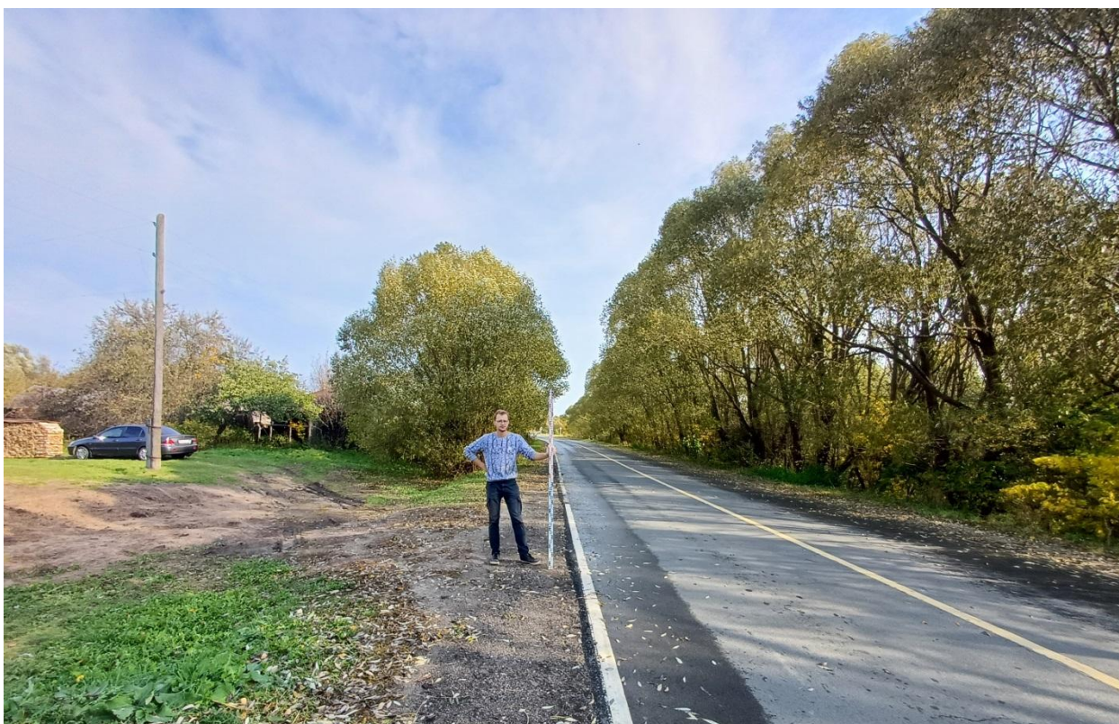
Рис. 148. Ивановская обл., Лухский р-н, распределительный газопровод д. Сорокино. Общий вид с юго-запада участка газопровода на ул. Центральная (точка фотофиксации 2).
