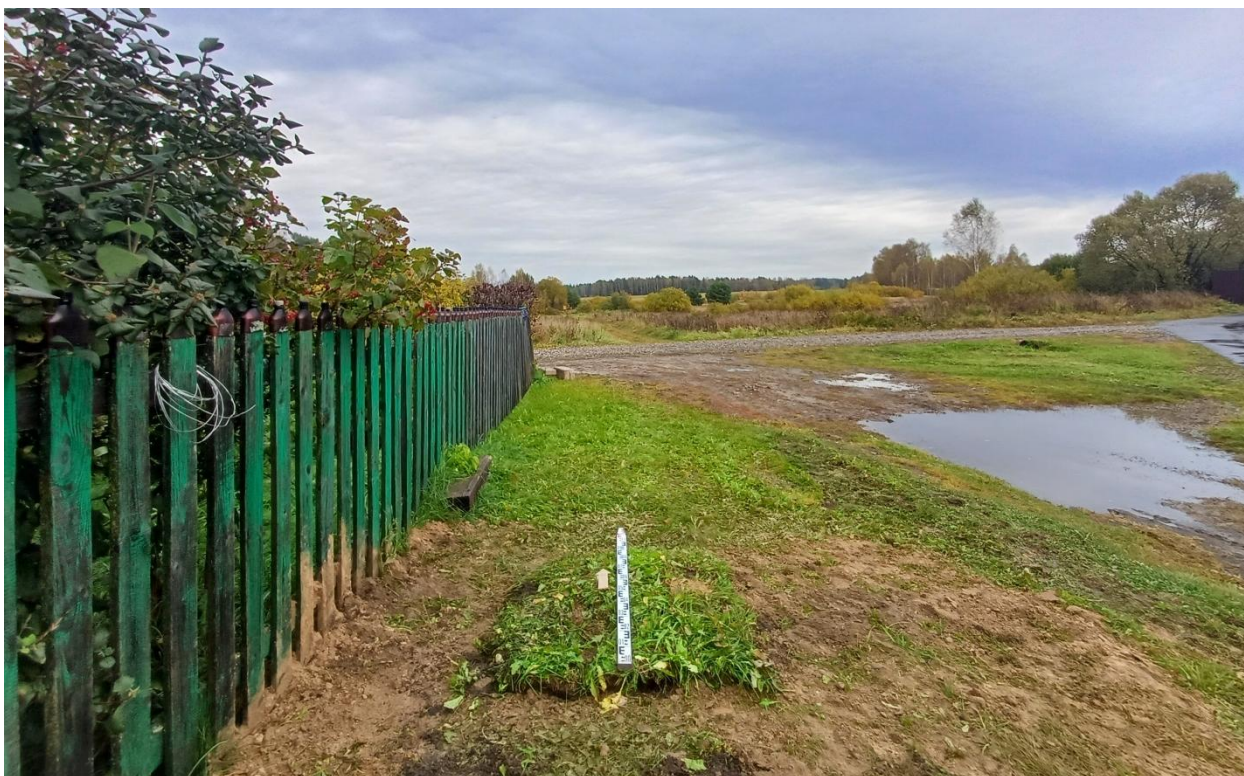
Рис. 147. Ивановская обл., Лухский р-н, распределительный газопровод д. Сорокино. Шурф № 1, рекультивация, вид с юга.
