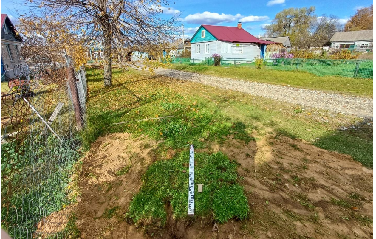
Рис. 134. Ивановская обл., Лухский р-н, распределительный газопровод д. Слободки. Шурф № 4, рекультивация, вид с юга.
