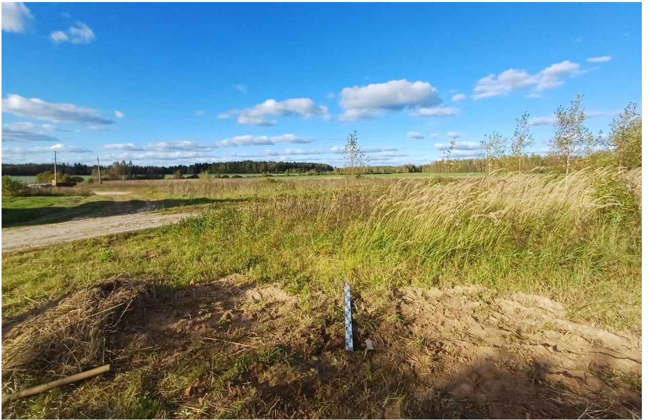
Рис. 54. Ивановская обл., Лухский р-н, распределительный газопровод с. Благовещенье. Шурф № 3, рекультивация, вид с юга.
