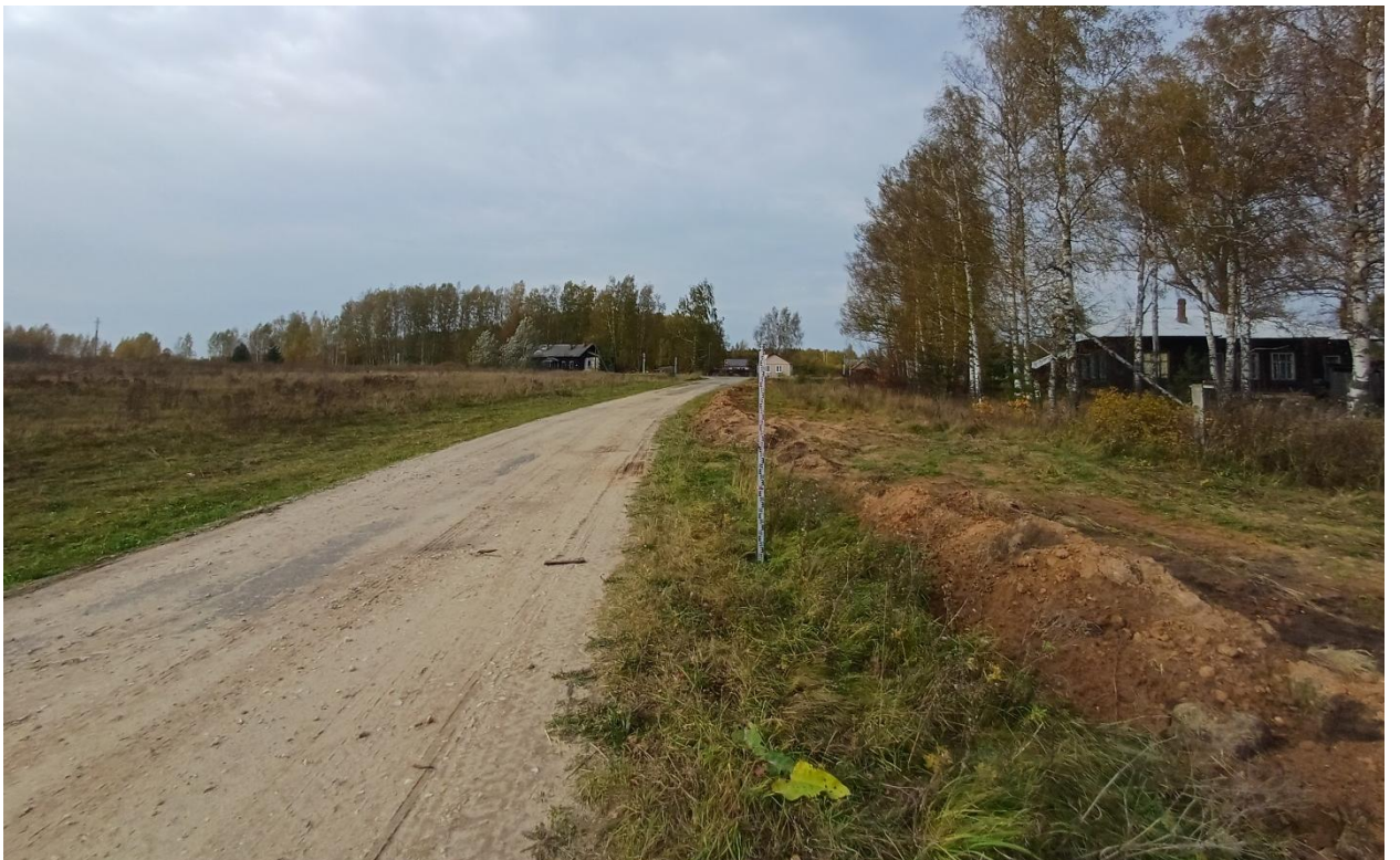
Рис. 168. Ивановская обл., Лухский р-н, распределительный газопровод д. Сорокино. Общий вид участка газопровода с юго-востока (точка фотофиксации 5).
