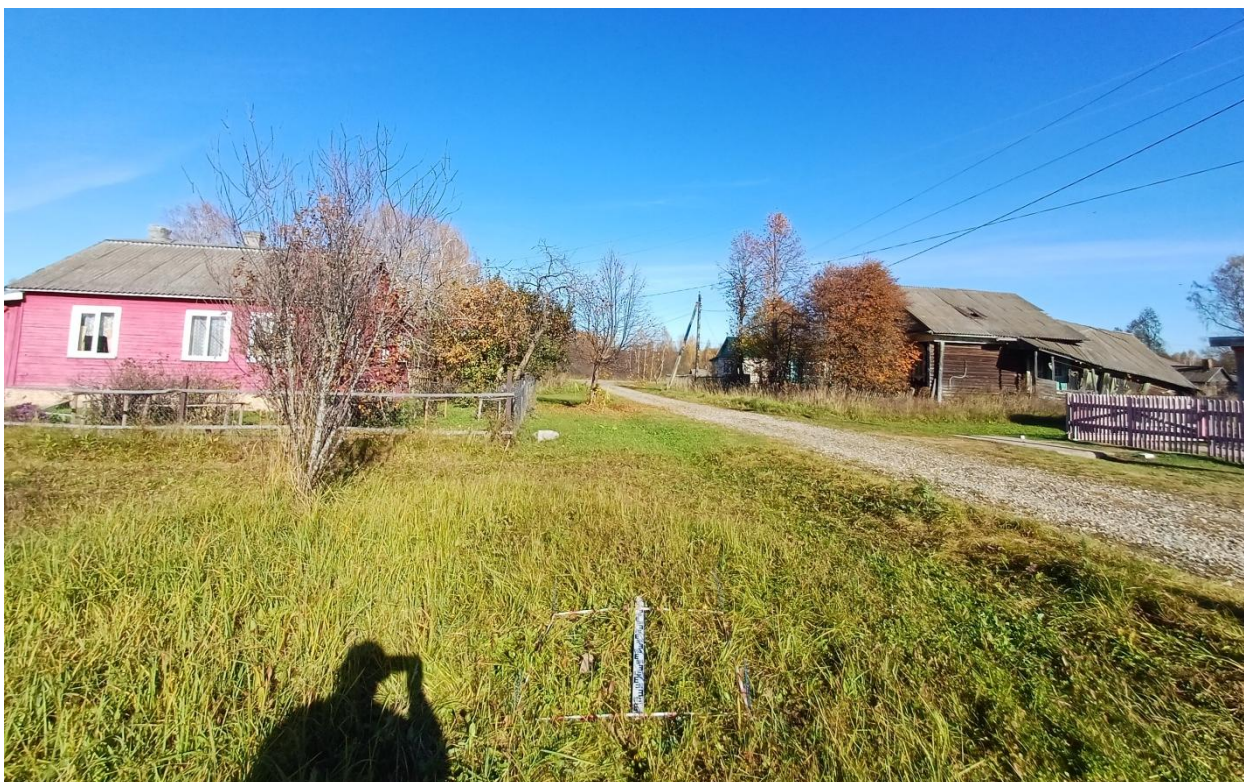
Рис. 110. Ивановская обл., Лухский р-н, распределительный газопровод д. Слободки. Шурф № 1, разметка и общий вид с юга.
