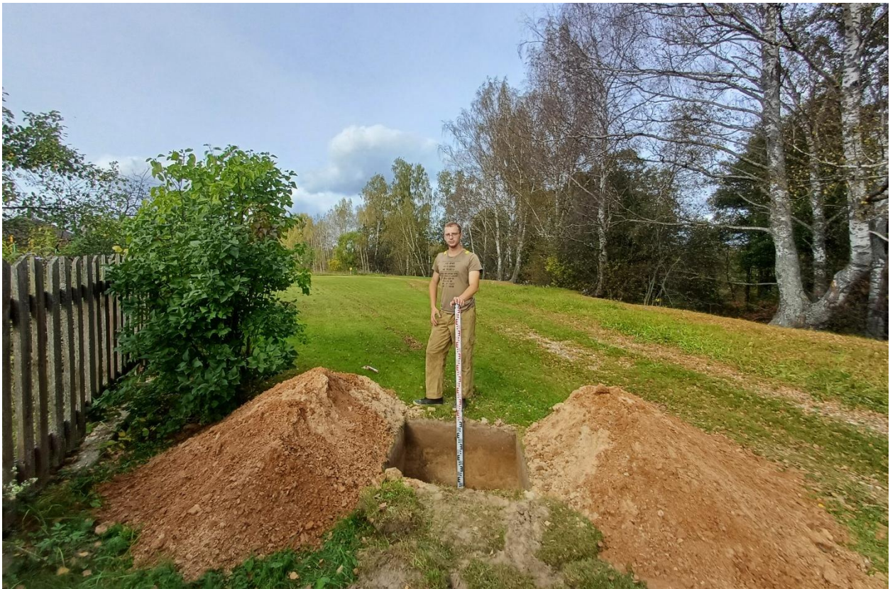
Рис. 13. Ивановская обл., Лухский р-н, распределительный газопровод д. Андреевское. Общий вид выкопанного шурфа № 1 с юга.
