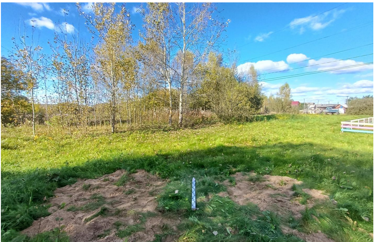
Рис. 61. Ивановская обл., Лухский р-н, распределительный газопровод с. Благовещенье. Шурф № 4, рекультивация, вид с юга.
