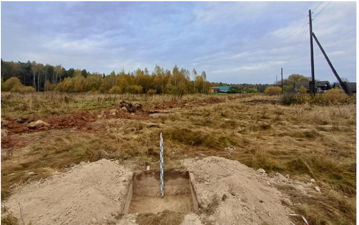
Рис. 179. Ивановская обл., Лухский р-н, распределительный газопровод д. Сорокино. Общий вид выкопанного шурфа № 6 с юга.
