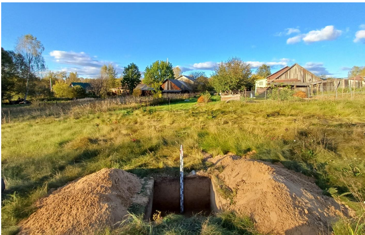
Рис. 67. Ивановская обл., Лухский р-н, распределительный газопровод с. Благовещенье. Общий вид с юга выкопанного шурфа № 5.
