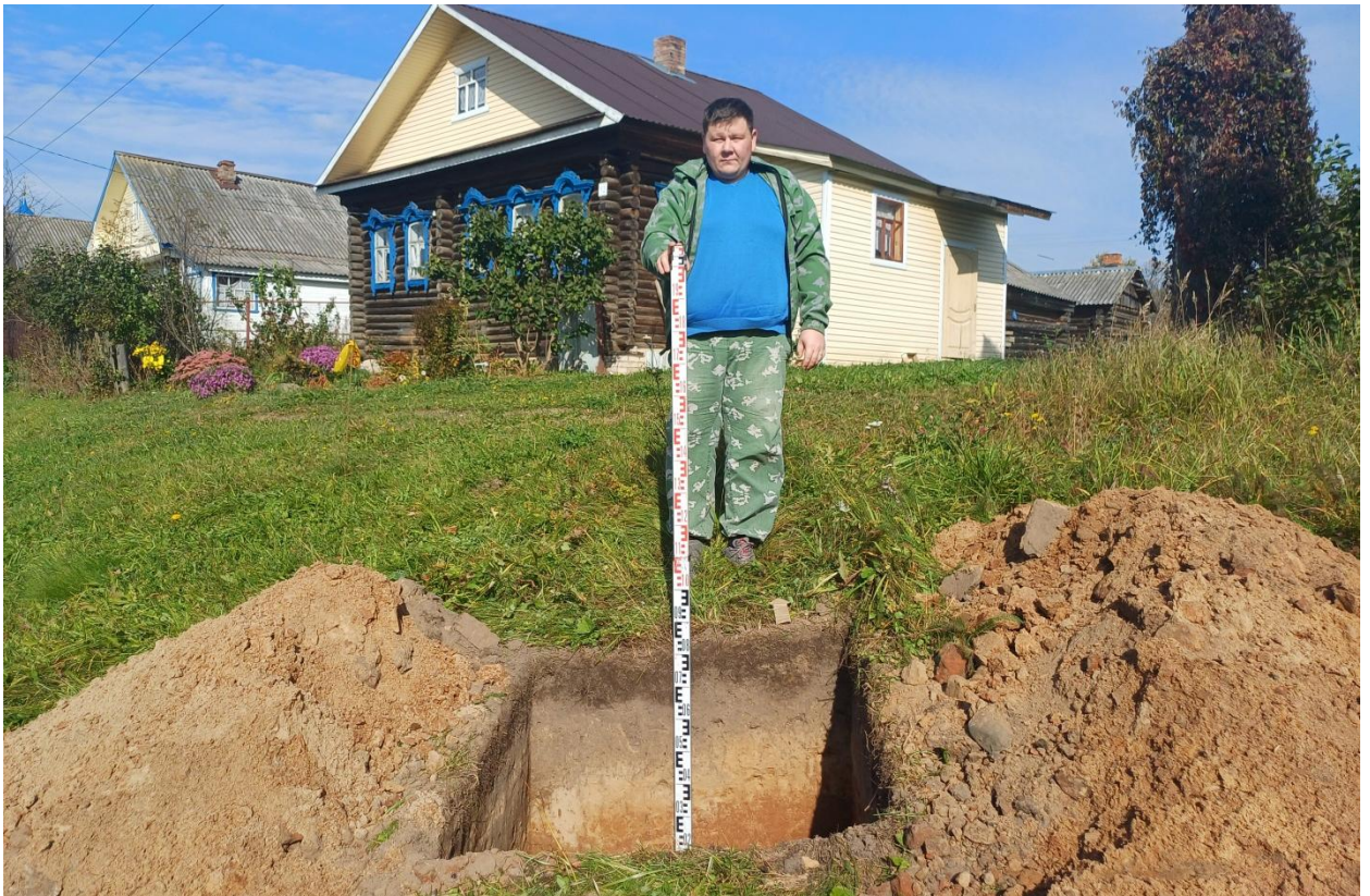
Рис. 40. Ивановская обл., Лухский р-н, распределительный газопровод с. Благовещенье. Общий вид с юга выкопанного шурфа № 1.
