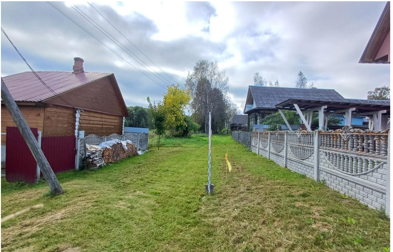
Рис. 15. Ивановская обл., Лухский р-н, распределительный газопровод д. Андреевское. Общий вид с северо-северо-востока (точка фотофиксации 2).
