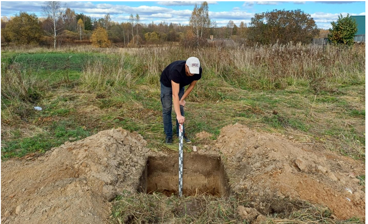
Рис. 126. Ивановская обл., Лухский р-н, распределительный газопровод д. Слободки. Общий вид с юга выкопанного шурфа № 3.
