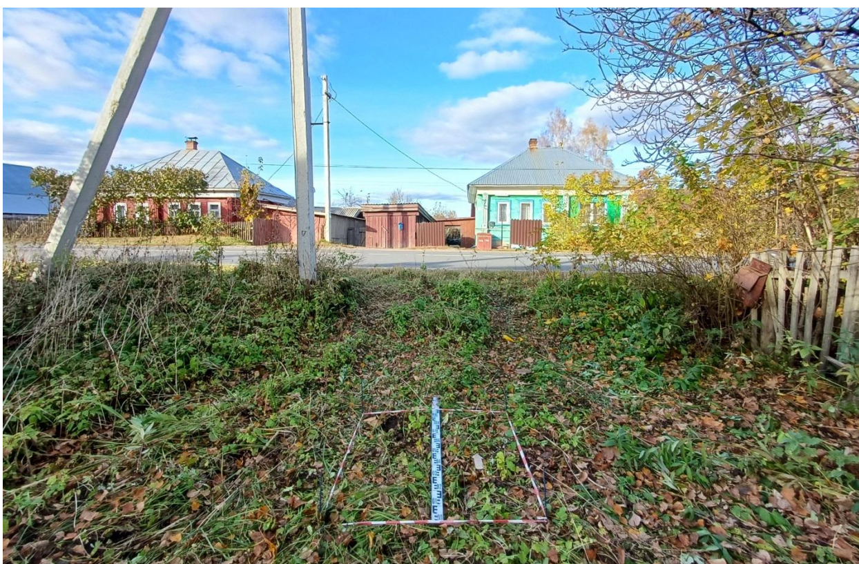
Рис. 98. Ивановская обл., Лухский р-н, распределительный газопровод д. Мясниково. Шурф № 4, разметка и общий вид с юга.
