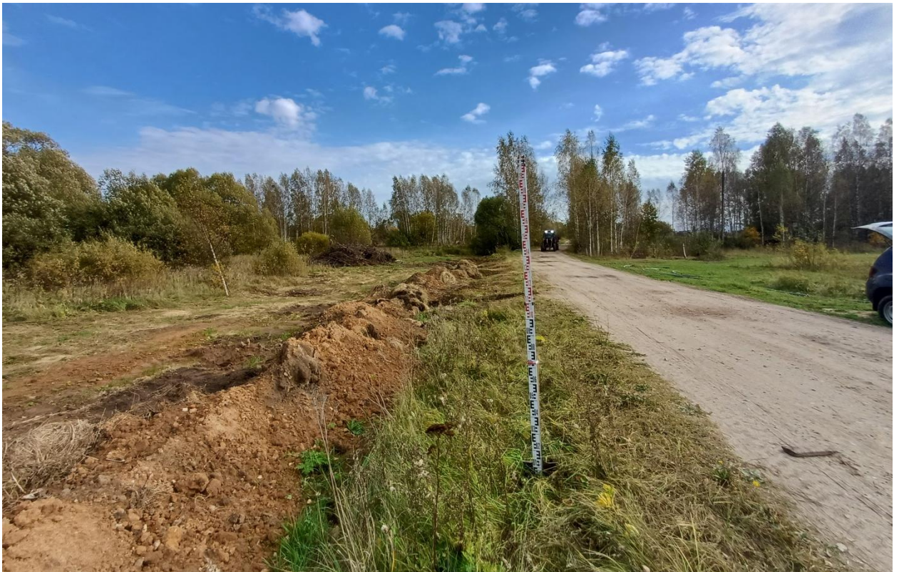
Рис. 169. Ивановская обл., Лухский р-н, распределительный газопровод д. Сорокино. Общий вид участка газопровода с северо-запада (точка фотофиксации 5).
