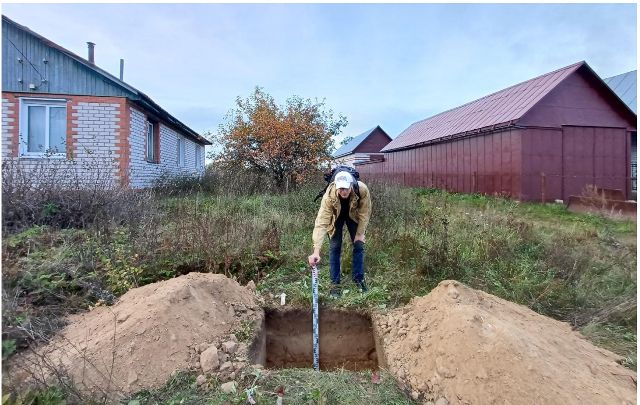
Рис. 94. Ивановская обл., Лухский р-н, распределительный газопровод д. Мясниково. Общий вид с юга выкопанного шурфа № 3.
