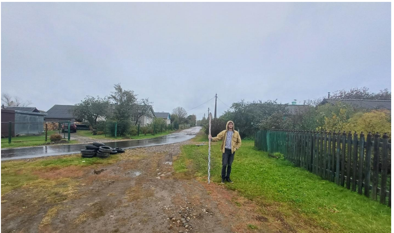
Рис. 142. Ивановская обл., Лухский р-н, распределительный газопровод д. Сорокино. Общий вид с северо-востока участка газопровода на ул. Молодёжная (точка фотофиксации 1).
