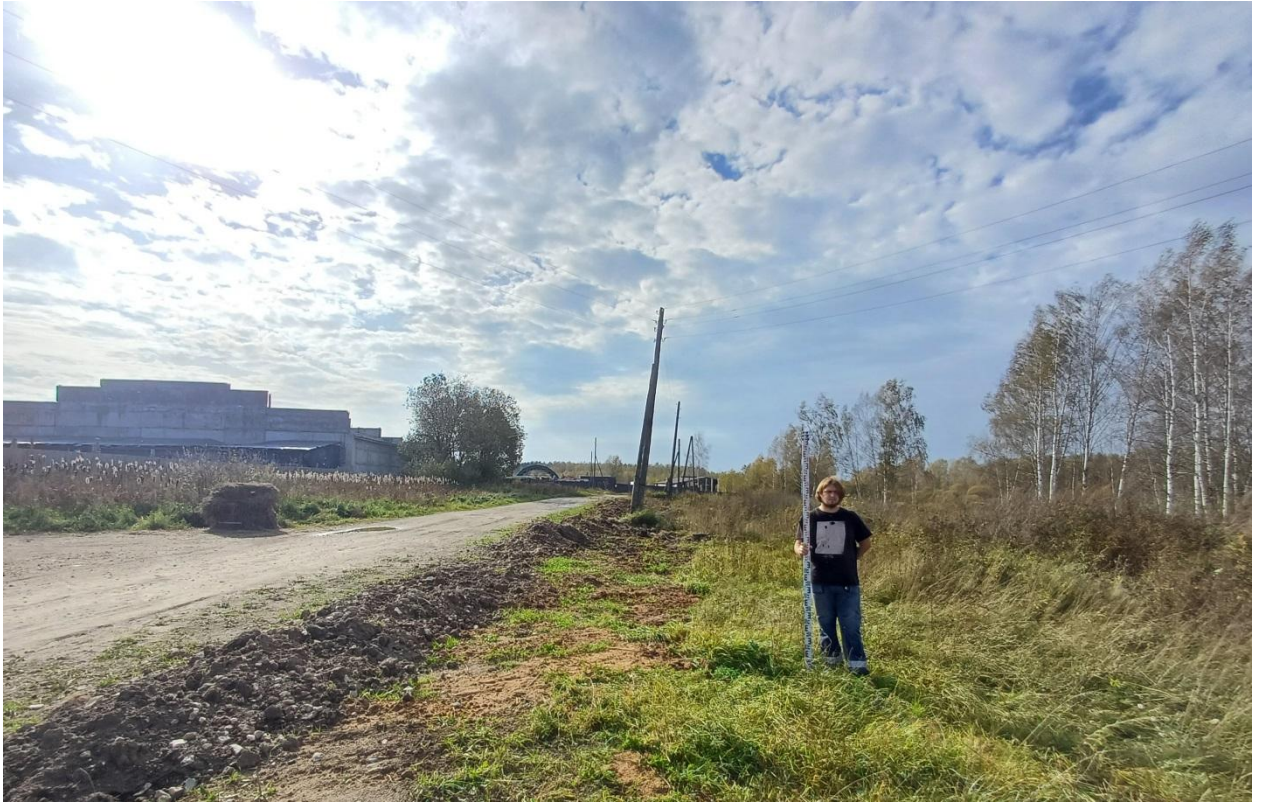
Рис. 161. Ивановская обл., Лухский р-н, распределительный газопровод д. Сорокино. Общий вид с северо-востока участка газопровода (точка фотофиксации 4).
