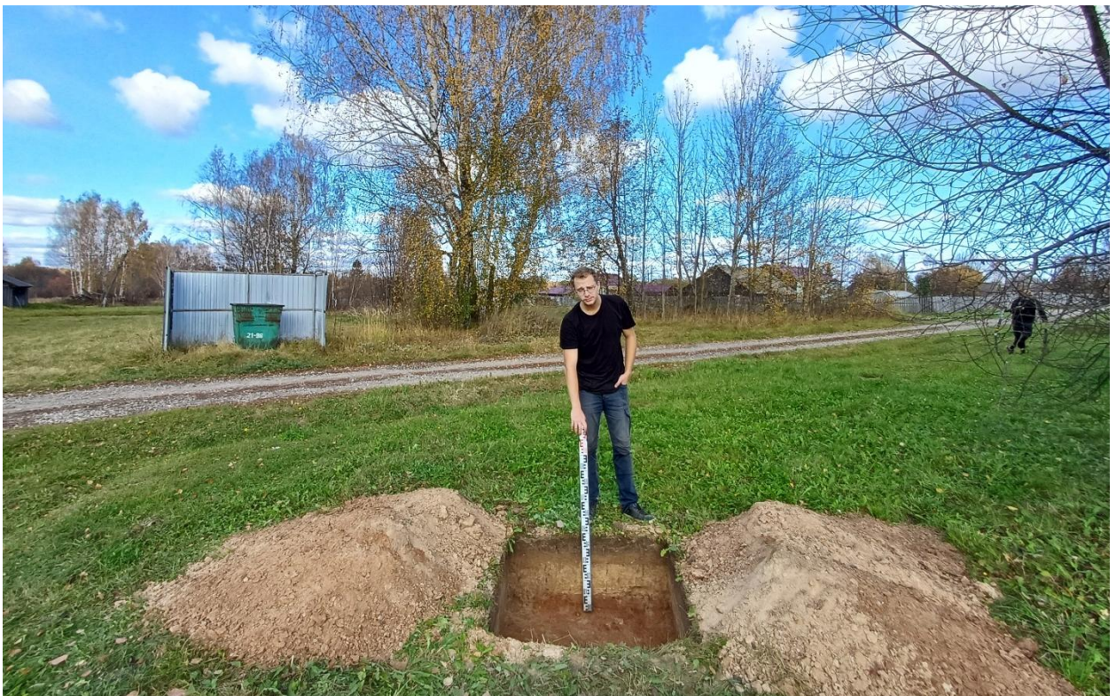
Рис. 119. Ивановская обл., Лухский р-н, распределительный газопровод д. Слободки. Общий вид с юга выкопанного шурфа № 2.
