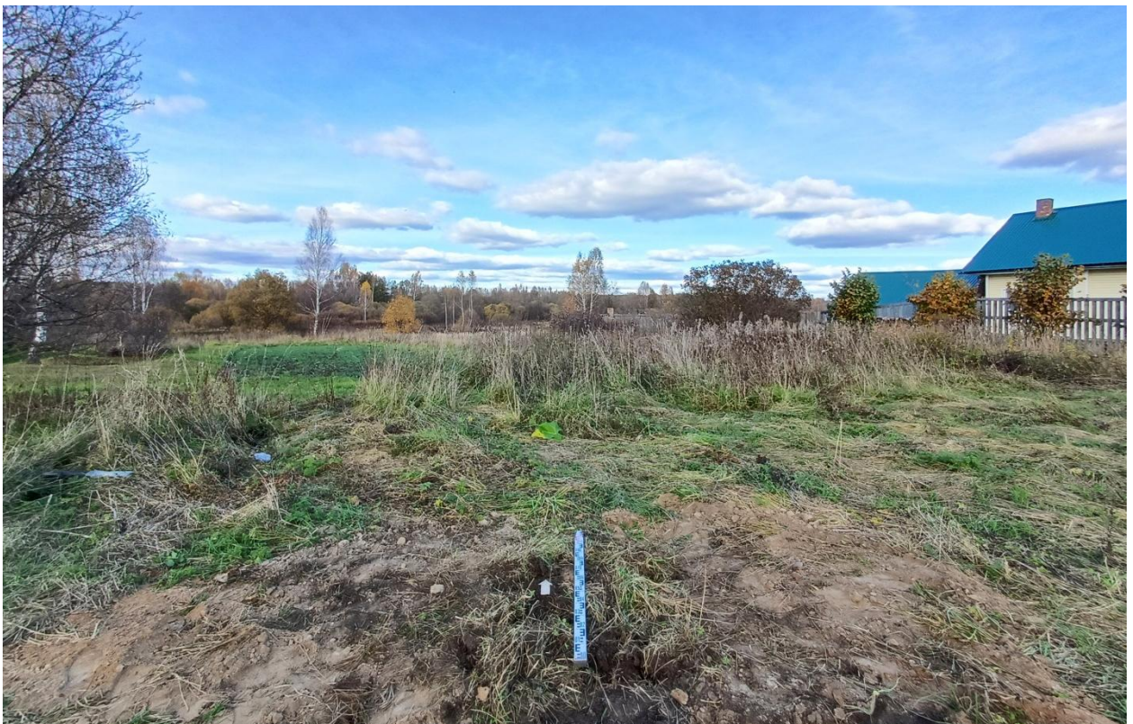
Рис. 127. Ивановская обл., Лухский р-н, распределительный газопровод д. Слободки. Шурф № 3, рекультивация, вид с юга.
