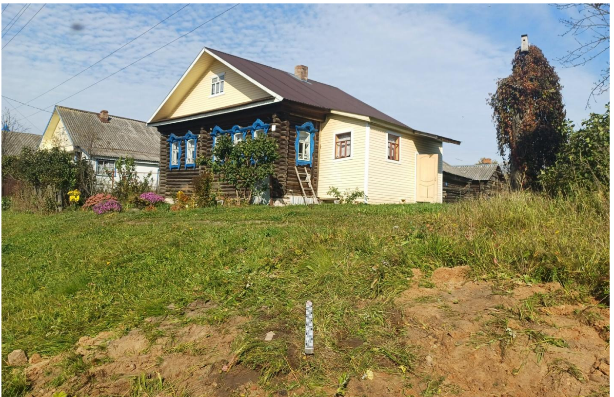
Рис. 41. Ивановская обл., Лухский р-н, распределительный газопровод с. Благовещенье. Шурф № 1, рекультивация, вид с юга.
