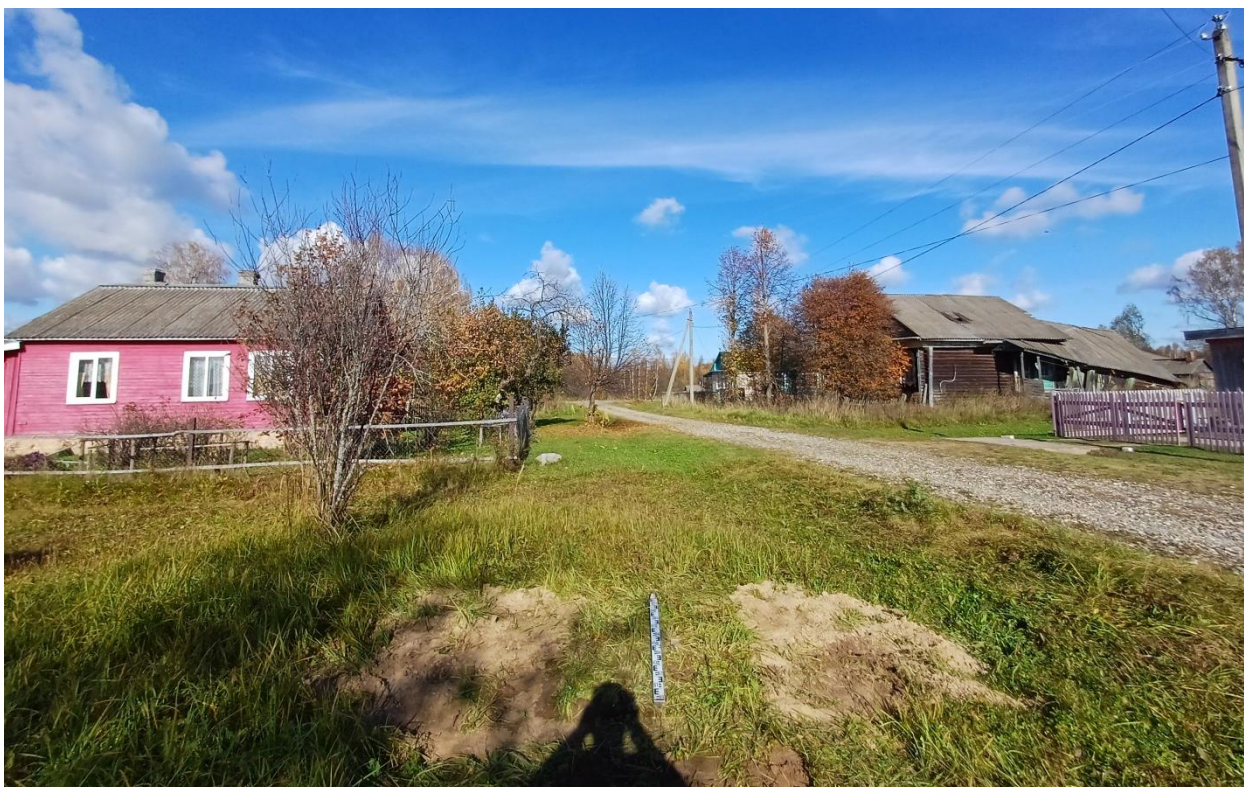
Рис. 114. Ивановская обл., Лухский р-н, распределительный газопровод д. Слободки. Шурф № 1, рекультивация, вид с юга.
