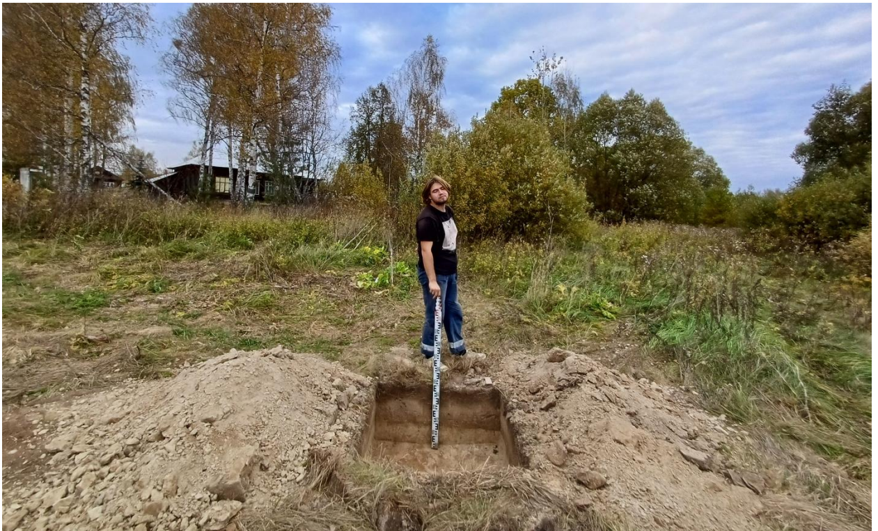
Рис. 173. Ивановская обл., Лухский р-н, распределительный газопровод д. Сорокино. Общий вид с юга выкопанного шурфа № 5.
