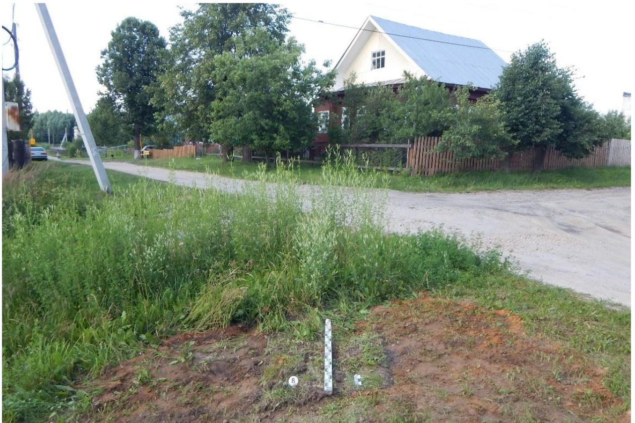
Рис. 86. Ивановская обл., Верхнеландеховский р-н, п.г.т. Верхний Ландех, 2 очередь. Шурф № 8, рекультивация, вид с юга.
