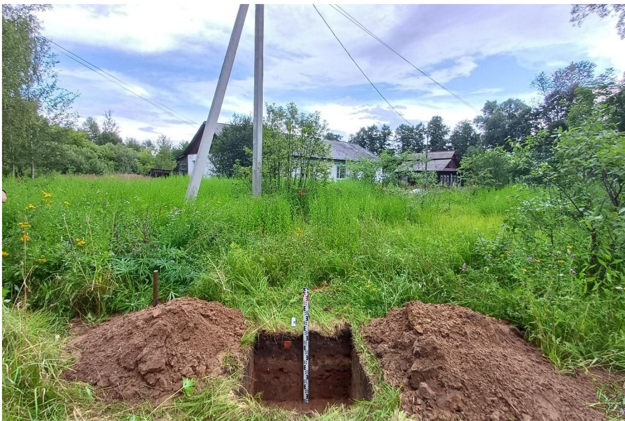
Рис. 132. Ивановская обл., Верхнеландеховский р-н, п.г.т. Верхний Ландех, 2 очередь. Общий вид выкопанного шурфа № 20 с юга.
