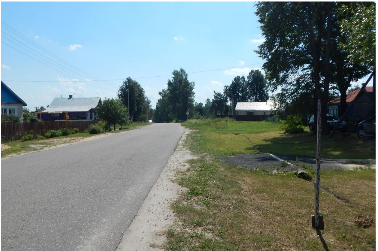
Рис. 69. Ивановская обл., Верхнеландеховский р-н, п.г.т. Верхний Ландех, 2 очередь. Общий вид с северо-северо-запада, съёмка от шурфа № 6 (точка фотофиксации 26).
