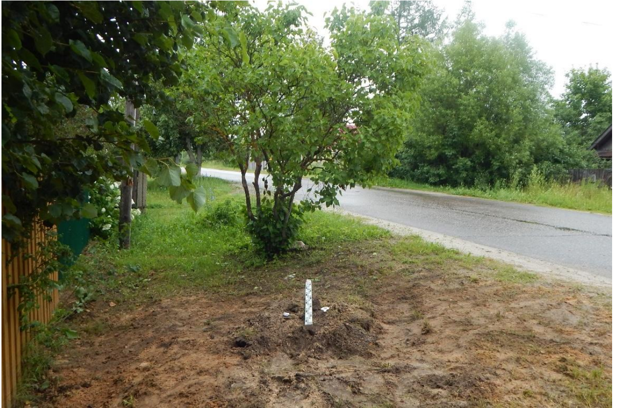
Рис. 92. Ивановская обл., Верхнеландеховский р-н, п.г.т. Верхний Ландех, 2 очередь. Шурф № 9, рекультивация, вид с юга.
