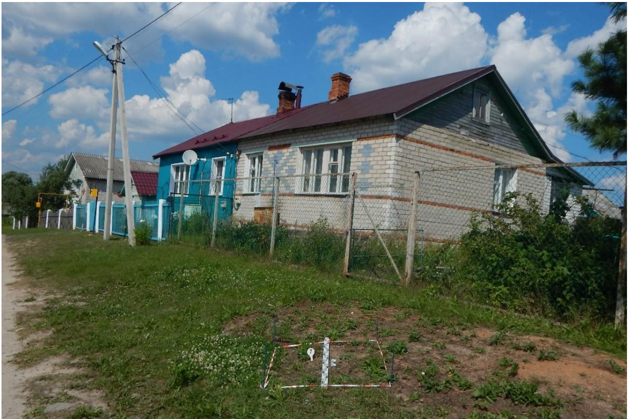
Рис. 76. Ивановская обл., Верхнеландеховский р-н, п.г.т. Верхний Ландех, 2 очередь. Шурф № 7, разметка и общий вид с юга.
