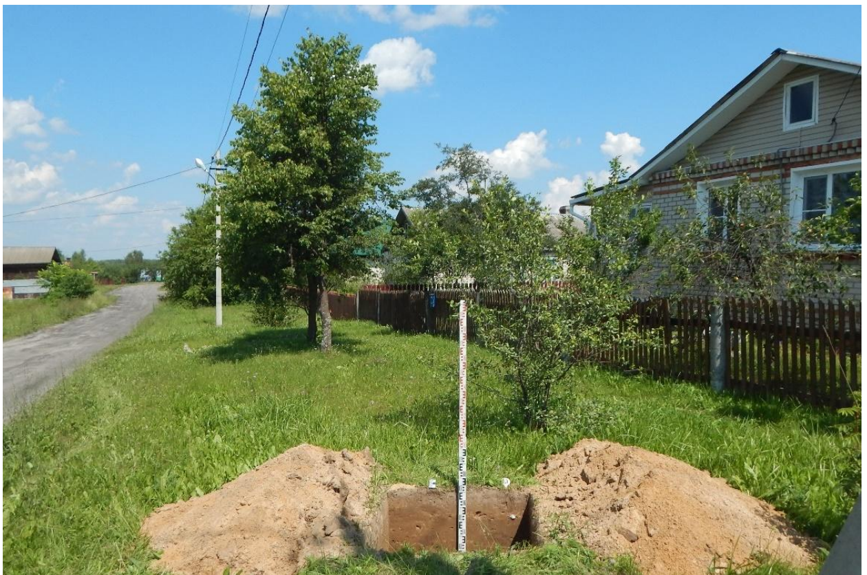
Рис. 55. Ивановская обл., Верхнеландеховский р-н, п.г.т. Верхний Ландех, 2 очередь. Общий вид выкопанного шурфа № 3 с юга.
