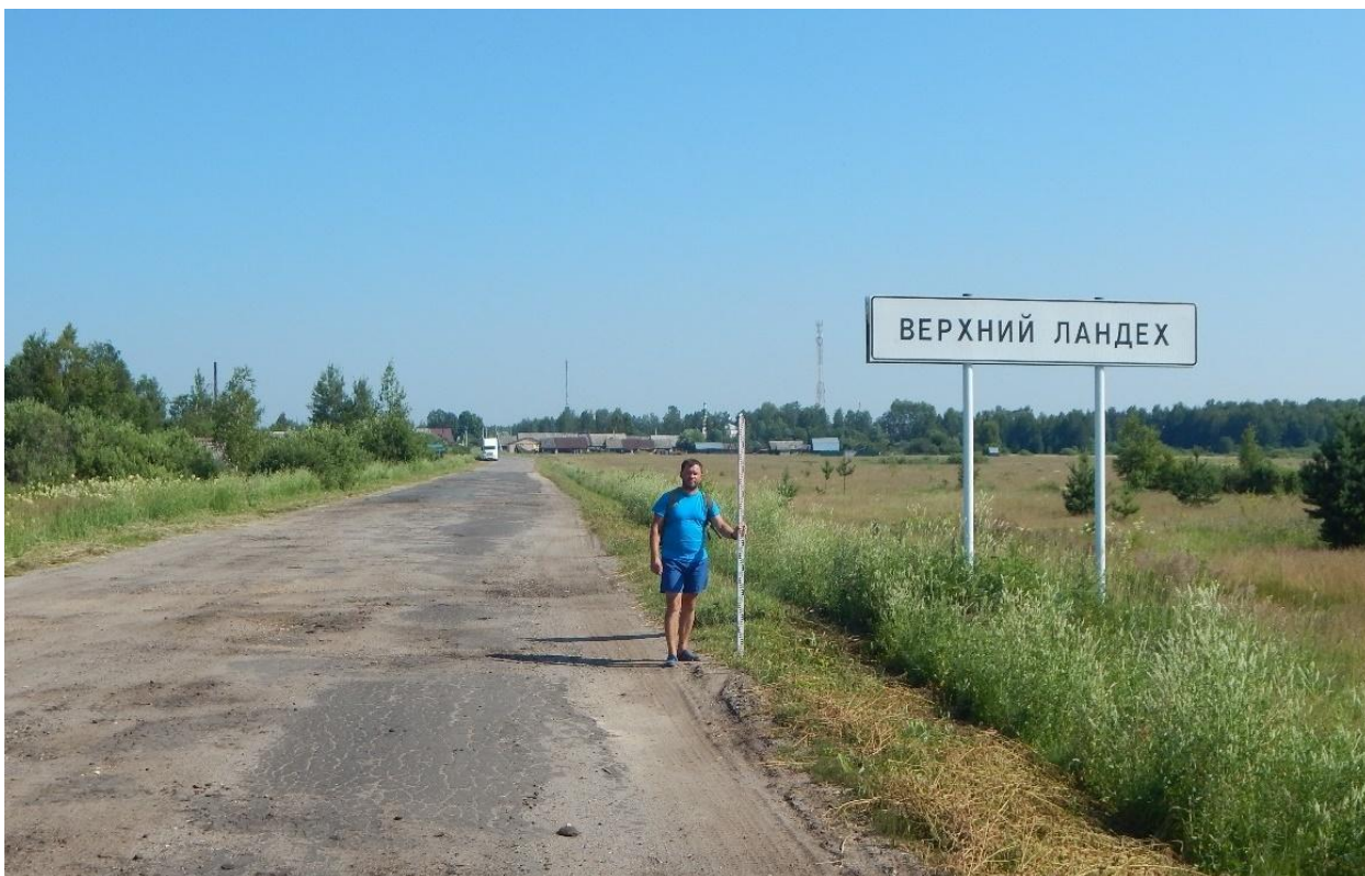
Рис. 38. Ивановская обл., Верхнеландеховский р-н, п.г.т. Верхний Ландех, 2 очередь. Въезд в п. Верхний Ландех по а/д 24Н-187, со стороны п. Пестяки, вид с юга (точка фотофиксации 20).
