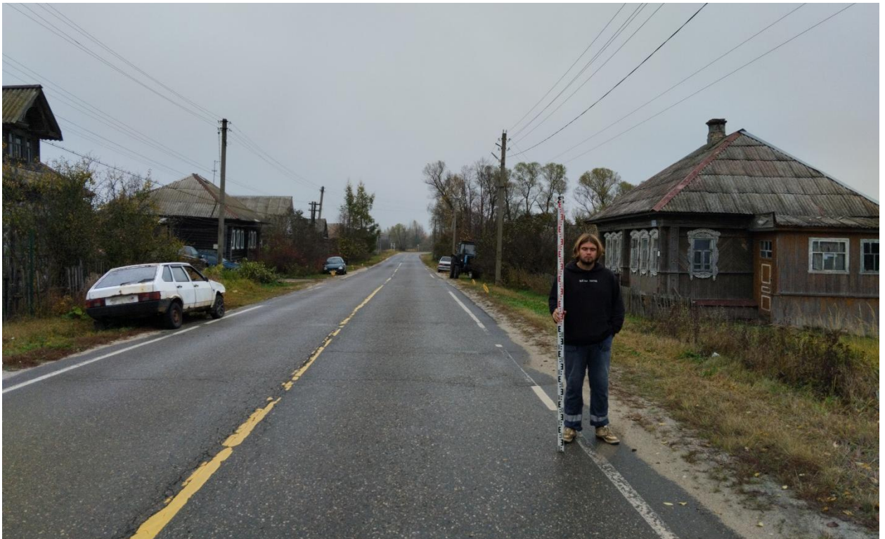
Рис. 23. Ивановская обл., Верхнеландеховский р-н, д. Токарево, распределительный газопровод. Вид с юго-запада на участок прокладки газопровода на первой жилой улице – а/д 24Н-157 (точка фотофиксации 6).
