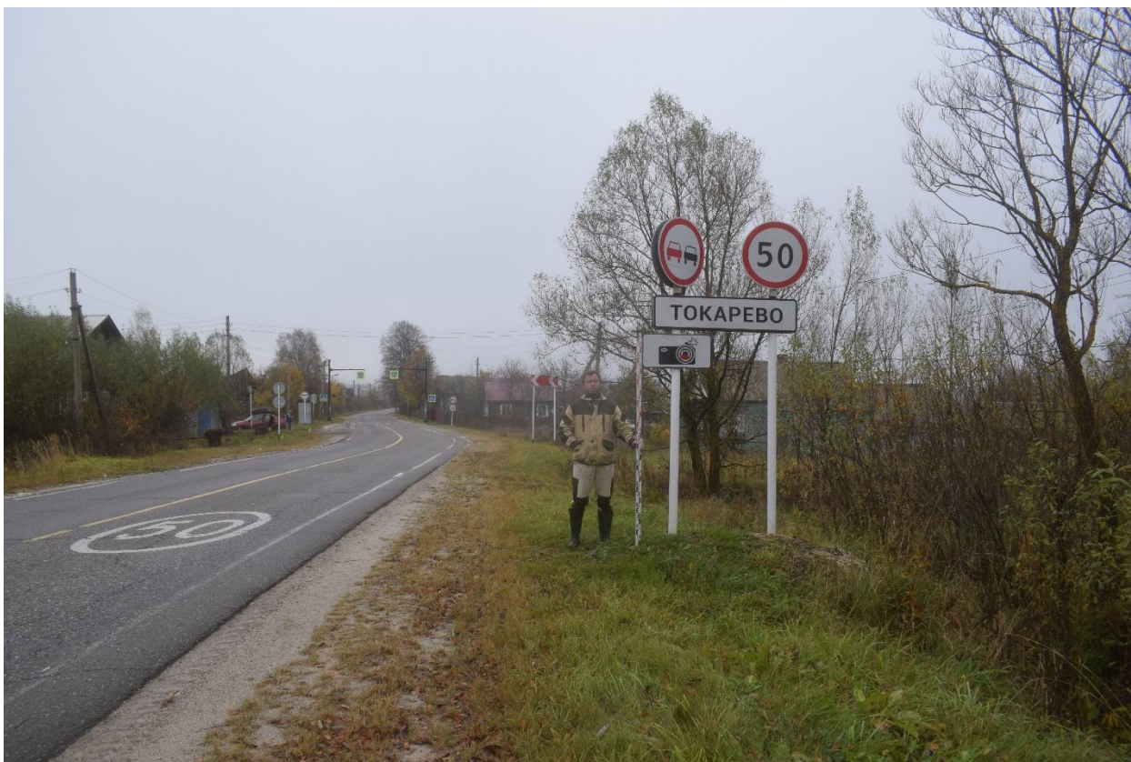
Рис. 16. Ивановская обл., Верхнеландеховский р-н, д. Токарево, распределительный газопровод. Въезд в д. Токарево (точка фотофиксации 1), вид с юго-запада.
