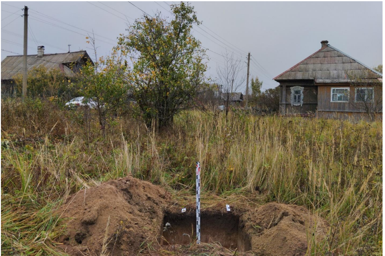
Рис. 42. Ивановская обл., Верхнеландеховский р-н, д. Токарево, распределительный газопровод. Общий вид с юга выкопанного шурфа № 4.
