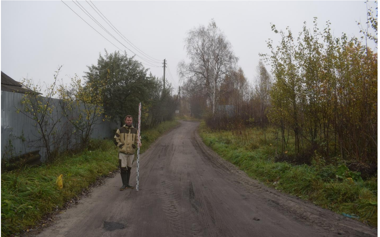
Рис. 21. Ивановская обл., Верхнеландеховский р-н, д. Токарево, распределительный газопровод. Вид с юго-востока на участок строительства газопровода в проулке, соединяющем три жилые улицы (точка фотофиксации 5).
