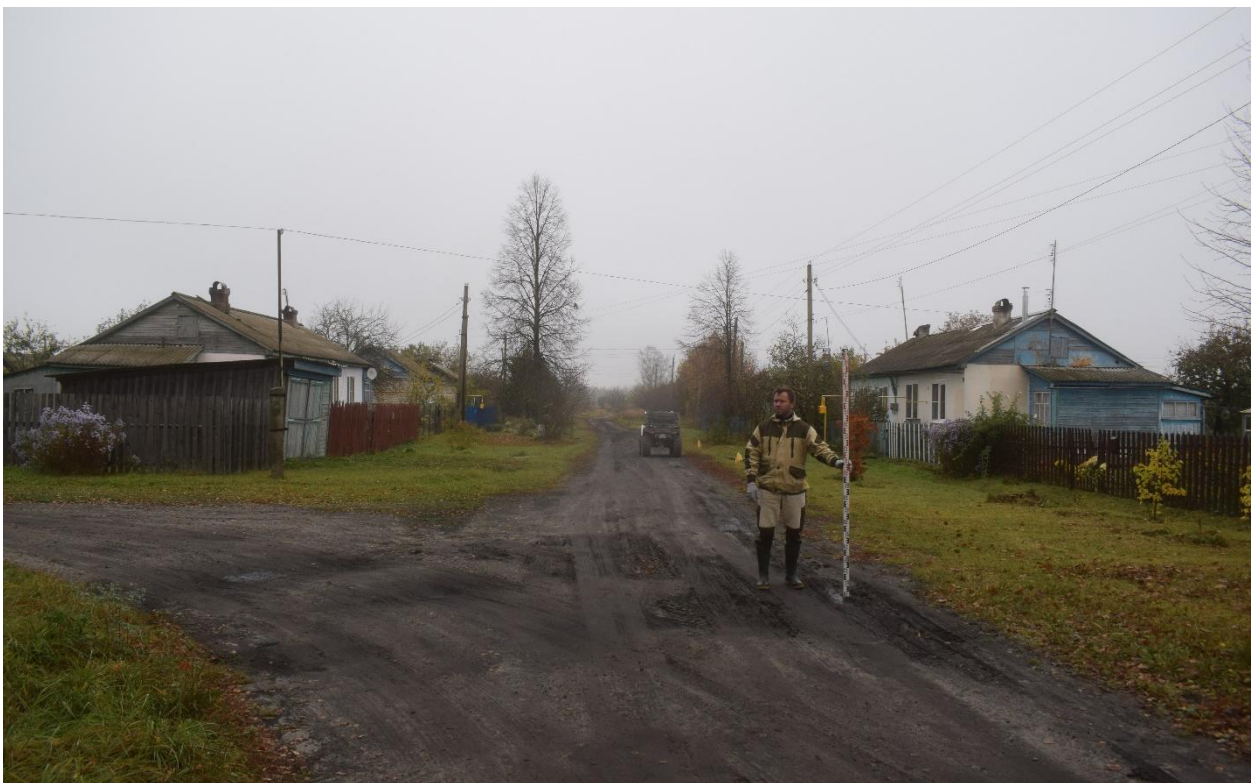
Рис. 19. Ивановская обл., Верхнеландеховский р-н, д. Токарево, распределительный газопровод. Вид с юго-запада на участок прокладки газопровода по второй жилой улице (точка фотофиксации 3).
