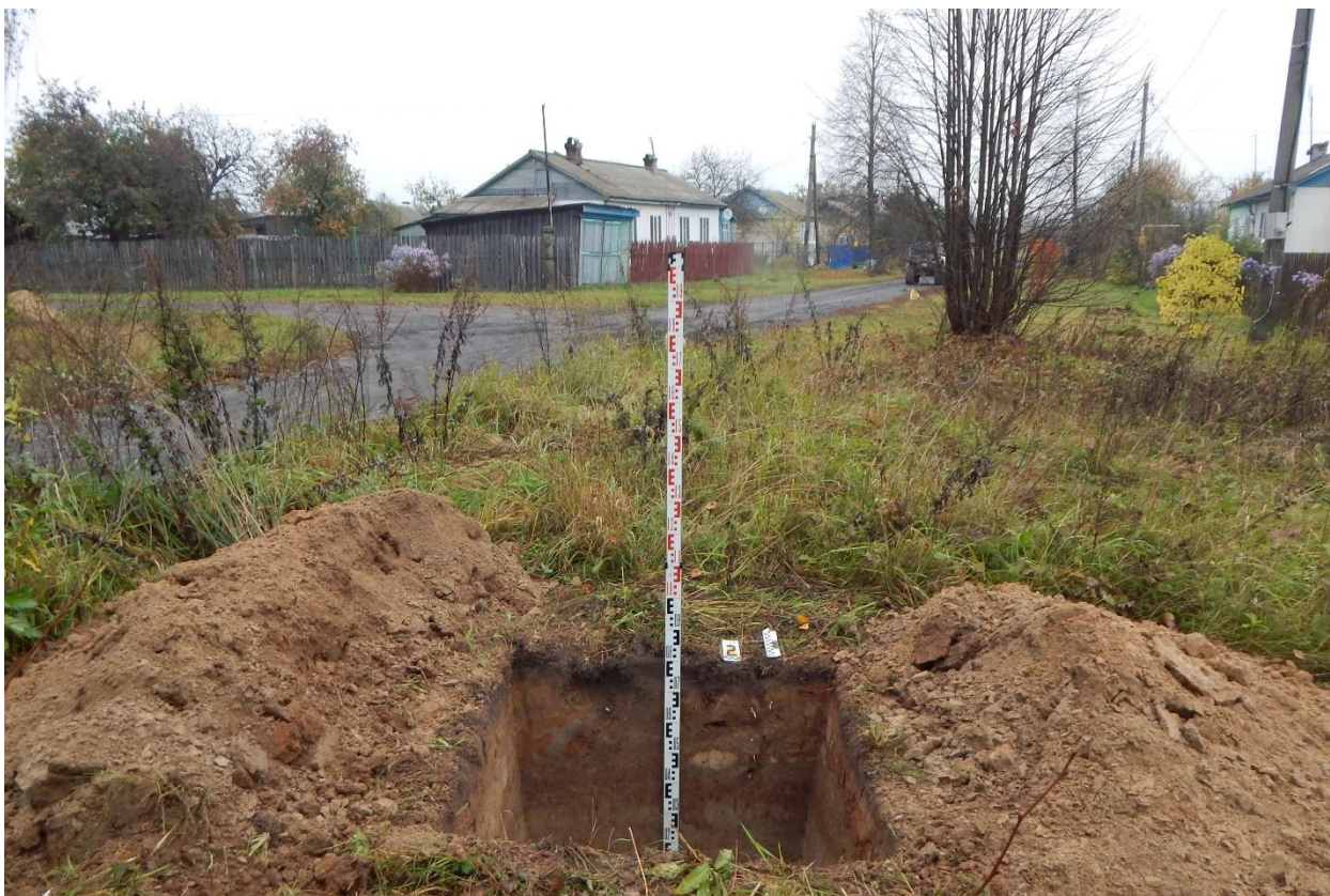
Рис. 32. Ивановская обл., Верхнеландеховский р-н, д. Токарево, распределительный газопровод. Общий вид с юга выкопанного шурфа № 2.
