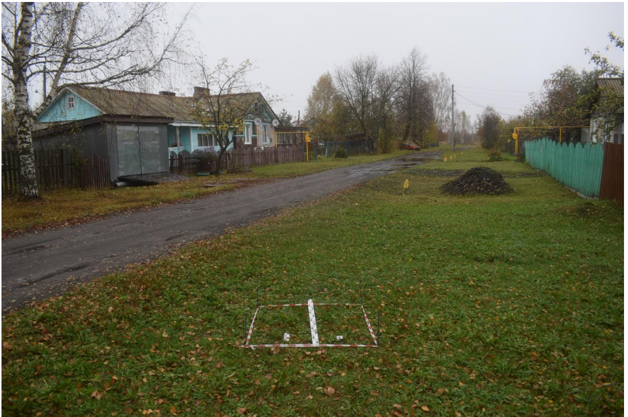
Рис. 24. Ивановская обл., Верхнеландеховский р-н, д. Токарево, распределительный газопровод. Шурф № 1, разметка и общий вид с юга.
