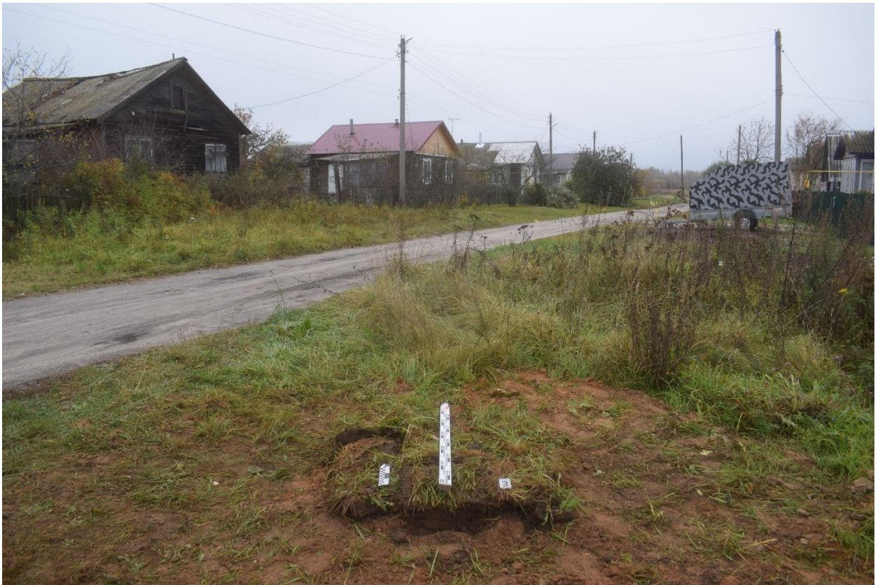
Рис. 38. Ивановская обл., Верхнеландеховский р-н, д. Токарево, распределительный газопровод. Шурф № 3, рекультивация, вид с юга.
