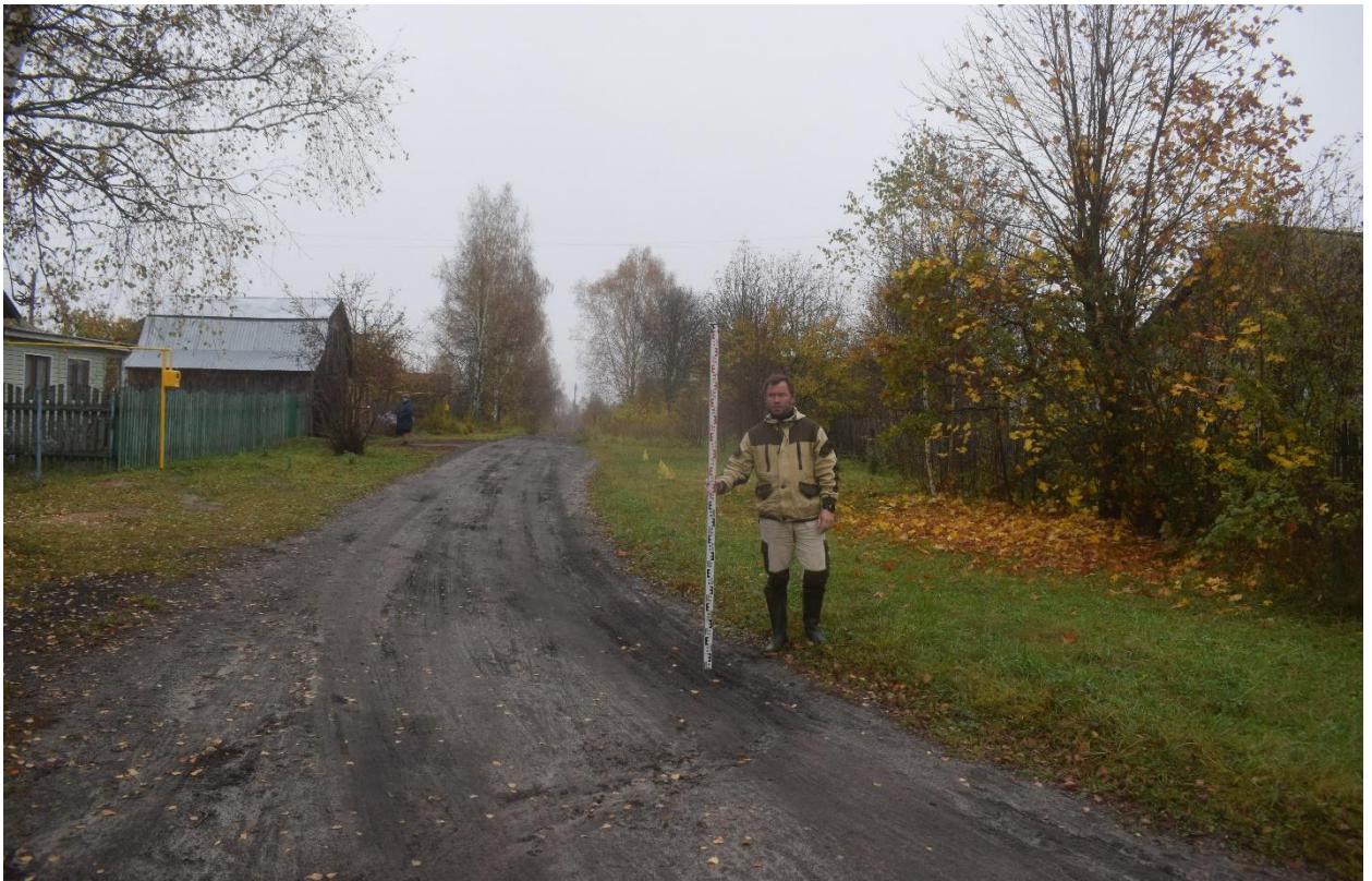
Рис. 18. Ивановская обл., Верхнеландеховский р-н, д. Токарево, распределительный газопровод. Вид с юго-запада на участок прокладки газопровода по третьей жилой улице (точка фотофиксации 2).
