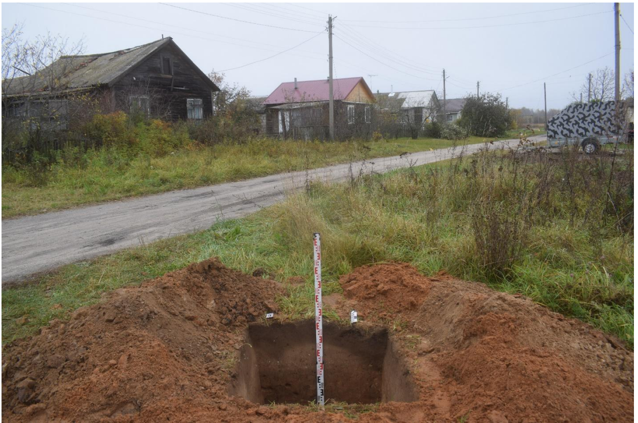
Рис. 37. Ивановская обл., Верхнеландеховский р-н, д. Токарево, распределительный газопровод. Общий вид с юга выкопанного шурфа № 3.
