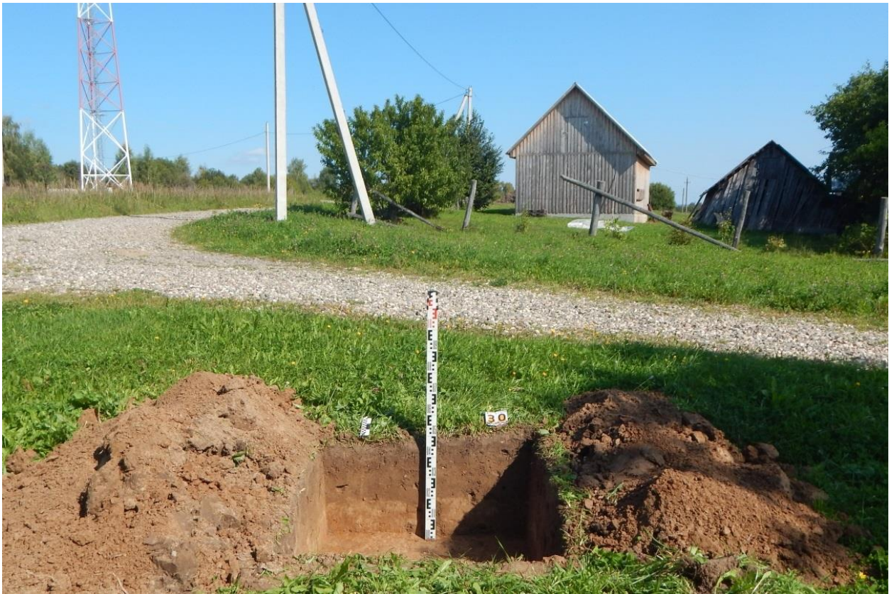
Рис. 269. Ивановская обл., Фурмановский р-н, с. Дуляпино, распределительный газопровод, 2-ая очередь. Общий вид с юга выкопанного шурфа № 30.
