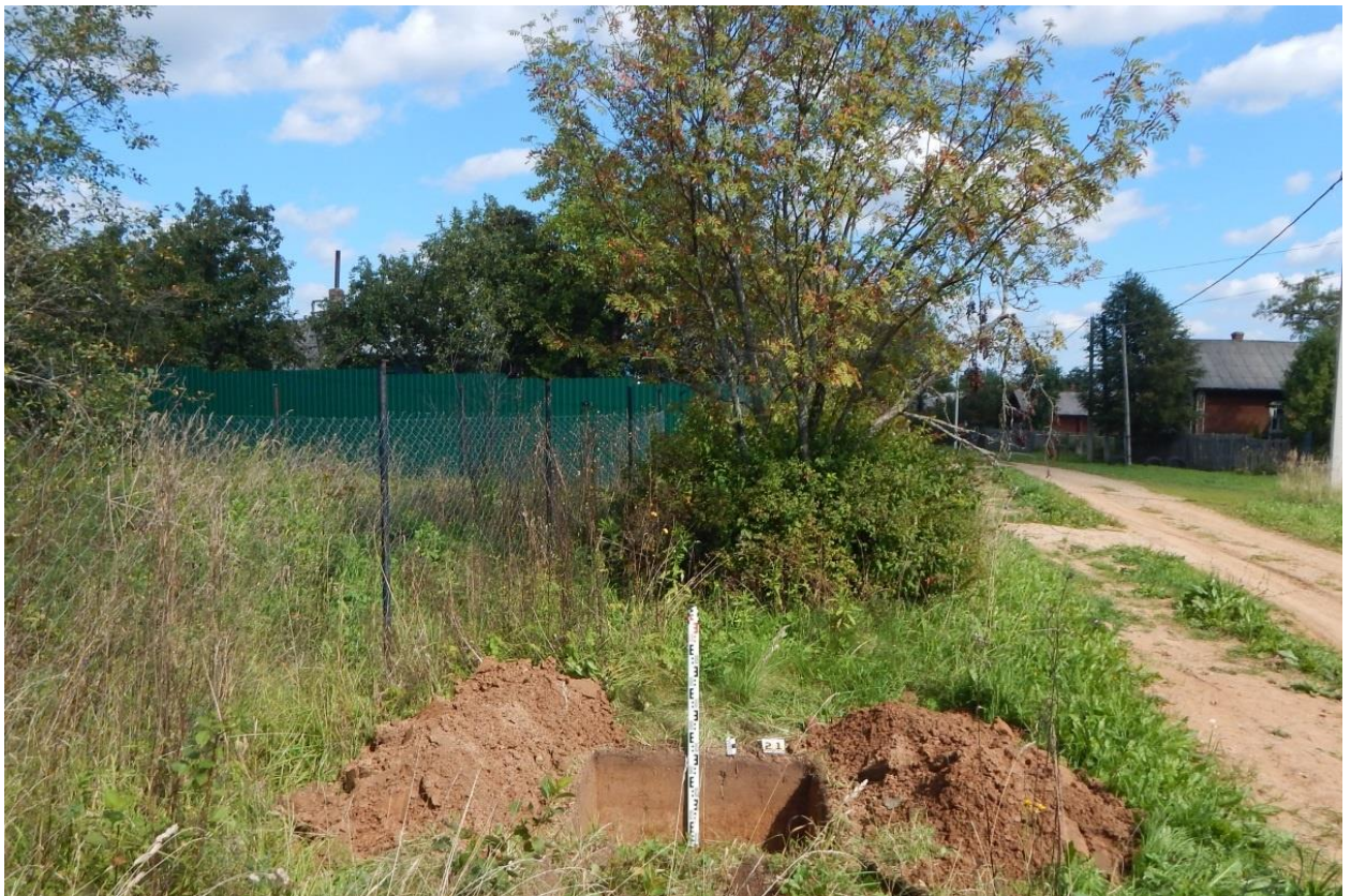
Рис. 208. Ивановская обл., Фурмановский р-н, с. Дуляпино, распределительный газопровод, 2-ая очередь. Общий вид с юга выкопанного шурфа № 21.
