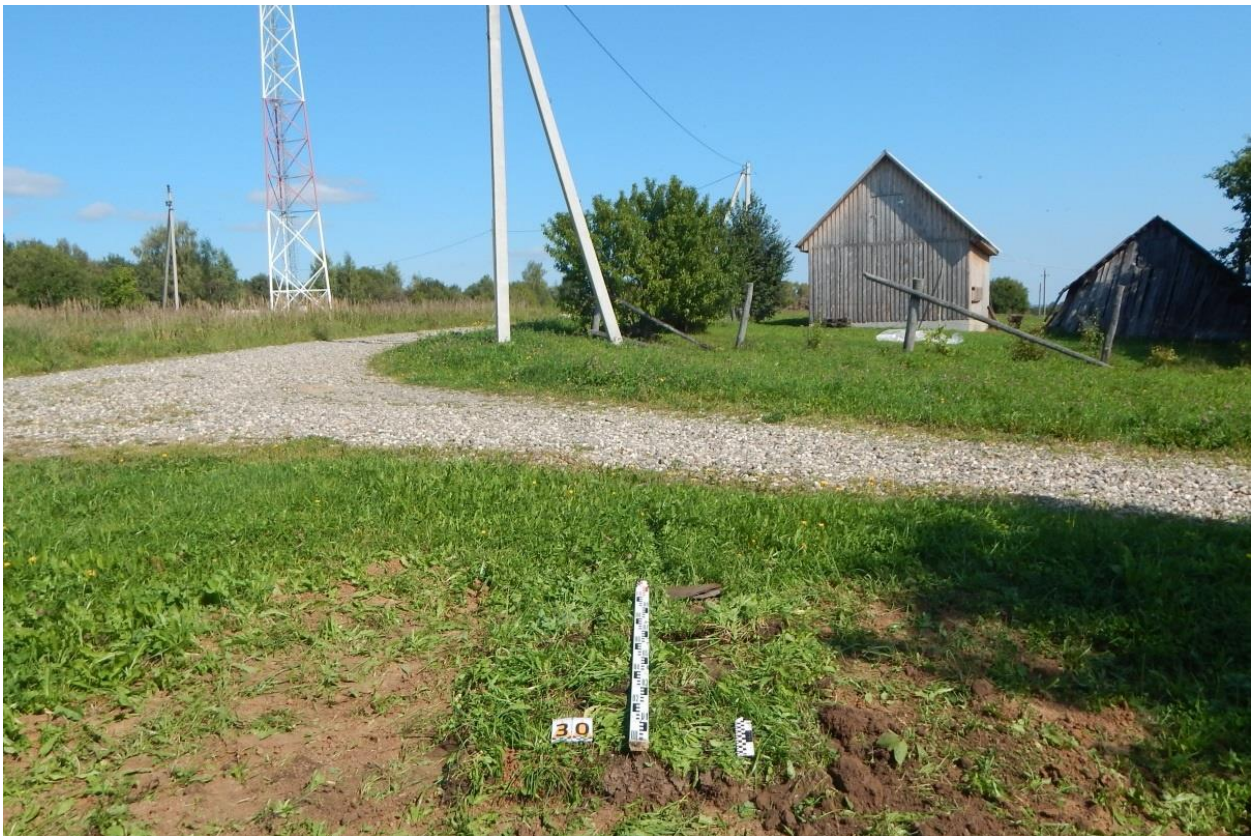
Рис. 270. Ивановская обл., Фурмановский р-н, с. Дуляпино, распределительный газопровод, 2-ая очередь. Шурф № 30, рекультивация, вид с юга.
