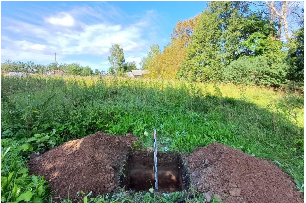
Рис. 110. Ивановская обл., Фурмановский р-н, с. Дуляпино, распределительный газопровод, 2-ая очередь. Общий вид с юга выкопанного шурфа № 6.
