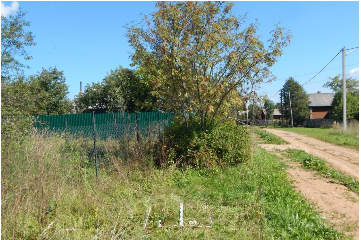
Рис. 205. Ивановская обл., Фурмановский р-н, с. Дуляпино, распределительный газопровод, 2-ая очередь. Шурф № 21, разметка и общий вид с юга.
