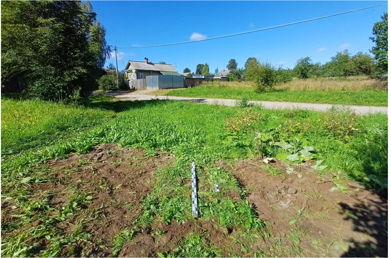
Рис. 125. Ивановская обл., Фурмановский р-н, с. Дуляпино, распределительный газопровод, 2-ая очередь. Шурф № 8, рекультивация, вид с юга.
