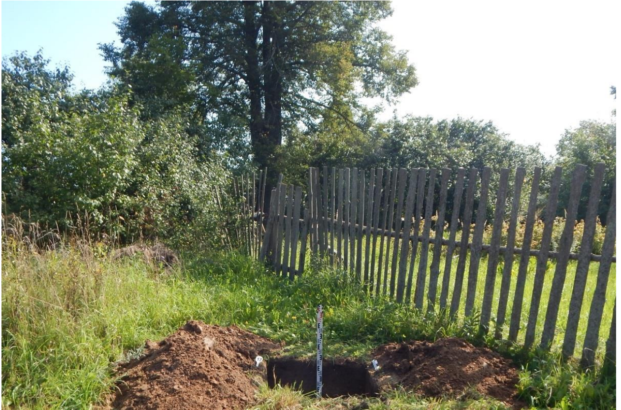
Рис. 183. Ивановская обл., Фурмановский р-н, с. Дуляпино, распределительный газопровод, 2-ая очередь. Общий вид с юга выкопанного шурфа № 17.
