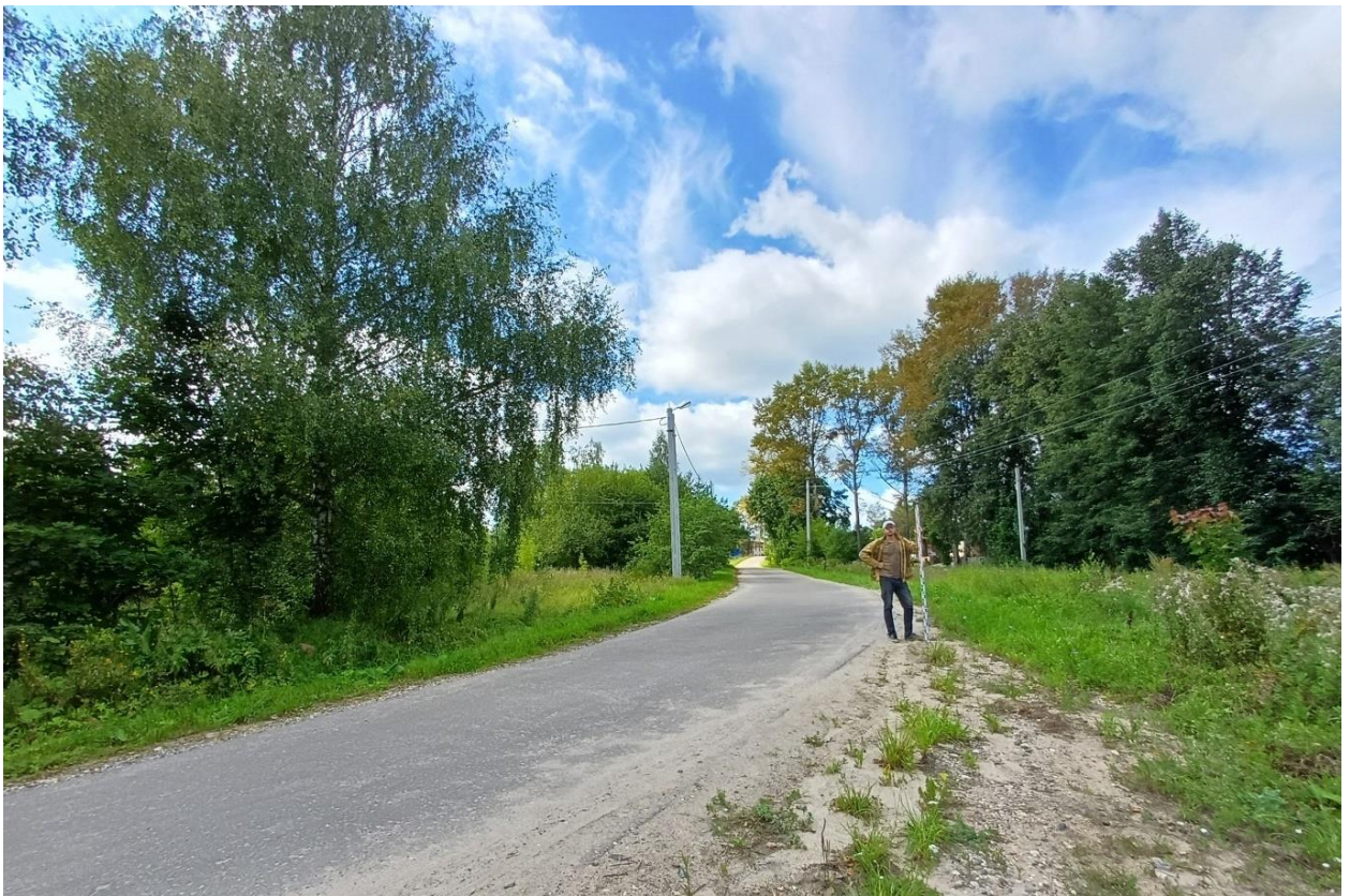
Рис. 106. Ивановская обл., Фурмановский р-н, с. Дуляпино, распределительный газопровод, 2-ая очередь. Точка фотофиксации 6, вид с северо-запада.
