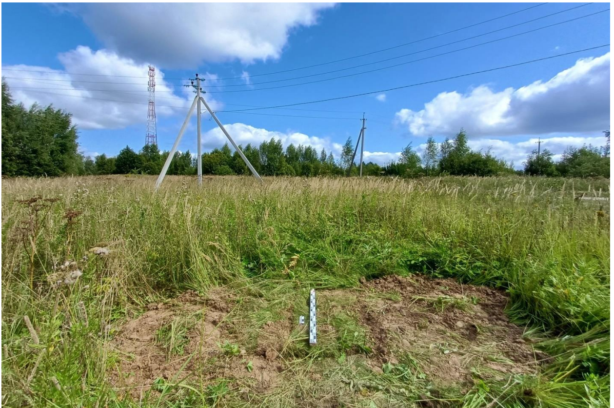
Рис. 104. Ивановская обл., Фурмановский р-н, с. Дуляпино, распределительный газопровод, 2-ая очередь. Шурф № 5, рекультивация, вид с юга.
