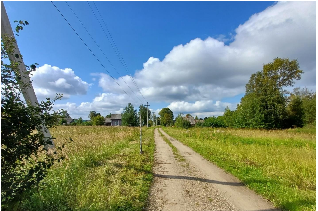
Рис. 99. Ивановская обл., Фурмановский р-н, с. Дуляпино, распределительный газопровод, 2-ая очередь. Точка фотофиксации 5, вид с северо-востока.
