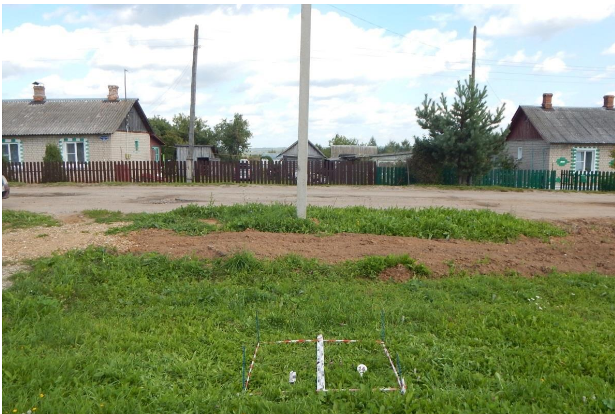
Рис. 161. Ивановская обл., Фурмановский р-н, с. Дуляпино, распределительный газопровод, 2-ая очередь. Шурф № 14, разметка и общий вид с юга.
