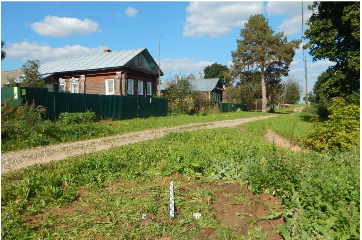
Рис. 238. Ивановская обл., Фурмановский р-н, с. Дуляпино, распределительный газопровод, 2-ая очередь. Шурф № 25, рекультивация, вид с юга.
