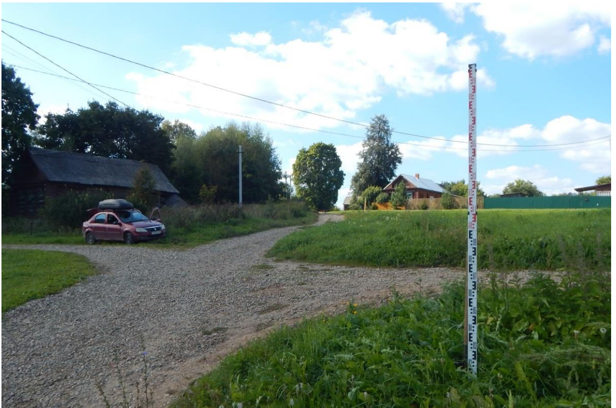
Рис. 232. Ивановская обл., Фурмановский р-н, с. Дуляпино, распределительный газопровод, 2-ая очередь. Точка фотофиксации 25, вид с востока.
