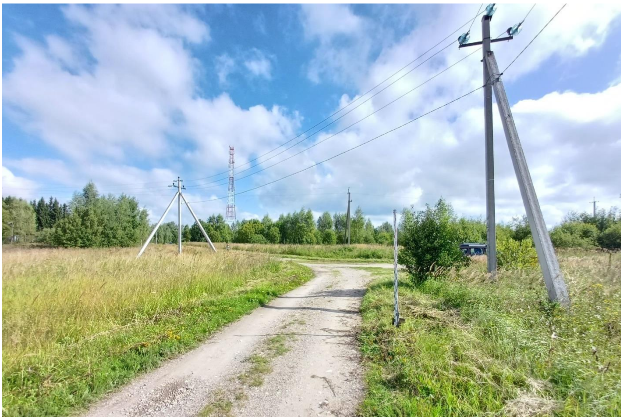
Рис. 98. Ивановская обл., Фурмановский р-н, с. Дуляпино, распределительный газопровод, 2-ая очередь. Точка фотофиксации 5, вид с юго-запада.
