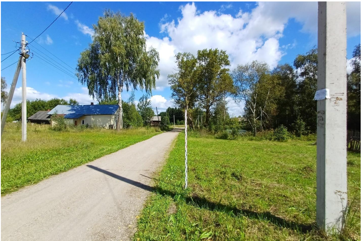
Рис. 80. Ивановская обл., Фурмановский р-н, с. Дуляпино, распределительный газопровод, 2-ая очередь. Точка фотофиксации 2, вид с юго-запада.
