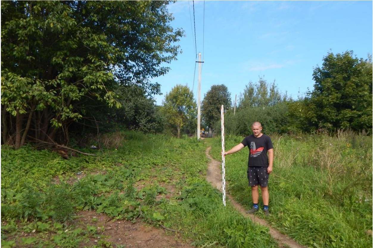
Рис. 147. Ивановская обл., Фурмановский р-н, с. Дуляпино, распределительный газопровод, 2-ая очередь. Точка фотофиксации 12, вид с юго-востока.
