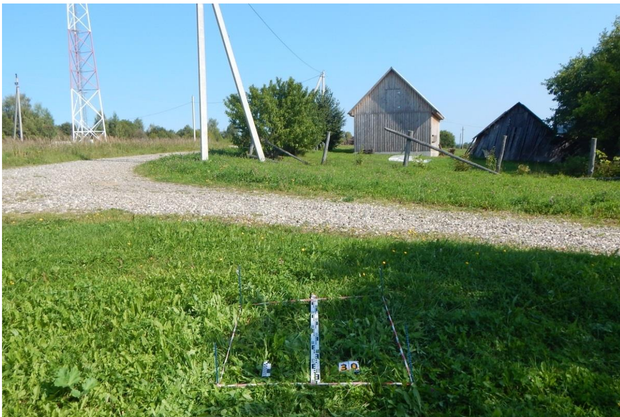
Рис. 266. Ивановская обл., Фурмановский р-н, с. Дуляпино, распределительный газопровод, 2-ая очередь. Шурф № 30, разметка и общий вид с юга.
