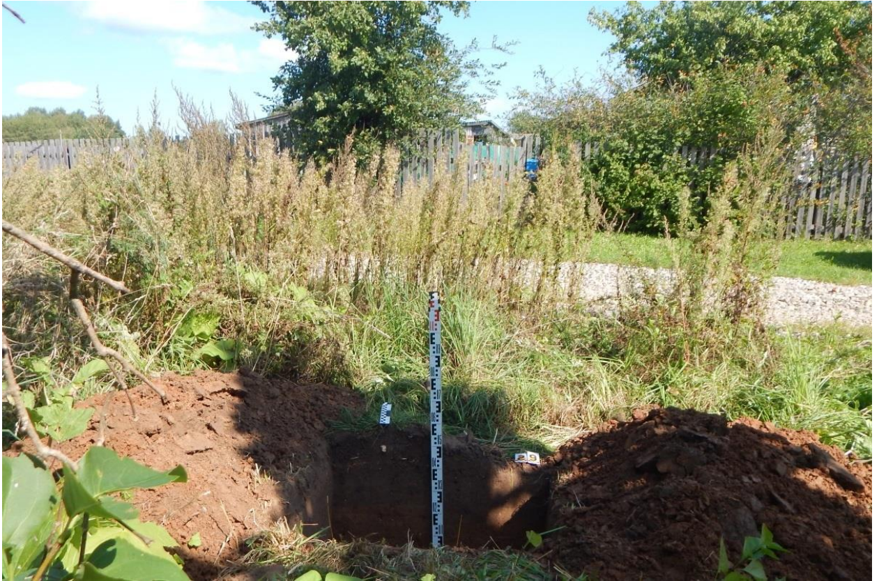
Рис. 263. Ивановская обл., Фурмановский р-н, с. Дуляпино, распределительный газопровод, 2-ая очередь. Общий вид с юга выкопанного шурфа № 29.
