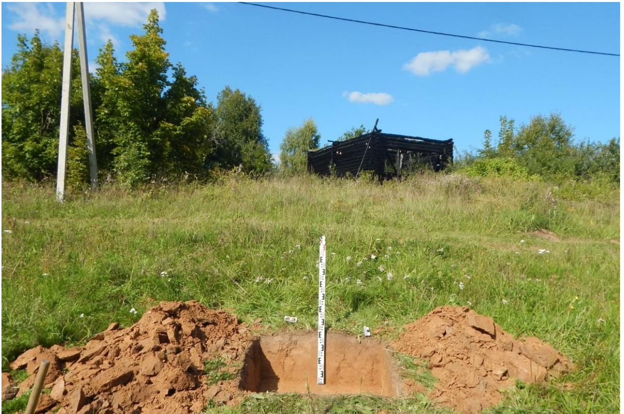
Рис. 223. Ивановская обл., Фурмановский р-н, с. Дуляпино, распределительный газопровод, 2-ая очередь. Общий вид с юга выкопанного шурфа № 23.
