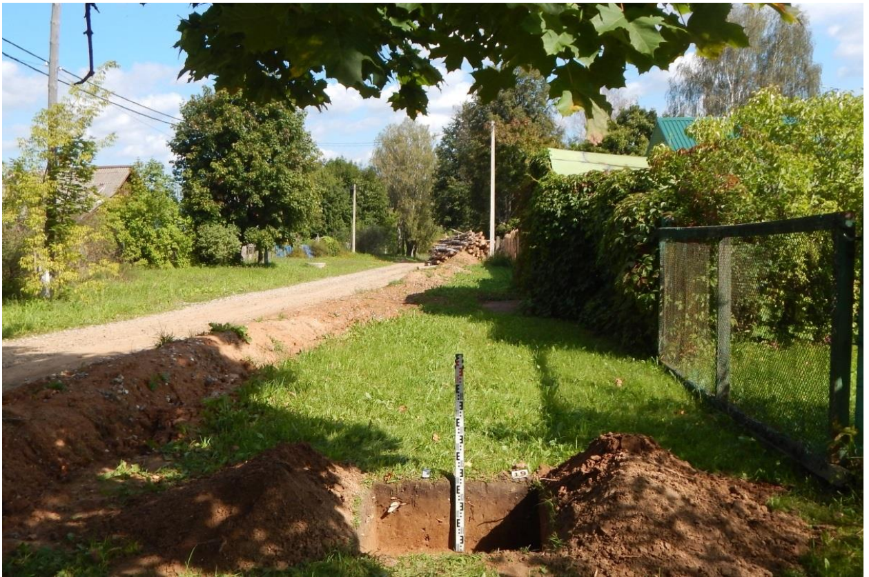
Рис. 195. Ивановская обл., Фурмановский р-н, с. Дуляпино, распределительный газопровод, 2-ая очередь. Общий вид с юга выкопанного шурфа № 19.
