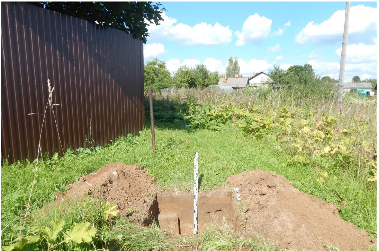
Рис. 170. Ивановская обл., Фурмановский р-н, с. Дуляпино, распределительный газопровод, 2-ая очередь. Общий вид с юга выкопанного шурфа № 15.
