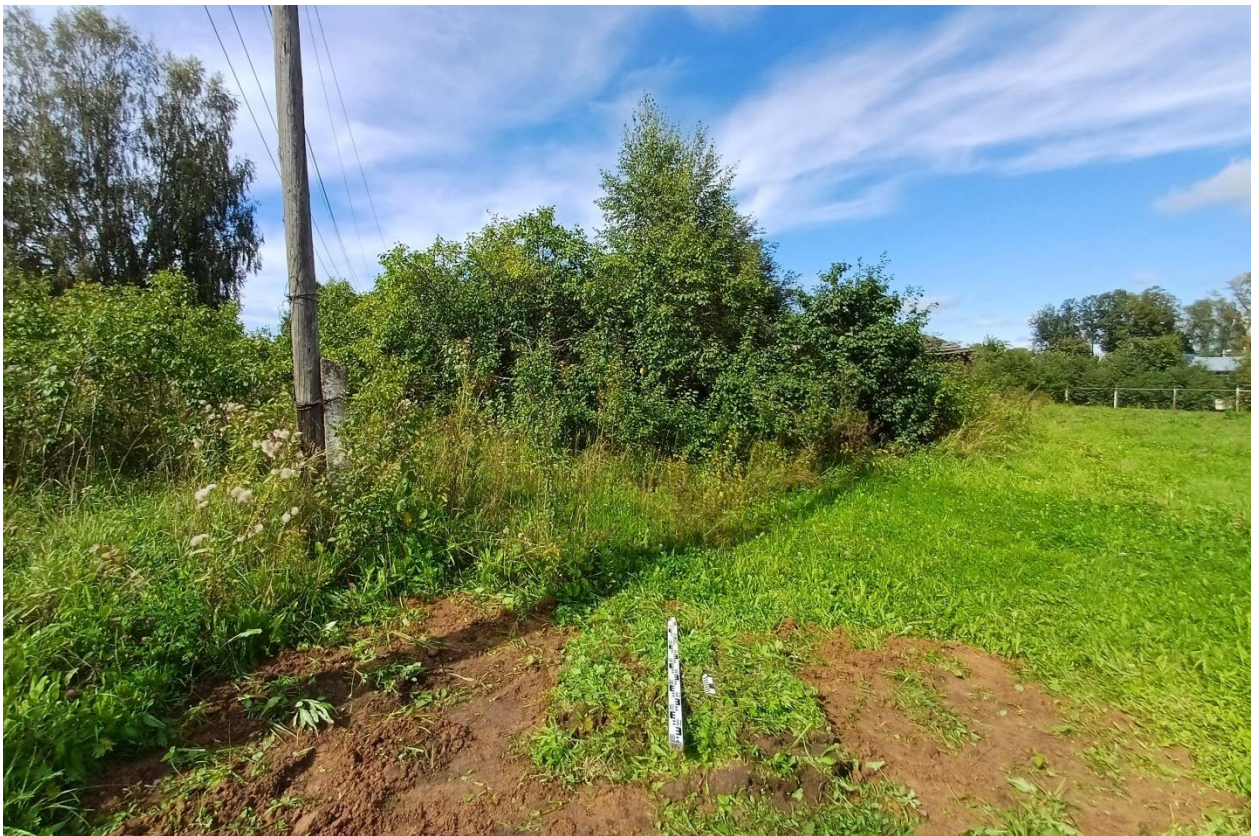
Рис. 118. Ивановская обл., Фурмановский р-н, с. Дуляпино, распределительный газопровод, 2-ая очередь. Шурф № 7, рекультивация, вид с юга.
