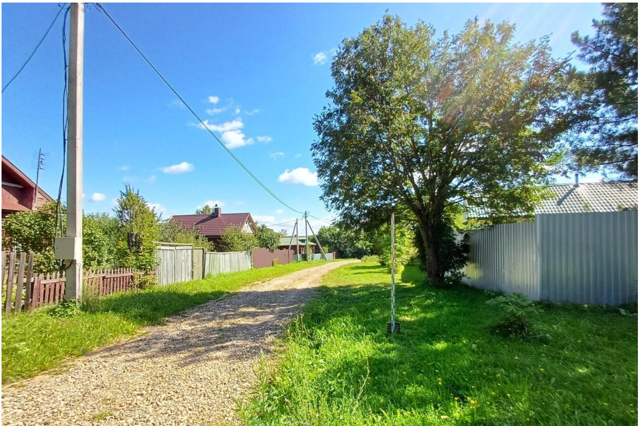
Рис. 126. Ивановская обл., Фурмановский р-н, с. Дуляпино, распределительный газопровод, 2-ая очередь. Точка фотофиксации 9, вид с северо-запада.
