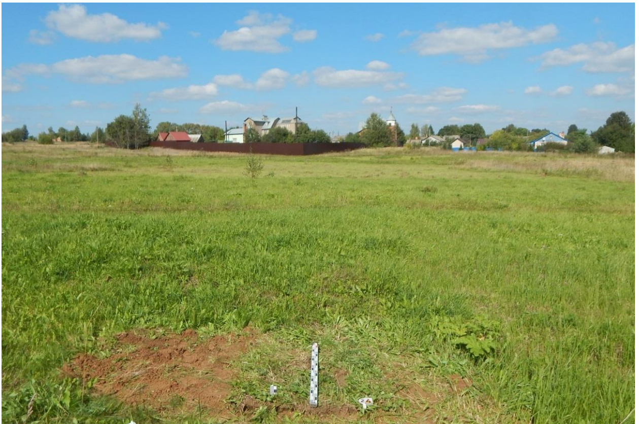
Рис. 230. Ивановская обл., Фурмановский р-н, с. Дуляпино, распределительный газопровод, 2-ая очередь. Шурф № 24, рекультивация, вид с юга.
