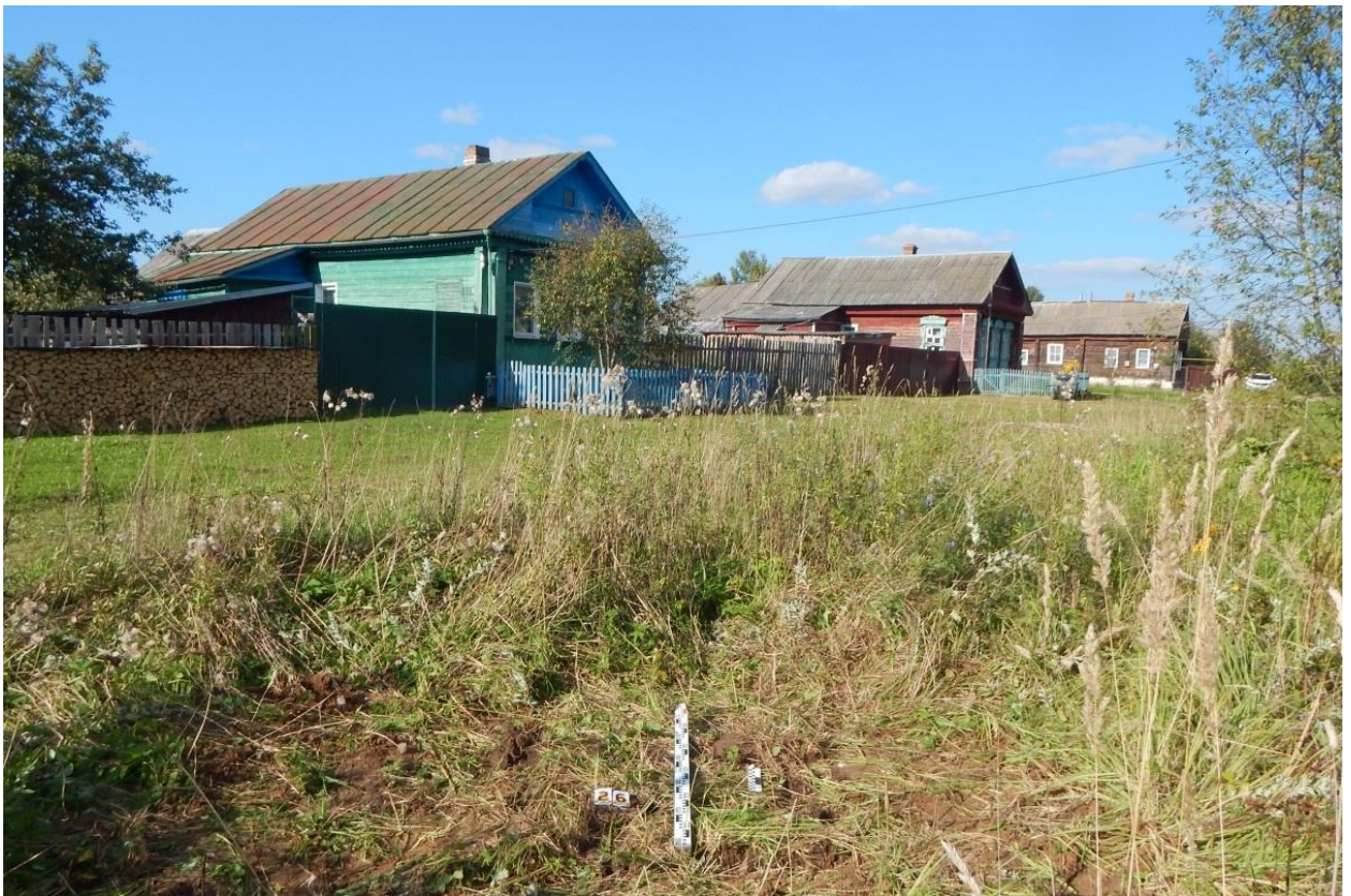
Рис. 244. Ивановская обл., Фурмановский р-н, с. Дуляпино, распределительный газопровод, 2-ая очередь. Шурф № 26, рекультивация, вид с юга.
