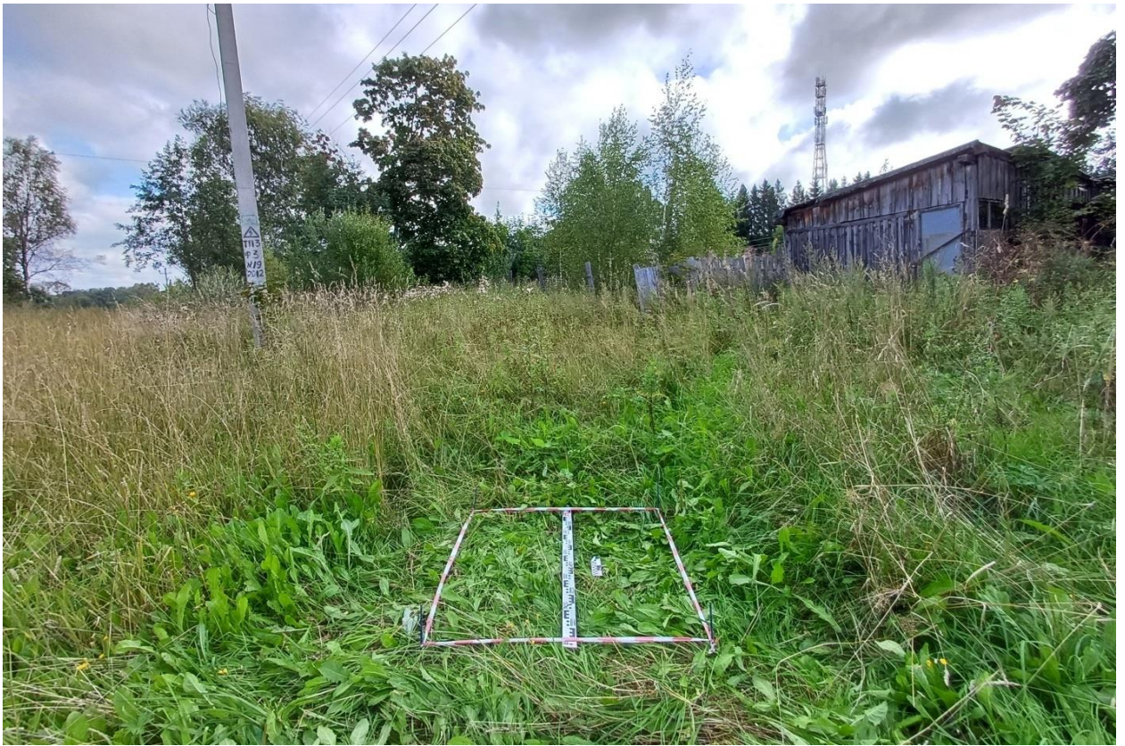
Рис. 93. Ивановская обл., Фурмановский р-н, с. Дуляпино, распределительный газопровод, 2-ая очередь. Шурф № 4, разметка и общий вид с юга.
