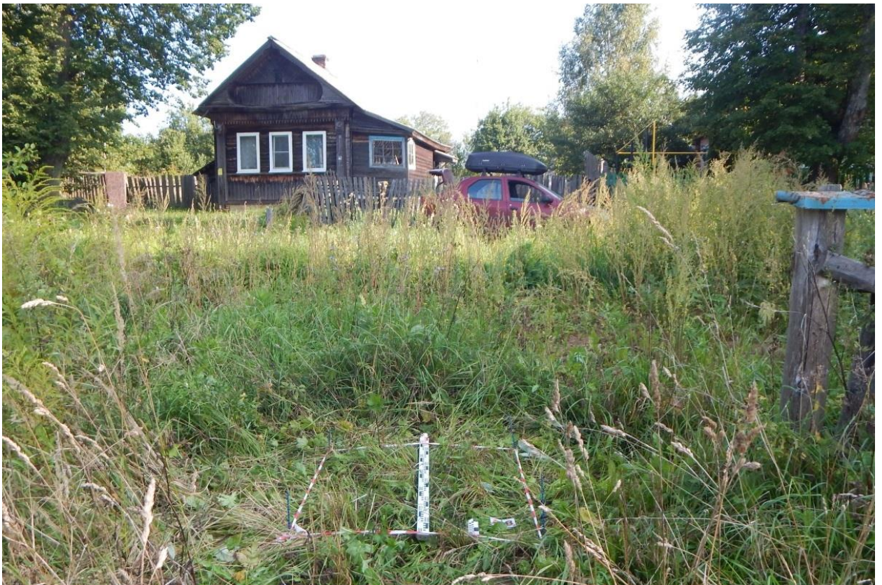
Рис. 254. Ивановская обл., Фурмановский р-н, с. Дуляпино, распределительный газопровод, 2-ая очередь. Шурф № 28, разметка и общий вид с юга.
