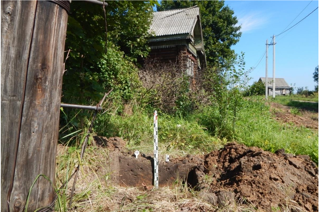
Рис. 151. Ивановская обл., Фурмановский р-н, с. Дуляпино, распределительный газопровод, 2-ая очередь. Общий вид с юга выкопанного шурфа № 12.
