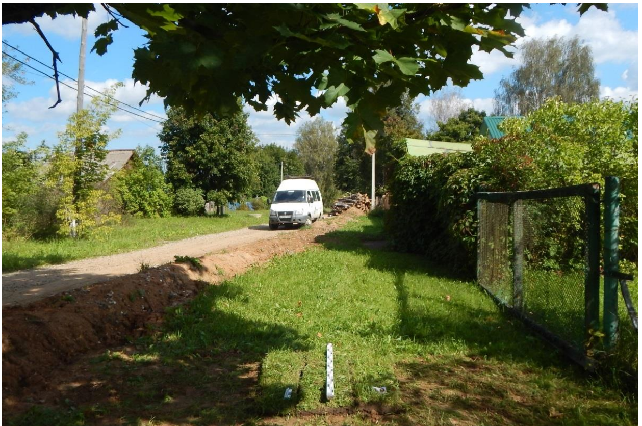
Рис. 196. Ивановская обл., Фурмановский р-н, с. Дуляпино, распределительный газопровод, 2-ая очередь. Шурф № 19, рекультивация, вид с юга.
