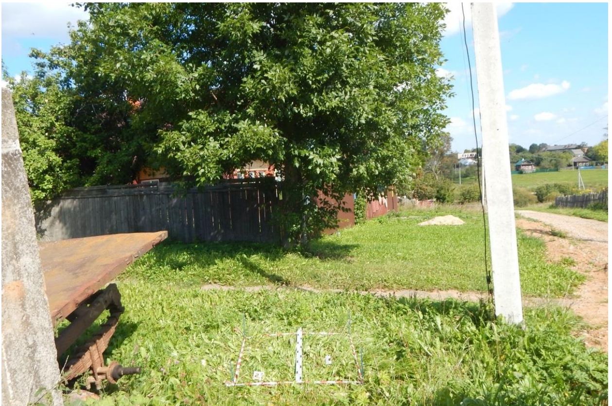
Рис. 212. Ивановская обл., Фурмановский р-н, с. Дуляпино, распределительный газопровод, 2-ая очередь. Шурф № 22, разметка и общий вид с юга.
