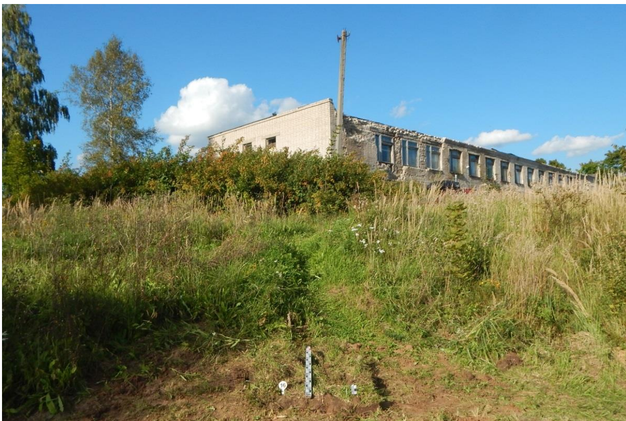
Рис. 177. Ивановская обл., Фурмановский р-н, с. Дуляпино, распределительный газопровод, 2-ая очередь. Шурф № 16, рекультивация, вид с юга.
