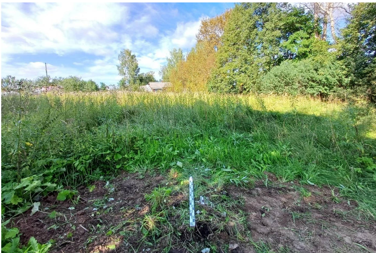
Рис. 111. Ивановская обл., Фурмановский р-н, с. Дуляпино, распределительный газопровод, 2-ая очередь. Шурф № 6, рекультивация, вид с юга.
