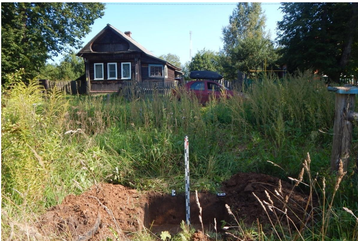
Рис. 257. Ивановская обл., Фурмановский р-н, с. Дуляпино, распределительный газопровод, 2-ая очередь. Общий вид с юга выкопанного шурфа № 28.
