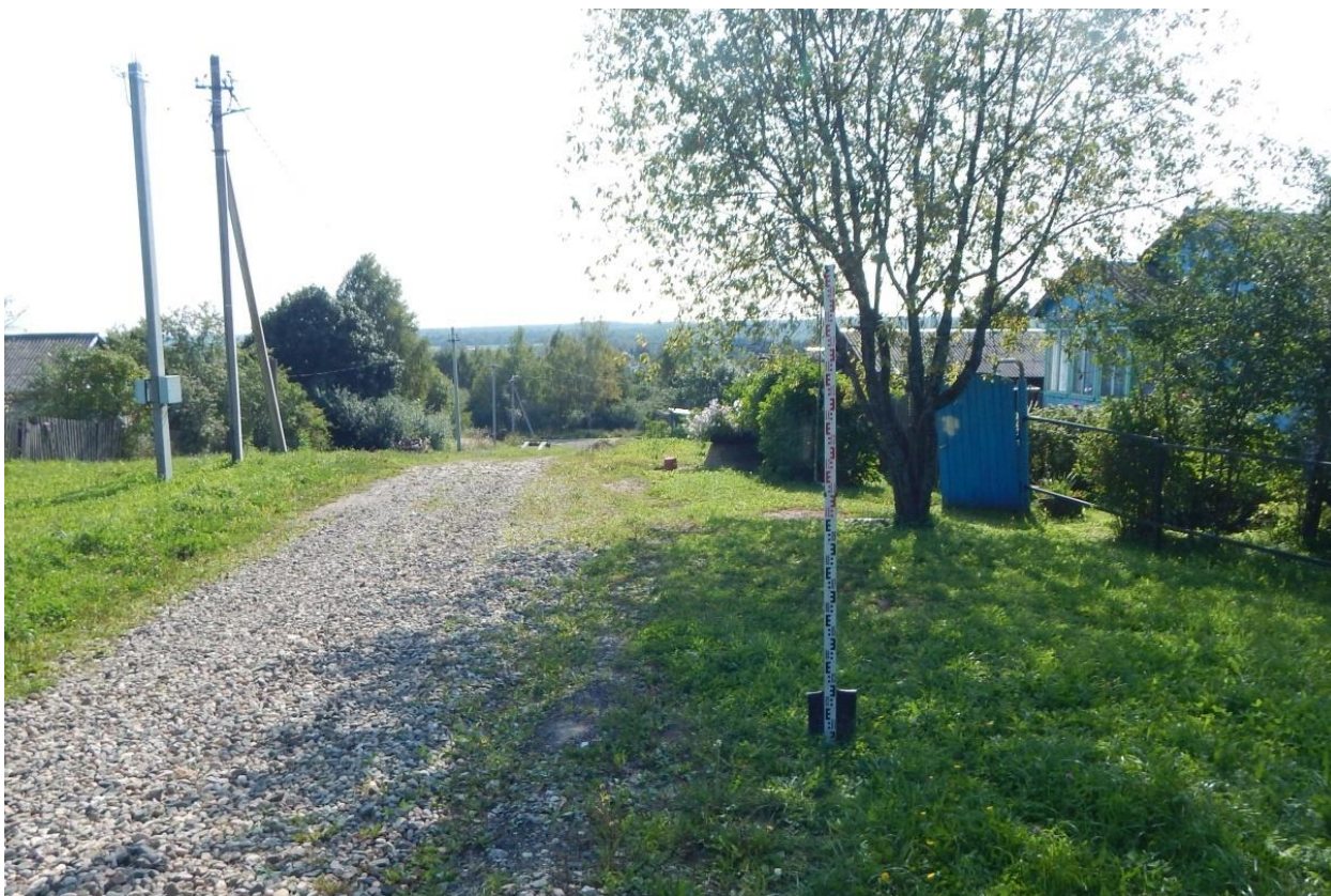
Рис. 265. Ивановская обл., Фурмановский р-н, с. Дуляпино, распределительный газопровод, 2-ая очередь. Точка фотофиксации 30, вид с северо-запада.
