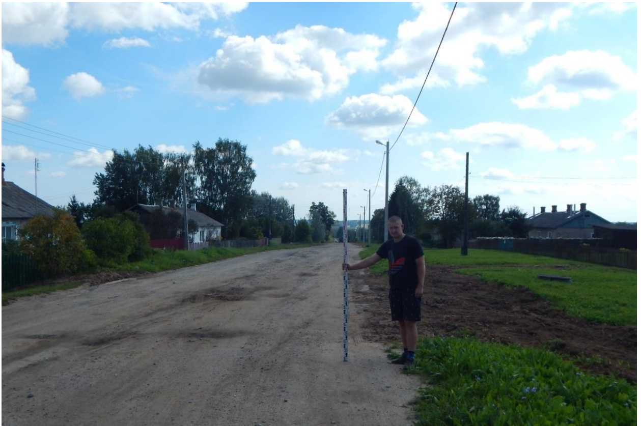
Рис. 159. Ивановская обл., Фурмановский р-н, с. Дуляпино, распределительный газопровод, 2-ая очередь. Точка фотофиксации 14, вид с северо-запада.
