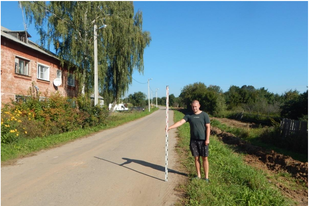
Рис. 179. Ивановская обл., Фурмановский р-н, с. Дуляпино, распределительный газопровод, 2-ая очередь. Точка фотофиксации 17, вид с юго-юго-востока.
