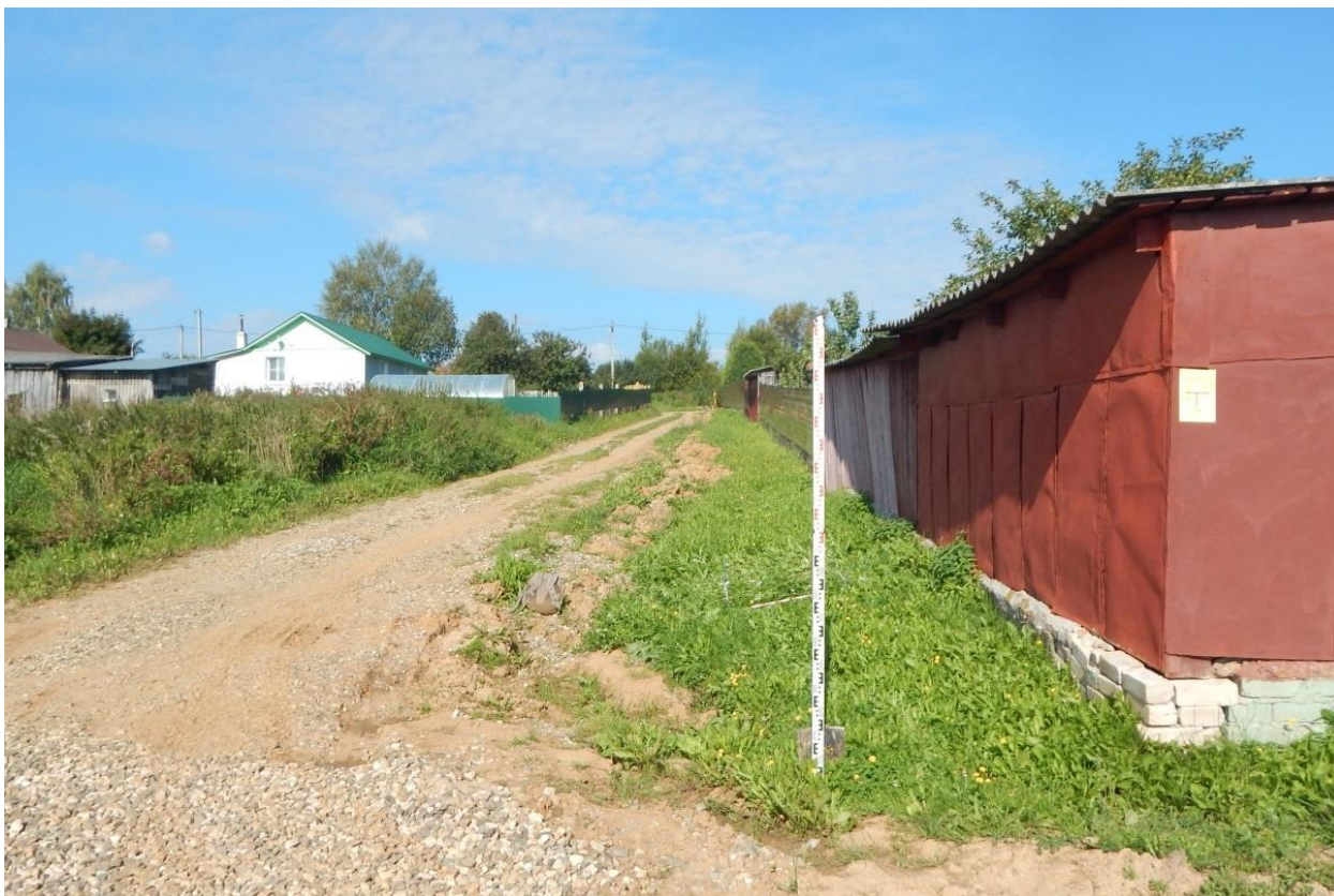
Рис. 198. Ивановская обл., Фурмановский р-н, с. Дуляпино, распределительный газопровод, 2-ая очередь. Точка фотофиксации 20, вид с юго-востока.
