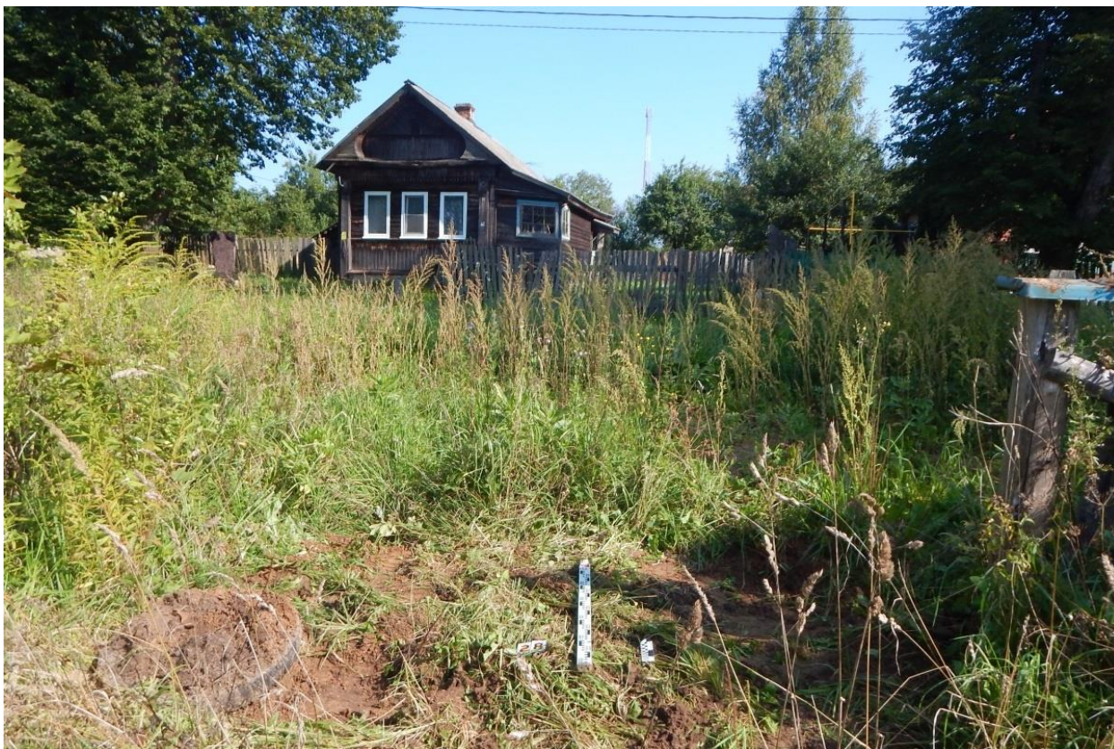
Рис. 258. Ивановская обл., Фурмановский р-н, с. Дуляпино, распределительный газопровод, 2-ая очередь. Шурф № 28, рекультивация, вид с юга.
