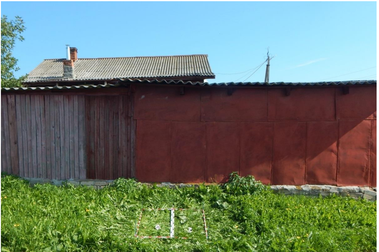
Рис. 199. Ивановская обл., Фурмановский р-н, с. Дуляпино, распределительный газопровод, 2-ая очередь. Шурф № 20, разметка и общий вид с юга.
