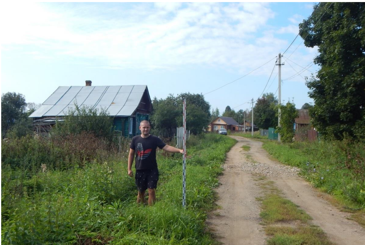
Рис. 146. Ивановская обл., Фурмановский р-н, с. Дуляпино, распределительный газопровод, 2-ая очередь. Точка фотофиксации 12, вид с северо-востока.
