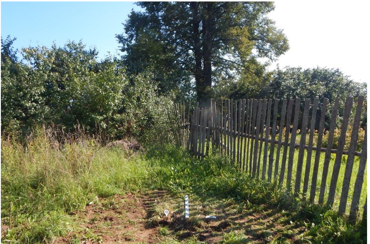
Рис. 184. Ивановская обл., Фурмановский р-н, с. Дуляпино, распределительный газопровод, 2-ая очередь. Шурф № 17, рекультивация, вид с юга.
