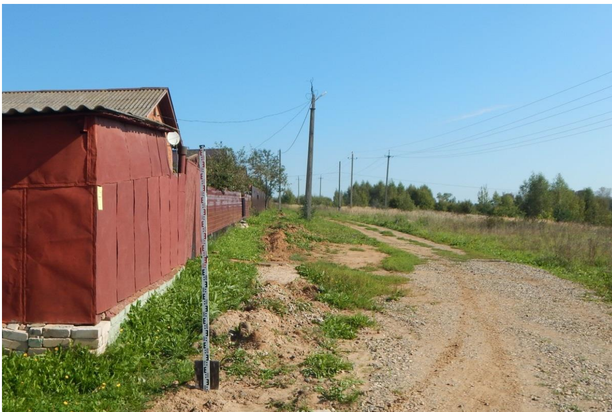
Рис. 197. Ивановская обл., Фурмановский р-н, с. Дуляпино, распределительный газопровод, 2-ая очередь. Точка фотофиксации 20, вид с юго-запада.
