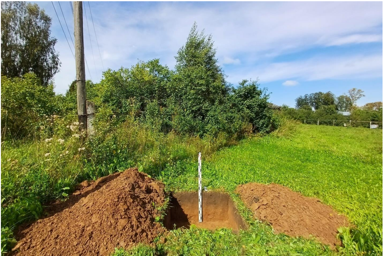
Рис. 117. Ивановская обл., Фурмановский р-н, с. Дуляпино, распределительный газопровод, 2-ая очередь. Общий вид с юга выкопанного шурфа № 7.
