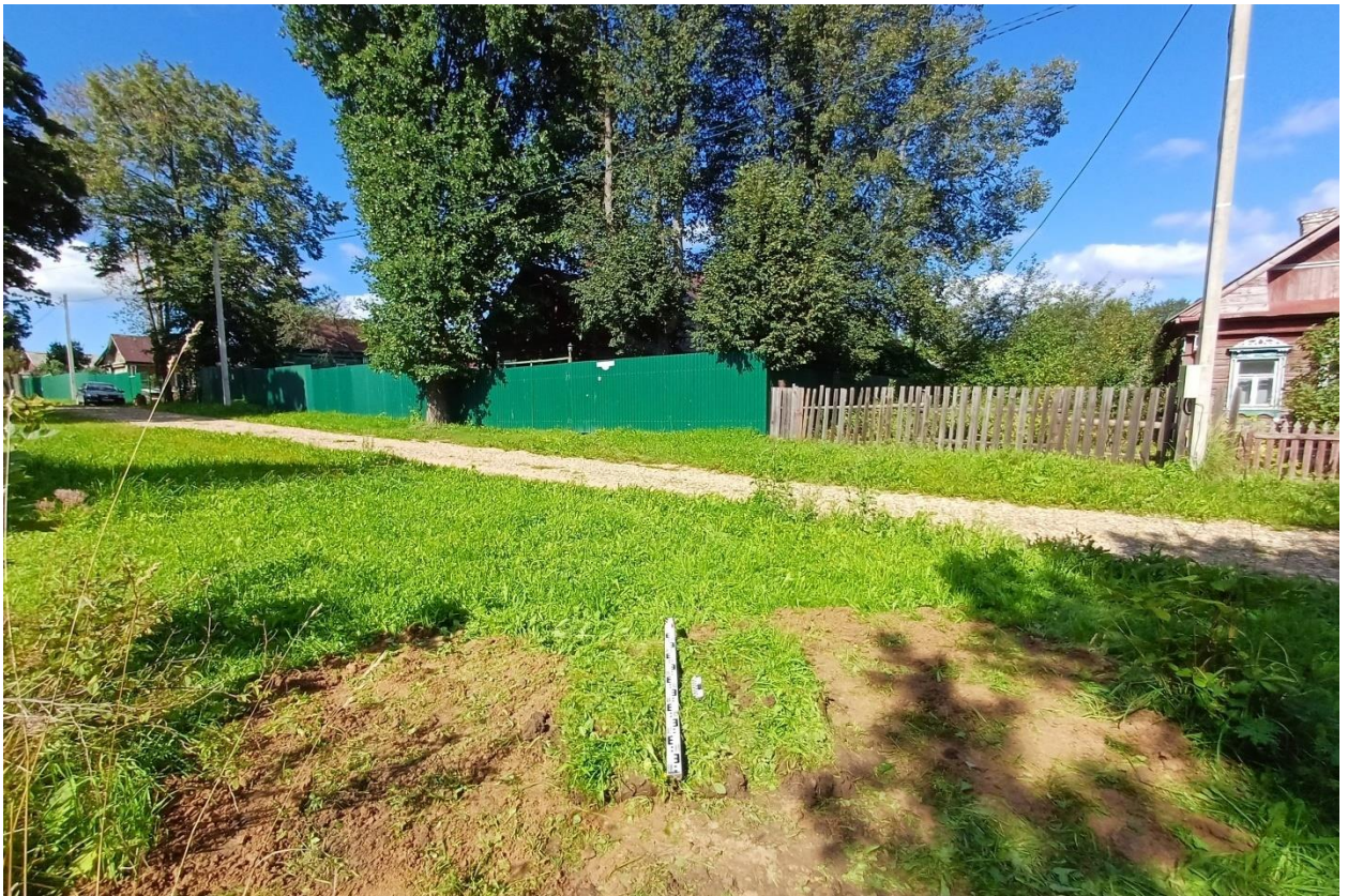
Рис. 131. Ивановская обл., Фурмановский р-н, с. Дуляпино, распределительный газопровод, 2-ая очередь. Шурф № 9, рекультивация, вид с юга.
