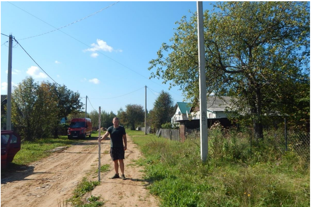
Рис. 204. Ивановская обл., Фурмановский р-н, с. Дуляпино, распределительный газопровод, 2-ая очередь. Точка фотофиксации 21, вид с северо-востока.
