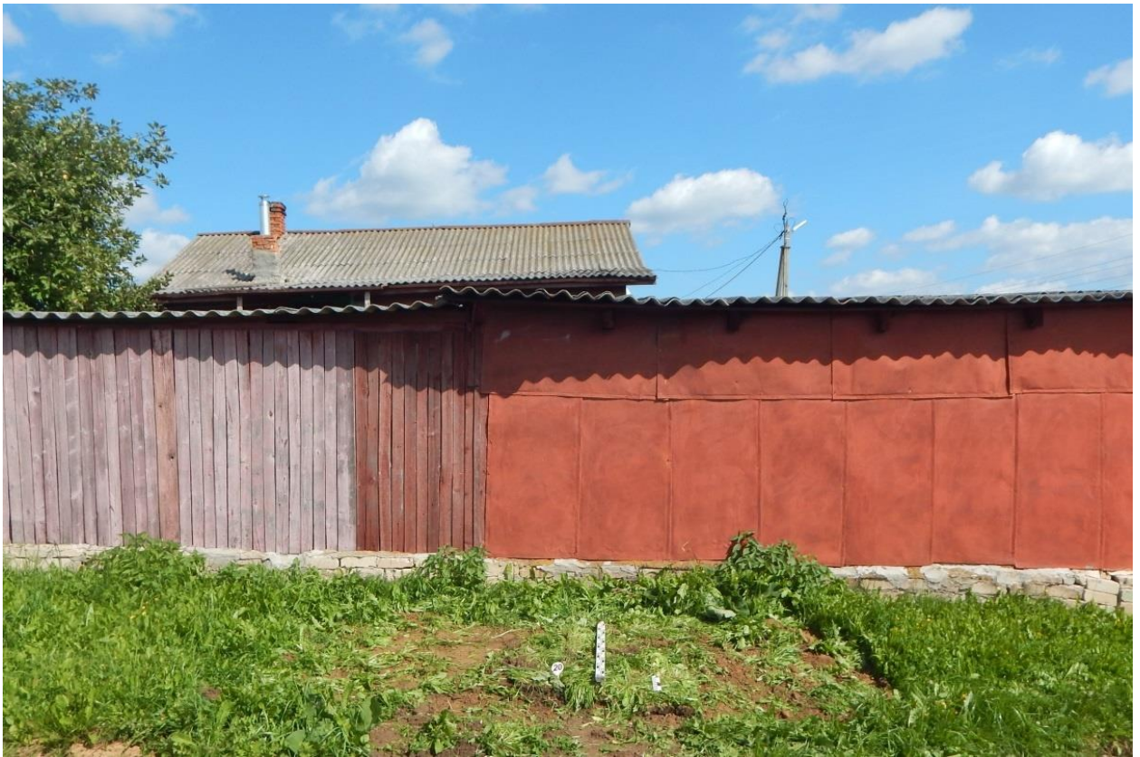
Рис. 203. Ивановская обл., Фурмановский р-н, с. Дуляпино, распределительный газопровод, 2-ая очередь. Шурф № 20, рекультивация, вид с юга.
