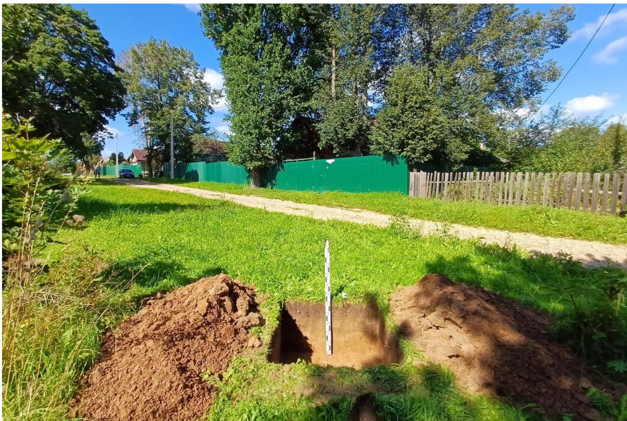
Рис. 130. Ивановская обл., Фурмановский р-н, с. Дуляпино, распределительный газопровод, 2-ая очередь. Общий вид с юга выкопанного шурфа № 9.
