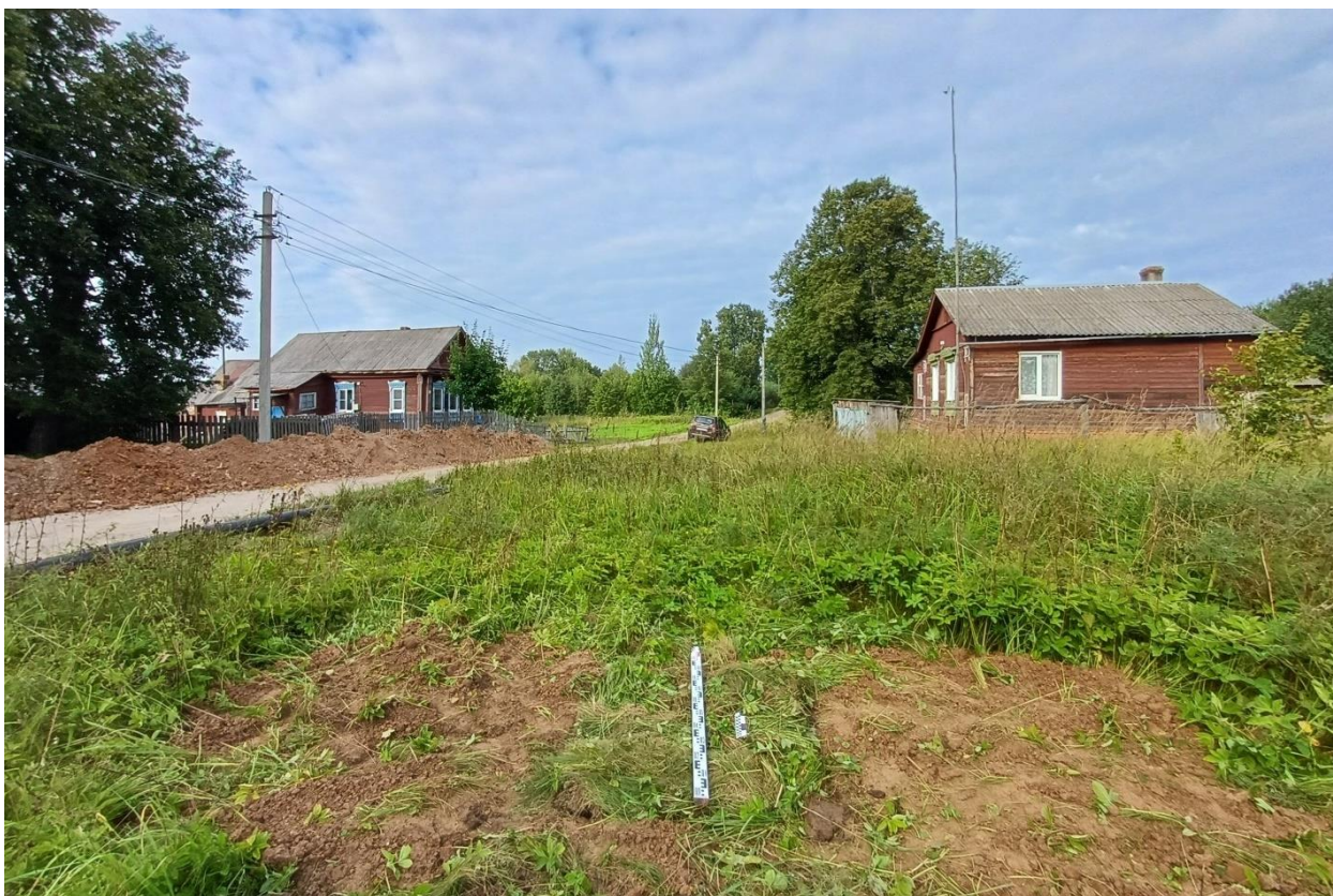
Рис. 91. Ивановская обл., Фурмановский р-н, с. Дуляпино, распределительный газопровод, 2-ая очередь. Шурф № 3, рекультивация, вид с юга.
