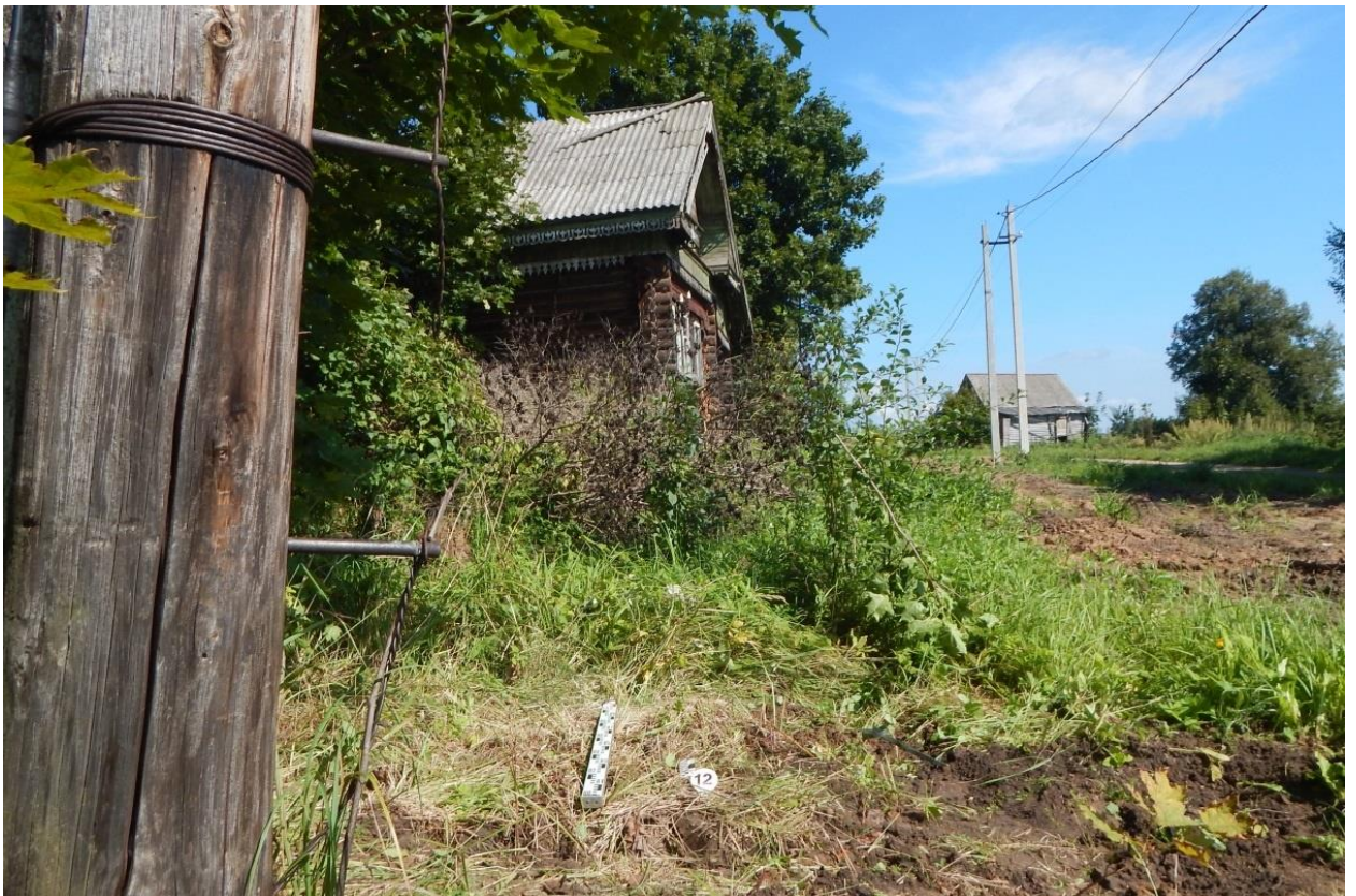
Рис. 152. Ивановская обл., Фурмановский р-н, с. Дуляпино, распределительный газопровод, 2-ая очередь. Шурф № 12, рекультивация, вид с юга.
