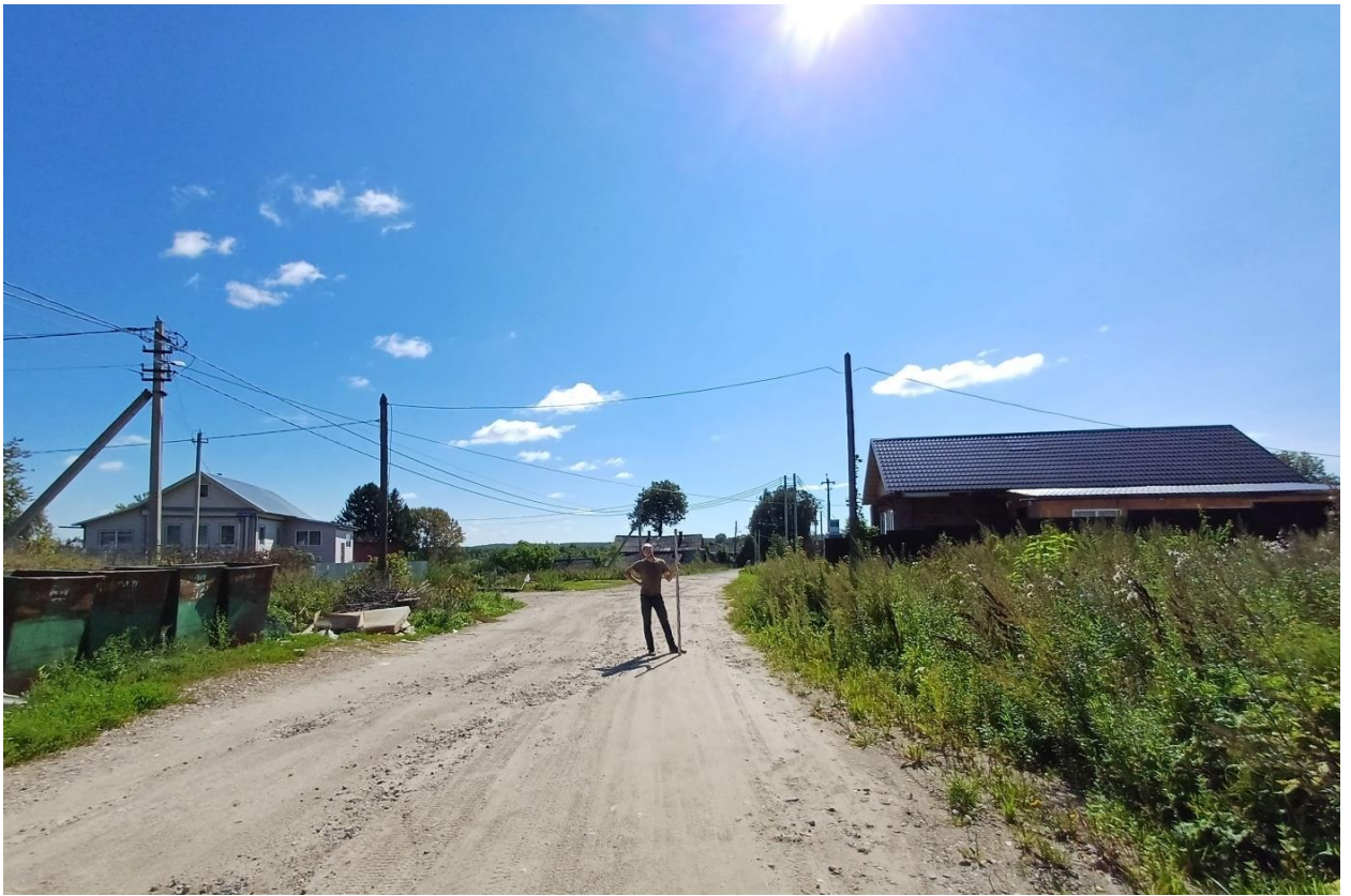
Рис. 119. Ивановская обл., Фурмановский р-н, с. Дуляпино, распределительный газопровод, 2-ая очередь. Точка фотофиксации 8, вид с северо-запада.
