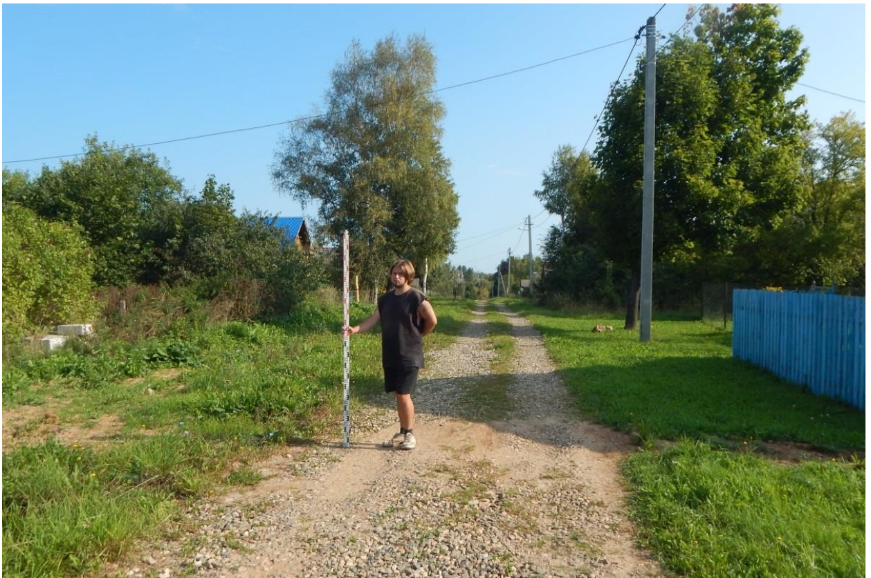
Рис. 246. Ивановская обл., Фурмановский р-н, с. Дуляпино, распределительный газопровод, 2-ая очередь. Точка фотофиксации 27, вид с юго-запада.
