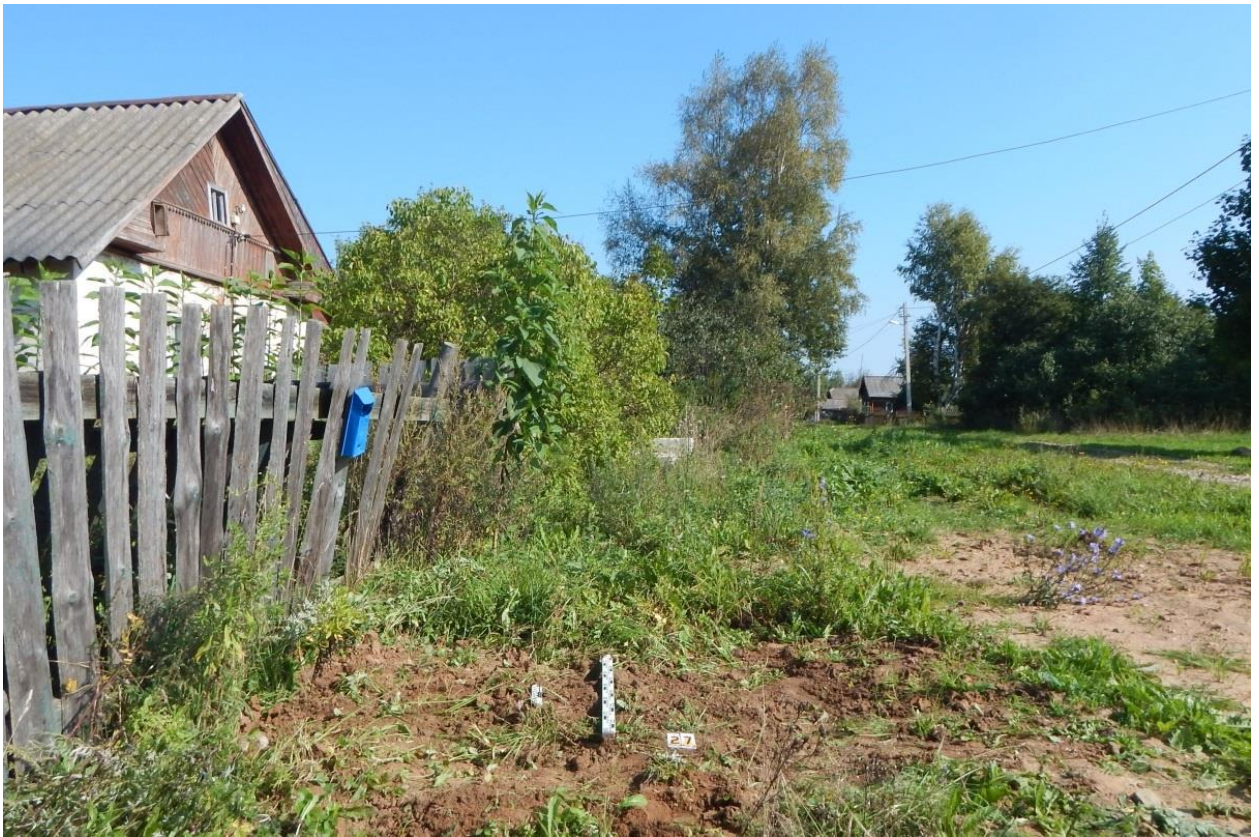
Рис. 251. Ивановская обл., Фурмановский р-н, с. Дуляпино, распределительный газопровод, 2-ая очередь. Шурф № 27, рекультивация, вид с юга.
