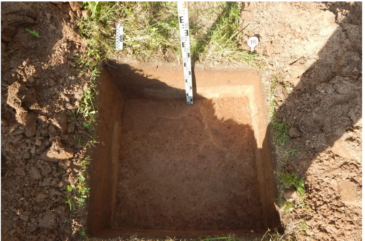
Рис. 174. Ивановская обл., Фурмановский р-н, с. Дуляпино, распределительный газопровод, 2-ая очередь. Шурф № 16, зачистка поверхности материка, вид с юга.
