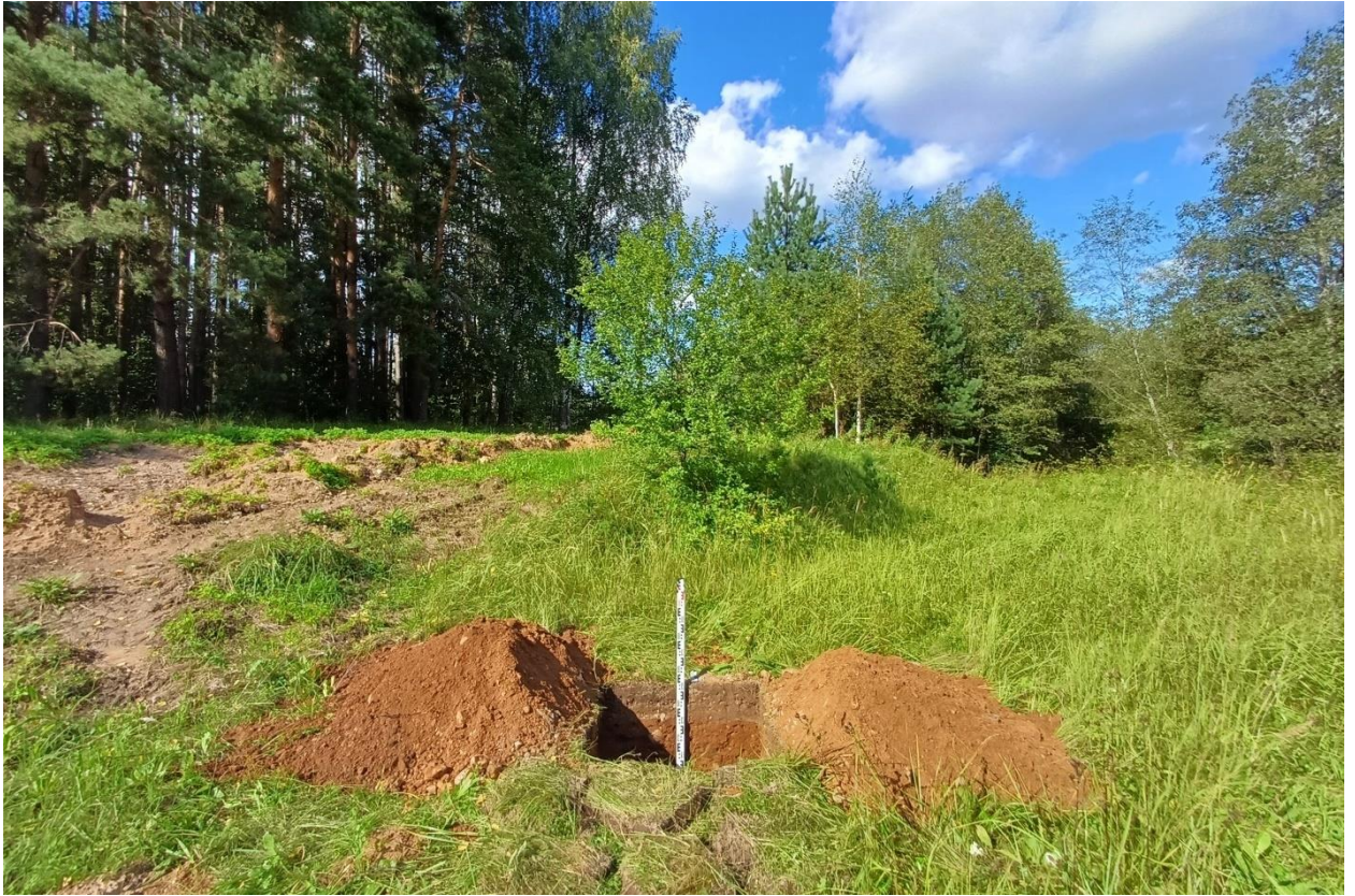
Рис. 77. Ивановская обл., Фурмановский р-н, с. Дуляпино, распределительный газопровод, 2-ая очередь. Общий вид с юга выкопанного шурфа № 1.
