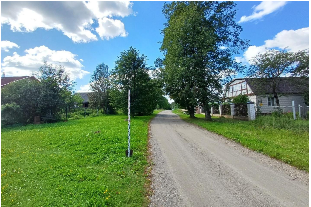
Рис. 79. Ивановская обл., Фурмановский р-н, с. Дуляпино, распределительный газопровод, 2-ая очередь. Точка фотофиксации 2, вид с северо-востока.
