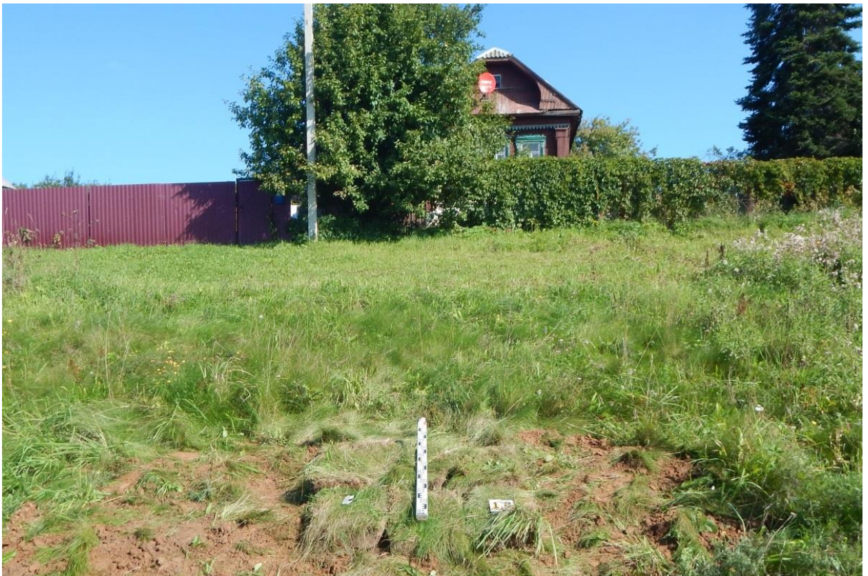
Рис. 190. Ивановская обл., Фурмановский р-н, с. Дуляпино, распределительный газопровод, 2-ая очередь. Шурф № 18, рекультивация, вид с юга.
