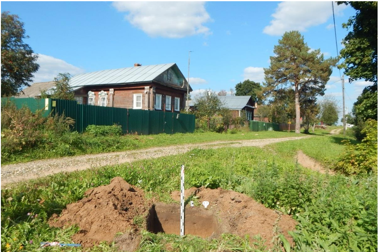
Рис. 237. Ивановская обл., Фурмановский р-н, с. Дуляпино, распределительный газопровод, 2-ая очередь. Общий вид с юга выкопанного шурфа № 25.
