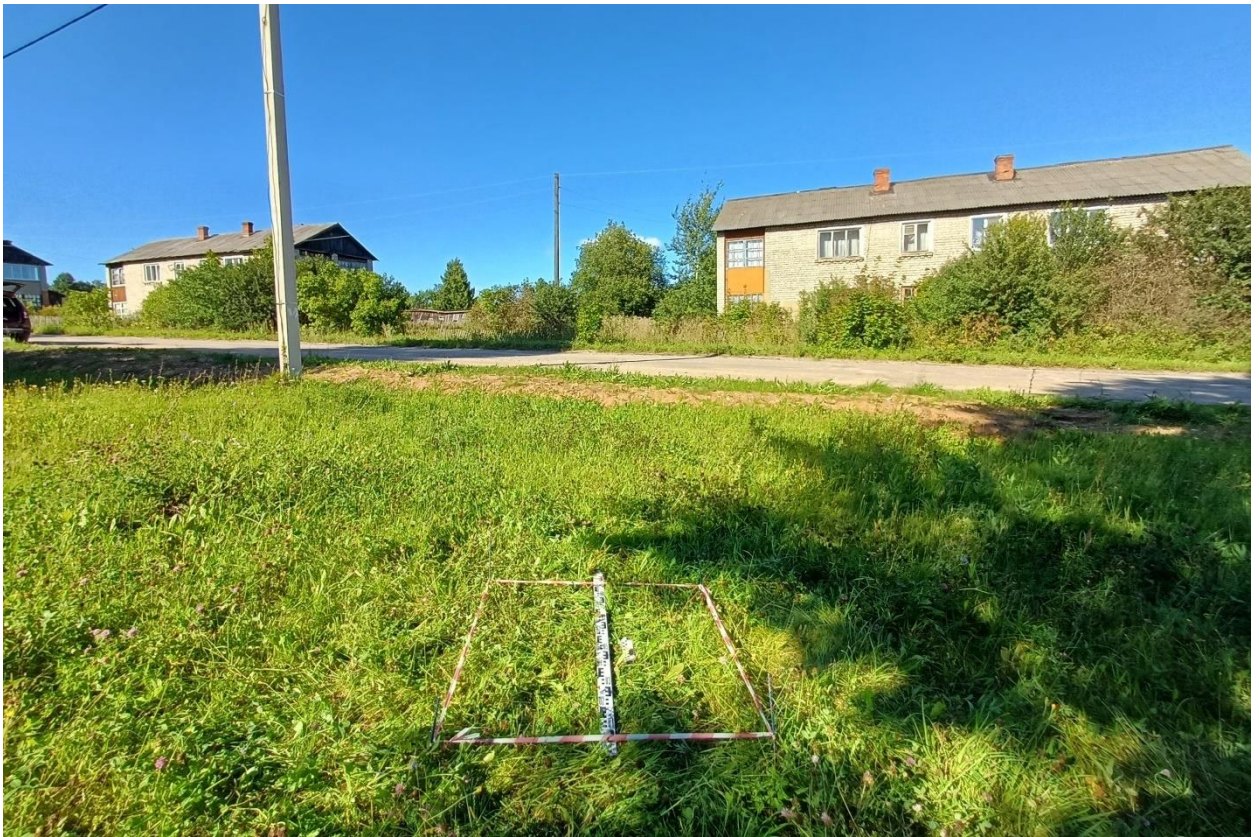
Рис. 133. Ивановская обл., Фурмановский р-н, с. Дуляпино, распределительный газопровод, 2-ая очередь. Шурф № 10, разметка и общий вид с юга.
